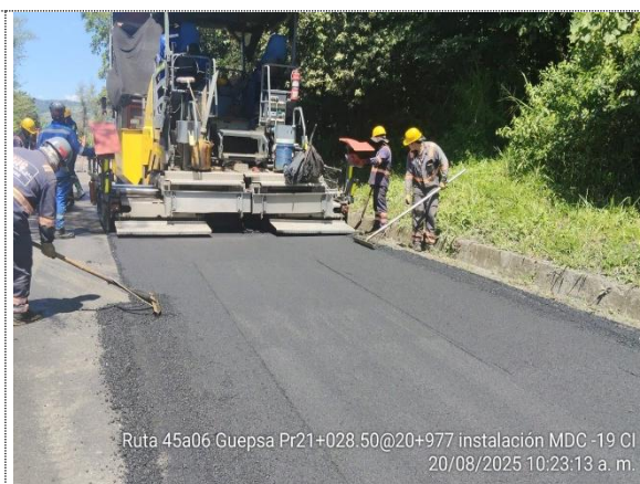
BACHEO RUTA 45 A 06, GÜEPSA, PR20+0977 - PR21+0028, FRESADO E INSTALACIÓN DE MDC-19
