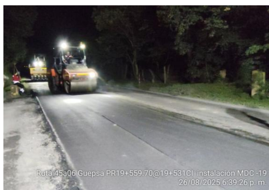
PR19+0531 – PR19+0559, Güepsa, fresado e instalación de BTA y MDC-19 (26/08/25)
