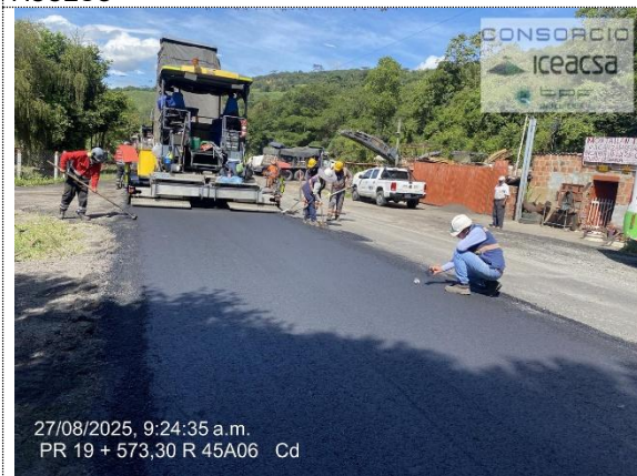
BACHEO RUTA 45 A 06, GÜEPSA, PR19+0573 - PR19+0600, FRESADO E INSTALACIÓN DE MDC-19
