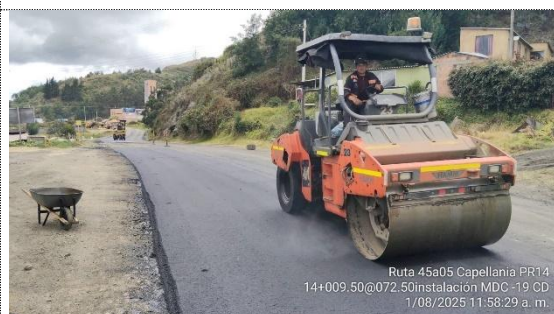
PR14+0009 – PR14+0072, Capellanía, instalación de BTA y MDC-19 (04/08/25)
