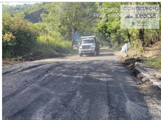
RUTA 45 A 06, PR22+0900, Güepsa, instalación y compactación de material de fresado (11/08/25)
