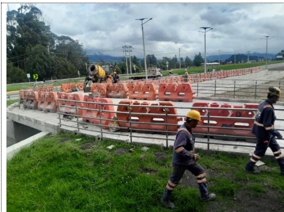
VARIANTE ZIPAQUIRÁ, ESPACIO PÚBLICO, INSTALACIÓN DE BARANDA M82 SOBRE CANAL DE ACCESO
