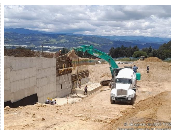
TRAMO 2, MRUO S-25, FUNDIDA DE 5ta SECCIÓN DE VÁSTAGO DE MÓDULO 2
