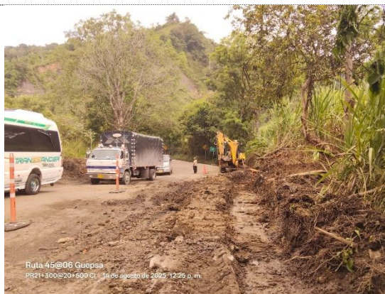
RUTA 45 A 06, PR22+0900, Güepsa, limpieza de cuneta y excavación para canal (14/08/25)
