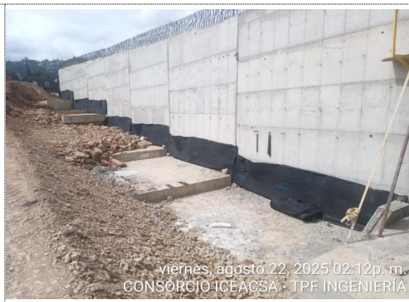
TRAMO2, MURO S-25, INSTALACIÓN DE GEODRÉN PLANAR A LO LARGO DEL MURO
