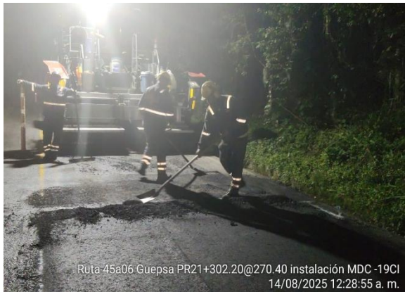
BACHEO RUTA 45 A 06, GÜEPSA, PR21+0270 - PR21+0302, FRESADO E INSTALACIÓN DE BTA Y MDC-19
