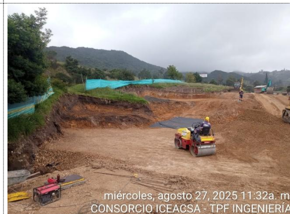
TRAMO2, RETORNO K44+410 SUR - SUR, K0+020 - K0+028, INSTALACIÓN DE 2da CAPA DE TERRAPLÉN
