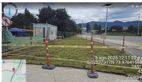
Revegetalización finalizada de áreas aledañas a la glorieta de la calle 8 con variante
