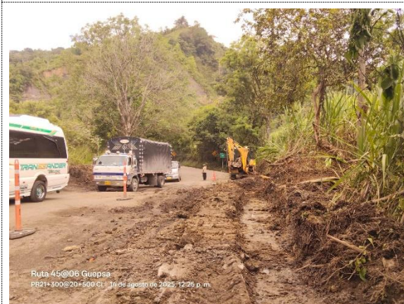
SITIO CRÍTICO GÜEPSA, PR22+0900, EXCAVACIÓN PARA LIMIEZA DE CUNETA Y CONSTRUCCIÓN DE CANAL DE DESAGÜE
