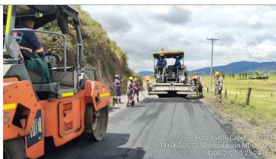
PR14+0065 – PR14+0072, Capellanía, instalación de BTA y MDC-19 (04/08/25)
