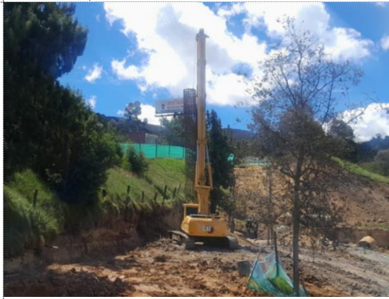
TRAMO 2, PUENTE K44+500, PERFORACIÓN, IZAJE DE CANASTA DE ACERO Y FUNDIDA DE PILOTE No 12 PILA 2
