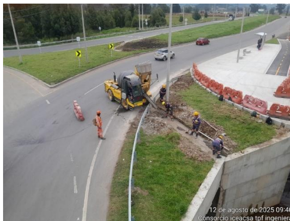
VARIANTE ZIPAQUIRÁ, CONECTANTE NORTE, FUNDIDA DE CANAL DE DESCOLE DE CUNETETA.
