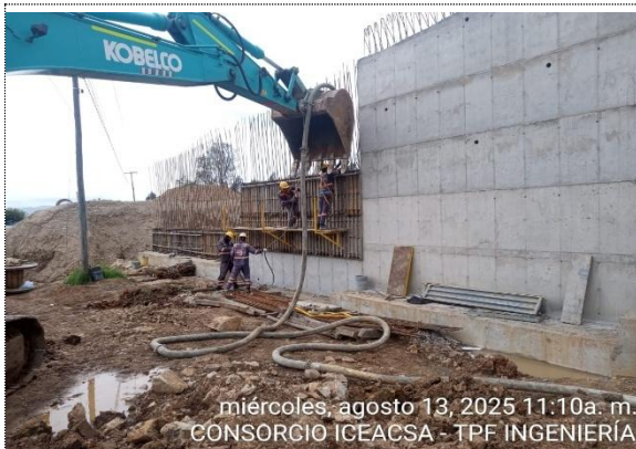
TRAMO 2, MURO S5, FUNDIDA DE 2da SECCIÓN DE VÁSTAGO MÓDULO 2
