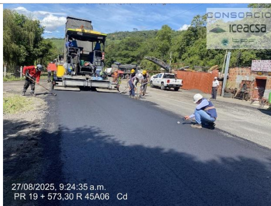
PR19+0573 – PR19+0600, Güepsa, fresado e instalación de BTA y MDC-19 (27/08/25)
