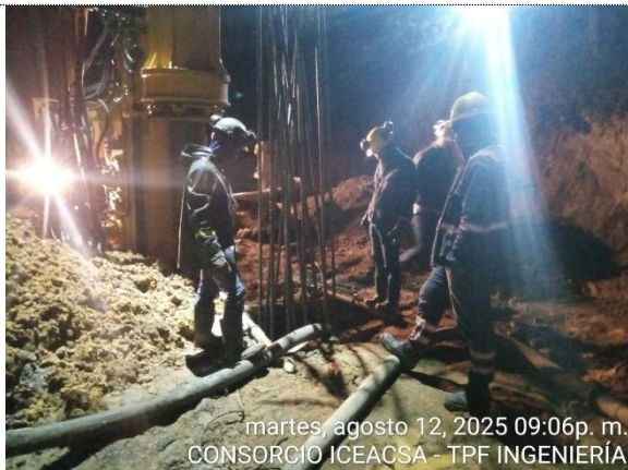
TRAMO 2, PUENTE K44+500, PERFORACIÓN, IZAJE DE CANASTE DE ACERO Y FUNDIDA DE PILOTE No 12 PILA 2
