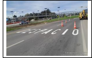
VARIANTE ZIPAQUIRÁ, DEMARCACIÓN DE BANDAS ALERTADORAS Y TEXTO "DESPACIO" EN CONECTANTES
