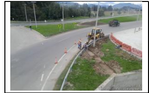
VARIANTE ZIPAQUIRÁ, GLORIETA, CORTE DE ASFALTO Y EXCAVACIÓN PARA CONSTRUCCIÓN DE CUNETAS CONECTANTE NORTE
