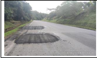
TAPAHUECOS RUTA 45 A 05, PUENTE NACIONAL, PR85+0500, INSTALACIÓN DE MDC-19
