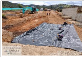
TRAMO 2, K44+395 - K44+405, INSTALACIÓN DE RAJÓN Y GEOTEXTIL
