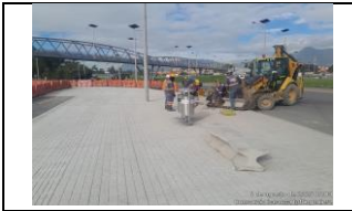
VARIANTE ZIPAQUIRÁ, ESPACIO PÚBLICO, INSTALACIÓN DE BANCAS MODULARES EN CONECTANTE NORTE
