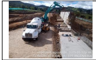
TRAMO 2, MURO S-25, FUNDIDA DE 4ta SECCIÓN DE VÁSTAGO MÓDULO 2
