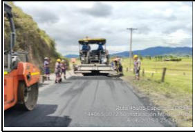
BACHEO RUTA 45 A 05, CAPELLANÍA, PR14+0065 - PR14+0072, FRESADO E INSTALACIÓN DE BTA Y MDC-19
