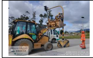
VARIANTE ZIPAQUIRÁ, GLORIETA, RETIRO DE CAJA DE CONTROL Y SEMÁFOROS
