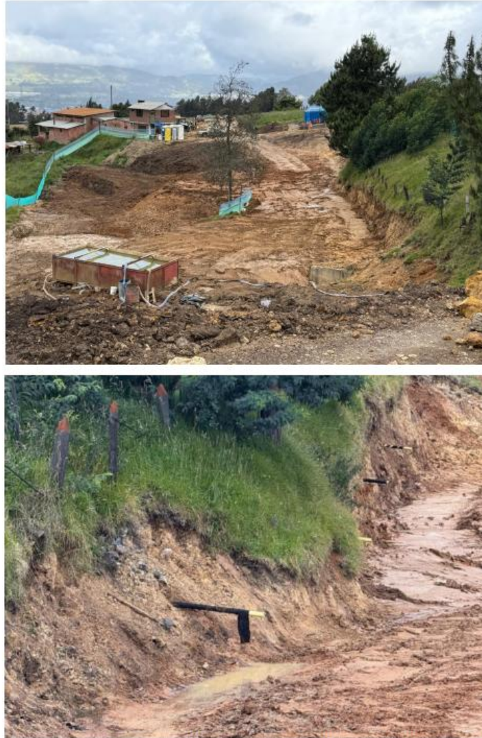
Fotografía 1. Condiciones de drenaje ladera abajo – zona construcción cimentación puente vehicular
