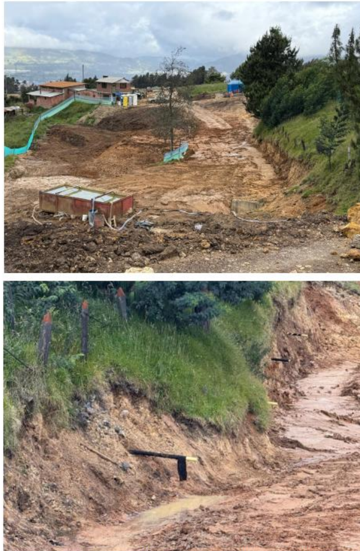
Fotografía 1. Condiciones de drenaje ladera abajo – zona construcción cimentación puente vehicular
