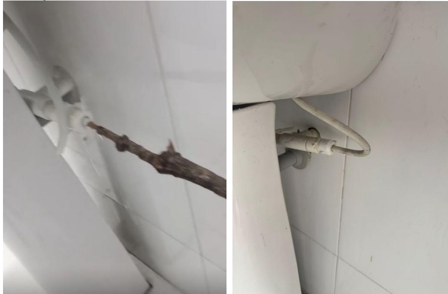
Se observan mangueras rotas
