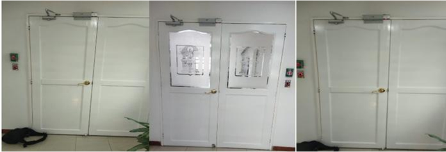
CONTROL DE ACCESO PISO 12
