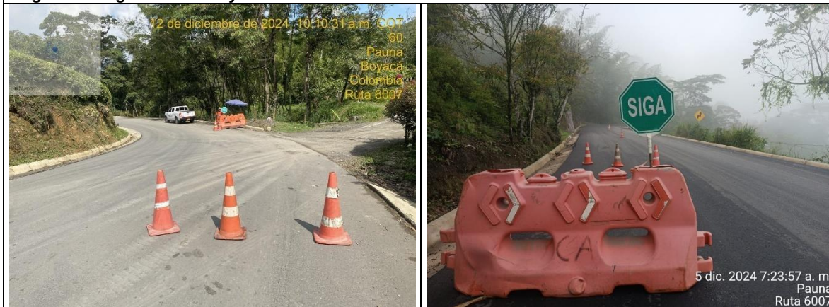
Registro fotográfico N.º 39 y 40: Ubicación de controladores de tráfico frentes de obra 6007
