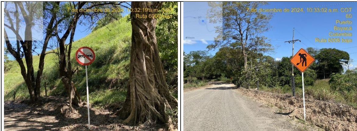
Registro fotográfico N° 31 y 32: Mantenimiento a las señales verticales preventivas instaladas en el corredor vial, en cumplimiento con el PMT.
