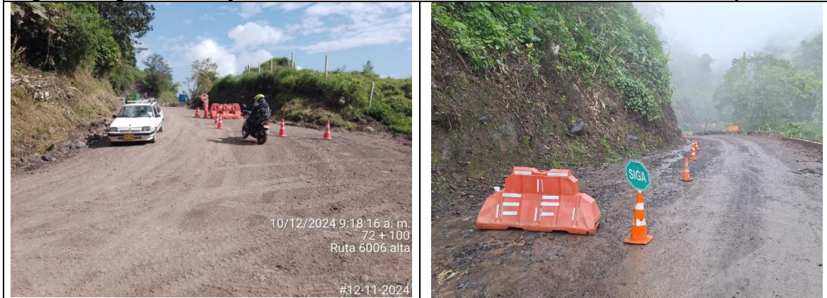
Registro fotográfico N.º 37 y 38: Ubicación de controladores de tráfico frentes de obra 6006 alta
