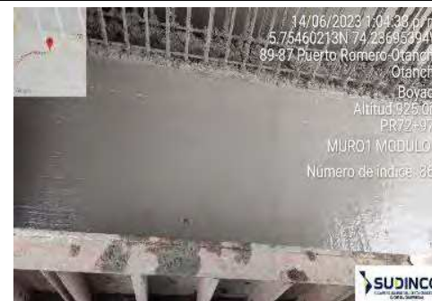
Foto Avance (PR 72 - 14.06.23)
