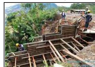
Foto 6. Ruta 6006. Construcción de obras de drenaje.
