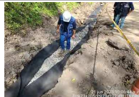
Foto Avance (PR 73 - 21.06.23)
