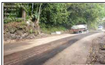
Foto 5. Ruta 6006. Humectación para control de MP. PB73+900
