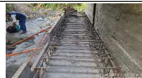
Foto Avance (PR 1 - 20.06.23)
