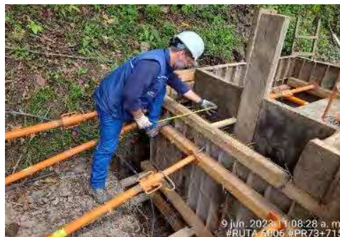
Foto Avance (PR 73 - 9.06.23)
