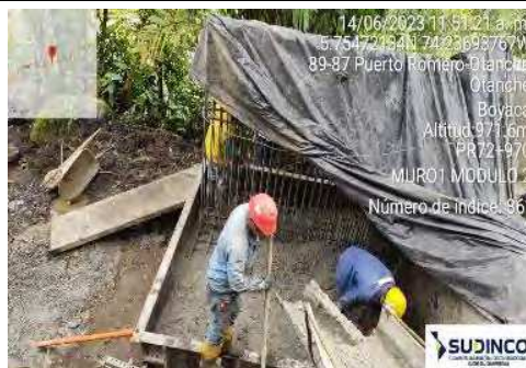
Foto Avance (PR 72 - 14.06.23)
