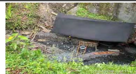
Foto Avance (PR 1 - 22.06.23)
