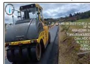
Foto 9. Ruta 6009. Compactación de MDC-19
