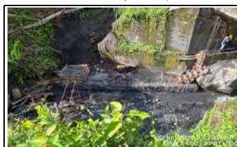
Foto 8. Ruta 6007. Inspección ambiental de obras de mitigación en Puente Tambrías, PR1+230
