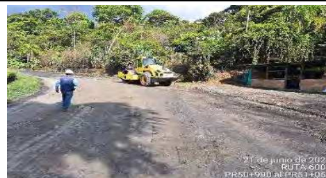
Foto Avance (PR 50/51 - 21.06.23)
