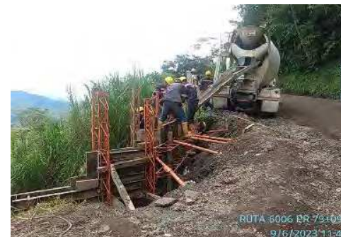
Foto Avance (PR 73 - 18.05.23)
