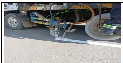
Foto 1. Ruta 45BY01. Demarcación de líneas laterales en Cra 5
