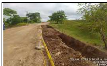
Foto 2. Ruta 6006. Excavación inicial para construcción de muro oriental PR11+990
