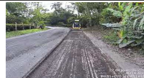
Foto Avance (PR 50/51 - 22.06.23)
