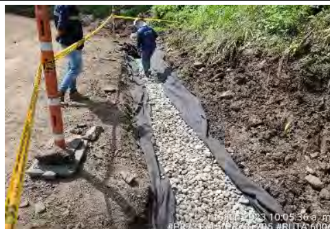
Foto Avance (PR 73 - 16.06.23)
