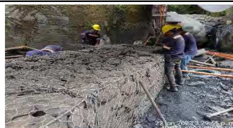
Foto Avance (PR 1 - 22.06.23)
