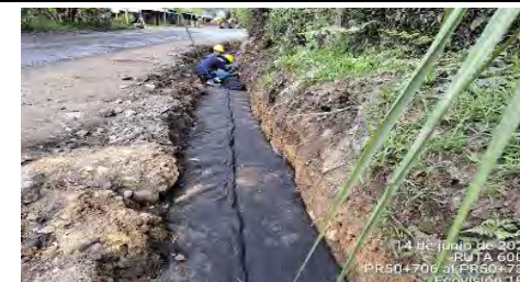
Foto Avance (PR 50 - 14.06.23)
