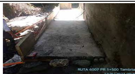
Foto Avance (PR 1 - 13.06.23)
