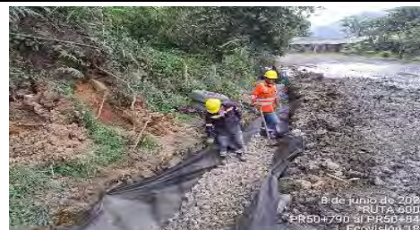
Foto Avance (PR 50 - 08.06.23)
