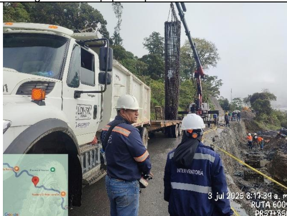
Registro Fotográfico N° 81 y 82: Inspección y Verificación de actividad de izaje cargas en conjunto contratista e interventoría.
