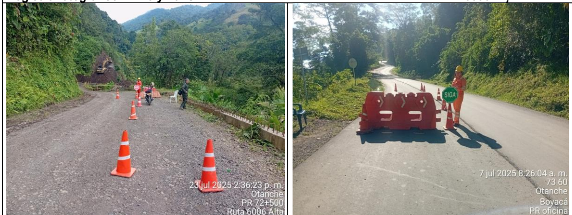
Registro fotográfico N.º 47 y 48: Ubicación de controladores de tráfico frentes de obra 6006 alta
