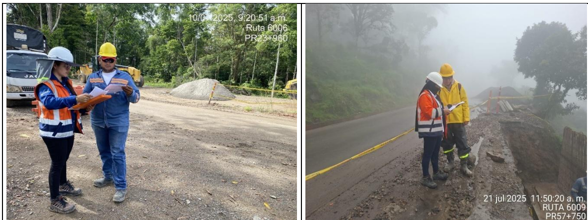
Registro Fotográfico N° 75 y 76: Inspecciones en los frentes de obras y permisos de Trabajo por parte de la interventoría
