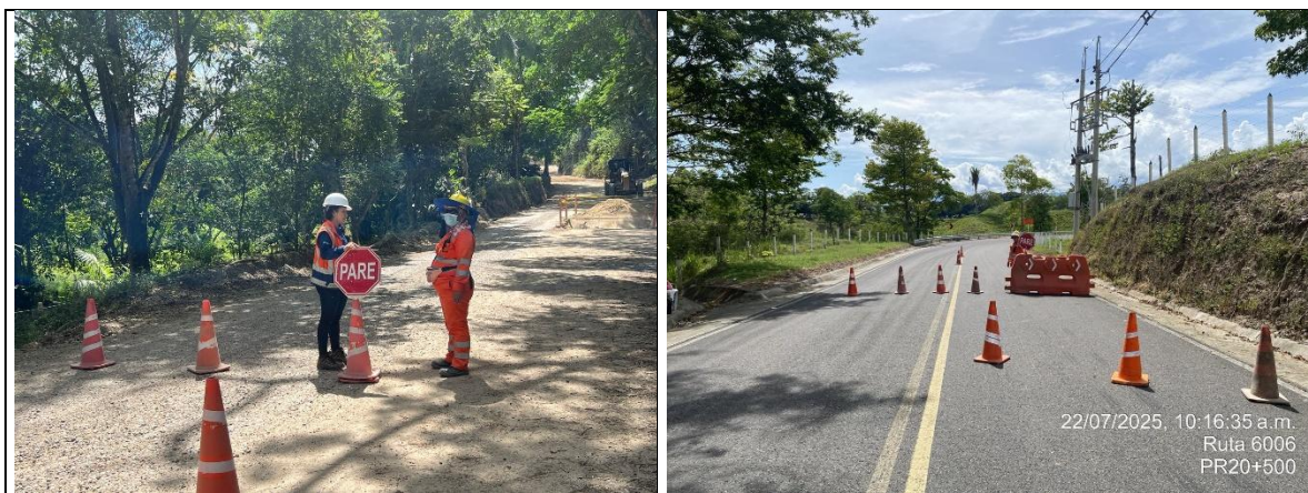
Registro fotográfico N.º 45 y 46: Ubicación de controladores de tráfico frentes de obra 6006 baja
