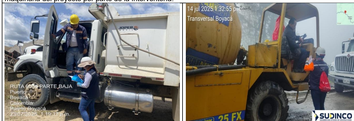
Registro Fotográfico N° 61 y 62: Seguimiento por parte del contratista en el cumplimiento de preoperacionales por parte de los conductores y operadores de obra.
