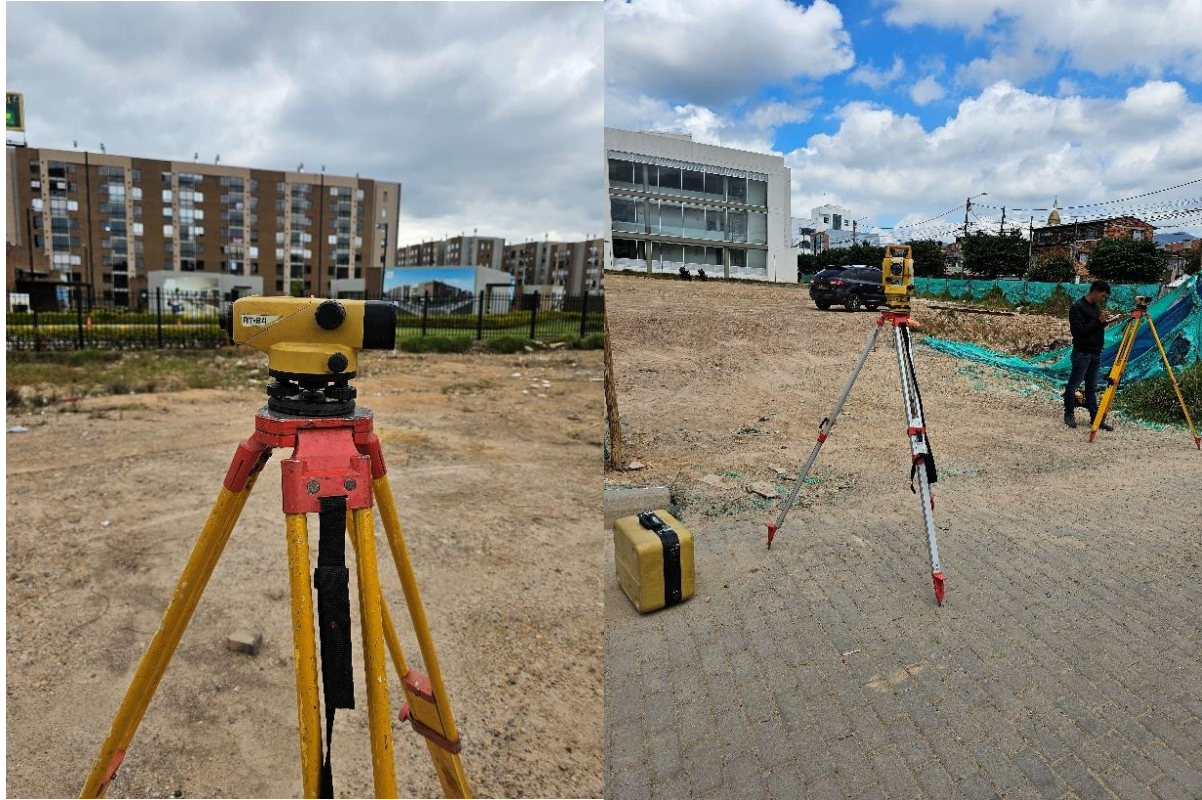
Localización y replanteo de cimientos con elementos de precisión. Se inicio, en compañía de la comisión topográfica, la actividad de localización y replanteo del predio a intervenir, identificando principalmente las áreas del
