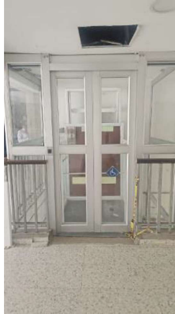
puerta de acceso segundo nivel
