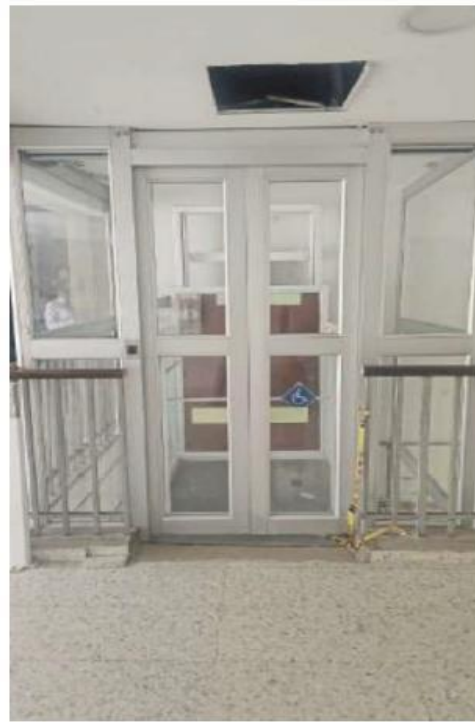
puerta de acceso segundo nivel
