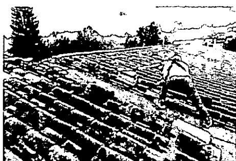
Mantenimiento de cubierta existente en teja de barro
