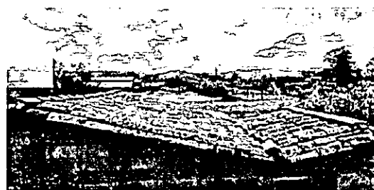
Mantenimiento de cubierta existente en teja de barro - Colocación de canoa "U"
