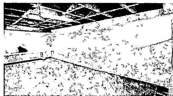
Muro en drywall con acabado doble cara
