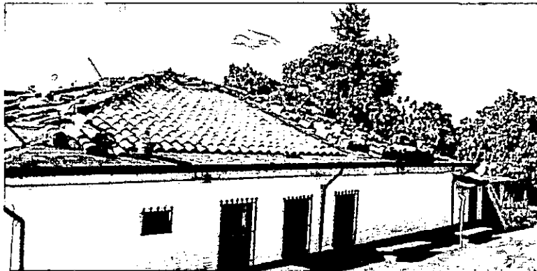
Mantenimiento de cubierta existente en teja de barro - Mantenimiento de canoa
