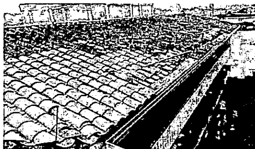
Suministro, transporte y colocación de canoa "U"
