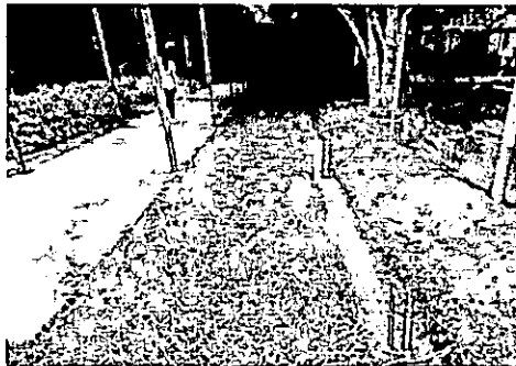
Construcción de cerramiento con malla eslabonada
