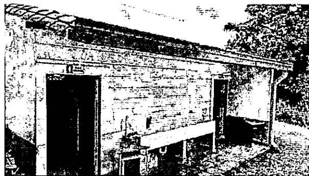
Instalación canoa y bajante 4"
