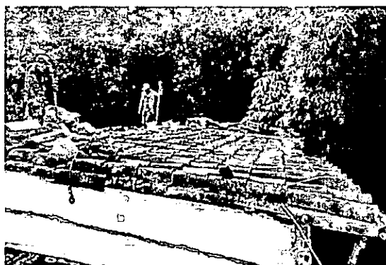
Mantenimiento de cubierta existente en teja de barro y retiro de canoas
