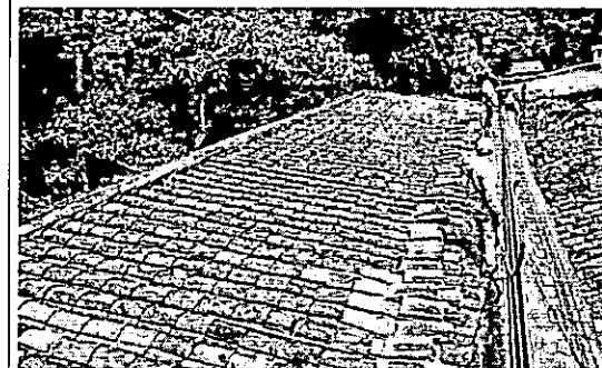
Mantenimiento cubierta e instalación canoa nueva
