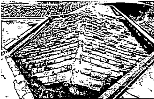
Mantenimiento de cubierta existente en teja de barro y canoas
