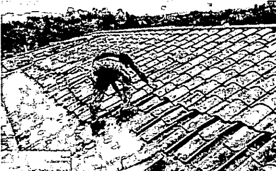
Mantenimiento de cubierta existente en teja de barro
