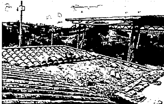
Mantenimiento de cubierta existente en teja de barro
