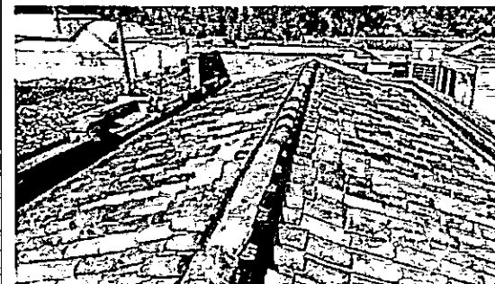
Mantenimiento cubierta y canoas
