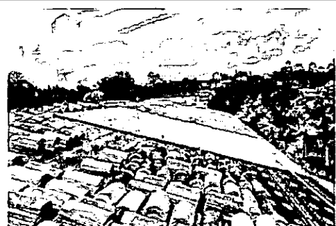
Mantenimiento de cubierta existente en teja de barro
