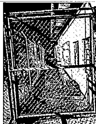
Instalación de ala puerta malla en estructura PTS
