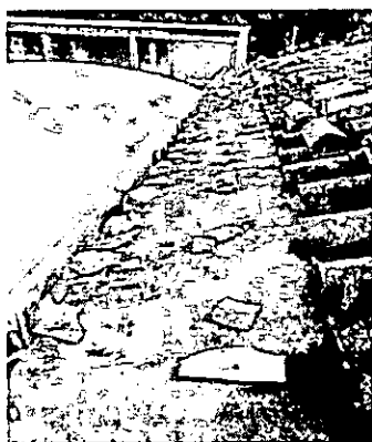
Mantenimiento de cubierta existente en teja de barro y de canoa
