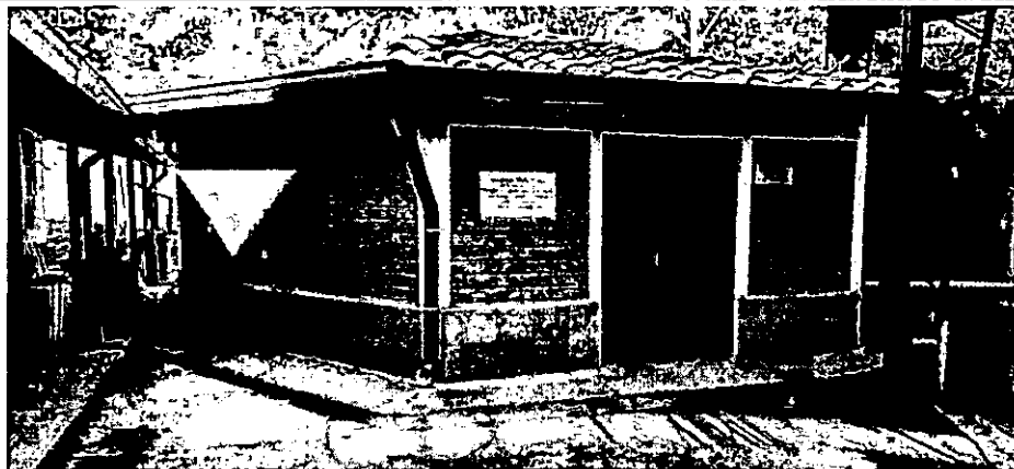
INSTALACIÓN CANOA, BAJANTE Y ZÓCALO EN TABLÓN
