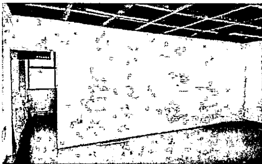
Muro en drywall con acabado doble cara
