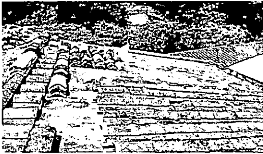
Mantenimiento de cubierta existente en teja de barro
