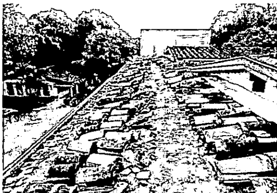
Mantenimiento de cubierta existente en teja de barro y de canoas
