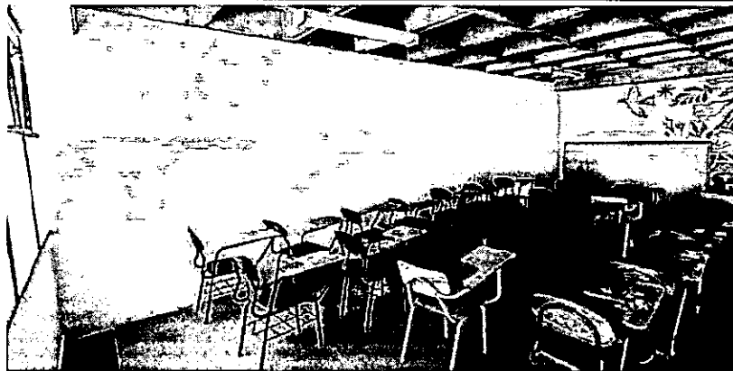
Muro en drywall con acabado doble cara
