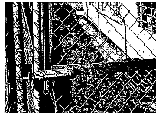
Instalación de ala puerta malla en estructura PTS
