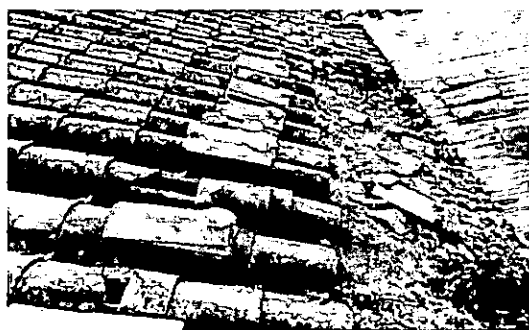
Mantenimiento de cubierta existente en teja de barro
