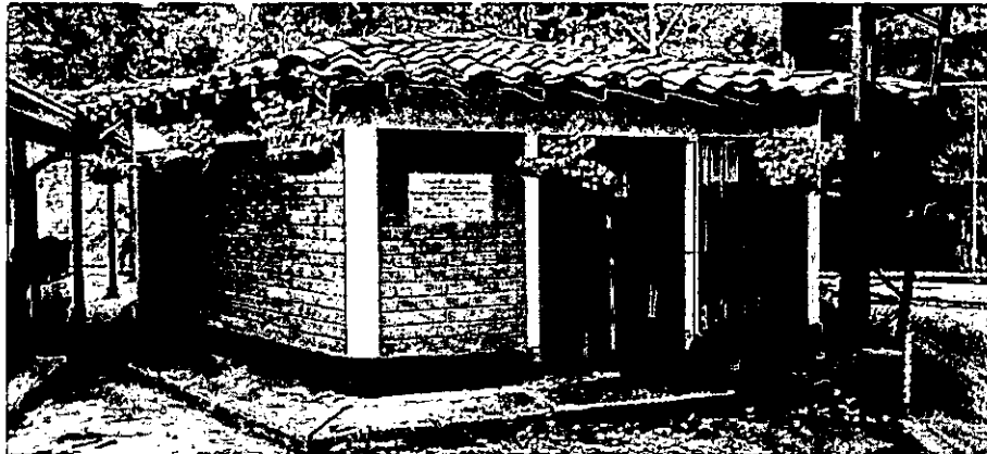
INSTALACIÓN CANOA, BAJANTE Y ZÓCALO EN TABLÓN
