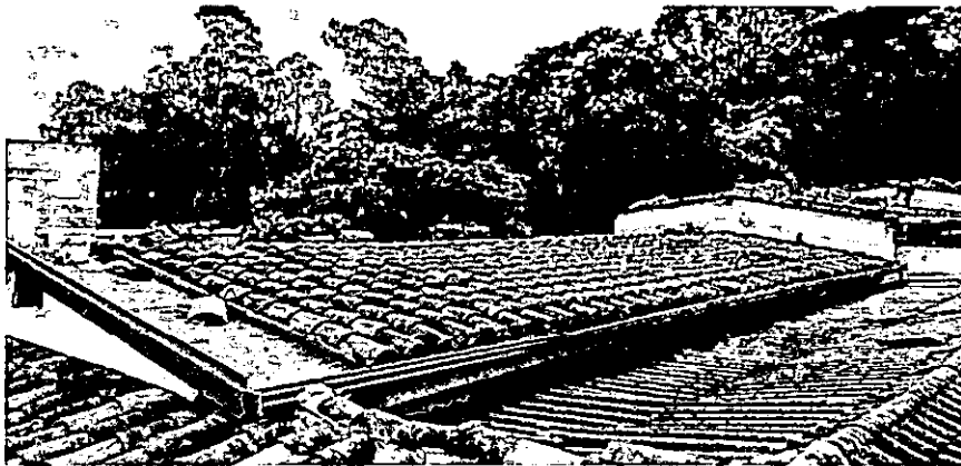
Mantenimiento de cubierta existente en teja de barro y retiro de canoas
