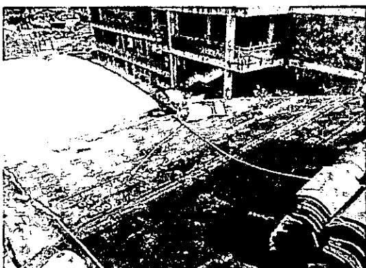
Mantenimiento de cubierta existente en teja de barro y de canoa
