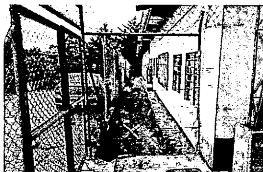
Instalación de ala puerta malla en estructura PTS
