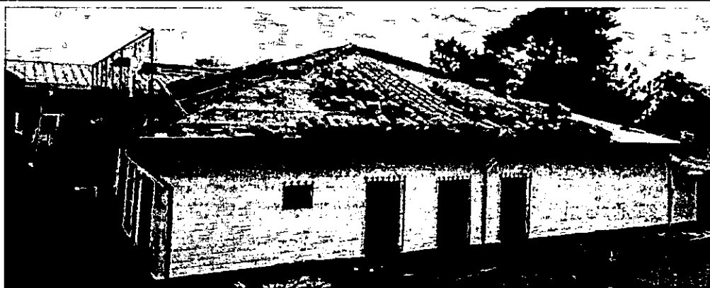
Mantenimiento de cubierta existente en teja de barro - Mantenimiento de canoa
