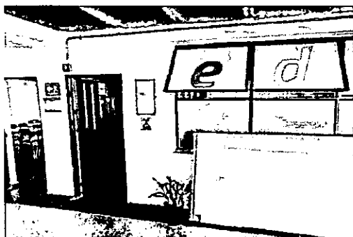
Muro en drywall con acabado doble cara
