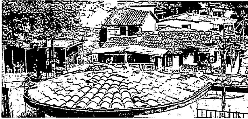
Mantenimiento de cubierta existente en teja de barro y de canoas
