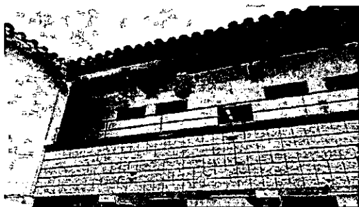
Mantenimiento de cubierta e instalación canoa "U" y bajantes
