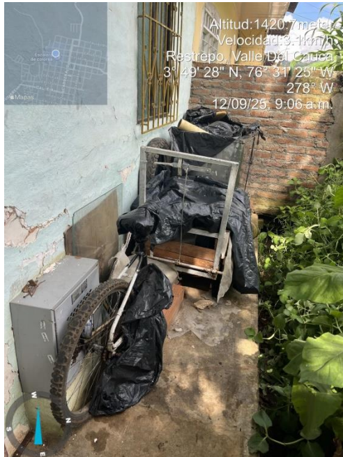
FOTO 11: VIVIENDA BARRIO LOS ALPES
