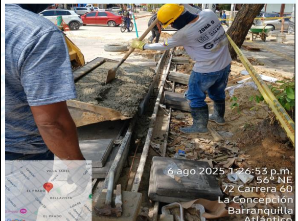
Instalación de bordillos.
