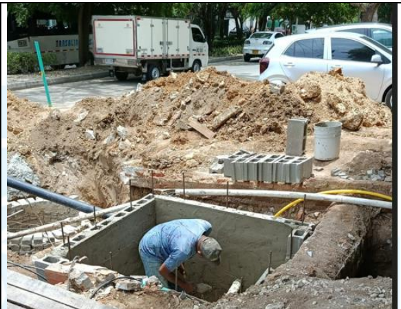
Construcción de registro común.
