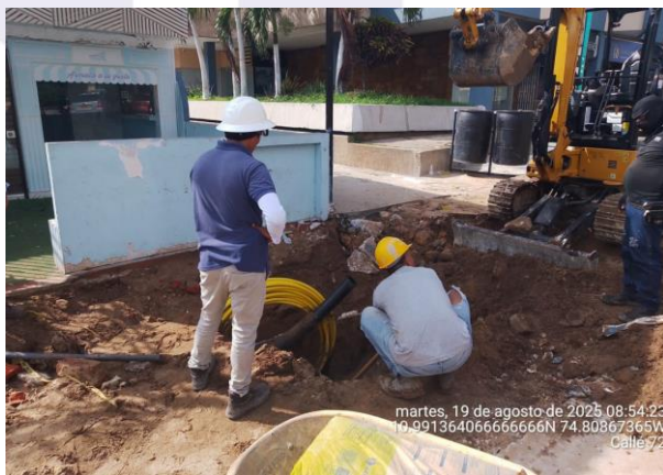
Excavación e instalación de red de gas 3/4".
