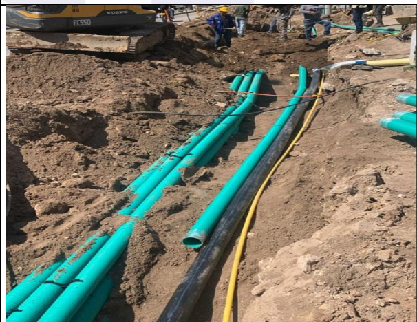
Excavación e instalación de tubería agua potable 110mm.
