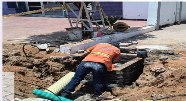
Construcción de registro sanitario
