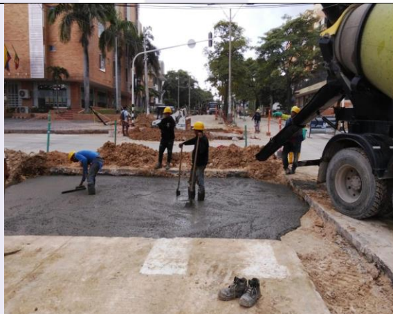
Vaciado de solado de cruces.
