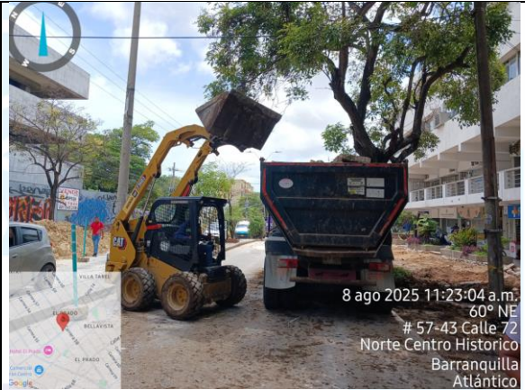
Retiro de RCD.
