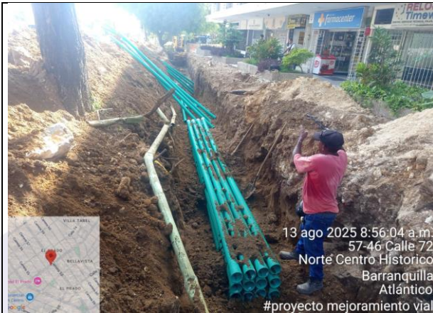
Excavación e instalación de ductos de telecomunicaciones.
