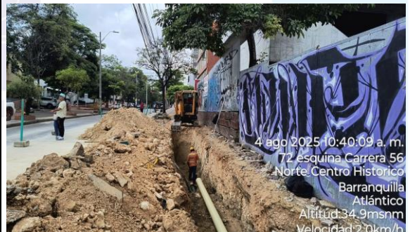
Excavación e instalación de tubería de alcantarillado.
