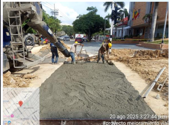
Vaciado de concreto de cruces.
