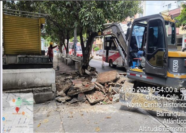
Demolición de espacio público.
