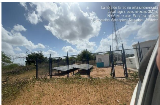
Fotografía 1. Sistema de potabilización de agua por medio de osmosis inversas en la comunidad de Elepelo.
