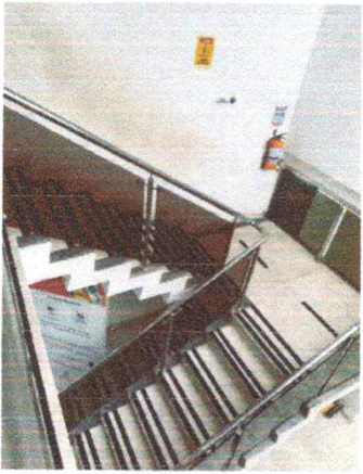
Suministro e instalación de cinta antideslizante para escaleras (alcaldía municipal y Crem) con el fin de contar con las rutas disponibles de evacuación en caso de incendio.
