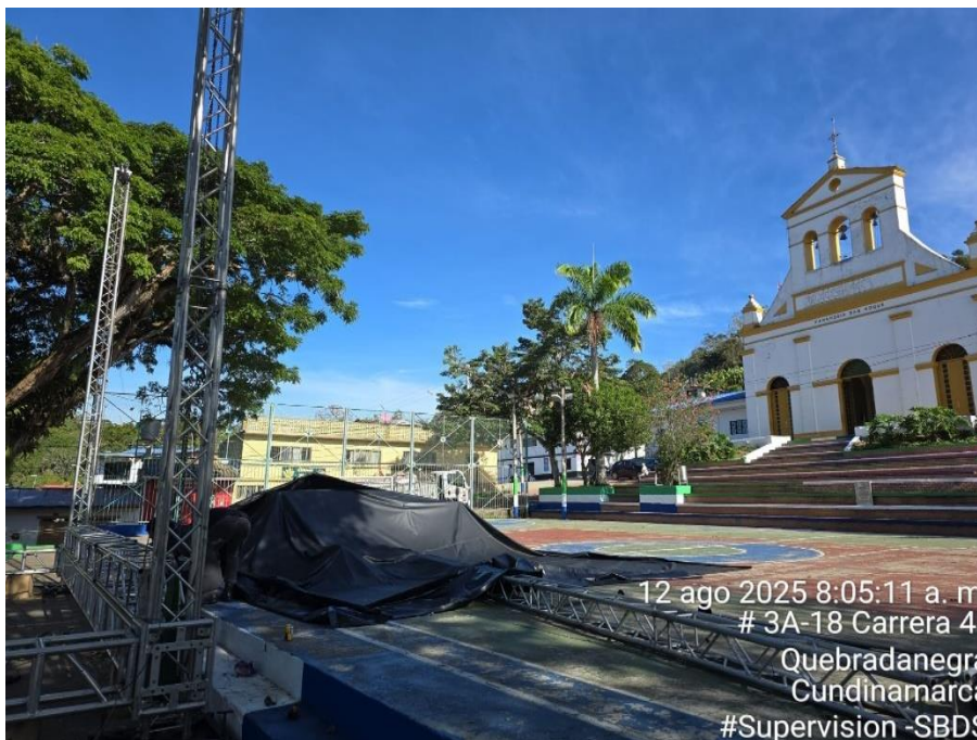
14 ago 2025 7:18:29 p. m. # 3-60 Carrera 4ª Quebradanegra Cundinamarca #Supervision -SBDS
