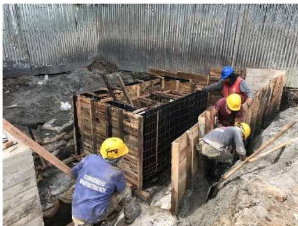
Fotografía No. 25. Preparación del terreno para vaciado de tanque anaerobio.
