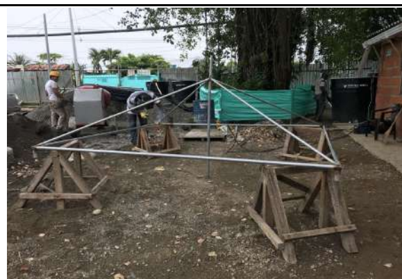
Construcción de estructura para carpas; cumplimiento protocolo bioseguridad
