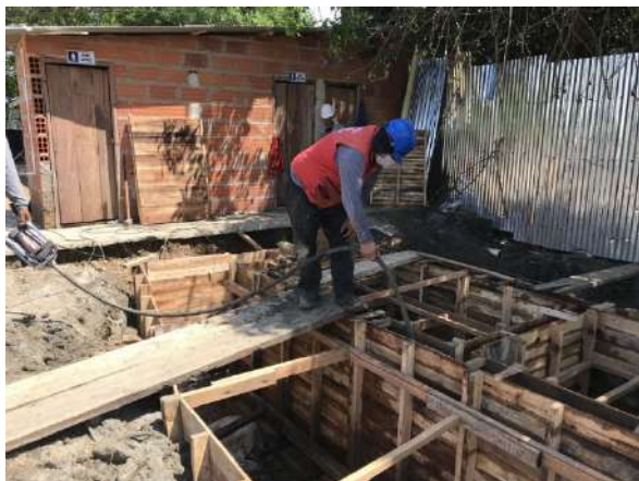
Fotografía No. 17. Vibrado de concreto.
