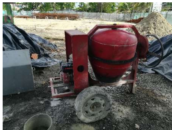
Fotografía No. 46. Manejo de maquinaria en obra, concretadora
