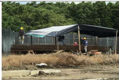
Armado de canastas para los barretes
