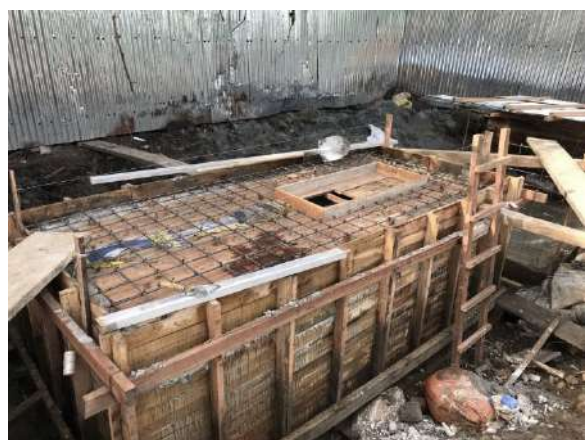
Fotografía No. 21. Colocación de refuerzo para losa de techo.
