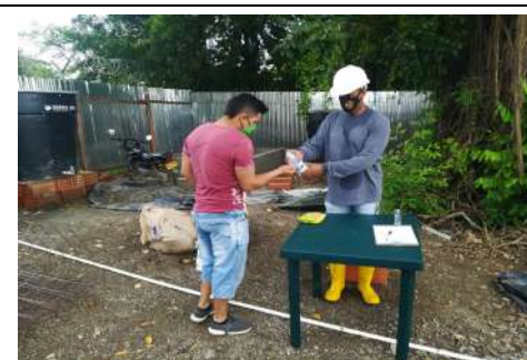
Desinfección de manos al entrar a la obra
