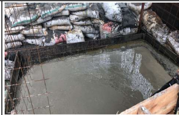
Losa de piso vaciada para tanque secundario de filtro anaerobio
