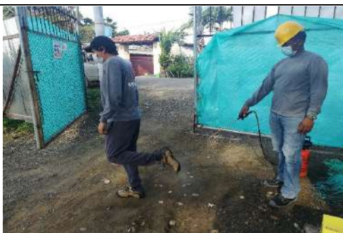
Desinfección de calzado al ingresar a la obra
