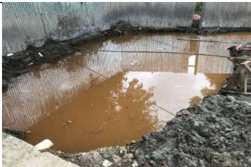
Estado de la excavación para el pozo séptico por falta de motobomba
