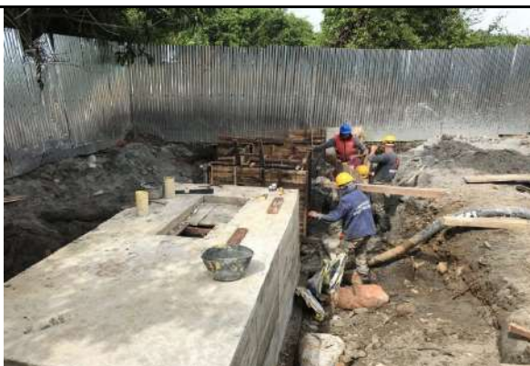
Formaletas para paredes tanque de filtro anaerobio
