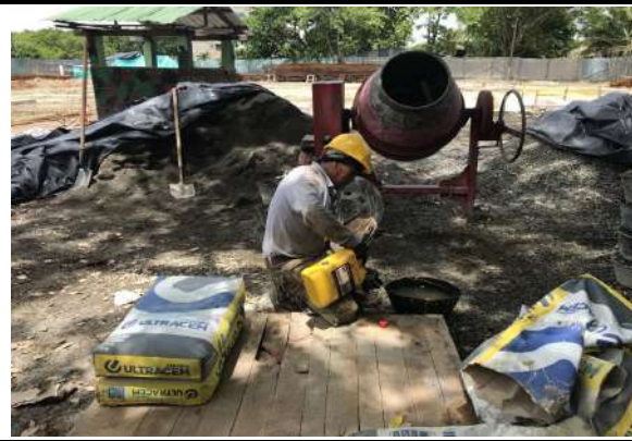
Adición de plastocrete para impermeabilización del concreto
