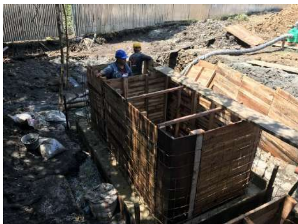
Fotografía No. 14. Formaleta muros interiores tanque de aguas residuales
