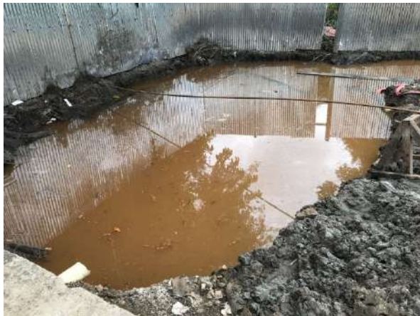
Fotografía No. 1. Excavación para pozo séptico anegado.
