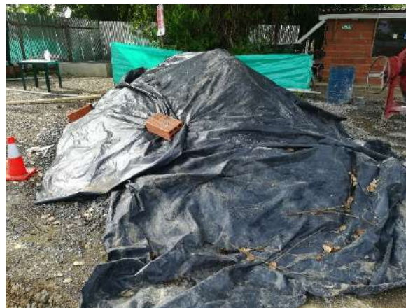
Fotografía No. 42. Control de emisiones atmosféricas.
