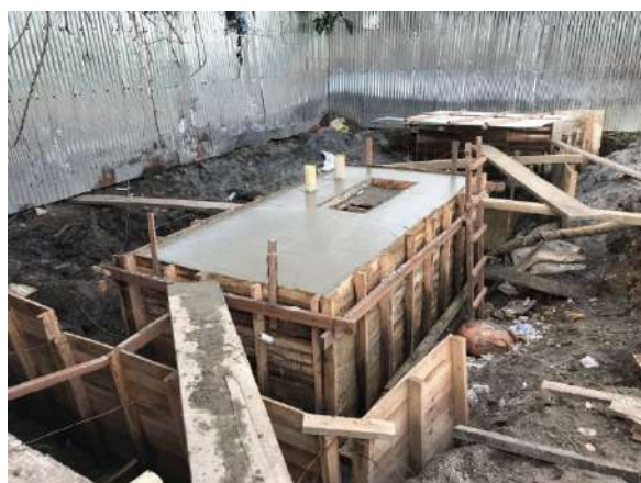
Fotografía No. 22. Losa de techo vaciada.
