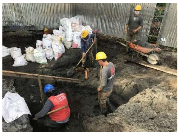
Fotografía No. 19. Excavación para tanque de filtro anaerobio.
