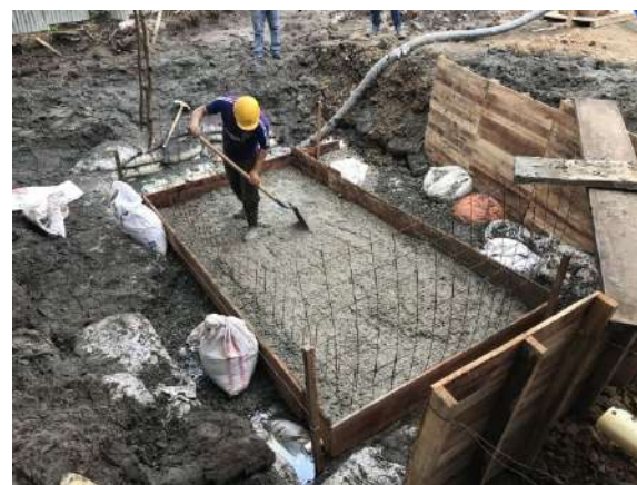
Fotografía No. 10. Losa de fondo con malla electrosoldada de refuerzo.
