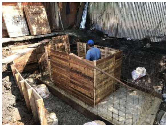
Fotografía No. 13. Formaleta para muros compartimiento N°1.
