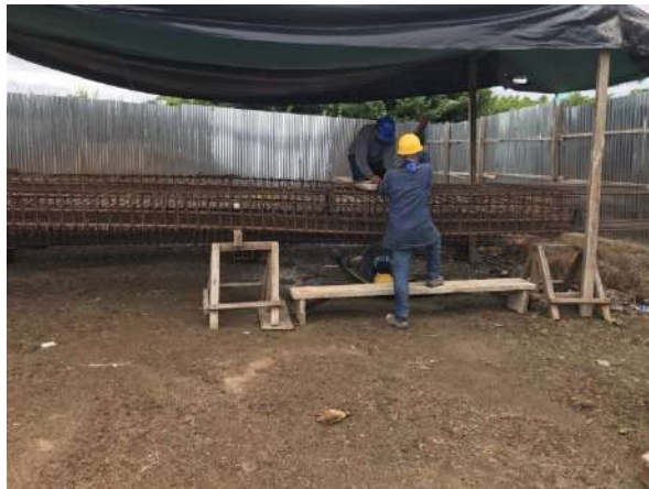
Fotografía No. 2. Armado de refuerzo para canastas de barretes para cimentación.
