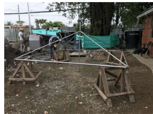
Fotografía No. 28. Estructura metálica para techo de carpa.
