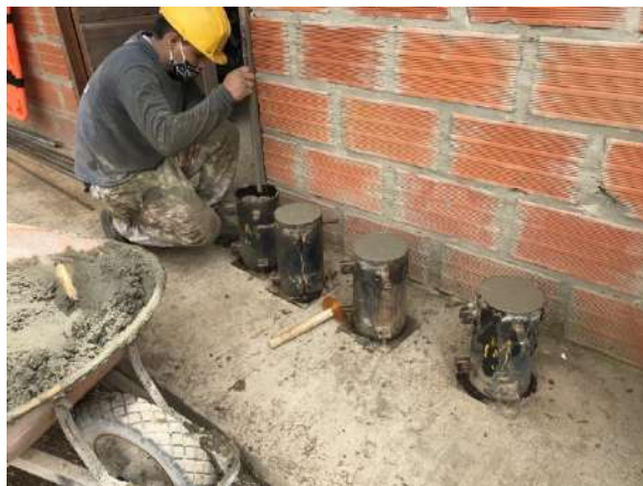
Fotografía No. 29. Cilindros de concreto para verificar resistencia
