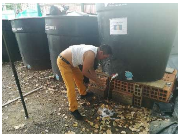
Fotografía No. 37. Lavado de manos al salir de la obra.
