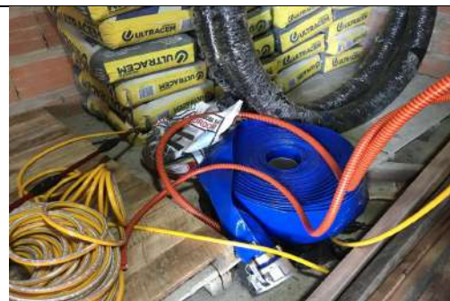
Manguera de 4" para el desalojo con la motobomba
