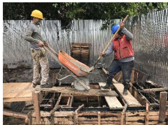
Fotografía No. 27. Vaciado de concreto para muros de tanque anaerobio.
