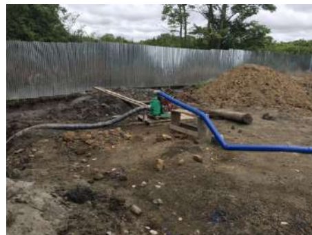
Fotografía No. 6. Motobomba de 11HP para bombeo de agua de la excavación del pozo séptico
