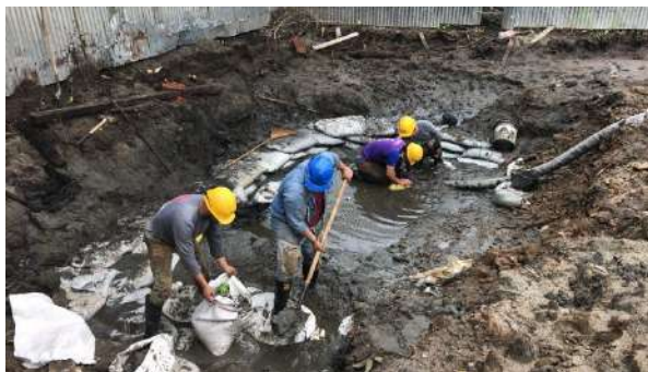
Fotografía No. 5. Manejo de aguas y preparación de piso para tanque séptico.
