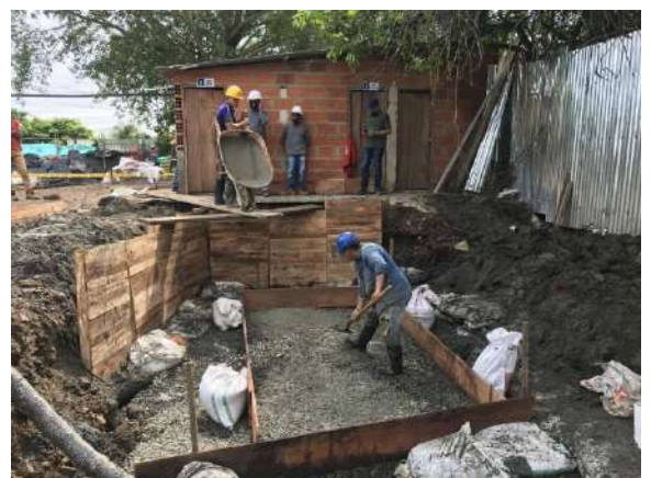
Fotografía No. 9. Vaciado de losa de fondo tanque para aguas residuales.
