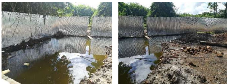
Fotografía No. 1. Estado actual zona de construcción pozo séptico.
