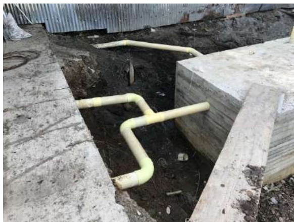
Fotografía No. 31. Tubería de 4\"/>
