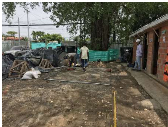
Fotografía No. 24. Tubería para reparación de carpas para protocolo de bioseguridad.
