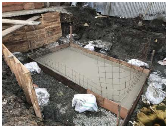
Fotografía No. 12. Losa de fondo vaciada y terminada.
