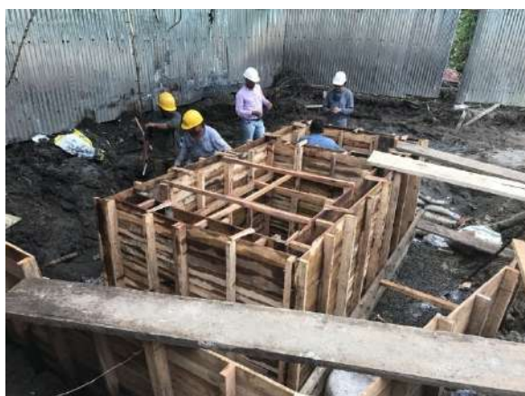
Fotografía No. 15. Muros formaleteados para tanque séptico.
