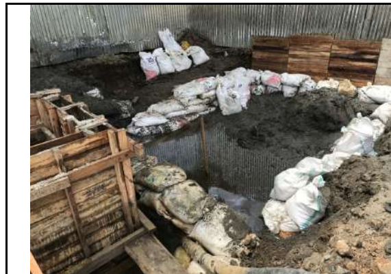
Excavación para tanque de filtrado
