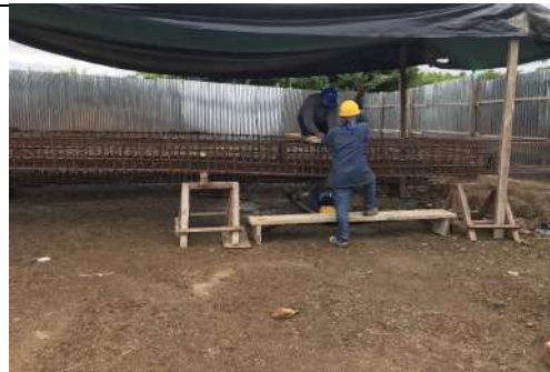
Armado de canastas para los barretes
