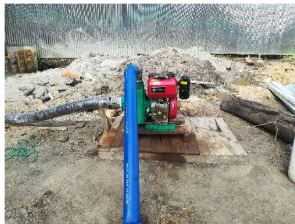
Fotografía No. 44. Manejo de maquinaria en obra, motobomba 11HP
