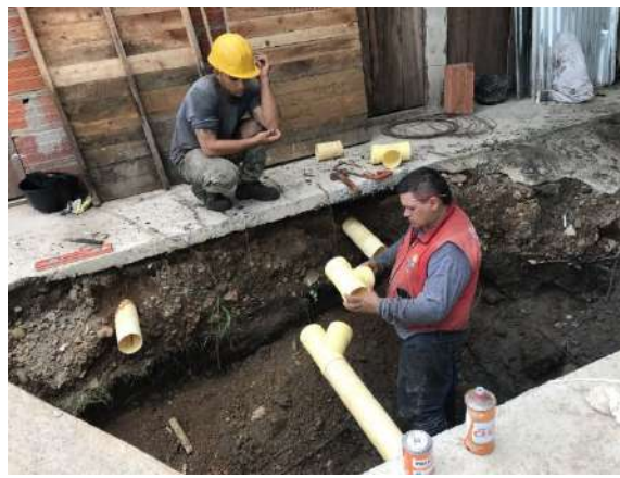
Fotografía No. 30. Colocación de tubería sanitaria para conectar las unidades sanitarias al pozo séptico.
