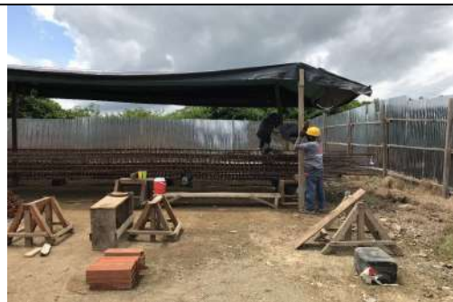
Armado de canastas para los barretes
