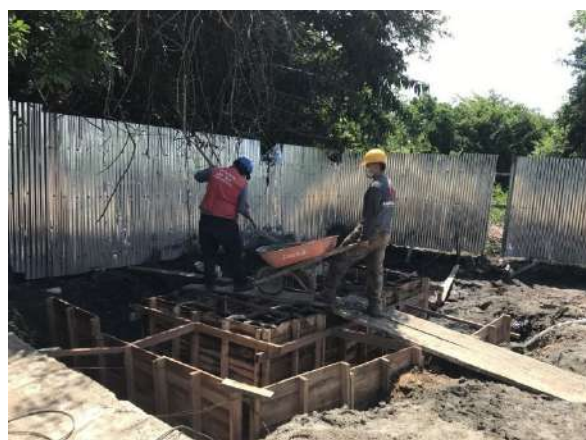
Fotografía No. 16. Vaciado de concreto para muros
