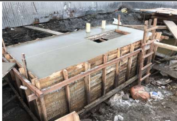
Losa superior tanque primario pozo séptico
