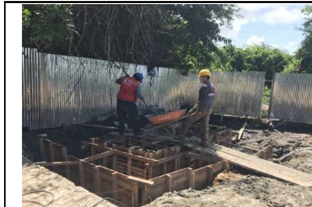
Vaciado de muros de pozo séptico
