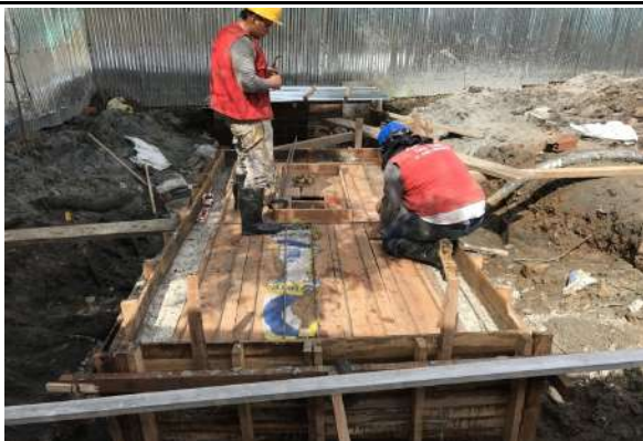
Armado de falso fondo para vaciado de losa superior
