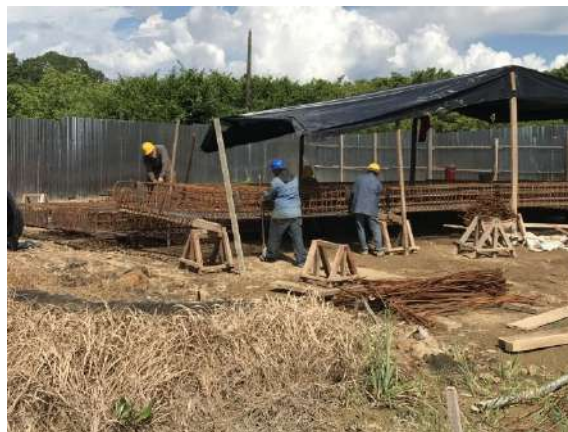
Fotografía No. 4. Armado de refuerzo para canastas de barretes para cimentación.
