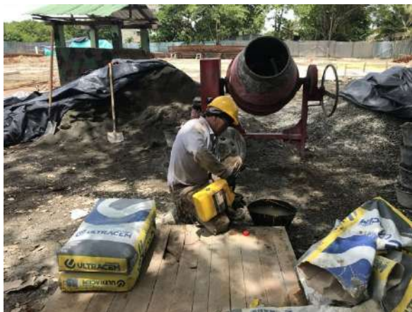
Fotografía No. 18. Adición de plastocrete para impermeabilizar el tanque.
