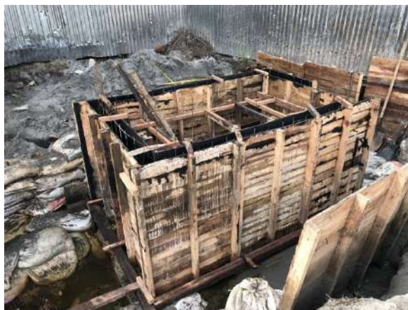
Fotografía No. 26. Muros formateados para vaciado de tanque anaerobio.
