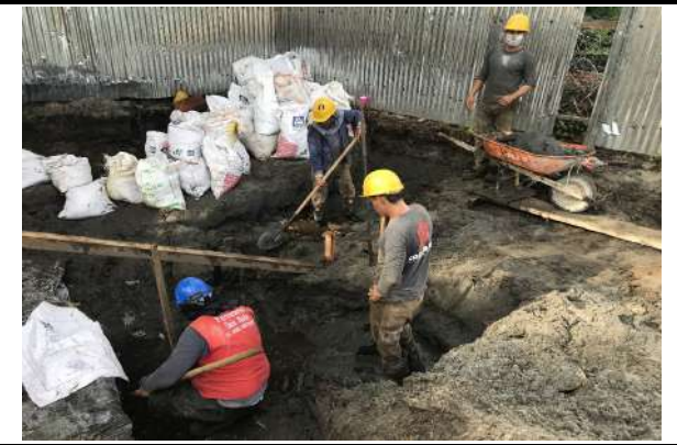
Excavación para tanque de filtrado
