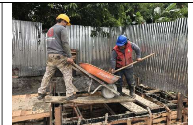
Vaciado losa superior tanque de filtro anaerobio
