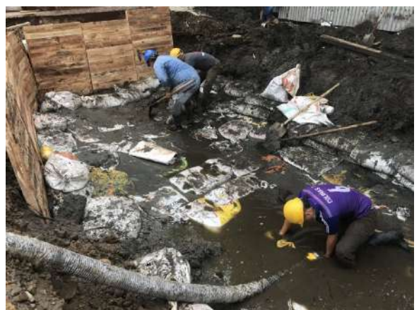
Fotografía No. 7. Preparación de piso con costales de arena para losa de fondo.
