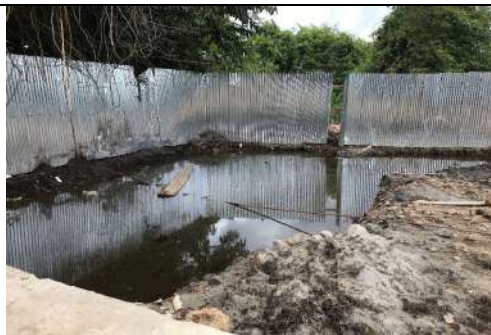
Estado de la excavación para el pozo séptico de las instalaciones provisionales
