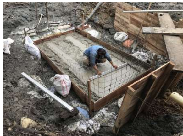
Fotografía No. 11. Pulido y nivelado de losa de fondo para tanque de aguas residuales.
