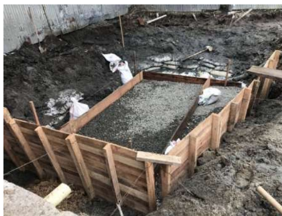
Fotografía No. 8. Cama de triturado para vaciar la losa de fondo del tanque
