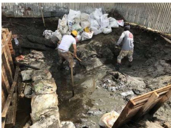
Fotografía No. 20. Excavación y llenado de costales con arena.
