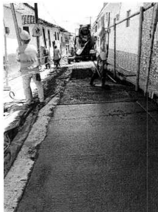
Foto N° 63: Vibreador de concreto Foto N° 64: Mixer para vaciado de concreto
