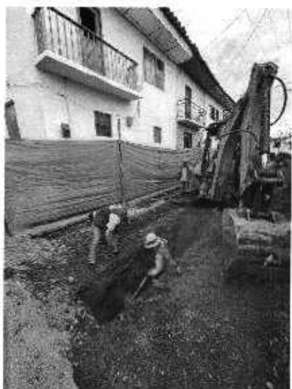
Foto N° 7: Excavación para tubería central Foto N° 8: Excavación para tubería central
