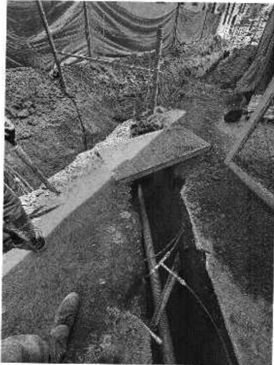
Foto N° 19: Instalación de tubería de 6" Foto N° 20: Instalación de tubería de 6"
