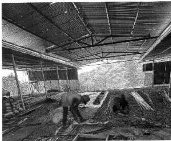
Foto N° 70: Transporte de acero de refuerzo 60000 psi
