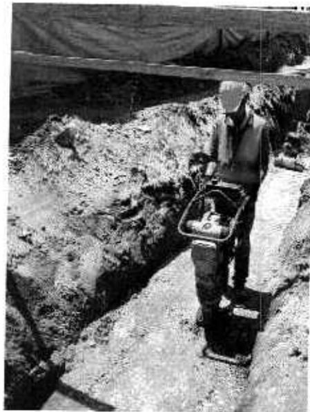
Foto N° 14: Compactación con canguro
