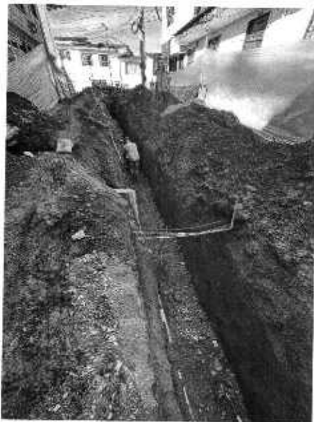
Foto N° 15: Lleno con material de préstamo
