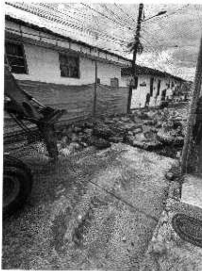
Foto N° 5: Demolición de vía a intervenir
