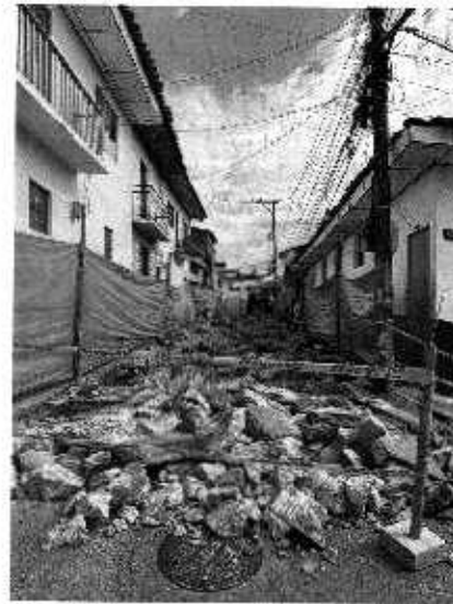
Foto N° 6: Demolición de vía a intervenir
