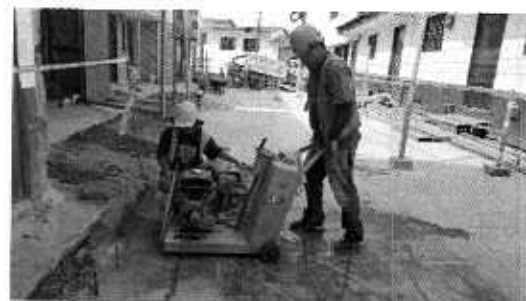
Foto N° 36: Corte de pavimento
