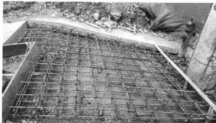
Foto N° 37: Acero de refuerzo en zona irregular
