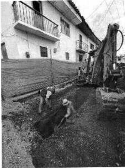
Foto N° 57: Retroexcavadora para brecha principal Foto N° 58: Entibado en madera
