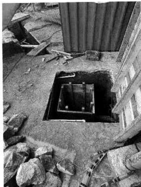
Foto N° 59: Formaleta metálica para recámara Foto N° 60: Formaleta en madera para cajas de inspección
