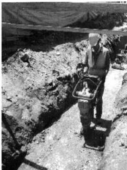
Foto N° 61: Canguro para compactación Foto N° 62: Rana para compactación
