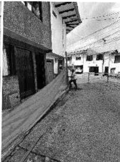
Foto N° 4: Instalación de cerramiento con yute
