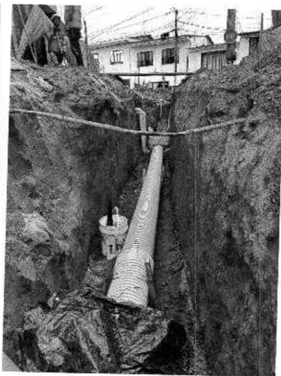
Foto N° 21: Instalación de tubería de 12" Foto N° 22: Instalación de tubería de 12"
