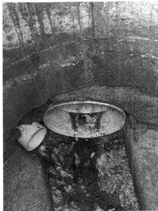
Foto N° 27: Empalme a recámara existente Cra 4 Foto N° 28: Empalme a recámara existente Cra 4
