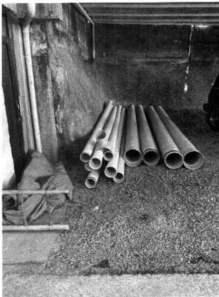
Foto N° 73: Almacenamiento de tubería Alcantarillado
