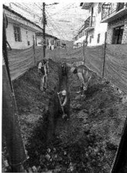
Foto N° 7: Excavación para tubería central Foto N° 8: Excavación para tubería central
