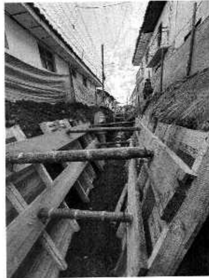
Foto N° 57: Retroexcavadora para brecha principal Foto N° 58: Entibado en madera
