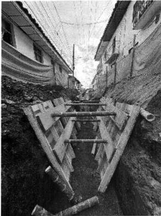
Foto N° 29: Entibado en excavación central
