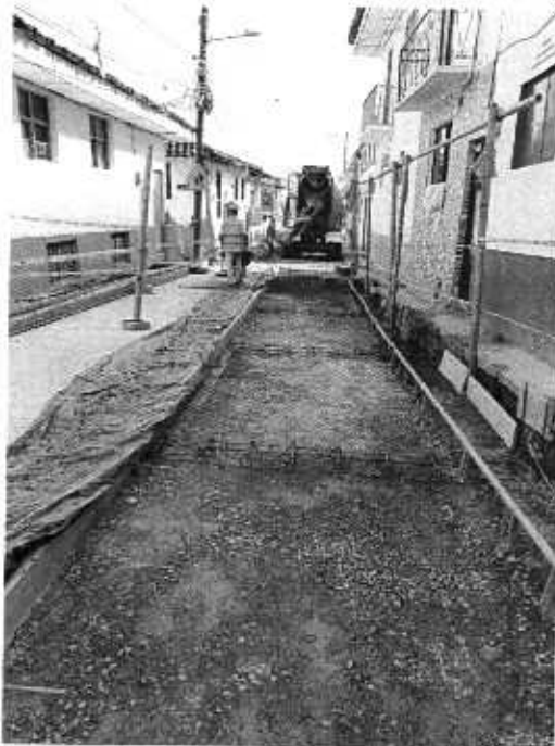
Foto N° 33: Vaciado de concreto para cámara
