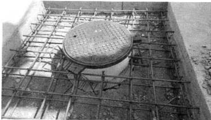
Foto N° 37: Acero de refuerzo en zona irregular
