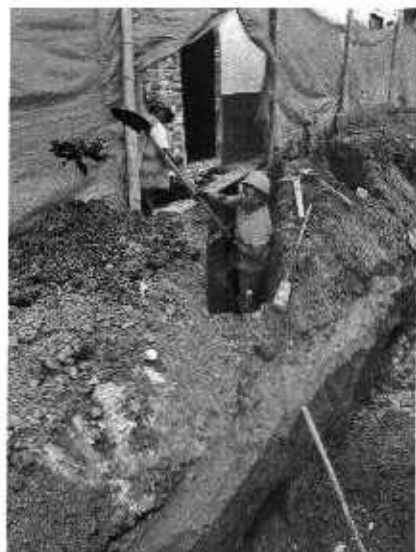
Foto N° 9: Excavación tubería domiciliaria Foto N° 10: Excavación tubería domiciliaria
