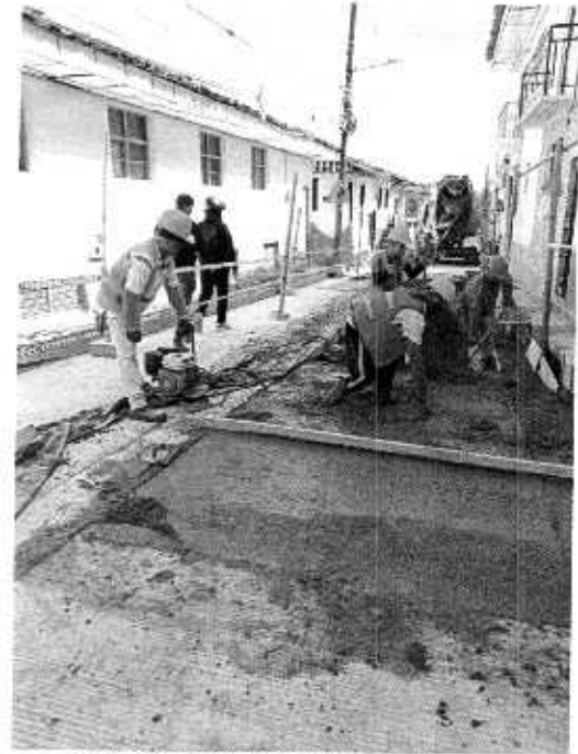
Foto N° 34: Concreto premezclado
