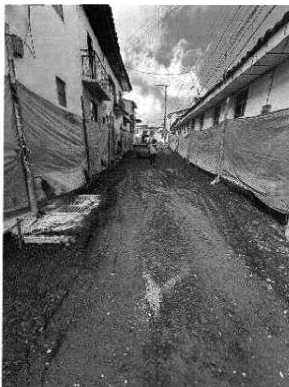
Foto N° 31 y 32: Suministro e instalación de la Base Granular
