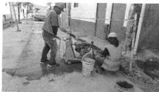
Foto N° 35: Corte de pavimento
