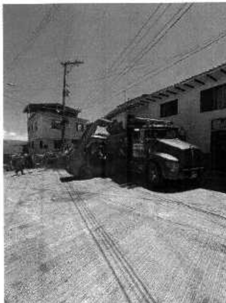
Foto N° 69: Transporte de material sobrante (Escombros y material de la excavación)
