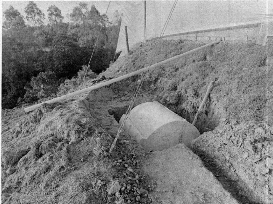
Se realiza revisión a la instalación del pozo séptico
