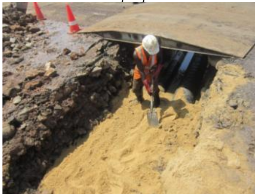
Fotografía 4 Ejemplo de zanjado a cielo abierto
