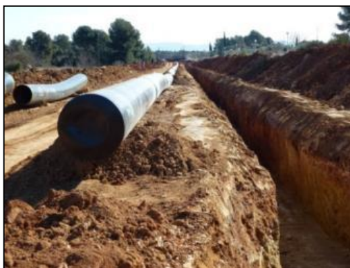
Fotografía 1 Zanja Tipo para la Instalación del Gasoducto
