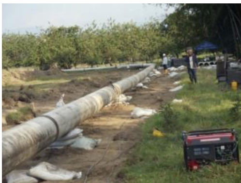
Fotografía 3 Tendido de Tubería, Alineamiento y Soldadura
