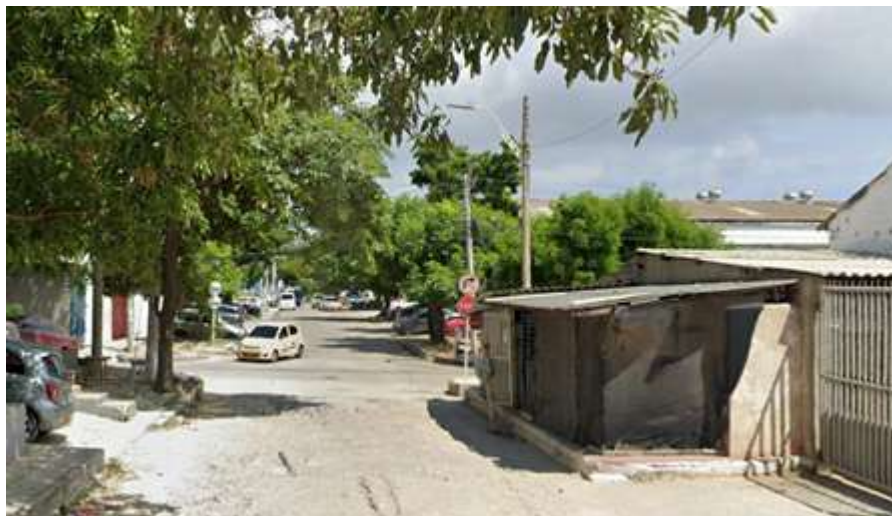
Figura 1 Estado de la carrera 74 con calle
