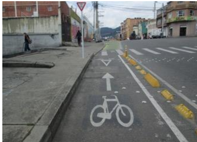
Ilustración 2- Bordillos no traspasables e hitos segregando el tránsito
