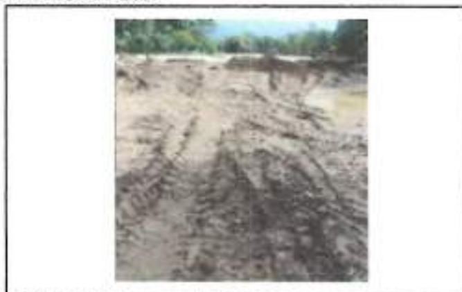
FOTOGRAFIA 1. FECHA DE TOMA: 13-09-25 ITEM 4: RETROEXCAVADORA CARGADORA DE LLANTAS TIPO PAJARITA JD340 O EQUIVALENTE INCLUYE OPERADOR Y COMBUSTIBLE
