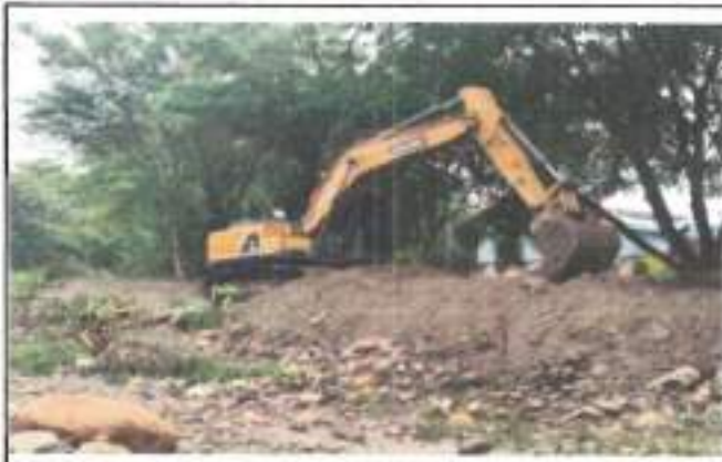
FOTOGRAFIA 1. FECHA DE TOMA: 15-08-25 ITEM 1: RETROEXCAVADORA 20 T O SIM. INC. OPE Y COMB
