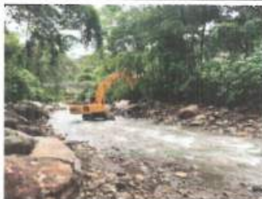
FOTOGRAFIA 2. FECHA DE TOMA: 30-08-25 ITEM 1: RETROEXCAVADORA 20 T O SIM. INC. OPE Y COMB
