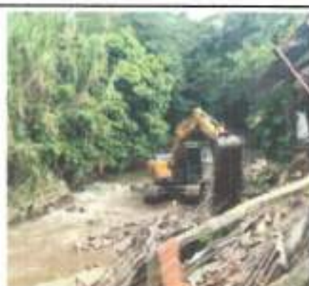
FOTOGRAFIA 4. FECHA DE TOMA: 06-09-25 ITEM 1: RETROEXCAVADORA 20 T O SIM. INC. OPE Y COMB
