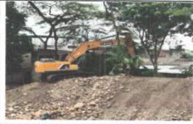
FOTOGRAFIA 1. FECHA DE TOMA: 21-08-25 ITEM 1: RETROEXCAVADORA 20 T O SIM. INC. OPE Y COMB
