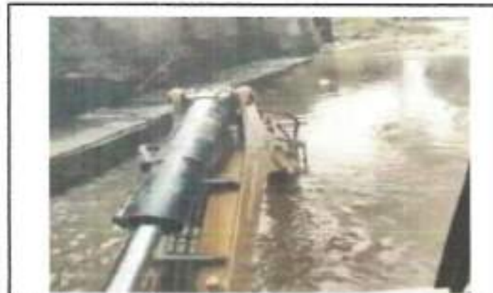
FOTOGRAFIA 2. FECHA DE TOMA: 09-09-25 ITEM 4: RETROEXCAVADORA CARGADORA DE LLANTAS TIPO PAJARITA JD340 O EQUIVALENTE INCLUYE OPERADOR Y COMBUSTIBLE
