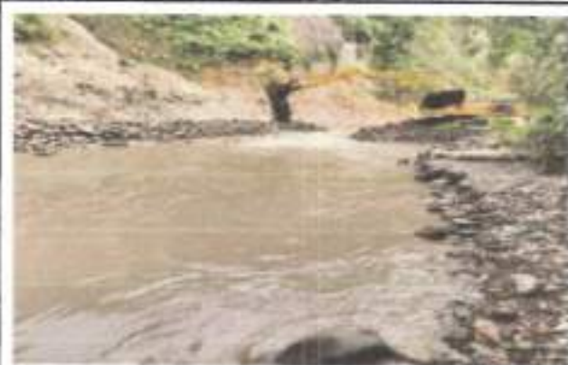
FOTOGRAFIA 1. FECHA DE TOMA: 30-08-25 ITEM 1: RETROEXCAVADORA 20 T O SIM. INC. OPE Y COMB
