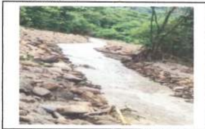
FOTOGRAFIA 3. FECHA DE TOMA: 04-09-25 ITEM 1: RETROEXCAVADORA 20 T O SIM. INC. OPE Y COMB
