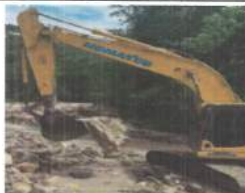
FOTOGRAFIA 4. FECHA DE TOMA: 11-09-25 ITEM 1: RETROEXCAVADORA 20 T O SIM. INC. OPE Y COMB
