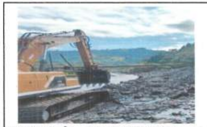
FOTOGRAFIA 4. FECHA DE TOMA: 15-09-25 ITEM 1: RETROEXCAVADORA 20 T O SIM. INC. OPE Y COMB
