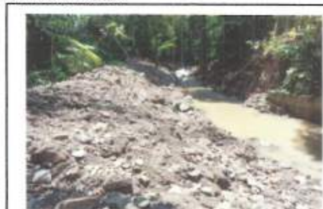
FOTOGRAFIA 3. FECHA DE TOMA: 10-09-25 ITEM 4: RETROEXCAVADORA CARGADORA DE LLANTAS TIPO PAJARITA JD340 O EQUIVALENTE INCLUYE OPERADOR Y COMBUSTIBLE
