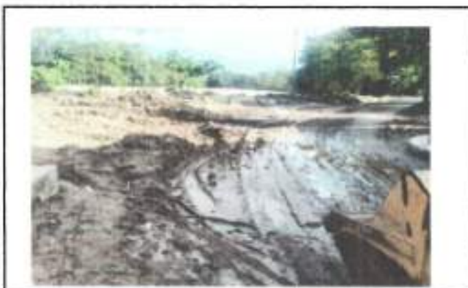
FOTOGRAFIA 2. FECHA DE TOMA: 14-09-25 ITEM 4: RETROEXCAVADORA CARGADORA DE LLANTAS TIPO PAJARITA JD340 O EQUIVALENTE INCLUYE OPERADOR Y COMBUSTIBLE
