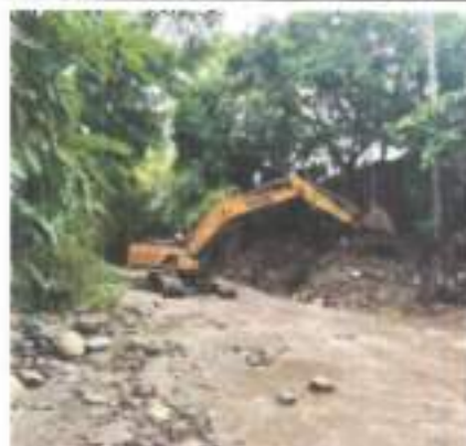
FOTOGRAFIA 2. FECHA DE TOMA: 05-09-25 ITEM 1: RETROEXCAVADORA 20 T O SIM. INC. OPE Y COMB
