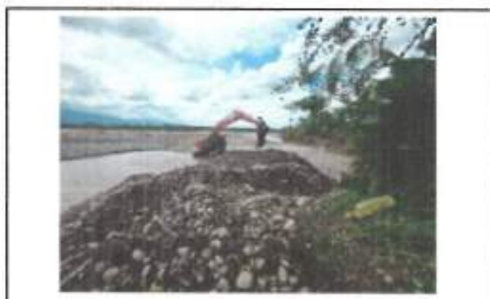
FOTOGRAFIA 4. FECHA DE TOMA: 24-08-25 ITEM 1: RETROEXCAVADORA 20 T O SIM. INC. OPE Y COMB
