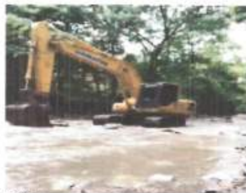
FOTOGRAFIA 4. FECHA DE TOMA: 01-09-25 ITEM 1: RETROEXCAVADORA 20 T O SIM. INC. OPE Y COMB
