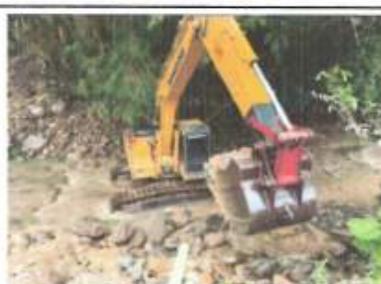
FOTOGRAFIA 4. FECHA DE TOMA: 22-08-25 ITEM 1: RETROEXCAVADORA 20 T O SIM. INC. OPE Y COMB
