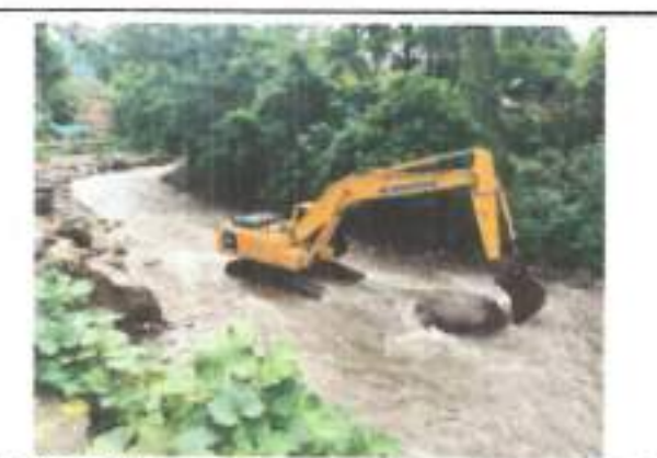
FOTOGRAFIA 4. FECHA DE TOMA: 28-08-25 ITEM 1: RETROEXCAVADORA 20 T O SIM. INC. OPE Y COMB
