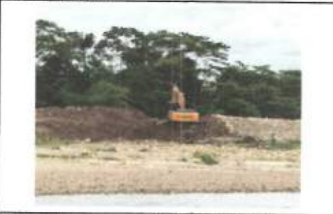
FOTOGRAFIA 3. FECHA DE TOMA: 13-09-25 ITEM 1: RETROEXCAVADORA 20 T O SIM. INC. OPE Y COMB
