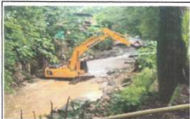
FOTOGRAFIA 1. FECHA DE TOMA: 20-08-25 ITEM 1: RETROEXCAVADORA 20 T O SIM. INC. OPE Y COMB
