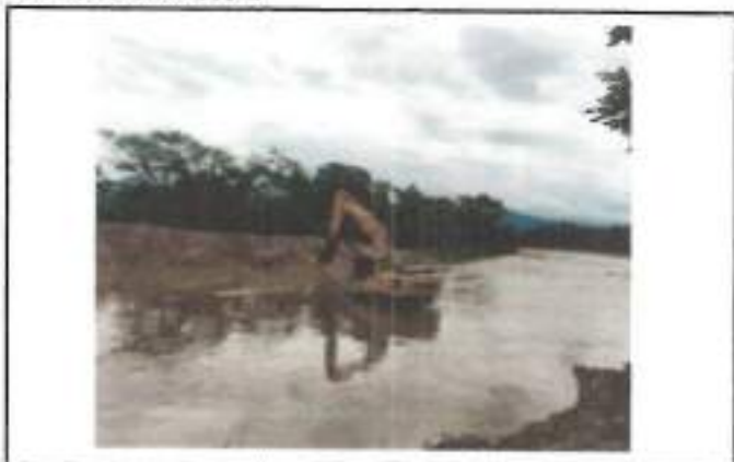
FOTOGRAFIA 1. FECHA DE TOMA: 14-09-25 ITEM 1: RETROEXCAVADORA 20 T O SIM. INC. OPE Y COMB
