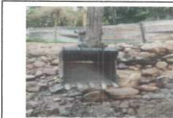
FOTOGRAFIA 3. FECHA DE TOMA: 09-09-25 ITEM 1: RETROEXCAVADORA 20 T O SIM. INC. OPE Y COMB
