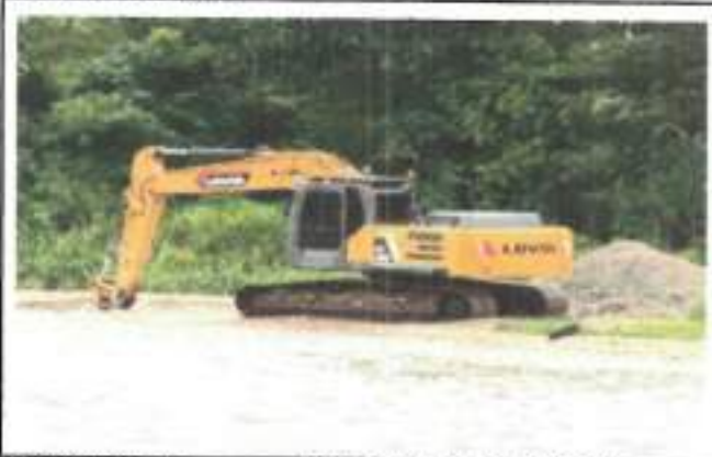
FOTOGRAFIA 1. FECHA DE TOMA: 10-09-25 ITEM 1: RETROEXCAVADORA 20 T O SIM. INC. OPE Y COMB
