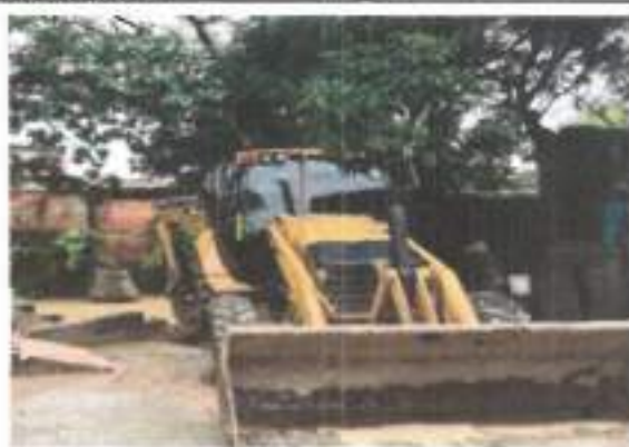
FOTOGRAFIA 1. FECHA DE TOMA: 21-08-25 ITEM 4: RETROEXCAVADORA CARGADORA DE LLANTAS TIPO PAJARITA JD340 O EQUIVALENTE INCLUYE OPERADOR Y COMBUSTIBLE
