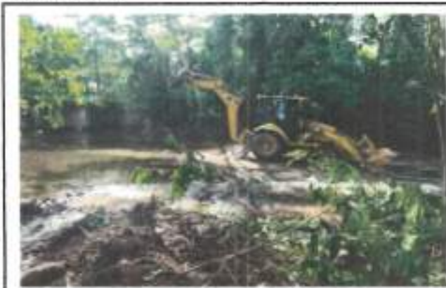
FOTOGRAFIA 1. FECHA DE TOMA: 17-08-25 ITEM 4: RETROEXCAVADORA CARGADORA DE LLANTAS TIPO PAJARITA JD340 O EQUIVALENTE INCLUYE OPERADOR Y COMBUSTIBLE
