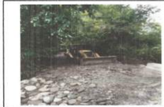
FOTOGRAFIA 4. FECHA DE TOMA: 20-08-25 ITEM 4: RETROEXCAVADORA CARGADORA DE LLANTAS TIPO PAJARITA JD340 O EQUIVALENTE INCLUYE OPERADOR Y COMBUSTIBLE
