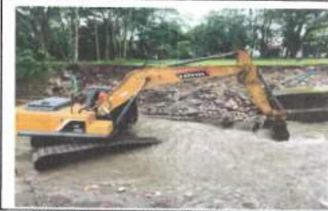
FOTOGRAFIA 1. FECHA DE TOMA: 27-08-25 ITEM 1: RETROEXCAVADORA 20 T O SIM. INC. OPE Y COMB
