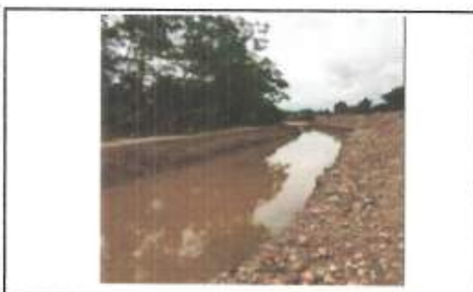
FOTOGRAFIA 2. FECHA DE TOMA: 14-09-25 ITEM 1: RETROEXCAVADORA 20 T O SIM. INC. OPE Y COMB
