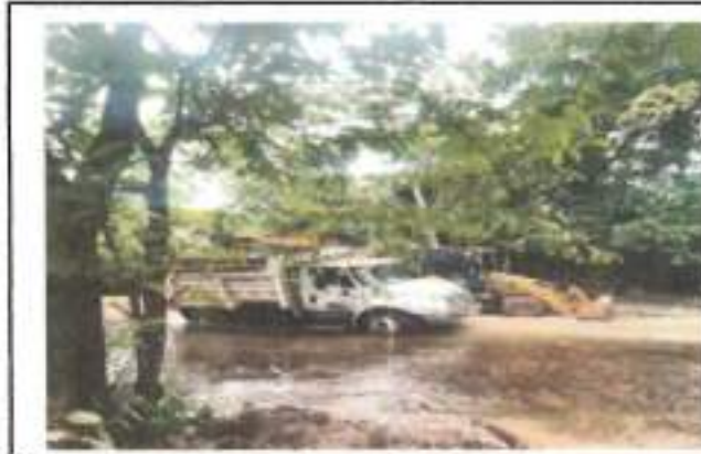
FOTOGRAFIA 3. FECHA DE TOMA: 19-08-25 ITEM 4: RETROEXCAVADORA CARGADORA DE LLANTAS TIPO PAJARITA JD340 O EQUIVALENTE INCLUYE OPERADOR Y COMBUSTIBLE
