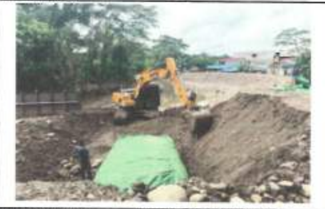
FOTOGRAFIA 3. FECHA DE TOMA: 25-08-25 ITEM 1: RETROEXCAVADORA 20 T O SIM. INC. OPE Y COMB
