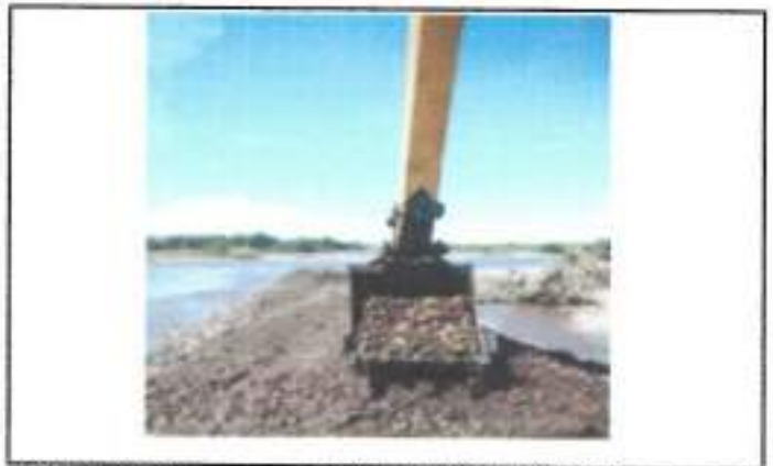
FOTOGRAFIA 4. FECHA DE TOMA: 31-08-25 ITEM 1: RETROEXCAVADORA 20 T O SIM. INC. OPE Y COMB
