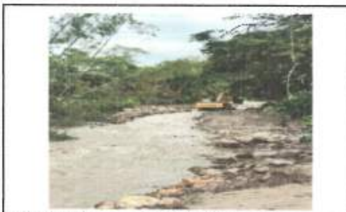
FOTOGRAFIA 2. FECHA DE TOMA: 03-09-25 ITEM 1: RETROEXCAVADORA 20 T O SIM. INC. OPE Y COMB
