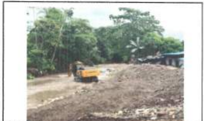
FOTOGRAFIA 2. FECHA DE TOMA: 23-08-25 ITEM 1: RETROEXCAVADORA 20 T O SIM. INC. OPE Y COMB
