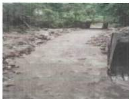
FOTOGRAFIA 2. FECHA DE TOMA: 08-09-25 ITEM 1: RETROEXCAVADORA 20 T O SIM. INC. OPE Y COMB
