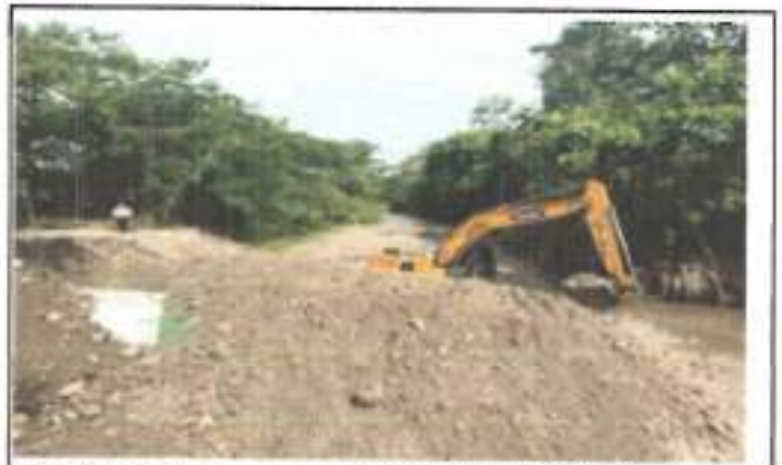
FOTOGRAFIA 4. FECHA DE TOMA: 26-08-25 ITEM 1: RETROEXCAVADORA 20 T O SIM. INC. OPE Y COMB
