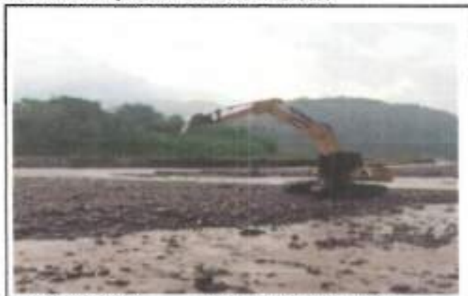
FOTOGRAFIA 3. FECHA DE TOMA: 14-09-25 ITEM 1: RETROEXCAVADORA 20 T O SIM. INC. OPE Y COMB
