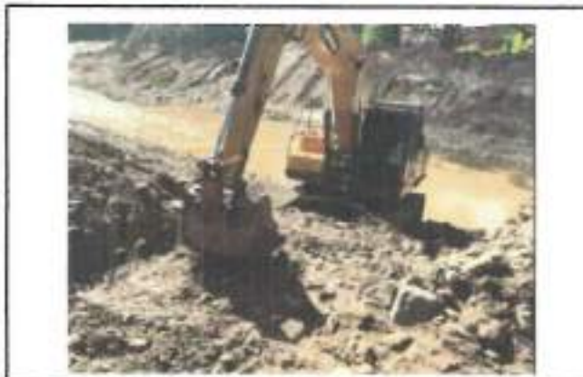
FOTOGRAFIA 4. FECHA DE TOMA: 20-08-25 ITEM 1: RETROEXCAVADORA 20 T O SIM. INC. OPE Y COMB
