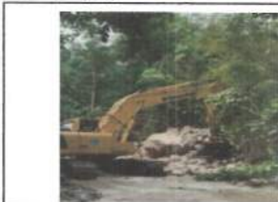
FOTOGRAFIA 1. FECHA DE TOMA: 07-09-25 ITEM 1: RETROEXCAVADORA 20 T O SIM. INC. OPE Y COMB
