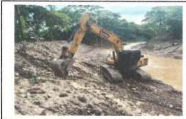
FOTOGRAFIA 3. FECHA DE TOMA: 20-08-25 ITEM 1: RETROEXCAVADORA 20 T O SIM. INC. OPE Y COMB
