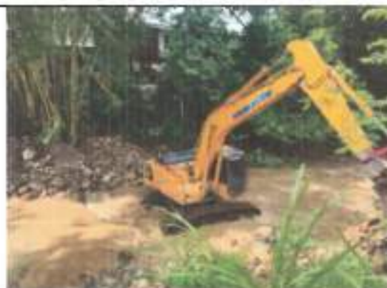
FOTOGRAFIA 2. FECHA DE TOMA: 21-08-25 ITEM 1: RETROEXCAVADORA 20 T O SIM. INC. OPE Y COMB
