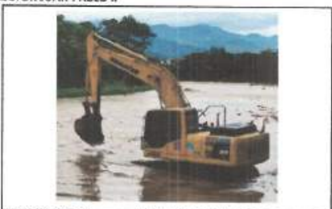
FOTOGRAFIA 3. FECHA DE TOMA: 16-08-25 ITEM 1: RETROEXCAVADORA 20 T O SIM. INC. OPE Y COMB
