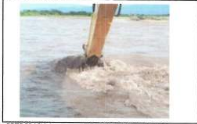
FOTOGRAFIA 1. FECHA DE TOMA: 17-08-25 ITEM 1: RETROEXCAVADORA 20 T O SIM. INC. OPE Y COMB
