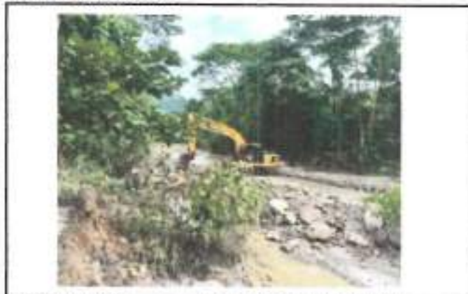
FOTOGRAFIA 1. FECHA DE TOMA: 02-09-25 ITEM 1: RETROEXCAVADORA 20 T O SIM. INC. OPE Y COMB
