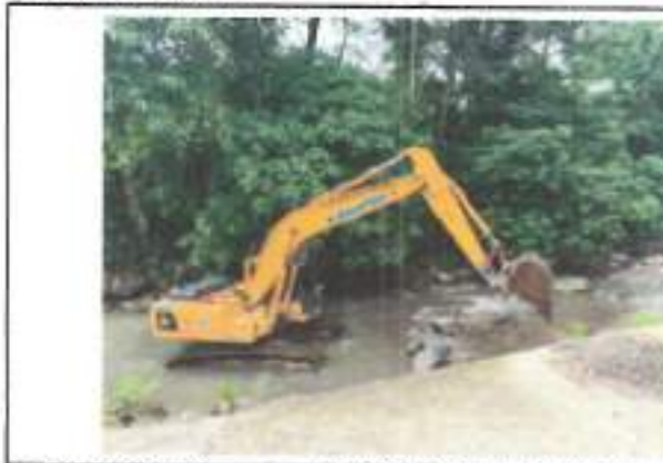
FOTOGRAFIA 3. FECHA DE TOMA: 27-08-25 ITEM 1: RETROEXCAVADORA 20 T O SIM. INC. OPE Y COMB
