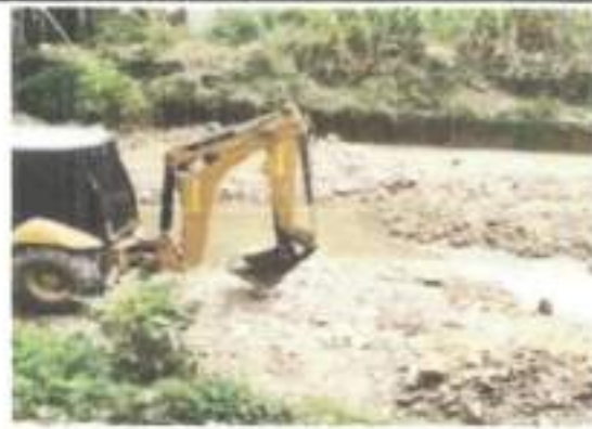
FOTOGRAFIA 4. FECHA DE TOMA: 24-08-25 ITEM 4: RETROEXCAVADORA CARGADORA DE LLANTAS TIPO PAJARITA JD340 O EQUIVALENTE INCLUYE OPERADOR Y COMBUSTIBLE
