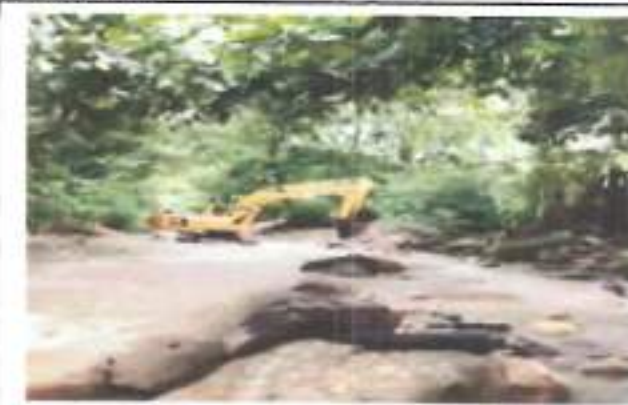
FOTOGRAFIA 3. FECHA DE TOMA: 31-08-25 ITEM 1: RETROEXCAVADORA 20 T O SIM. INC. OPE Y COMB
