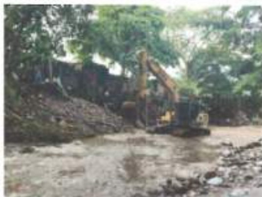
FOTOGRAFIA 1. FECHA DE TOMA: 04-09-25 ITEM 1: RETROEXCAVADORA 20 T O SIM. INC. OPE Y COMB
