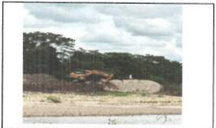
FOTOGRAFIA 4. FECHA DE TOMA: 13-09-25 ITEM 1: RETROEXCAVADORA 20 T O SIM. INC. OPE Y COMB
