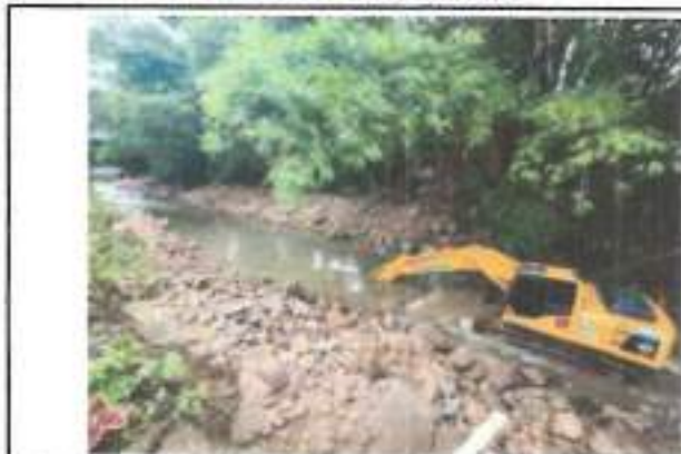
FOTOGRAFIA 3. FECHA DE TOMA: 22-08-25 ITEM 1: RETROEXCAVADORA 20 T O SIM. INC. OPE Y COMB
