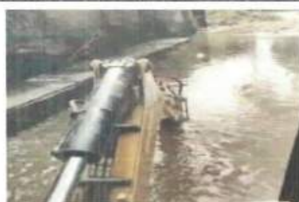
FOTOGRAFIA 2. FECHA DE TOMA: 22-08-25 ITEM 4: RETROEXCAVADORA CARGADORA DE LLANTAS TIPO PAJARITA JD340 O EQUIVALENTE INCLUYE OPERADOR Y COMBUSTIBLE
