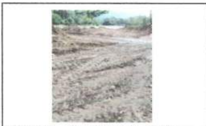
FOTOGRAFIA 4. FECHA DE TOMA: 16-09-25 ITEM 4: RETROEXCAVADORA CARGADORA DE LLANTAS TIPO PAJARITA JD340 O EQUIVALENTE INCLUYE OPERADOR Y COMBUSTIBLE
