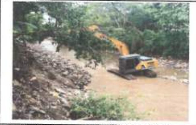
FOTOGRAFIA 3. FECHA DE TOMA: 28-08-25 ITEM 1: RETROEXCAVADORA 20 T O SIM. INC. OPE Y COMB
