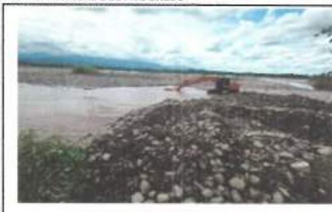
FOTOGRAFIA 3. FECHA DE TOMA: 24-08-25 ITEM 1: RETROEXCAVADORA 20 T O SIM. INC. OPE Y COMB
