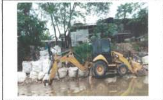
FOTOGRAFIA 3. FECHA DE TOMA: 29-08-25 ITEM 4: RETROEXCAVADORA CARGADORA DE LLANTAS TIPO PAJARITA JD340 O EQUIVALENTE INCLUYE OPERADOR Y COMBUSTIBLE
