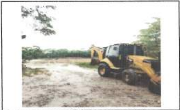
FOTOGRAFIA 2. FECHA DE TOMA: 28-08-25 ITEM 4: RETROEXCAVADORA CARGADORA DE LLANTAS TIPO PAJARITA JD340 O EQUIVALENTE INCLUYE OPERADOR Y COMBUSTIBLE
