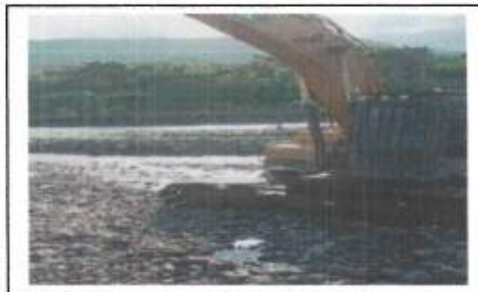
FOTOGRAFIA 2. FECHA DE TOMA: 13-09-25 ITEM 1: RETROEXCAVADORA 20 T O SIM. INC. OPE Y COMB
