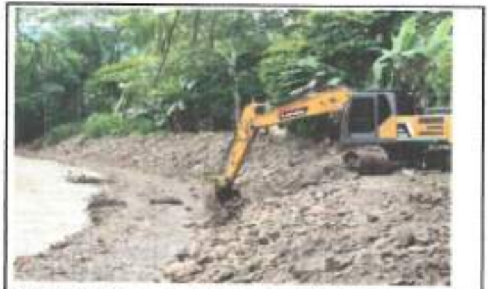
FOTOGRAFIA 4. FECHA DE TOMA: 30-08-25 ITEM 1: RETROEXCAVADORA 20 T O SIM. INC. OPE Y COMB
