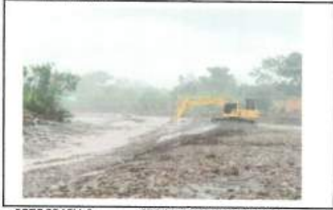
FOTOGRAFIA 3. FECHA DE TOMA: 23-08-25 ITEM 1: RETROEXCAVADORA 20 T O SIM. INC. OPE Y COMB
