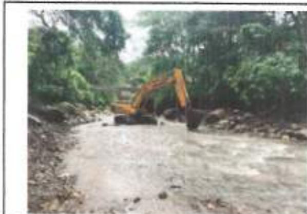
FOTOGRAFIA 1. FECHA DE TOMA: 26-08-25 ITEM 1: RETROEXCAVADORA 20 T O SIM. INC. OPE Y COMB
