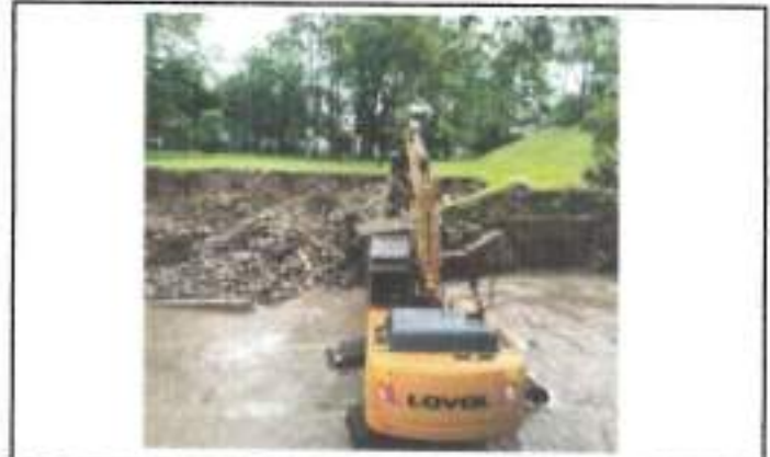
FOTOGRAFIA 2. FECHA DE TOMA: 27-08-25 ITEM 1: RETROEXCAVADORA 20 T O SIM. INC. OPE Y COMB
