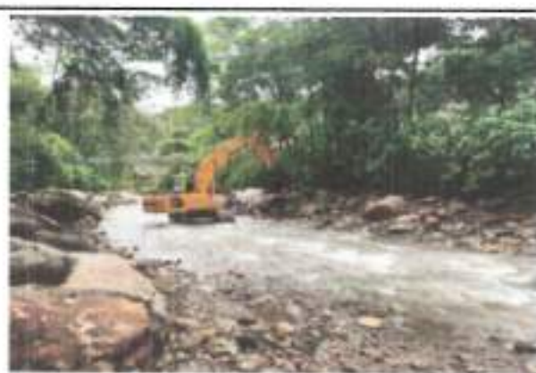
FOTOGRAFIA 2. FECHA DE TOMA: 27-08-25 ITEM 1: RETROEXCAVADORA 20 T O SIM. INC. OPE Y COMB
