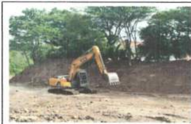
FOTOGRAFIA 2. FECHA DE TOMA: 18-08-25 ITEM 1: RETROEXCAVADORA 20 T O SIM. INC. OPE Y COMB
