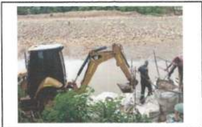
FOTOGRAFIA 1. FECHA DE TOMA: 27-08-25 ITEM 4: RETROEXCAVADORA CARGADORA DE LLANTAS TIPO PAJARITA JD340 O EQUIVALENTE INCLUYE OPERADOR Y COMBUSTIBLE
