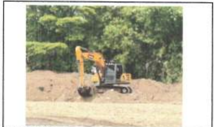
FOTOGRAFIA 2. FECHA DE TOMA: 12-09-25 ITEM 1: RETROEXCAVADORA 20 T O SIM. INC. OPE Y COMB
