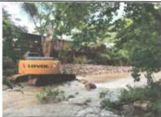
FOTOGRAFIA 3. FECHA DE TOMA: 05-09-25 ITEM 1: RETROEXCAVADORA 20 T O SIM. INC. OPE Y COMB
