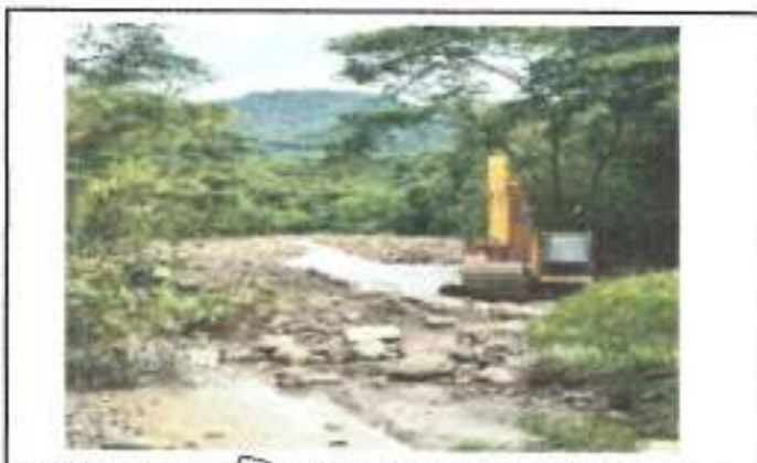
FOTOGRAFIA 4. FECHA DE TOMA: 04-09-25 ITEM 1: RETROEXCAVADORA 20 T O SIM. INC. OPE Y COMB
