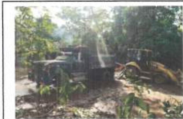
FOTOGRAFIA 2. FECHA DE TOMA: 18-08-25 ITEM 4: RETROEXCAVADORA CARGADORA DE LLANTAS TIPO PAJARITA JD340 O EQUIVALENTE INCLUYE OPERADOR Y COMBUSTIBLE
