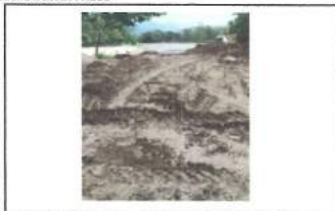
FOTOGRAFIA 3. FECHA DE TOMA: 15-09-25 ITEM 4: RETROEXCAVADORA CARGADORA DE LLANTAS TIPO PAJARITA JD340 O EQUIVALENTE INCLUYE OPERADOR Y COMBUSTIBLE
