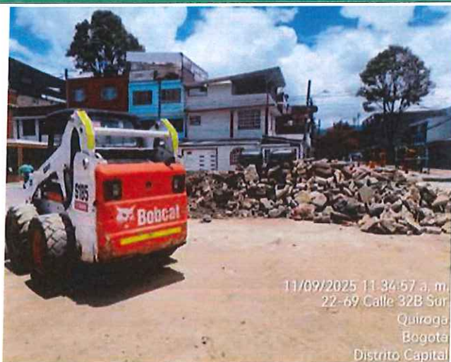
Acopio temporal de RCD
