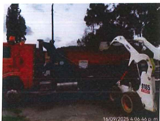
Evacuación de RCD
