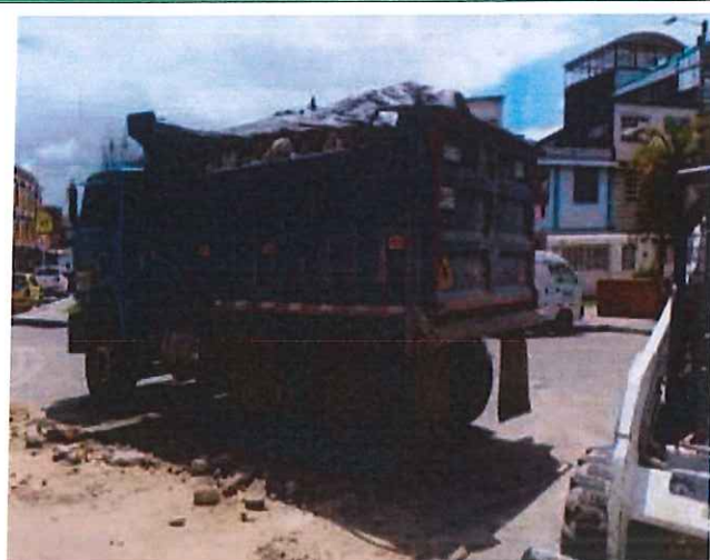
Evacuación de RCD
