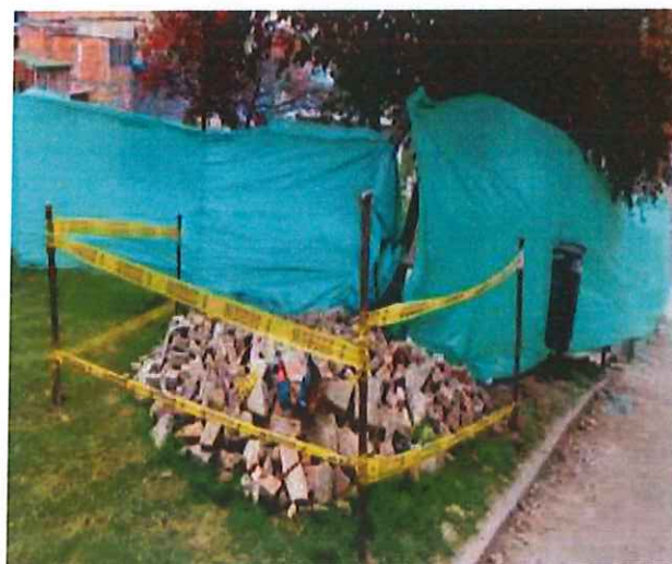
Acopio temporal de RCD
