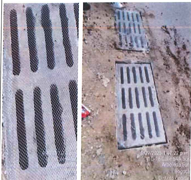
Mantenimiento de sumideros, cambio de polimalla por malla zaranda
