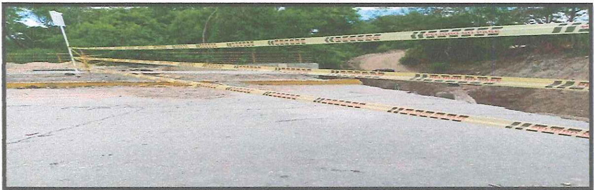
IMAGEN - SEÑALIZACIÓN Y DEMARCACIÓN DE OBRA
