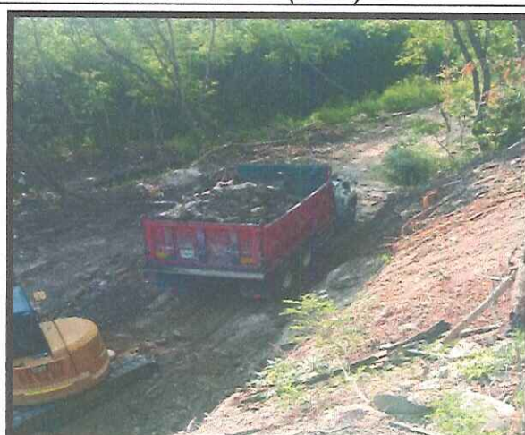
Imagen – Cargue de residuos de construcción demolición (RCD)
