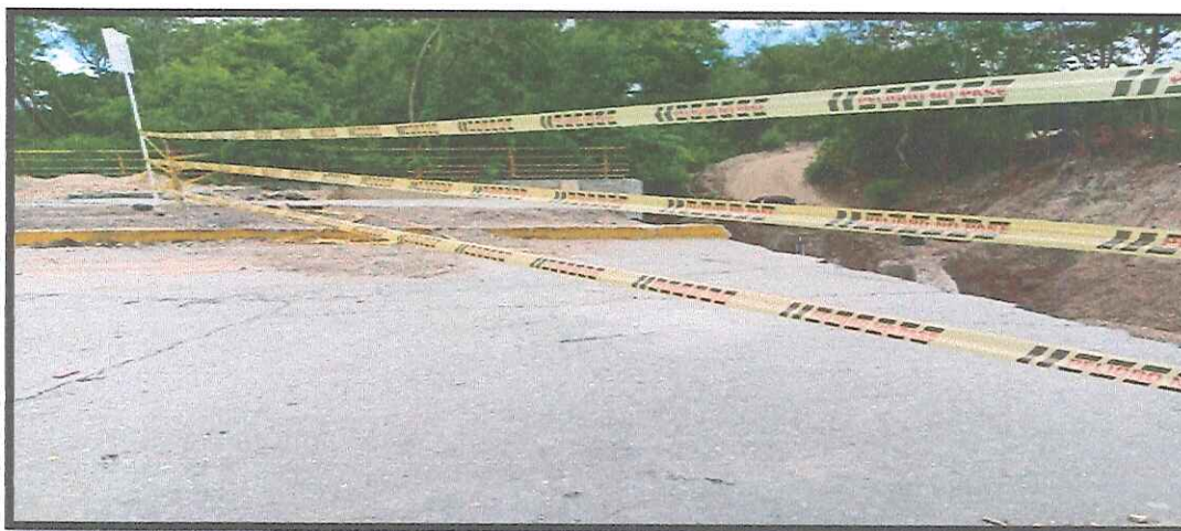
Imagen N° 15 Señalización y demarcación de obra
