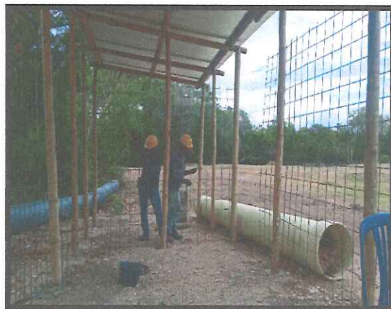
Imagen N°6. Instalación del campamento
