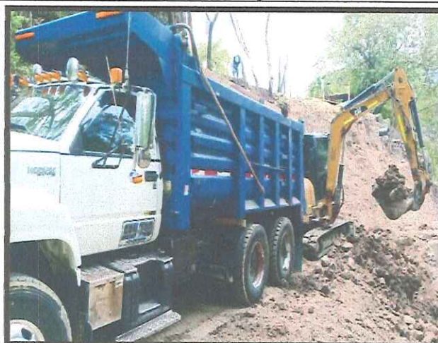
Imagen – Cargue de residuos de construcción demolición (RCD)
