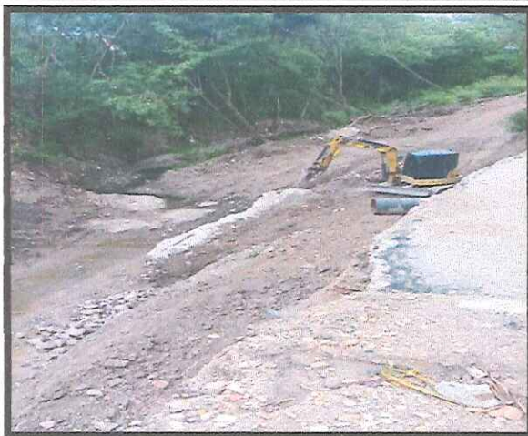
Imagen - Excavación y demolición de RCD
