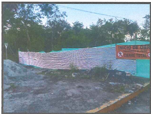
Imagen N°5. Instalación de encerramiento
