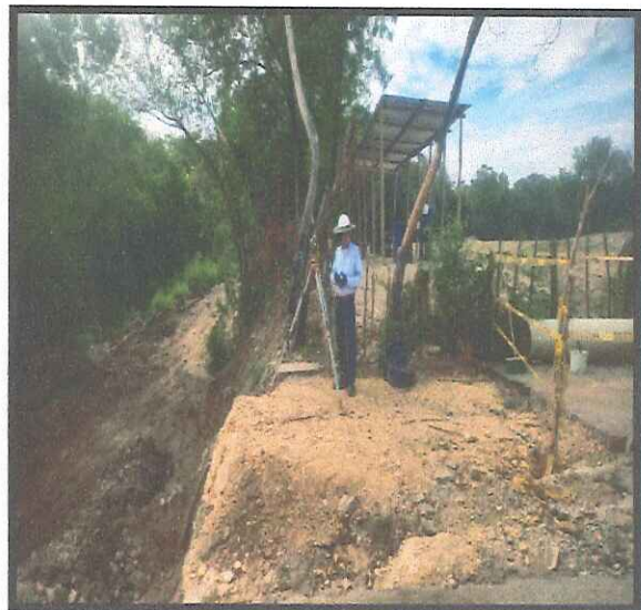
Imagen N°4. Ree-planteo topográfico
