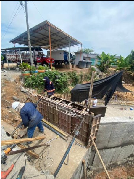
FOTO 13. 2025-03-01 DESENCOFRADO DE PARTE SUPERIOR DE LA ALETA DERECHA AGUAS DEBAJO DE BOX CULVERT K0+500 VÍA SAN PABLO – SIMITÍ. CONTINUACIÓN DE ENCONFRADO DE MURO PANTALLA EN LA PARTE SUPERIOR DE LA ESTRUCTURA DE TRANSICIÓN.
