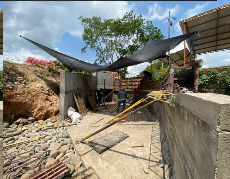
FOTO 94. 2025-03-08 FUNDIDA DE LA PARTE SUPERIOR DE LA ALETA IZQUIERDA AGUAS ABAJO DE BOX CULVERT K0+500 VÍA SAN PABLO CON CONCRETO DE 4000 PSI CON ADITIVO IMPERMEABILIZANTE Y APLICACIÓN DE ANTISOL
