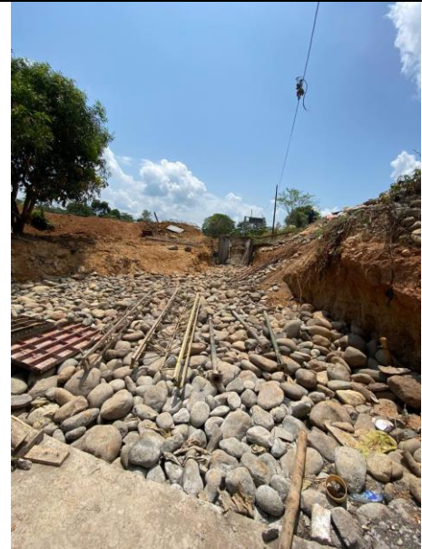
FOTO 102. 2025-03-08 FUNDIDA DE LA PARTE SUPERIOR DE LA ALETA IZQUIERDA AGUAS ABAJO DE BOX CULVERT K0+500 VÍA SAN PABLO CON CONCRETO DE 4000 PSI CON ADITIVO IMPERMEABILIZANTE Y APLICACIÓN DE ANTISOL
