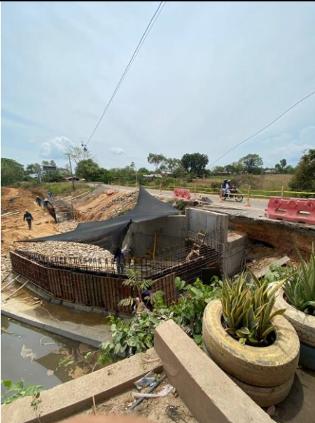
FOTO 37. 2025-03-05 CONTINUACIÓN DE ENCOFRADO DE PARTE BAJA DE LA ALETA IZQUIERDA AGUAS DEBAJO DE BOX CULVERT K0+500 VÍA SAN PABLO – SIMITÍ
