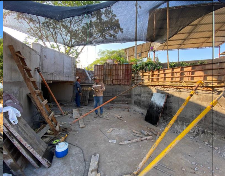
FOTO 78. 2025-03-07 DESENCOFRADO DE PARTE INFERIOR DE ALETA IZQUIERDA. SE LLEVA A CABO ENCOFRADO DE LA PARTE SUPERIOR DE LA ALETA IZQUIERDA AGUAS ABAJO DE BOX CULVERT K0+500 VÍA SAN PABLO – SIMITÍ
