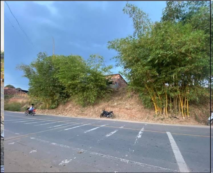
FOTO 140. 2025-03-16 ESTADO GENERAL DE LAS OBRAS DEL MURO DE CONTENCIÓN PROYECTADO, ALEDAÑO AL BARRIO EL BOSQUE, EN SAN PABLO, BOLÍVAR
