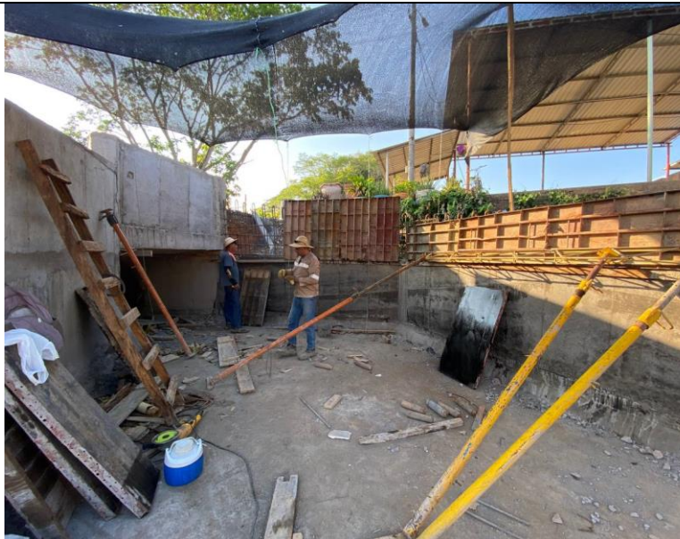
FOTO 75. 2025-03-07 DESENCOFRADO DE PARTE INFERIOR DE ALETA IZQUIERDA. SE LLEVA A CABO ENCOFRADO DE LA PARTE SUPERIOR DE LA ALETA IZQUIERDA AGUAS ABAJO DE BOX CULVERT K0+500 VÍA SAN PABLO – SIMITÍ
