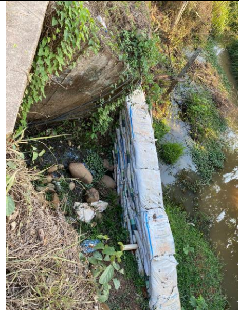
FOTO 66. 2025-03-07 CONTENCIÓN CON SACOS RELLENOS DE MATERIAL DE RELLENO AGUAS ARRIBA DE BOX CULVERT K0+500 VÍA SAN PABLO – SIMITÍ
