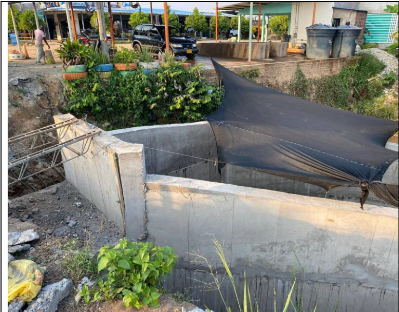
FOTO 137. 2025-03-10 ESTADO GENERAL DE LAS OBRAS DEL BOX CULVERT K0+500 VÍA SAN PABLO - SIMITÍ
