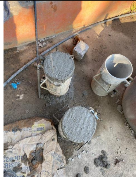
FOTO 114. 2025-03-08 TOMA DE MUESTRAS DE CONCRETO
