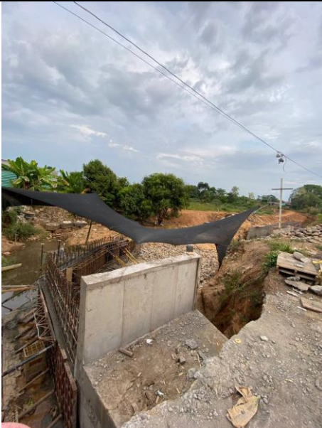
FOTO 61. 2025-03-06 FUNDIDA DE PARTE INFERIOR DE ALETA IZQUIERDA AGUAS ABAJO DE BOX CULVERT K0+500 VÍA SAN PABLO – SIMITÍ, CON CONCRETO DE 4000 PSI CON ADITIVO IMPERMEABILIZANTE Y APLICACIÓN DE ANTISOL
