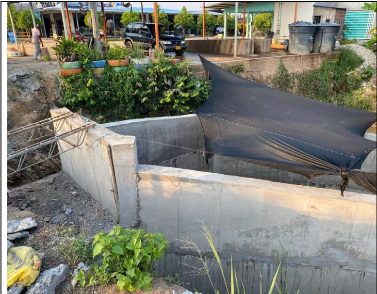
FOTO 133. 2025-03-10 ESTADO GENERAL DE LAS OBRAS DEL BOX CULVERT K0+500 VÍA SAN PABLO - SIMITÍ
