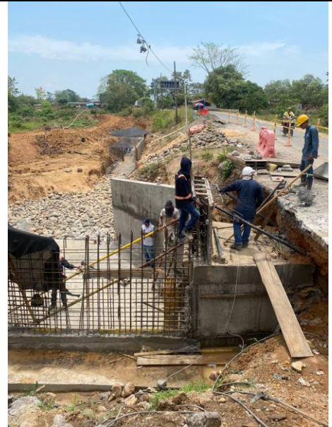
FOTO 6. 2025-03-01 DESENCOFRADO DE PARTE SUPERIOR DE LA ALETA DERECHA AGUAS DEBAJO DE BOX CULVERT K0+500 VÍA SAN PABLO – SIMITÍ. CONTINUACIÓN DE ENCOFRADO DE MURO PANTALLA EN LA PARTE SUPERIOR DE LA ESTRUCTURA DE TRANSICIÓN.
