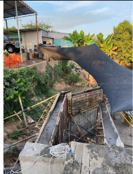
FOTO 126. 2025-03-08 FUNDIDA DE LA PARTE SUPERIOR DE LA ALETA IZQUIERDA AGUAS ABAJO DE BOX CULVERT K0+500 VÍA SAN PABLO CON CONCRETO DE 4000 PSI CON ADITIVO IMPERMEABILIZANTE Y APLICACIÓN DE ANTISOL
