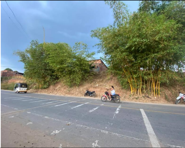
FOTO 143. 2025-03-16 ESTADO GENERAL DE LAS OBRAS DEL MURO DE CONTENCIÓN PROYECTADO, ALEDAÑO AL BARRIO EL BOSQUE, EN SAN PABLO, BOLÍVAR
