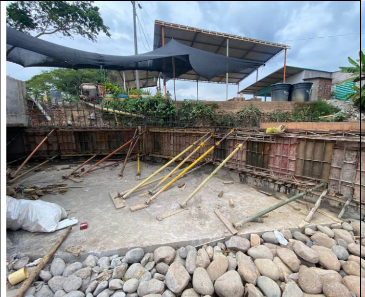
FOTO 42. 2025-03-06 FUNDIDA DE PARTE INFERIOR DE ALETA IZQUIERDA AGUAS ABAJO DE BOX CULVERT K0+500 VÍA SAN PABLO – SIMITÍ, CON CONCRETO DE 4000 PSI CON ADITIVO IMPERMEABILIZANTE Y APLICACIÓN DE ANTISOL
