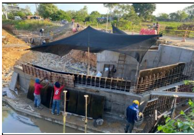
07/03/2025 INSTALACIÓN DE FORMALETAS PARA PODER REALIZAR VACIADO DE PARTE SUPERIOR DE MURO IZQUIERDO AGUAS ABAJO DE BOX CULVERT K0+500, VÍA SAN PABLO - SIMITÍ, BOLÍVAR
