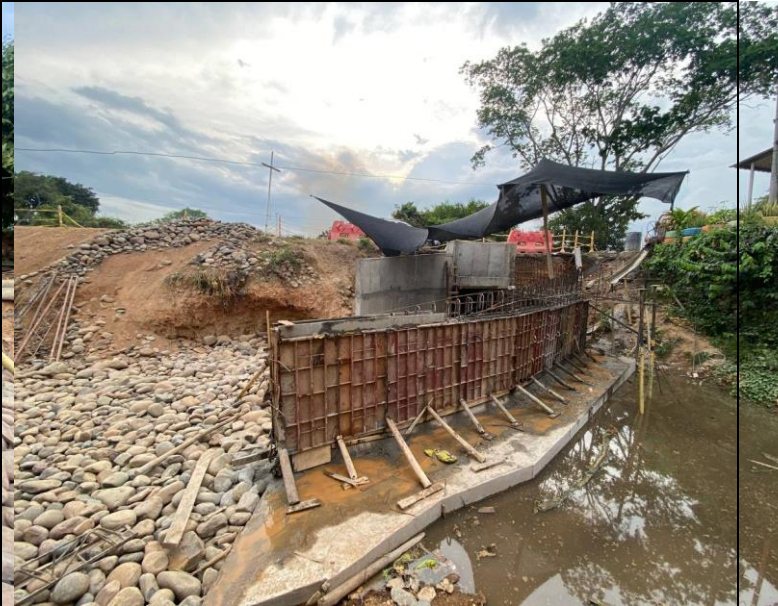
FOTO 46. 2025-03-06 FUNDIDA DE PARTE INFERIOR DE ALETA IZQUIERDA AGUAS ABAJO DE BOX CULVERT K0+500 VÍA SAN PABLO – SIMITÍ, CON CONCRETO DE 4000 PSI CON ADITIVO IMPERMEABILIZANTE Y APLICACIÓN DE ANTISOL
