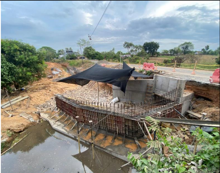
FOTO 55. 2025-03-06 FUNDIDA DE PARTE INFERIOR DE ALETA IZQUIERDA AGUAS ABAJO DE BOX CULVERT K0+500 VÍA SAN PABLO – SIMITÍ, CON CONCRETO DE 4000 PSI CON ADITIVO IMPERMEABILIZANTE Y APLICACIÓN DE ANTISOL
