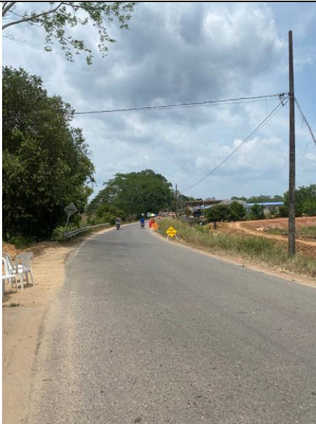
FOTO 19. 2025-03-05 IMPLEMENTACIÓN DE PMT EN CAMPO, BOX CULVERT K0+500, VÍA SAN PABLO - SIMITÍ, BOLÍVAR
