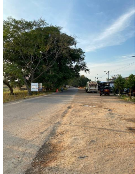
FOTO 124. VISTA HACIA MAYORES DE BOX CULVERT K0+500 VÍA SAN PABLO - SIMITÍ
