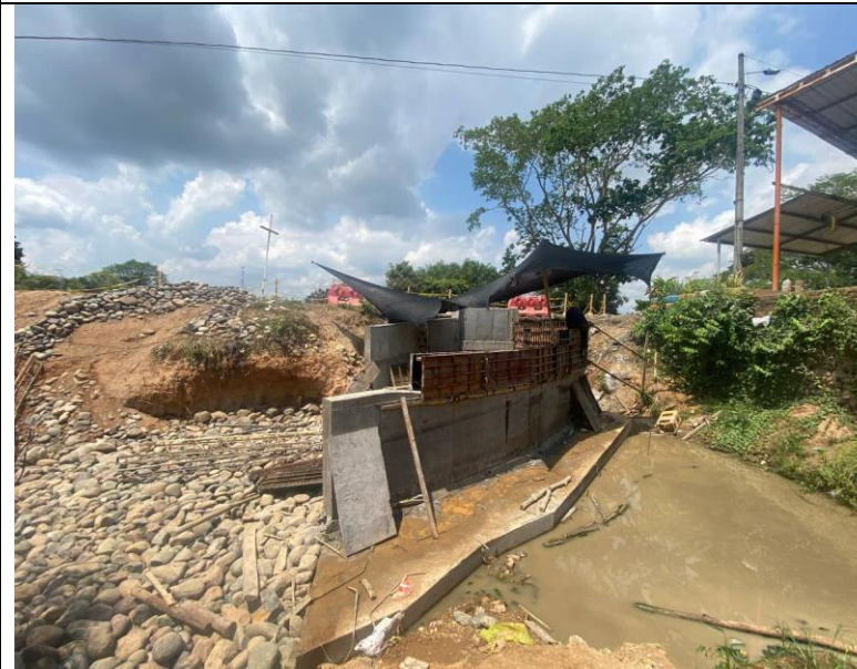
FOTO 91. 2025-03-08 FUNDIDA DE LA PARTE SUPERIOR DE LA ALETA IZQUIERDA AGUAS ABAJO DE BOX CULVERT K0+500 VÍA SAN PABLO CON CONCRETO DE 4000 PSI CON ADITIVO IMPERMEABILIZANTE Y APLICACIÓN DE ANTISOL
