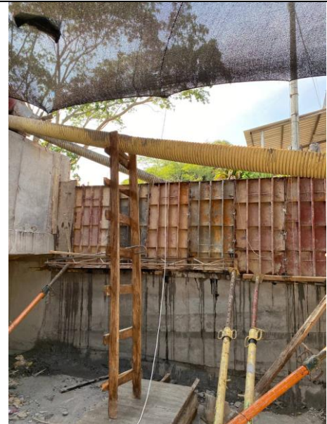
FOTO 116. 2025-03-08 FUNDIDA DE LA PARTE SUPERIOR DE LA ALETA IZQUIERDA AGUAS ABAJO DE BOX CULVERT K0+500 VÍA SAN PABLO CON CONCRETO DE 4000 PSI CON ADITIVO IMPERMEABILIZANTE Y APLICACIÓN DE ANTISOL
