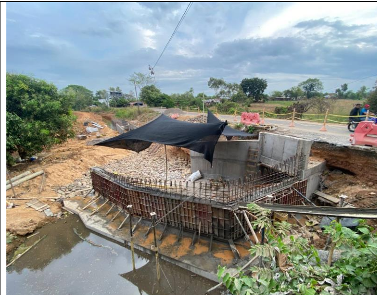
FOTO 57. 2025-03-06 FUNDIDA DE PARTE INFERIOR DE ALETA IZQUIERDA AGUAS ABAJO DE BOX CULVERT K0+500 VÍA SAN PABLO – SIMITÍ, CON CONCRETO DE 4000 PSI CON ADITIVO IMPERMEABILIZANTE Y APLICACIÓN DE ANTISOL
