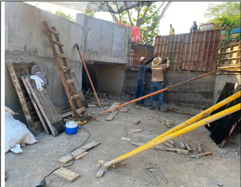
FOTO 85. 2025-03-07 DESENCOFRADO DE PARTE INFERIOR DE ALETA IZQUIERDA. SE LLEVA A CABO ENCOFRADO DE LA PARTE SUPERIOR DE LA ALETA IZQUIERDA AGUAS ABAJO DE BOX CULVERT K0+500 VÍA SAN PABLO – SIMITÍ
