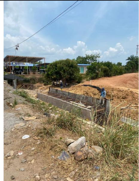
FOTO 22. 2025-03-05 OBRA ALEDAÑA AL PROYECTO, NO TIENE NINGUNA RELACIÓN CON LOS CONTRATOS DE OBRA E INTERVENTORÍA
