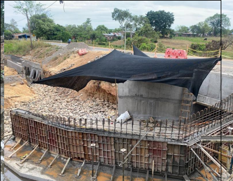
FOTO 52. 2025-03-06 FUNDIDA DE PARTE INFERIOR DE ALETA IZQUIERDA AGUAS ABAJO DE BOX CULVERT K0+500 VÍA SAN PABLO – SIMITÍ, CON CONCRETO DE 4000 PSI CON ADITIVO IMPERMEABILIZANTE Y APLICACIÓN DE ANTISOL
