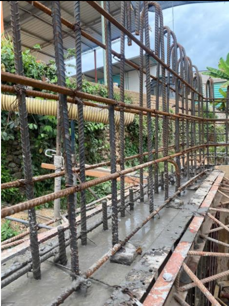
FOTO 41. 2025-03-06 FUNDIDA DE PARTE INFERIOR DE ALETA IZQUIERDA AGUAS ABAJO DE BOX CULVERT K0+500 VÍA SAN PABLO – SIMITÍ, CON CONCRETO DE 4000 PSI CON ADITIVO IMPERMEABILIZANTE Y APLICACIÓN DE ANTISOL
