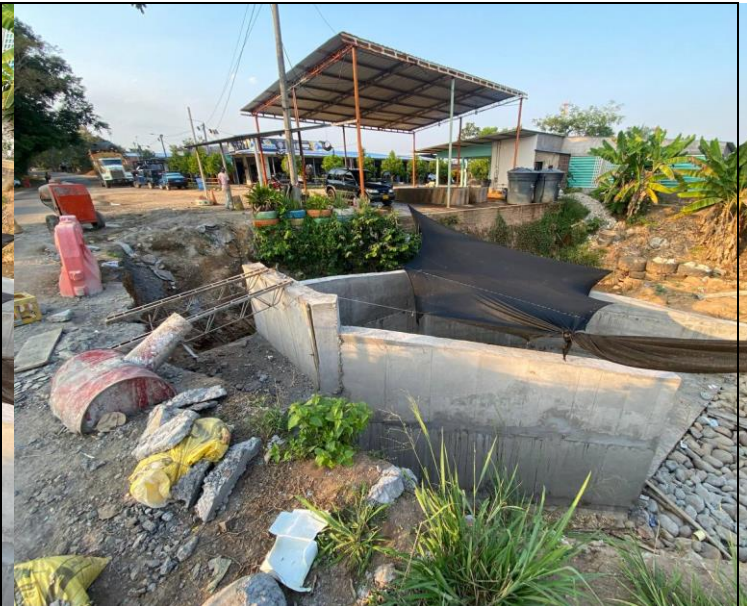
FOTO 134. 2025-03-10 ESTADO GENERAL DE LAS OBRAS DEL BOX CULVERT K0+500 VÍA SAN PABLO - SIMITÍ
