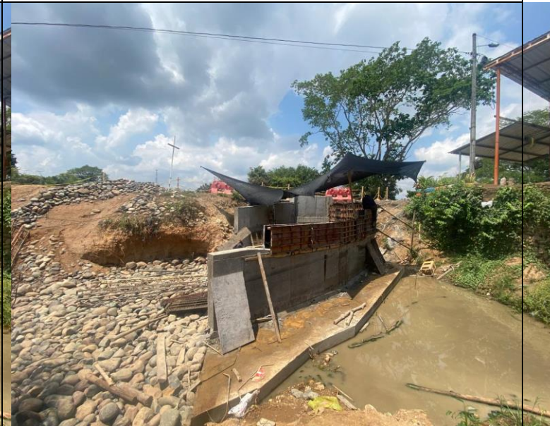
FOTO 92. 2025-03-08 FUNDIDA DE LA PARTE SUPERIOR DE LA ALETA IZQUIERDA AGUAS ABAJO DE BOX CULVERT K0+500 VÍA SAN PABLO CON CONCRETO DE 4000 PSI CON ADITIVO IMPERMEABILIZANTE Y APLICACIÓN DE ANTISOL
