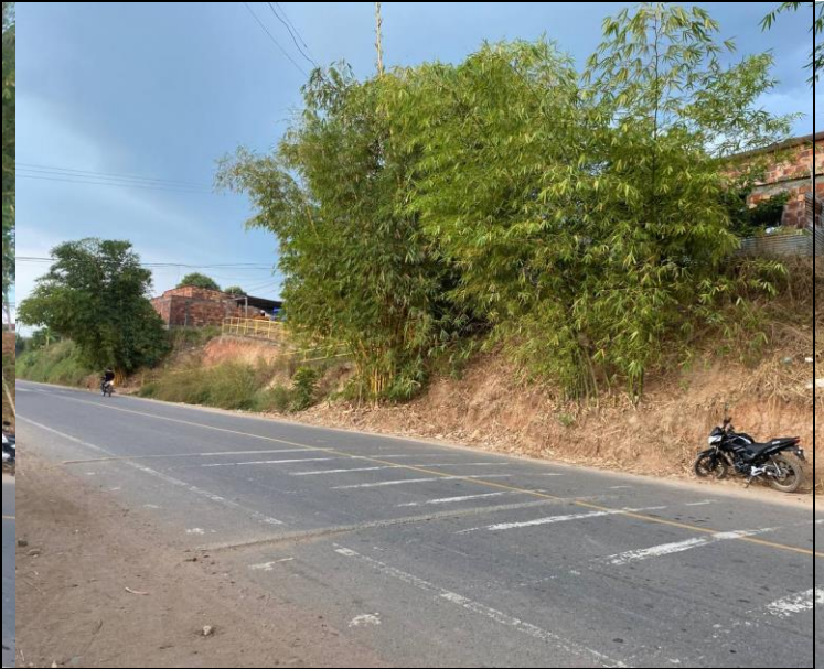
FOTO 144. 2025-03-16 ESTADO GENERAL DE LAS OBRAS DEL MURO DE CONTENCIÓN PROYECTADO, ALEDAÑO AL BARRIO EL BOSQUE, EN SAN PABLO, BOLÍVAR
