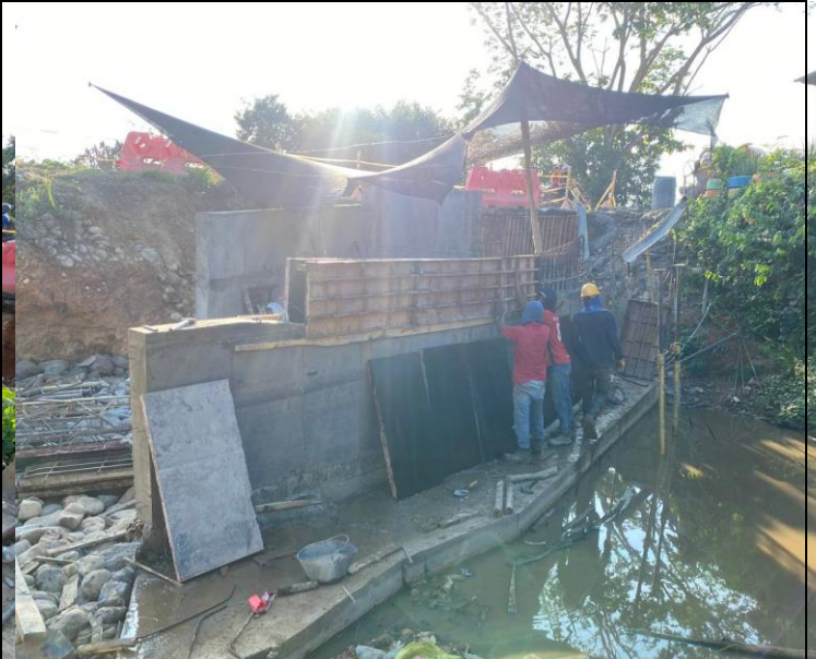
FOTO 70. 2025-03-07 DESENCOFRADO DE PARTE INFERIOR DE ALETA IZQUIERDA. SE LLEVA A CABO ENCOFRADO DE LA PARTE SUPERIOR DE LA ALETA IZQUIERDA AGUAS ABAJO DE BOX CULVERT K0+500 VÍA SAN PABLO – SIMITÍ
