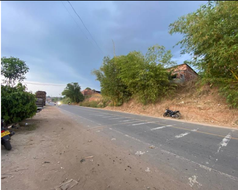
FOTO 141. 2025-03-16 ESTADO GENERAL DE LAS OBRAS DEL MURO DE CONTENCIÓN PROYECTADO, ALEDAÑO AL BARRIO EL BOSQUE, EN SAN PABLO, BOLÍVAR
