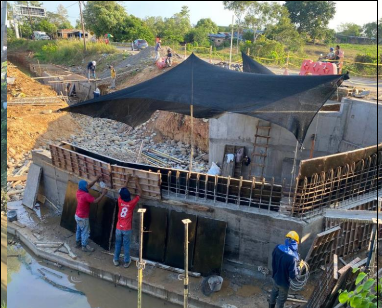
FOTO 72. 2025-03-07 DESENCOFRADO DE PARTE INFERIOR DE ALETA IZQUIERDA. SE LLEVA A CABO ENCOFRADO DE LA PARTE SUPERIOR DE LA ALETA IZQUIERDA AGUAS ABAJO DE BOX CULVERT K0+500 VÍA SAN PABLO – SIMITÍ
