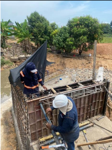
FOTO 11. 2025-03-01 DESENCOFRADO DE PARTE SUPERIOR DE LA ALETA DERECHA AGUAS DEBAJO DE BOX CULVERT K0+500 VÍA SAN PABLO – SIMITÍ. CONTINUACIÓN DE ENCONFRADO DE MURO PANTALLA EN LA PARTE SUPERIOR DE LA ESTRUCTURA DE TRANSICIÓN.
