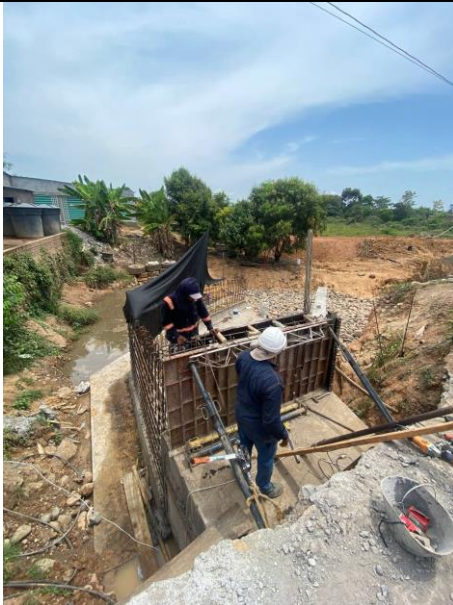
FOTO 7. 2025-03-01 DESENCOFRADO DE PARTE SUPERIOR DE LA ALETA DERECHA AGUAS DEBAJO DE BOX CULVERT K0+500 VÍA SAN PABLO – SIMITÍ. CONTINUACIÓN DE ENCOFRADO DE MURO PANTALLA EN LA PARTE SUPERIOR DE LA ESTRUCTURA DE TRANSICIÓN.
