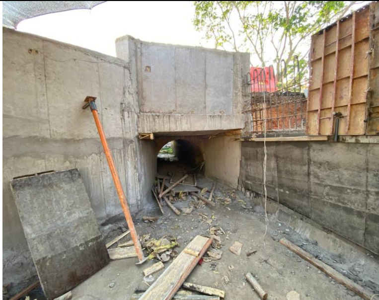
FOTO 79. 2025-03-07 DESENCOFRADO DE PARTE INFERIOR DE ALETA IZQUIERDA. SE LLEVA A CABO ENCOFRADO DE LA PARTE SUPERIOR DE LA ALETA IZQUIERDA AGUAS ABAJO DE BOX CULVERT K0+500 VÍA SAN PABLO – SIMITÍ
