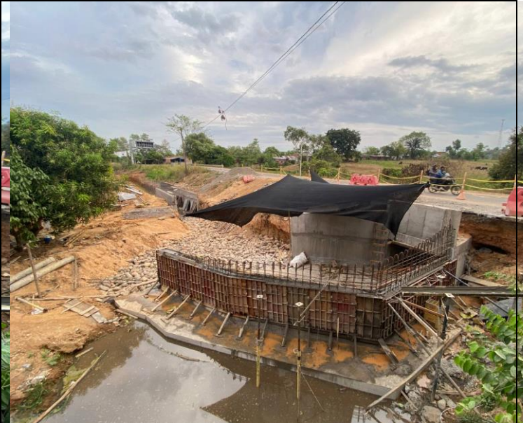
FOTO 56. 2025-03-06 FUNDIDA DE PARTE INFERIOR DE ALETA IZQUIERDA AGUAS ABAJO DE BOX CULVERT K0+500 VÍA SAN PABLO – SIMITÍ, CON CONCRETO DE 4000 PSI CON ADITIVO IMPERMEABILIZANTE Y APLICACIÓN DE ANTISOL
