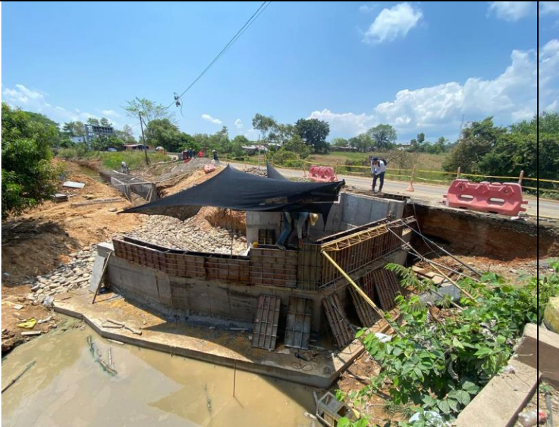
FOTO 129. 2025-03-08 FUNDIDA DE LA PARTE SUPERIOR DE LA ALETA IZQUIERDA AGUAS ABAJO DE BOX CULVERT K0+500 VÍA SAN PABLO CON CONCRETO DE 4000 PSI CON ADITIVO IMPERMEABILIZANTE Y APLICACIÓN DE ANTISOL
