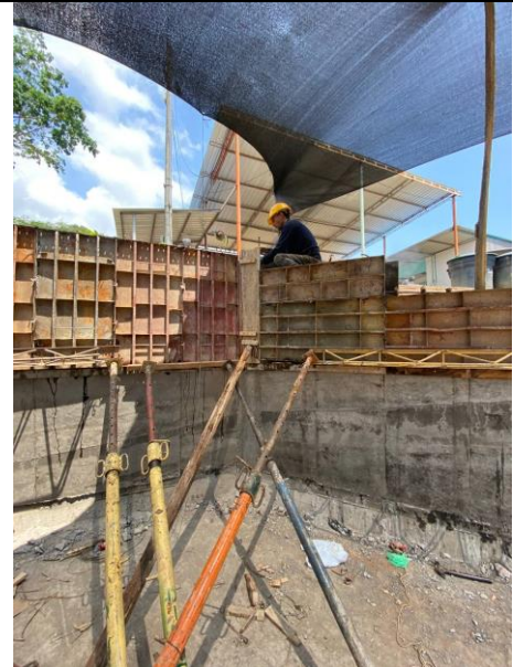
FOTO 98. 2025-03-08 FUNDIDA DE LA PARTE SUPERIOR DE LA ALETA IZQUIERDA AGUAS ABAJO DE BOX CULVERT K0+500 VÍA SAN PABLO CON CONCRETO DE 4000 PSI CON ADITIVO IMPERMEABILIZANTE Y APLICACIÓN DE ANTISOL
