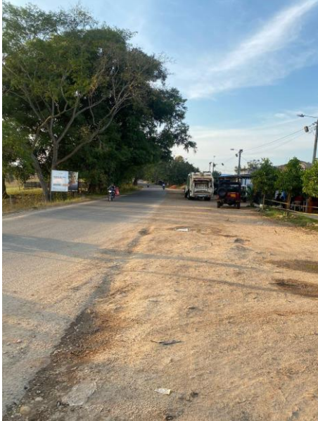
FOTO 123. VISTA HACIA MAYORES DE BOX CULVERT K0+500 VÍA SAN PABLO - SIMITÍ
