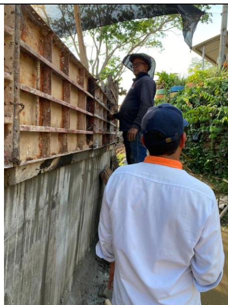
FOTO 118. 2025-03-08 FUNDIDA DE LA PARTE SUPERIOR DE LA ALETA IZQUIERDA AGUAS ABAJO DE BOX CULVERT K0+500 VÍA SAN PABLO CON CONCRETO DE 4000 PSI CON ADITIVO IMPERMEABILIZANTE Y APLICACIÓN DE ANTISOL
