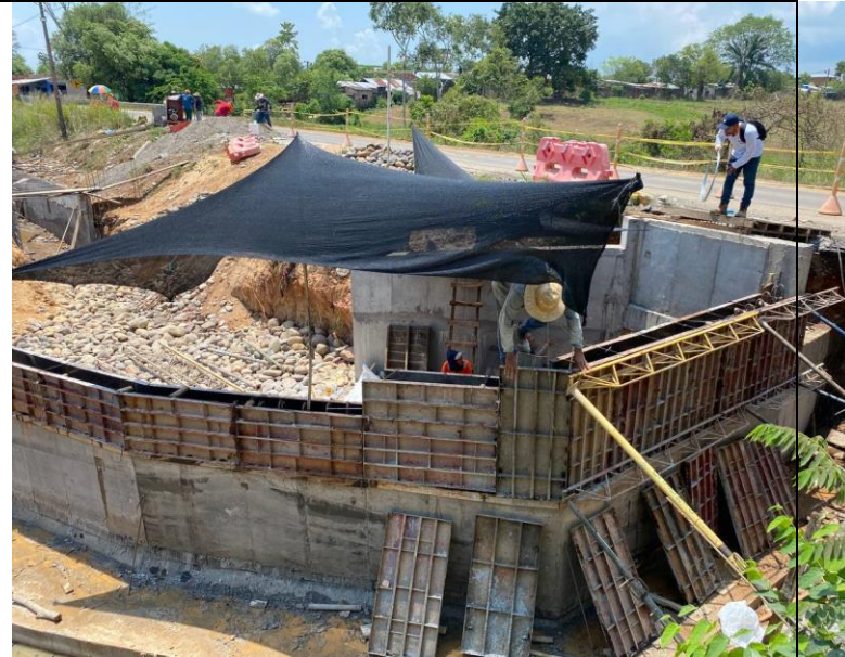
FOTO 106. 2025-03-08 FUNDIDA DE LA PARTE SUPERIOR DE LA ALETA IZQUIERDA AGUAS ABAJO DE BOX CULVERT K0+500 VÍA SAN PABLO CON CONCRETO DE 4000 PSI CON ADITIVO IMPERMEABILIZANTE Y APLICACIÓN DE ANTISOL
