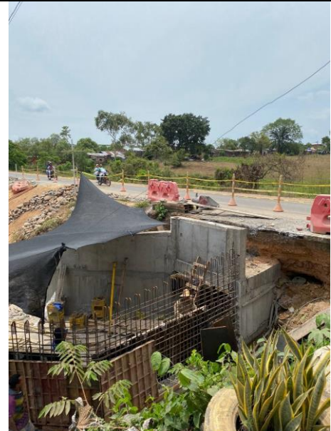
FOTO 38. 2025-03-05 CONTINUACIÓN DE ENCOFRADO DE PARTE BAJA DE LA ALETA IZQUIERDA AGUAS DEBAJO DE BOX CULVERT K0+500 VÍA SAN PABLO – SIMITÍ
