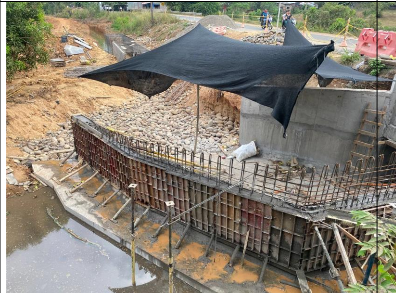
FOTO 59. 2025-03-06 FUNDIDA DE PARTE INFERIOR DE ALETA IZQUIERDA AGUAS ABAJO DE BOX CULVERT K0+500 VÍA SAN PABLO – SIMITÍ, CON CONCRETO DE 4000 PSI CON ADITIVO IMPERMEABILIZANTE Y APLICACIÓN DE ANTISOL
