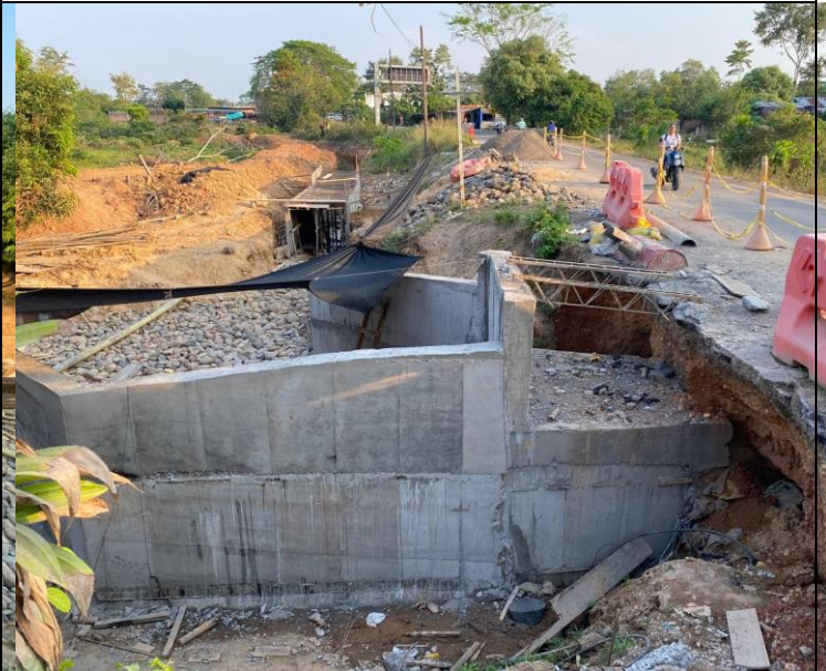
FOTO 136. 2025-03-10 ESTADO GENERAL DE LAS OBRAS DEL BOX CULVERT K0+500 VÍA SAN PABLO - SIMITÍ
