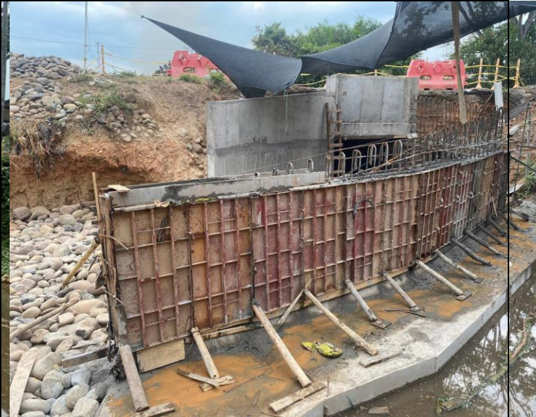
FOTO 50. 2025-03-06 FUNDIDA DE PARTE INFERIOR DE ALETA IZQUIERDA AGUAS ABAJO DE BOX CULVERT K0+500 VÍA SAN PABLO – SIMITÍ, CON CONCRETO DE 4000 PSI CON ADITIVO IMPERMEABILIZANTE Y APLICACIÓN DE ANTISOL
