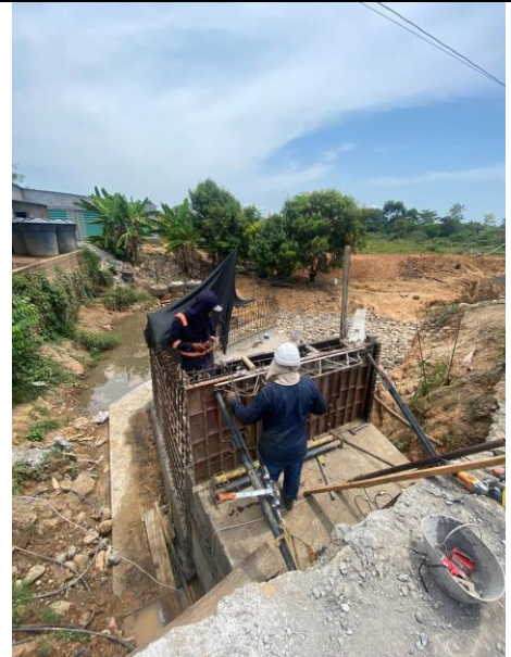
FOTO 8. 2025-03-01 DESENCOFRADO DE PARTE SUPERIOR DE LA ALETA DERECHA AGUAS DEBAJO DE BOX CULVERT K0+500 VÍA SAN PABLO – SIMITÍ. CONTINUACIÓN DE ENCOFRADO DE MURO PANTALLA EN LA PARTE SUPERIOR DE LA ESTRUCTURA DE TRANSICIÓN.
