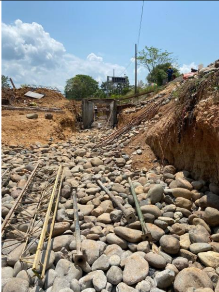
FOTO 99. 2025-03-08 FUNDIDA DE LA PARTE SUPERIOR DE LA ALETA IZQUIERDA AGUAS ABAJO DE BOX CULVERT K0+500 VÍA SAN PABLO CON CONCRETO DE 4000 PSI CON ADITIVO IMPERMEABILIZANTE Y APLICACIÓN DE ANTISOL
