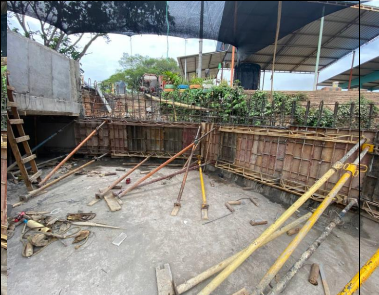
FOTO 48. 2025-03-06 FUNDIDA DE PARTE INFERIOR DE ALETA IZQUIERDA AGUAS ABAJO DE BOX CULVERT K0+500 VÍA SAN PABLO – SIMITÍ, CON CONCRETO DE 4000 PSI CON ADITIVO IMPERMEABILIZANTE Y APLICACIÓN DE ANTISOL
