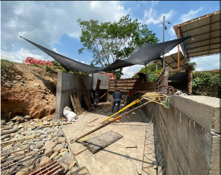
FOTO 93. 2025-03-08 FUNDIDA DE LA PARTE SUPERIOR DE LA ALETA IZQUIERDA AGUAS ABAJO DE BOX CULVERT K0+500 VÍA SAN PABLO CON CONCRETO DE 4000 PSI CON ADITIVO IMPERMEABILIZANTE Y APLICACIÓN DE ANTISOL
