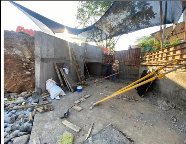
FOTO 83. 2025-03-07 DESENCOFRADO DE PARTE INFERIOR DE ALETA IZQUIERDA. SE LLEVA A CABO ENCOFRADO DE LA PARTE SUPERIOR DE LA ALETA IZQUIERDA AGUAS ABAJO DE BOX CULVERT K0+500 VÍA SAN PABLO – SIMITÍ
