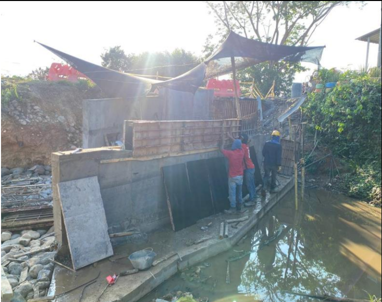
FOTO 71. 2025-03-07 DESENCOFRADO DE PARTE INFERIOR DE ALETA IZQUIERDA. SE LLEVA A CABO ENCOFRADO DE LA PARTE SUPERIOR DE LA ALETA IZQUIERDA AGUAS ABAJO DE BOX CULVERT K0+500 VÍA SAN PABLO – SIMITÍ
