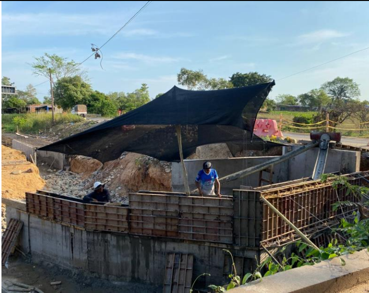
FOTO 121. 2025-03-08 FUNDIDA DE LA PARTE SUPERIOR DE LA ALETA IZQUIERDA AGUAS ABAJO DE BOX CULVERT K0+500 VÍA SAN PABLO CON CONCRETO DE 4000 PSI CON ADITIVO IMPERMEABILIZANTE Y APLICACIÓN DE ANTISOL
