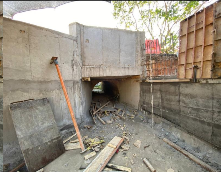
FOTO 80. 2025-03-07 DESENCOFRADO DE PARTE INFERIOR DE ALETA IZQUIERDA. SE LLEVA A CABO ENCOFRADO DE LA PARTE SUPERIOR DE LA ALETA IZQUIERDA AGUAS ABAJO DE BOX CULVERT K0+500 VÍA SAN PABLO – SIMITÍ
