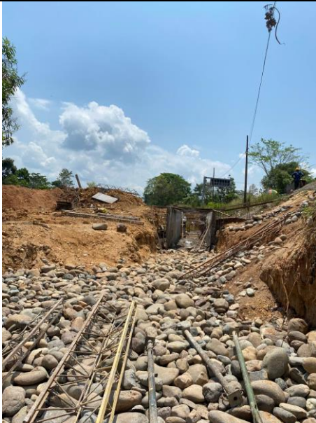
FOTO 101. 2025-03-08 FUNDIDA DE LA PARTE SUPERIOR DE LA ALETA IZQUIERDA AGUAS ABAJO DE BOX CULVERT K0+500 VÍA SAN PABLO CON CONCRETO DE 4000 PSI CON ADITIVO IMPERMEABILIZANTE Y APLICACIÓN DE ANTISOL
