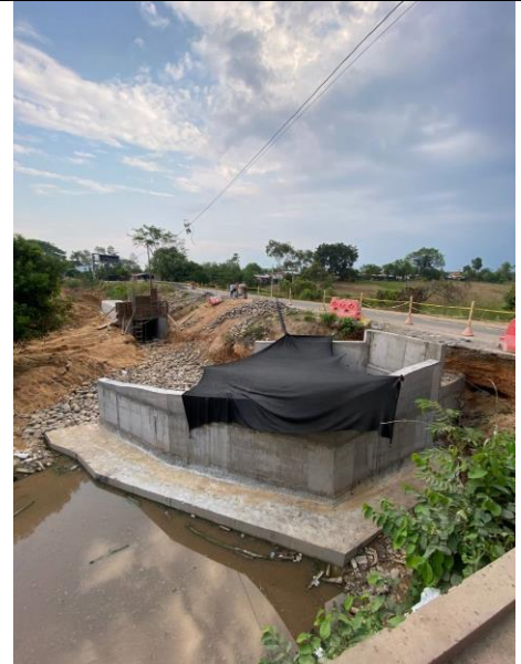
FOTO 152. 2025-03-16 ESTADO GENERAL DE LAS OBRAS DEL BOX CULVERT K0+500 VÍA SAN PABLO - SIMITÍ
