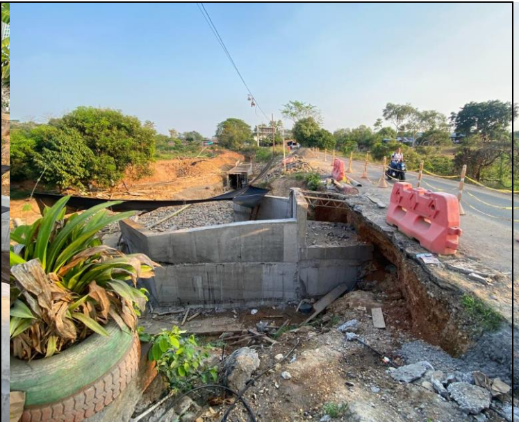
FOTO 138. 2025-03-10 ESTADO GENERAL DE LAS OBRAS DEL BOX CULVERT K0+500 VÍA SAN PABLO - SIMITÍ
