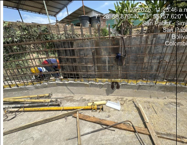
FOTO 18. 2025-03-01 DESENCOFRADO DE MURO PANTALLA QUE FUE FUNDIDO EN CONCRETO DE 4000 PSI CON ADITIVO IMPERMEABILIZANTE Y APLICACIÓN DE ANTISOL. SE INICIA ENCOFRADO DE PARTE BAJA DE LA ALETA IZQUIERDA AGUAS DEBAJO DE BOX CULVERT K0+500 VÍA SAN PABLO – SIMITÍ
