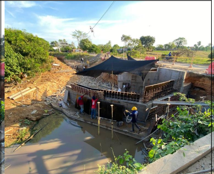
FOTO 68. 2025-03-07 DESENCOFRADO DE PARTE INFERIOR DE ALETA IZQUIERDA. SE LLEVA A CABO ENCOFRADO DE LA PARTE SUPERIOR DE LA ALETA IZQUIERDA AGUAS ABAJO DE BOX CULVERT K0+500 VÍA SAN PABLO – SIMITÍ
