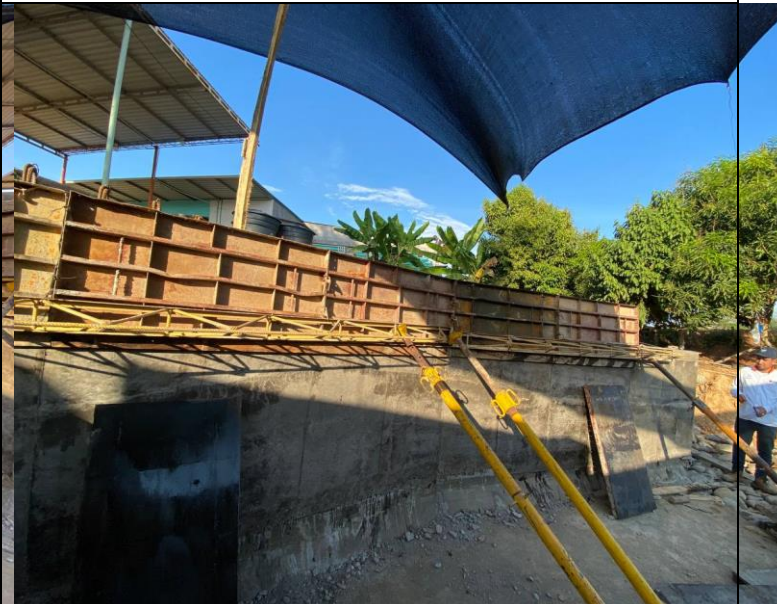
FOTO 76. 2025-03-07 DESENCOFRADO DE PARTE INFERIOR DE ALETA IZQUIERDA. SE LLEVA A CABO ENCOFRADO DE LA PARTE SUPERIOR DE LA ALETA IZQUIERDA AGUAS ABAJO DE BOX CULVERT K0+500 VÍA SAN PABLO – SIMITÍ
