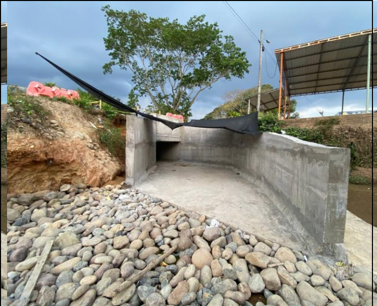
FOTO 146. 2025-03-16 ESTADO GENERAL DE LAS OBRAS DEL BOX CULVERT K0+500 VÍA SAN PABLO - SIMITÍ
