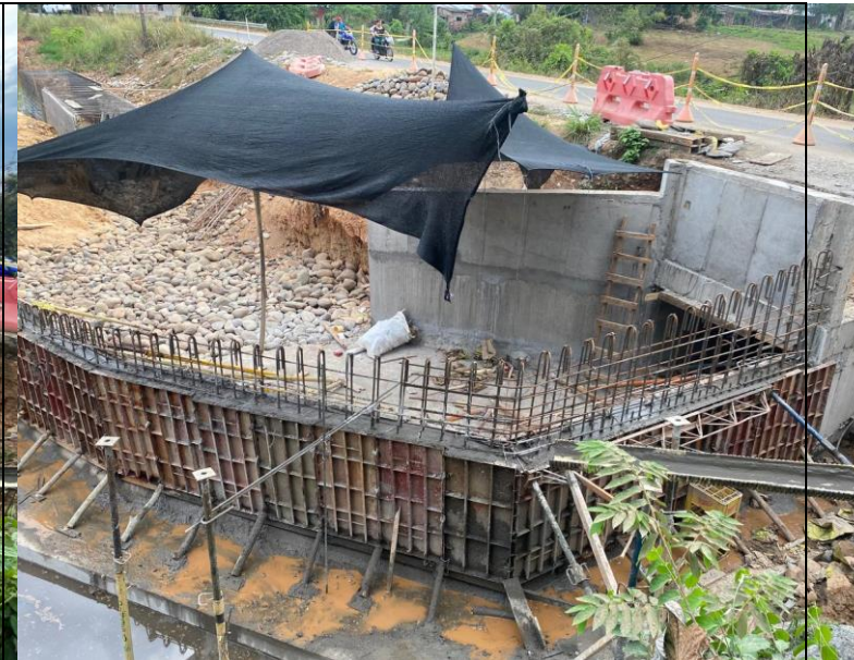
FOTO 58. 2025-03-06 FUNDIDA DE PARTE INFERIOR DE ALETA IZQUIERDA AGUAS ABAJO DE BOX CULVERT K0+500 VÍA SAN PABLO – SIMITÍ, CON CONCRETO DE 4000 PSI CON ADITIVO IMPERMEABILIZANTE Y APLICACIÓN DE ANTISOL
