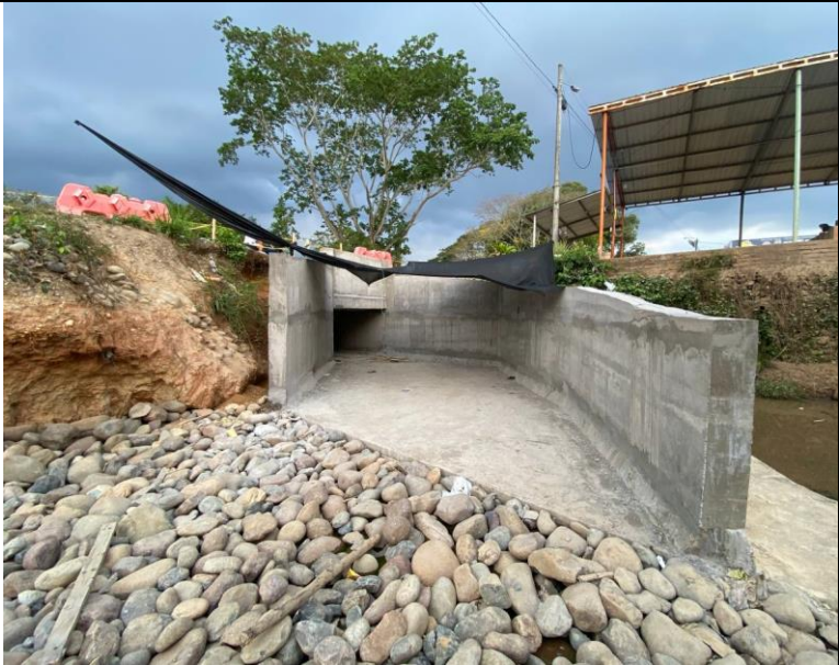
FOTO 157. 2025-03-16 ESTADO GENERAL DE LAS OBRAS DEL BOX CULVERT K0+500 VÍA SAN PABLO - SIMITÍ
