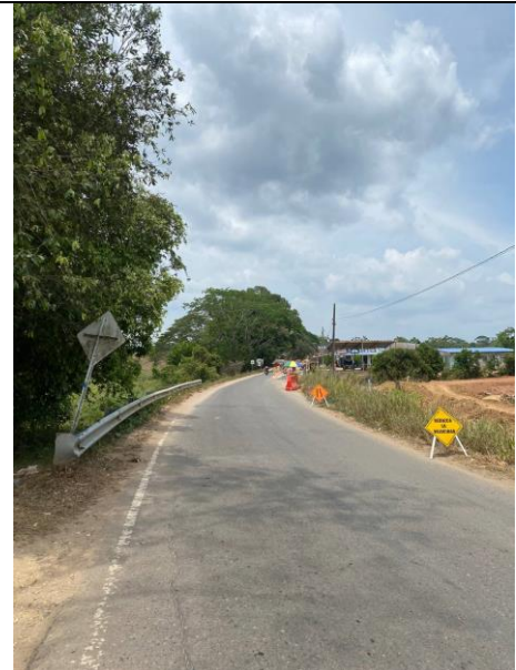
FOTO 20. 2025-03-05 IMPLEMENTACIÓN DE PMT EN CAMPO, BOX CULVERT K0+500, VÍA SAN PABLO - SIMITÍ, BOLÍVAR
