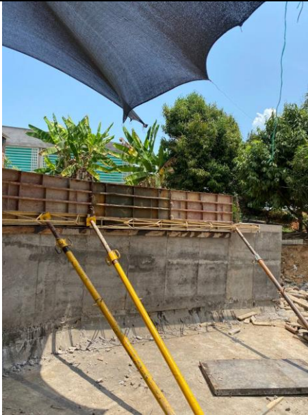
FOTO 105. 2025-03-08 FUNDIDA DE LA PARTE SUPERIOR DE LA ALETA IZQUIERDA AGUAS ABAJO DE BOX CULVERT K0+500 VÍA SAN PABLO CON CONCRETO DE 4000 PSI CON ADITIVO IMPERMEABILIZANTE Y APLICACIÓN DE ANTISOL
