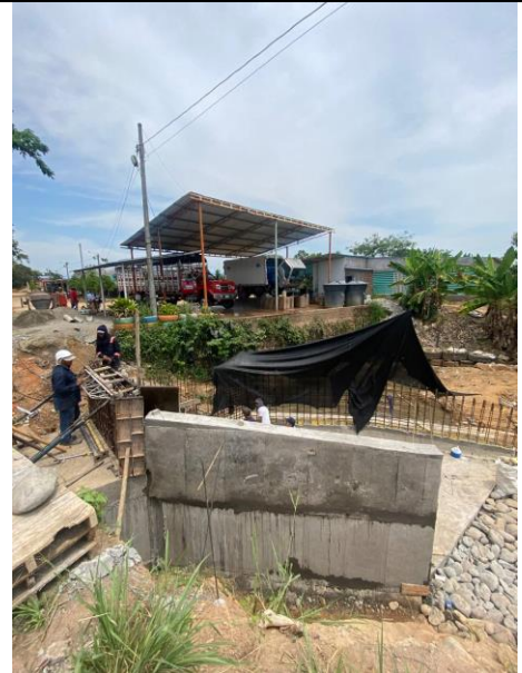
FOTO 12. 2025-03-01 DESENCOFRADO DE PARTE SUPERIOR DE LA ALETA DERECHA AGUAS DEBAJO DE BOX CULVERT K0+500 VÍA SAN PABLO – SIMITÍ. CONTINUACIÓN DE ENCONFRADO DE MURO PANTALLA EN LA PARTE SUPERIOR DE LA ESTRUCTURA DE TRANSICIÓN.
