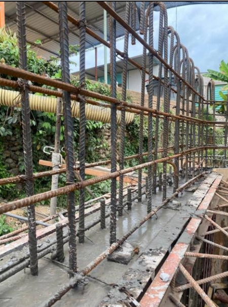
FOTO 39. 2025-03-06 FUNDIDA DE PARTE INFERIOR DE ALETA IZQUIERDA AGUAS ABAJO DE BOX CULVERT K0+500 VÍA SAN PABLO – SIMITÍ, CON CONCRETO DE 4000 PSI CON ADITIVO IMPERMEABILIZANTE Y APLICACIÓN DE ANTISOL
