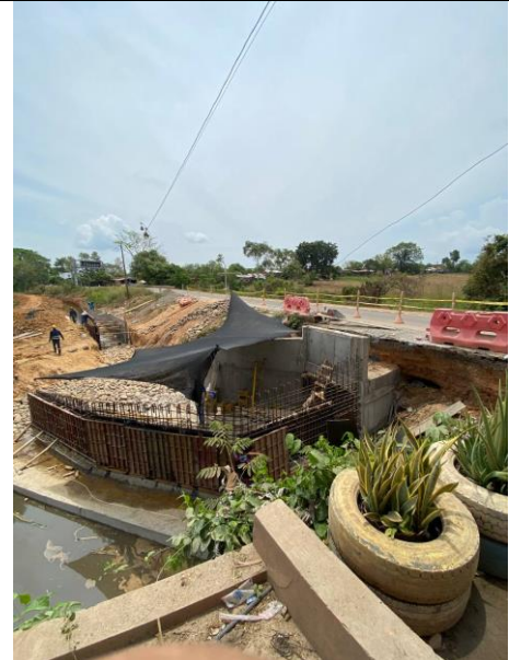
FOTO 36. 2025-03-05 CONTINUACIÓN DE ENCOFRADO DE PARTE BAJA DE LA ALETA IZQUIERDA AGUAS DEBAJO DE BOX CULVERT K0+500 VÍA SAN PABLO – SIMITÍ
