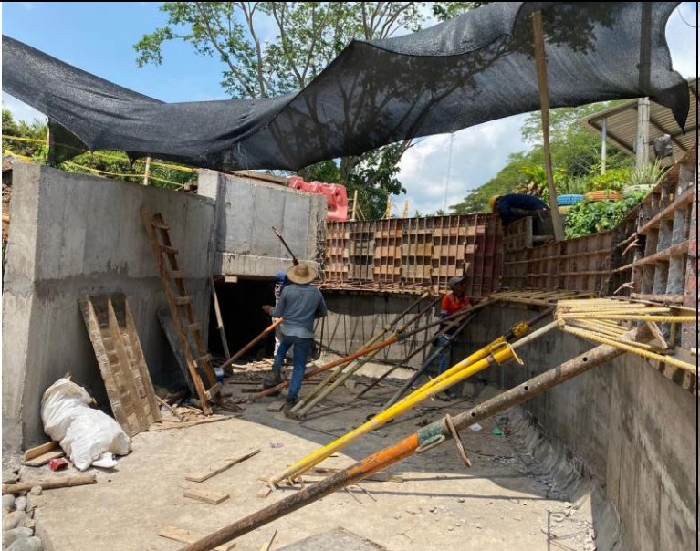
FOTO 95. 2025-03-08 FUNDIDA DE LA PARTE SUPERIOR DE LA ALETA IZQUIERDA AGUAS ABAJO DE BOX CULVERT K0+500 VÍA SAN PABLO CON CONCRETO DE 4000 PSI CON ADITIVO IMPERMEABILIZANTE Y APLICACIÓN DE ANTISOL
