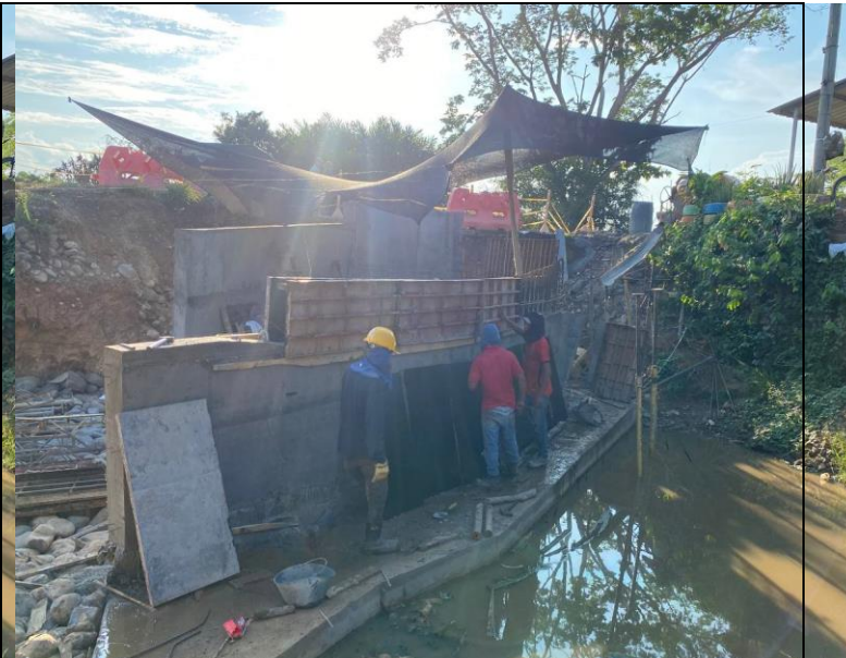
FOTO 74. 2025-03-07 DESENCOFRADO DE PARTE INFERIOR DE ALETA IZQUIERDA. SE LLEVA A CABO ENCOFRADO DE LA PARTE SUPERIOR DE LA ALETA IZQUIERDA AGUAS ABAJO DE BOX CULVERT K0+500 VÍA SAN PABLO – SIMITÍ
