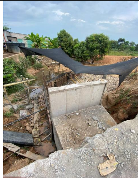
FOTO 62. 2025-03-06 FUNDIDA DE PARTE INFERIOR DE ALETA IZQUIERDA AGUAS ABAJO DE BOX CULVERT K0+500 VÍA SAN PABLO – SIMITÍ, CON CONCRETO DE 4000 PSI CON ADITIVO IMPERMEABILIZANTE Y APLICACIÓN DE ANTISOL
