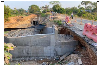
10/03/2025 DESENCOFRADO DE VACIADO DE PARTE ALTA DE ALETA IZQUIERDA AGUAS ABAJO DE BOX CULVERT K0+500, VÍA SAN PABLO - SIMITÍ, BOLÍVAR
