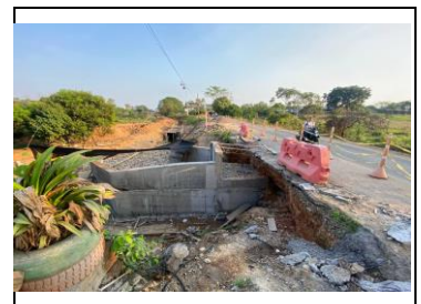
10/03/2025 DESENCOFRADO DE VACIADO DE PARTE ALTA DE ALETA IZQUIERDA AGUAS ABAJO DE BOX CULVERT K0+500, VÍA SAN PABLO - SIMITÍ, ROI IVAR
