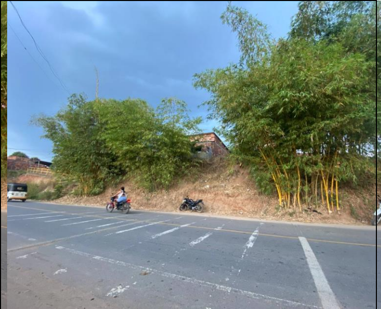
FOTO 142. 2025-03-16 ESTADO GENERAL DE LAS OBRAS DEL MURO DE CONTENCIÓN PROYECTADO, ALEDAÑO AL BARRIO EL BOSQUE, EN SAN PABLO, BOLÍVAR
