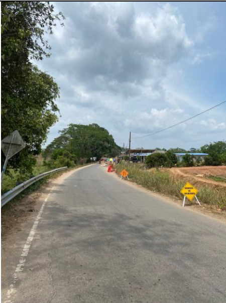
FOTO 23. 2025-03-05 IMPLEMENTACIÓN DE PMT EN CAMPO, BOX CULVERT K0+500, VÍA SAN PABLO - SIMITÍ, BOLÍVAR
