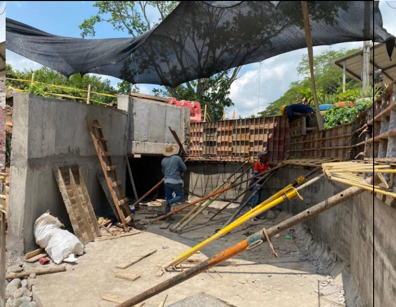
FOTO 96. 2025-03-08 FUNDIDA DE LA PARTE SUPERIOR DE LA ALETA IZQUIERDA AGUAS ABAJO DE BOX CULVERT K0+500 VÍA SAN PABLO CON CONCRETO DE 4000 PSI CON ADITIVO IMPERMEABILIZANTE Y APLICACIÓN DE ANTISOL
