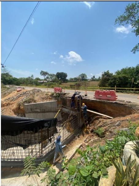
FOTO 1. 2025-03-01 DESENCOFRADO DE PARTE SUPERIOR DE LA ALETA DERECHA AGUAS DEBAJO DE BOX CULVERT K0+500 VÍA SAN PABLO – SIMITÍ. CONTINUACIÓN DE ENCONFRADO DE MURO PANTALLA EN LA PARTE SUPERIOR DE LA ESTRUCTURA DE TRANSICIÓN.
