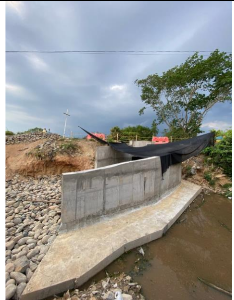
FOTO 150. 2025-03-16 ESTADO GENERAL DE LAS OBRAS DEL BOX CULVERT K0+500 VÍA SAN PABLO - SIMITÍ
