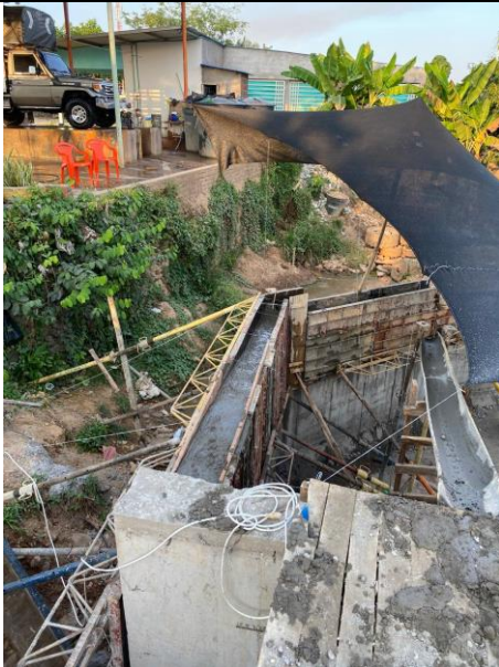
FOTO 125. 2025-03-08 FUNDIDA DE LA PARTE SUPERIOR DE LA ALETA IZQUIERDA AGUAS ABAJO DE BOX CULVERT K0+500 VÍA SAN PABLO CON CONCRETO DE 4000 PSI CON ADITIVO IMPERMEABILIZANTE Y APLICACIÓN DE ANTISOL
