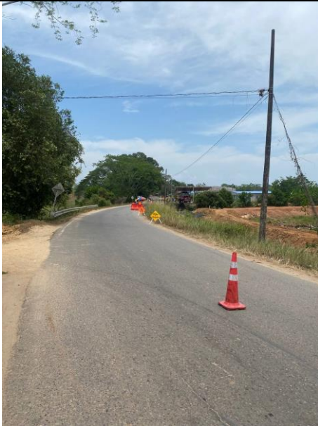
FOTO 15. 2025-03-01 IMPLEMENTACIÓN DE PMT EN CAMPO, BOX CULVERT K0+500, VÍA SAN PABLO - SIMITÍ, BOLÍVAR
