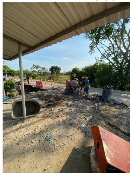
FOTO 120. 2025-03-08 FUNDIDA DE LA PARTE SUPERIOR DE LA ALETA IZQUIERDA AGUAS ABAJO DE BOX CULVERT K0+500 VÍA SAN PABLO CON CONCRETO DE 4000 PSI CON ADITIVO IMPERMEABILIZANTE Y APLICACIÓN DE ANTISOL
