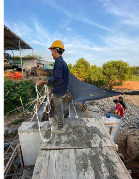
FOTO 128. 2025-03-08 FUNDIDA DE LA PARTE SUPERIOR DE LA ALETA IZQUIERDA AGUAS ABAJO DE BOX CULVERT K0+500 VÍA SAN PABLO CON CONCRETO DE 4000 PSI CON ADITIVO IMPERMEABILIZANTE Y APLICACIÓN DE ANTISOL
