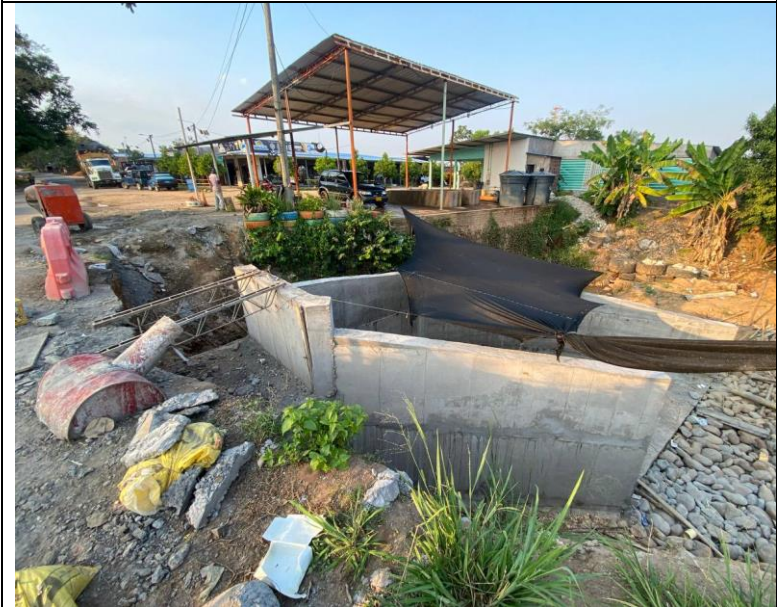
FOTO 135. 2025-03-10 ESTADO GENERAL DE LAS OBRAS DEL BOX CULVERT K0+500 VÍA SAN PABLO - SIMITÍ
