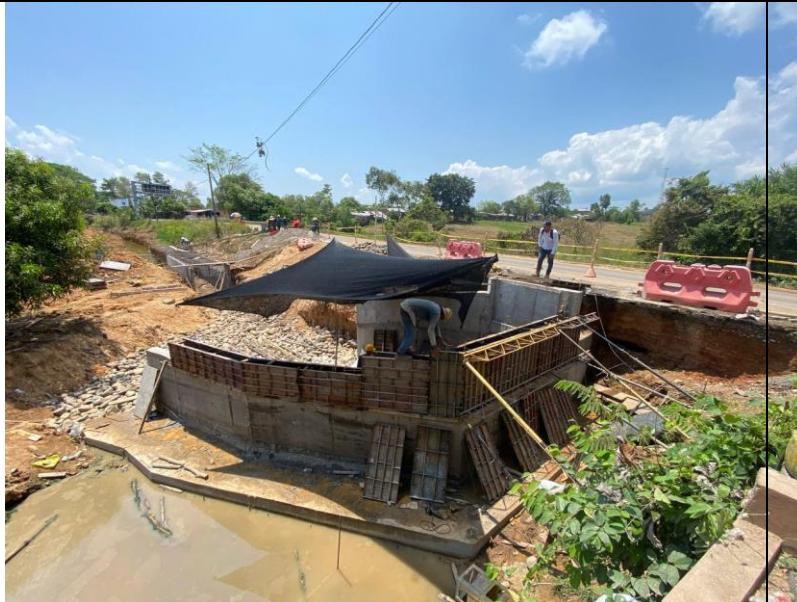
FOTO 107. 2025-03-08 FUNDIDA DE LA PARTE SUPERIOR DE LA ALETA IZQUIERDA AGUAS ABAJO DE BOX CULVERT K0+500 VÍA SAN PABLO CON CONCRETO DE 4000 PSI CON ADITIVO IMPERMEABILIZANTE Y APLICACIÓN DE ANTISOL
