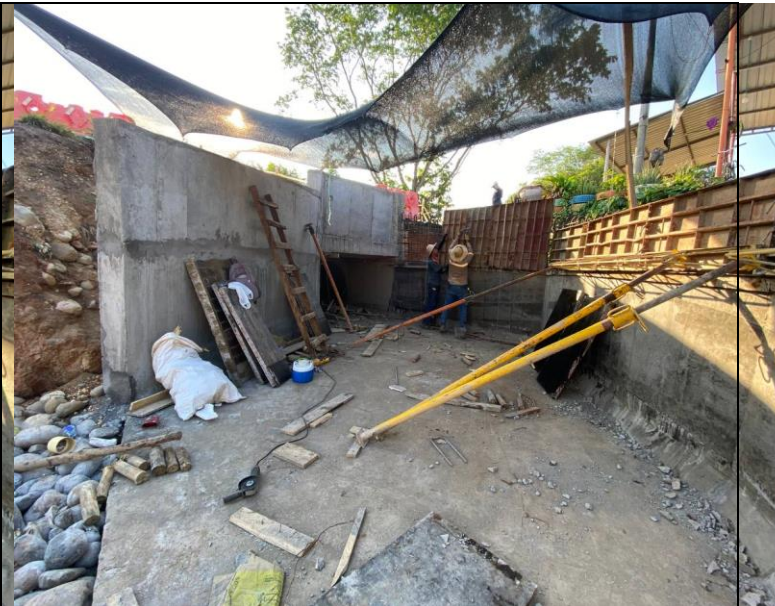
FOTO 82. 2025-03-07 DESENCOFRADO DE PARTE INFERIOR DE ALETA IZQUIERDA. SE LLEVA A CABO ENCOFRADO DE LA PARTE SUPERIOR DE LA ALETA IZQUIERDA AGUAS ABAJO DE BOX CULVERT K0+500 VÍA SAN PABLO – SIMITÍ
