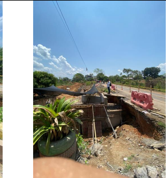
FOTO 130. 2025-03-08 FUNDIDA DE LA PARTE SUPERIOR DE LA ALETA IZQUIERDA AGUAS ABAJO DE BOX CULVERT K0+500 VÍA SAN PABLO CON CONCRETO DE 4000 PSI CON ADITIVO IMPERMEABILIZANTE Y APLICACIÓN DE ANTISOL
