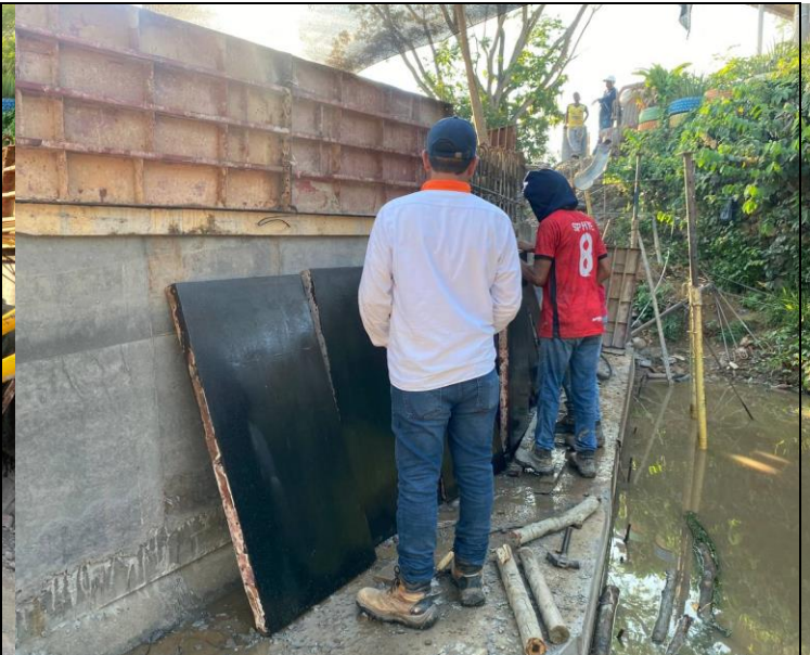
FOTO 86. 2025-03-07 DESENCOFRADO DE PARTE INFERIOR DE ALETA IZQUIERDA. SE LLEVA A CABO ENCOFRADO DE LA PARTE SUPERIOR DE LA ALETA IZQUIERDA AGUAS ABAJO DE BOX CULVERT K0+500 VÍA SAN PABLO – SIMITÍ
