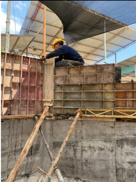
FOTO 97. 2025-03-08 FUNDIDA DE LA PARTE SUPERIOR DE LA ALETA IZQUIERDA AGUAS ABAJO DE BOX CULVERT K0+500 VÍA SAN PABLO CON CONCRETO DE 4000 PSI CON ADITIVO IMPERMEABILIZANTE Y APLICACIÓN DE ANTISOL
