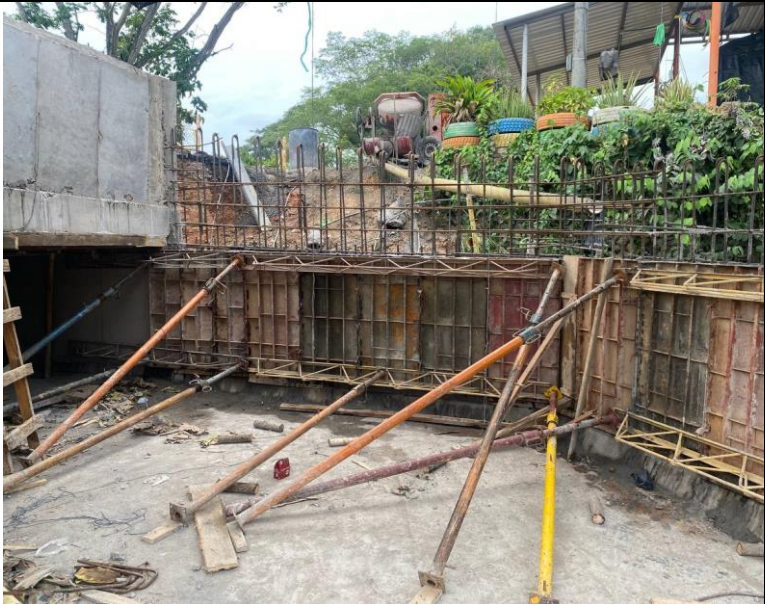
FOTO 47. 2025-03-06 FUNDIDA DE PARTE INFERIOR DE ALETA IZQUIERDA AGUAS ABAJO DE BOX CULVERT K0+500 VÍA SAN PABLO – SIMITÍ, CON CONCRETO DE 4000 PSI CON ADITIVO IMPERMEABILIZANTE Y APLICACIÓN DE ANTISOL
