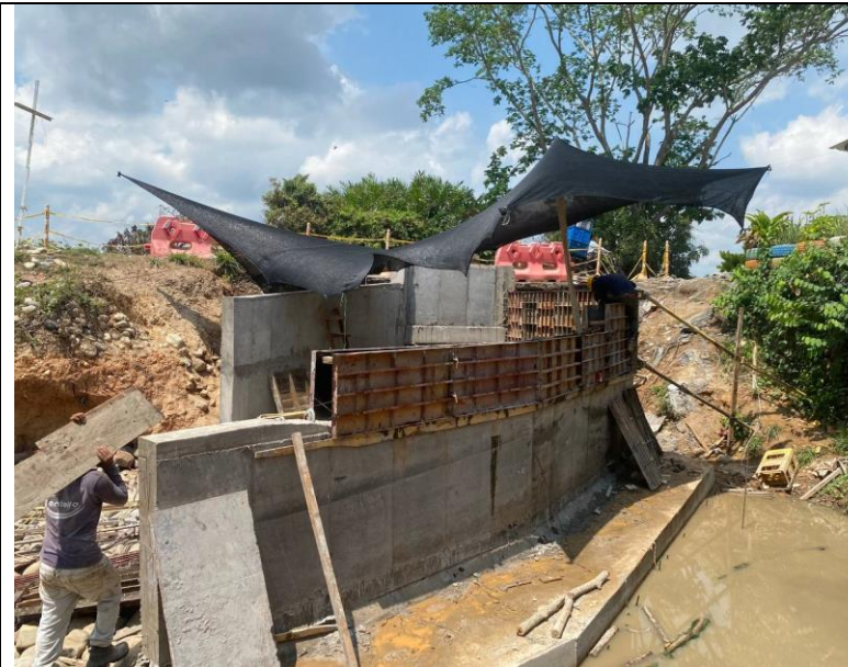
FOTO 89. 2025-03-08 FUNDIDA DE LA PARTE SUPERIOR DE LA ALETA IZQUIERDA AGUAS ABAJO DE BOX CULVERT K0+500 VÍA SAN PABLO CON CONCRETO DE 4000 PSI CON ADITIVO IMPERMEABILIZANTE Y APLICACIÓN DE ANTISOL
