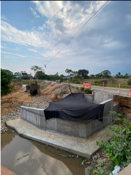
FOTO 153. 2025-03-16 ESTADO GENERAL DE LAS OBRAS DEL BOX CULVERT K0+500 VÍA SAN PABLO - SIMITÍ
