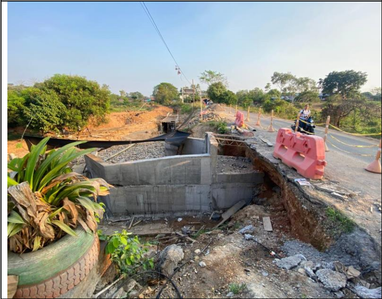
FOTO 139. 2025-03-10 ESTADO GENERAL DE LAS OBRAS DEL BOX CULVERT K0+500 VÍA SAN PABLO - SIMITÍ
