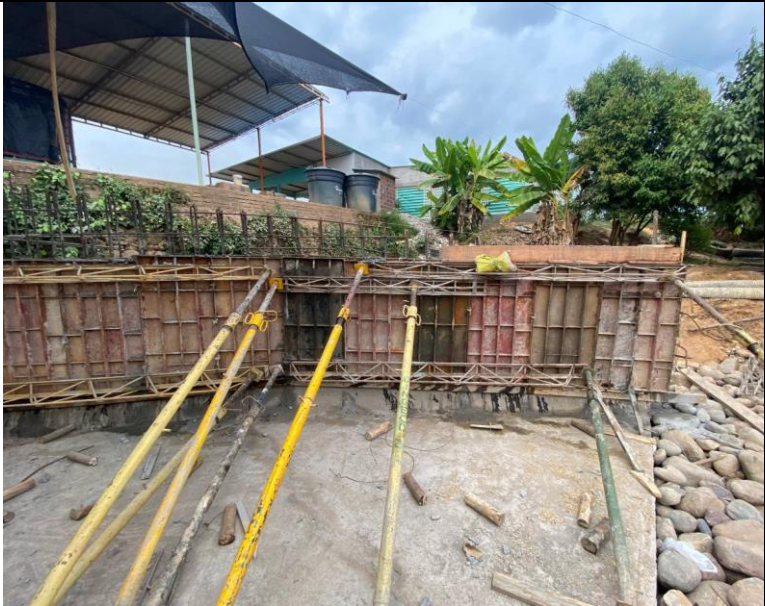
FOTO 45. 2025-03-06 FUNDIDA DE PARTE INFERIOR DE ALETA IZQUIERDA AGUAS ABAJO DE BOX CULVERT K0+500 VÍA SAN PABLO – SIMITÍ, CON CONCRETO DE 4000 PSI CON ADITIVO IMPERMEABILIZANTE Y APLICACIÓN DE ANTISOL
