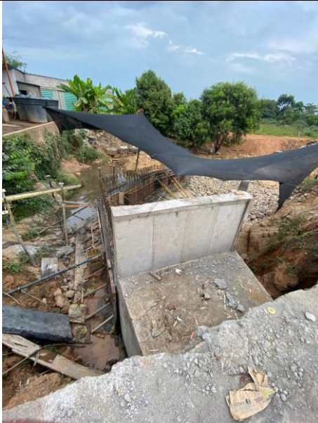
FOTO 63. 2025-03-06 FUNDIDA DE PARTE INFERIOR DE ALETA IZQUIERDA AGUAS ABAJO DE BOX CULVERT K0+500 VÍA SAN PABLO – SIMITÍ, CON CONCRETO DE 4000 PSI CON ADITIVO IMPERMEABILIZANTE Y APLICACIÓN DE ANTISOL
