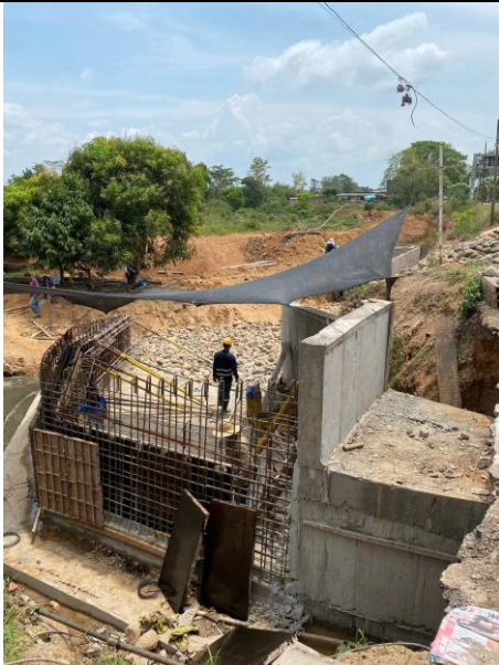
FOTO 33. 2025-03-05 CONTINUACIÓN DE ENCOFRADO DE PARTE BAJA DE LA ALETA IZQUIERDA AGUAS DEBAJO DE BOX CULVERT K0+500 VÍA SAN PABLO – SIMITÍ
