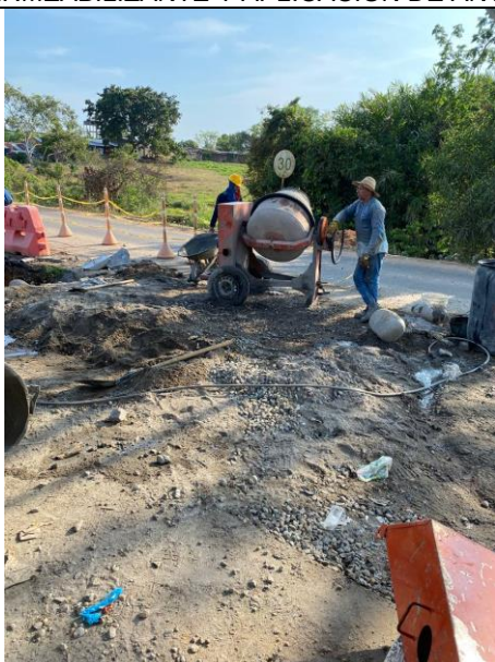
FOTO 119. 2025-03-08 FUNDIDA DE LA PARTE SUPERIOR DE LA ALETA IZQUIERDA AGUAS ABAJO DE BOX CULVERT K0+500 VÍA SAN PABLO CON CONCRETO DE 4000 PSI CON ADITIVO IMPERMEABILIZANTE Y APLICACIÓN DE ANTISOL
