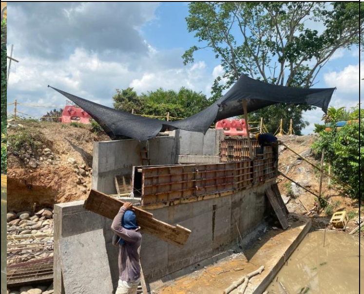
FOTO 88. 2025-03-08 FUNDIDA DE LA PARTE SUPERIOR DE LA ALETA IZQUIERDA AGUAS ABAJO DE BOX CULVERT K0+500 VÍA SAN PABLO CON CONCRETO DE 4000 PSI CON ADITIVO IMPERMEABILIZANTE Y APLICACIÓN DE ANTISOL
