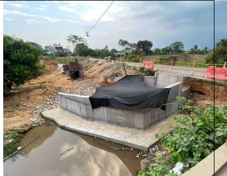
FOTO 154. 2025-03-16 ESTADO GENERAL DE LAS OBRAS DEL BOX CULVERT K0+500 VÍA SAN PABLO - SIMITÍ
