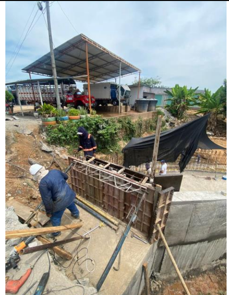
FOTO 14. 2025-03-01 DESENCOFRADO DE PARTE SUPERIOR DE LA ALETA DERECHA AGUAS DEBAJO DE BOX CULVERT K0+500 VÍA SAN PABLO – SIMITÍ. CONTINUACIÓN DE ENCONFRADO DE MURO PANTALLA EN LA PARTE SUPERIOR DE LA ESTRUCTURA DE TRANSICIÓN.
