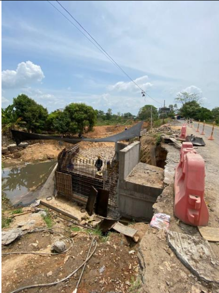
FOTO 35. 2025-03-05 CONTINUACIÓN DE ENCOFRADO DE PARTE BAJA DE LA ALETA IZQUIERDA AGUAS DEBAJO DE BOX CULVERT K0+500 VÍA SAN PABLO – SIMITÍ
