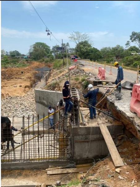
FOTO 3. 2025-03-01 DESENCOFRADO DE PARTE SUPERIOR DE LA ALETA DERECHA AGUAS DEBAJO DE BOX CULVERT K0+500 VÍA SAN PABLO – SIMITÍ. CONTINUACIÓN DE ENCONFRADO DE MURO PANTALLA EN LA PARTE SUPERIOR DE LA ESTRUCTURA DE TRANSICIÓN.
