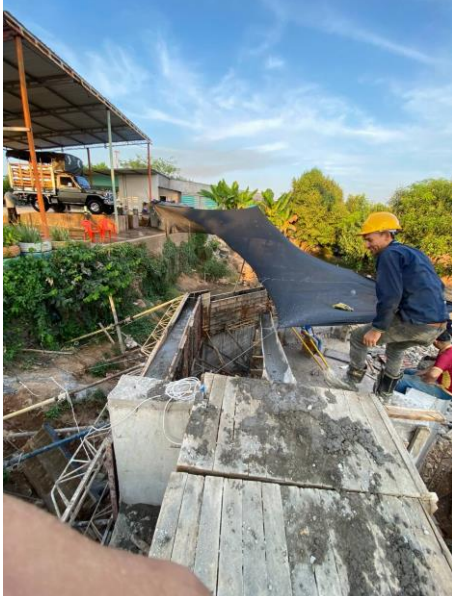
FOTO 127. 2025-03-08 FUNDIDA DE LA PARTE SUPERIOR DE LA ALETA IZQUIERDA AGUAS ABAJO DE BOX CULVERT K0+500 VÍA SAN PABLO CON CONCRETO DE 4000 PSI CON ADITIVO IMPERMEABILIZANTE Y APLICACIÓN DE ANTISOL
