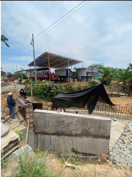
FOTO 17. 2025-03-01 DESENCOFRADO DE PARTE SUPERIOR DE LA ALETA DERECHA AGUAS DEBAJO DE BOX CULVERT K0+500 VÍA SAN PABLO – SIMITÍ. CONTINUACIÓN DE ENCOFRADO DE MURO PANTALLA EN LA PARTE SUPERIOR DE LA ESTRUCTURA DE TRANSICIÓN.
