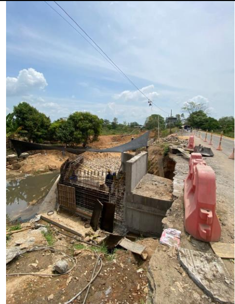
FOTO 30. 2025-03-05 CONTINUACIÓN DE ENCOFRADO DE PARTE BAJA DE LA ALETA IZQUIERDA AGUAS DEBAJO DE BOX CULVERT K0+500 VÍA SAN PABLO – SIMITÍ
