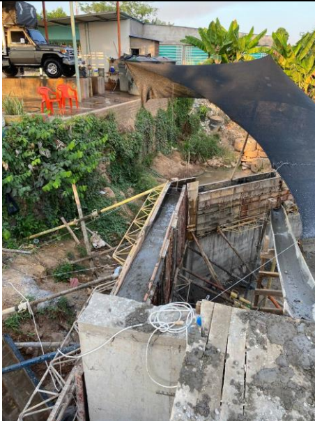
FOTO 131. 2025-03-08 FUNDIDA DE LA PARTE SUPERIOR DE LA ALETA IZQUIERDA AGUAS ABAJO DE BOX CULVERT K0+500 VÍA SAN PABLO CON CONCRETO DE 4000 PSI CON ADITIVO IMPERMEABILIZANTE Y APLICACIÓN DE ANTISOL
