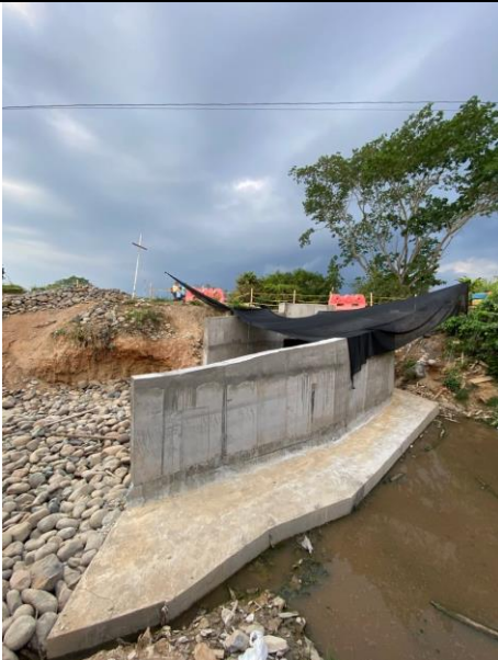
FOTO 149. 2025-03-16 ESTADO GENERAL DE LAS OBRAS DEL BOX CULVERT K0+500 VÍA SAN PABLO - SIMITÍ
