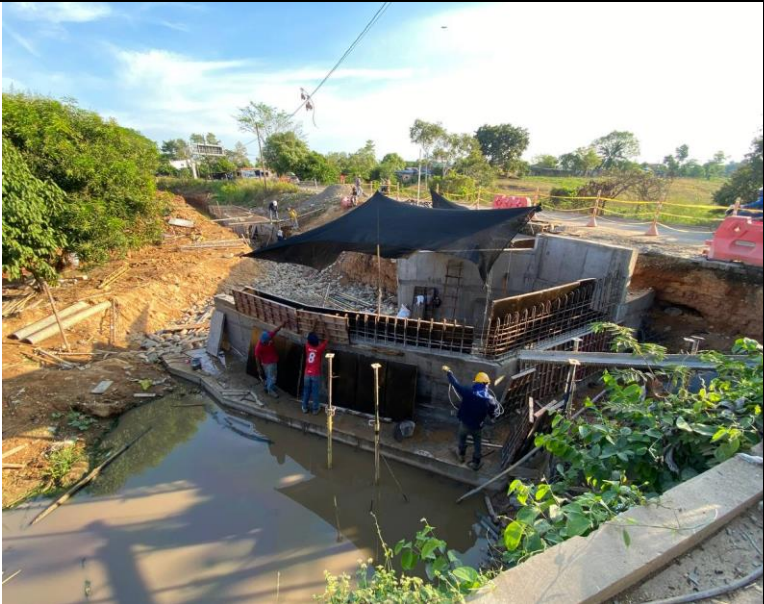
FOTO 69. 2025-03-07 DESENCOFRADO DE PARTE INFERIOR DE ALETA IZQUIERDA. SE LLEVA A CABO ENCOFRADO DE LA PARTE SUPERIOR DE LA ALETA IZQUIERDA AGUAS ABAJO DE BOX CULVERT K0+500 VÍA SAN PABLO – SIMITÍ
