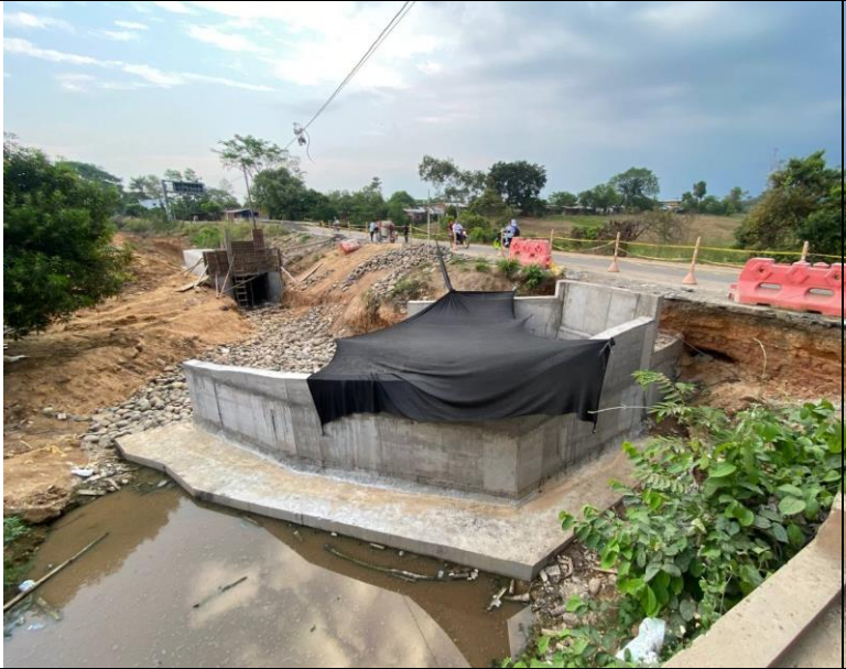
FOTO 155. 2025-03-16 ESTADO GENERAL DE LAS OBRAS DEL BOX CULVERT K0+500 VÍA SAN PABLO - SIMITÍ
