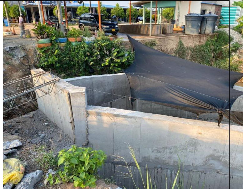
FOTO 132. 2025-03-10 ESTADO GENERAL DE LAS OBRAS DEL BOX CULVERT K0+500 VÍA SAN PABLO - SIMITÍ
