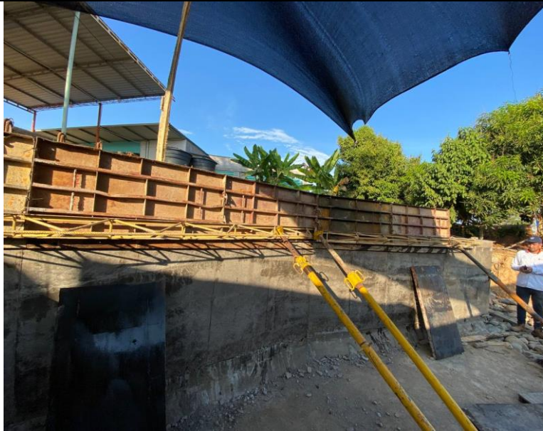
FOTO 77. 2025-03-07 DESENCOFRADO DE PARTE INFERIOR DE ALETA IZQUIERDA. SE LLEVA A CABO ENCOFRADO DE LA PARTE SUPERIOR DE LA ALETA IZQUIERDA AGUAS ABAJO DE BOX CULVERT K0+500 VÍA SAN PABLO – SIMITÍ
