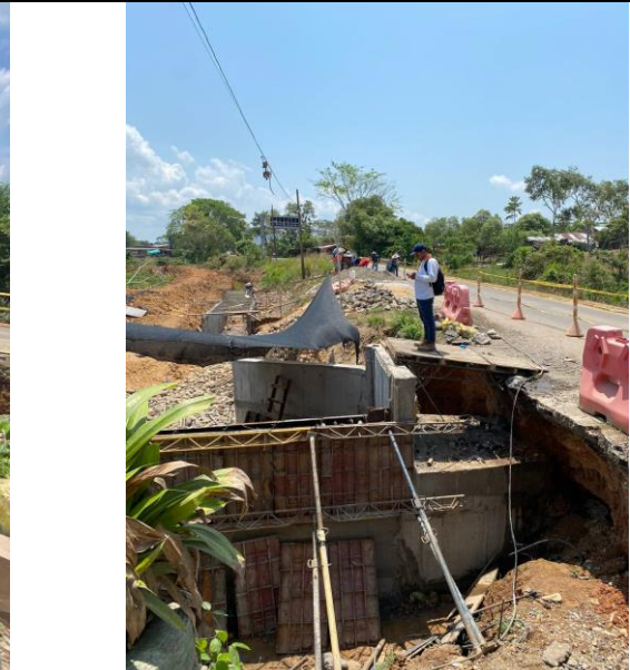
FOTO 108. 2025-03-08 FUNDIDA DE LA PARTE SUPERIOR DE LA ALETA IZQUIERDA AGUAS ABAJO DE BOX CULVERT K0+500 VÍA SAN PABLO CON CONCRETO DE 4000 PSI CON ADITIVO IMPERMEABILIZANTE Y APLICACIÓN DE ANTISOL
