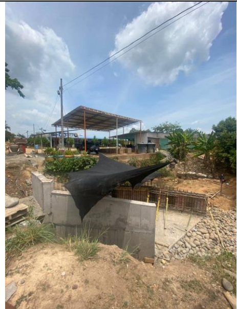
FOTO 28. 2025-03-05 CONTINUACIÓN DE ENCOFRADO DE PARTE BAJA DE LA ALETA IZQUIERDA AGUAS DEBAJO DE BOX CULVERT K0+500 VÍA SAN PABLO – SIMITÍ
