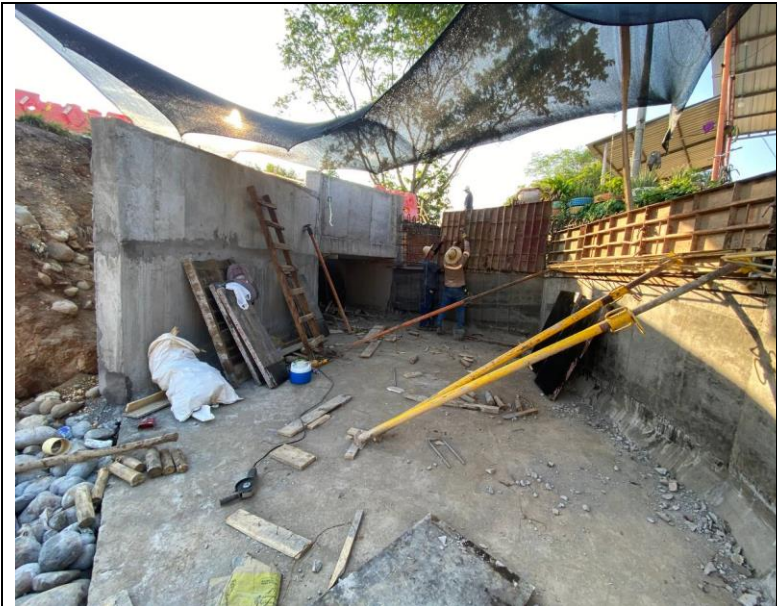
FOTO 81. 2025-03-07 DESENCOFRADO DE PARTE INFERIOR DE ALETA IZQUIERDA. SE LLEVA A CABO ENCOFRADO DE LA PARTE SUPERIOR DE LA ALETA IZQUIERDA AGUAS ABAJO DE BOX CULVERT K0+500 VÍA SAN PABLO – SIMITÍ
