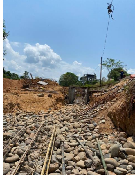
FOTO 100. 2025-03-08 FUNDIDA DE LA PARTE SUPERIOR DE LA ALETA IZQUIERDA AGUAS ABAJO DE BOX CULVERT K0+500 VÍA SAN PABLO CON CONCRETO DE 4000 PSI CON ADITIVO IMPERMEABILIZANTE Y APLICACIÓN DE ANTISOL
