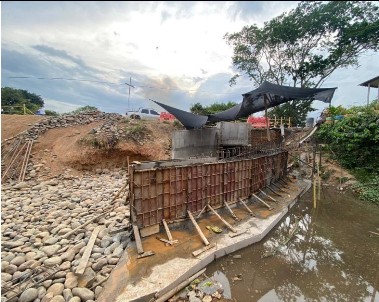
FOTO 49. 2025-03-06 FUNDIDA DE PARTE INFERIOR DE ALETA IZQUIERDA AGUAS ABAJO DE BOX CULVERT K0+500 VÍA SAN PABLO – SIMITÍ, CON CONCRETO DE 4000 PSI CON ADITIVO IMPERMEABILIZANTE Y APLICACIÓN DE ANTISOL
