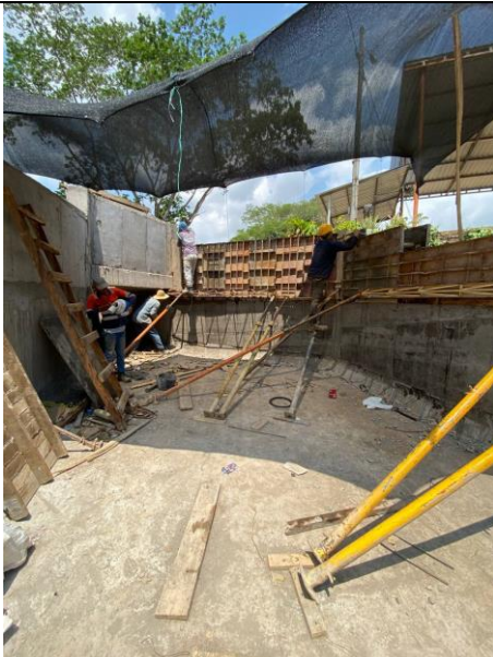
FOTO 103. 2025-03-08 FUNDIDA DE LA PARTE SUPERIOR DE LA ALETA IZQUIERDA AGUAS ABAJO DE BOX CULVERT K0+500 VÍA SAN PABLO CON CONCRETO DE 4000 PSI CON ADITIVO IMPERMEABILIZANTE Y APLICACIÓN DE ANTISOL
