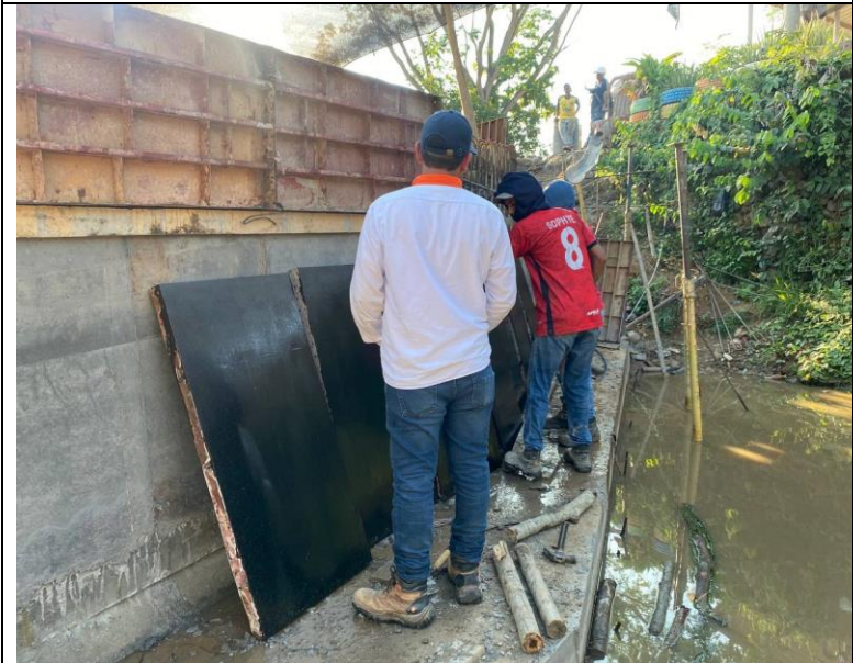
FOTO 87. 2025-03-07 DESENCOFRADO DE PARTE INFERIOR DE ALETA IZQUIERDA. SE LLEVA A CABO ENCOFRADO DE LA PARTE SUPERIOR DE LA ALETA IZQUIERDA AGUAS ABAJO DE BOX CULVERT K0+500 VÍA SAN PABLO – SIMITÍ
