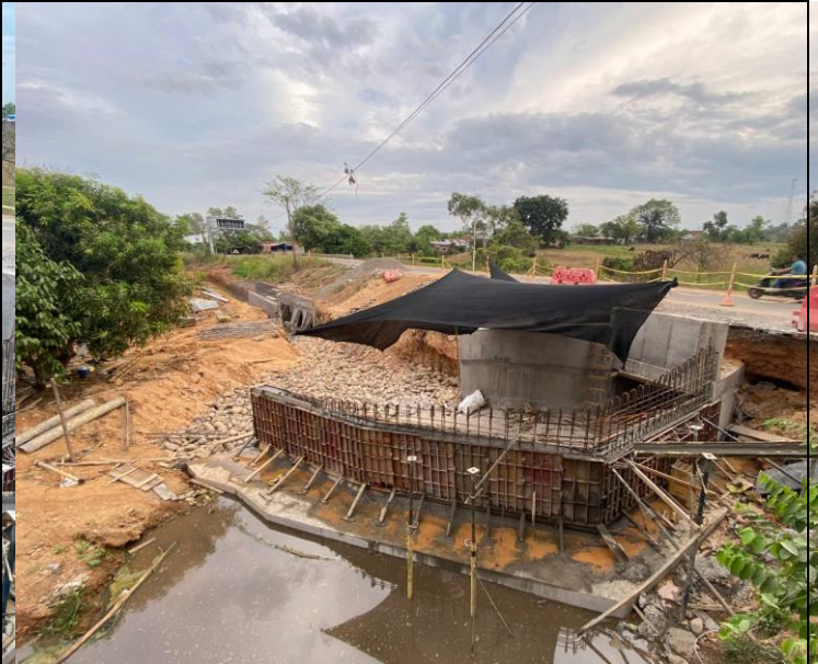
FOTO 54. 2025-03-06 FUNDIDA DE PARTE INFERIOR DE ALETA IZQUIERDA AGUAS ABAJO DE BOX CULVERT K0+500 VÍA SAN PABLO – SIMITÍ, CON CONCRETO DE 4000 PSI CON ADITIVO IMPERMEABILIZANTE Y APLICACIÓN DE ANTISOL
