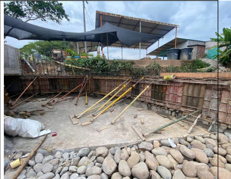
FOTO 40. 2025-03-06 FUNDIDA DE PARTE INFERIOR DE ALETA IZQUIERDA AGUAS ABAJO DE BOX CULVERT K0+500 VÍA SAN PABLO – SIMITÍ, CON CONCRETO DE 4000 PSI CON ADITIVO IMPERMEABILIZANTE Y APLICACIÓN DE ANTISOL
