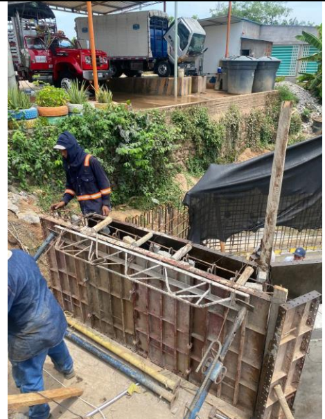
FOTO 10. 2025-03-01 DESENCOFRADO DE PARTE SUPERIOR DE LA ALETA DERECHA AGUAS DEBAJO DE BOX CULVERT K0+500 VÍA SAN PABLO – SIMITÍ. CONTINUACIÓN DE ENCONFRADO DE MURO PANTALLA EN LA PARTE SUPERIOR DE LA ESTRUCTURA DE TRANSICIÓN.
