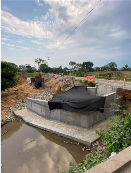
FOTO 151. 2025-03-16 ESTADO GENERAL DE LAS OBRAS DEL BOX CULVERT K0+500 VÍA SAN PABLO - SIMITÍ
