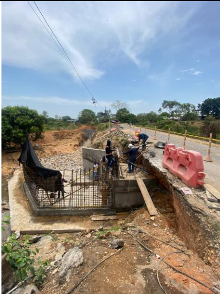
FOTO 5. 2025-03-01 DESENCOFRADO DE PARTE SUPERIOR DE LA ALETA DERECHA AGUAS DEBAJO DE BOX CULVERT K0+500 VÍA SAN PABLO – SIMITÍ. CONTINUACIÓN DE ENCOFRADO DE MURO PANTALLA EN LA PARTE SUPERIOR DE LA ESTRUCTURA DE TRANSICIÓN.
