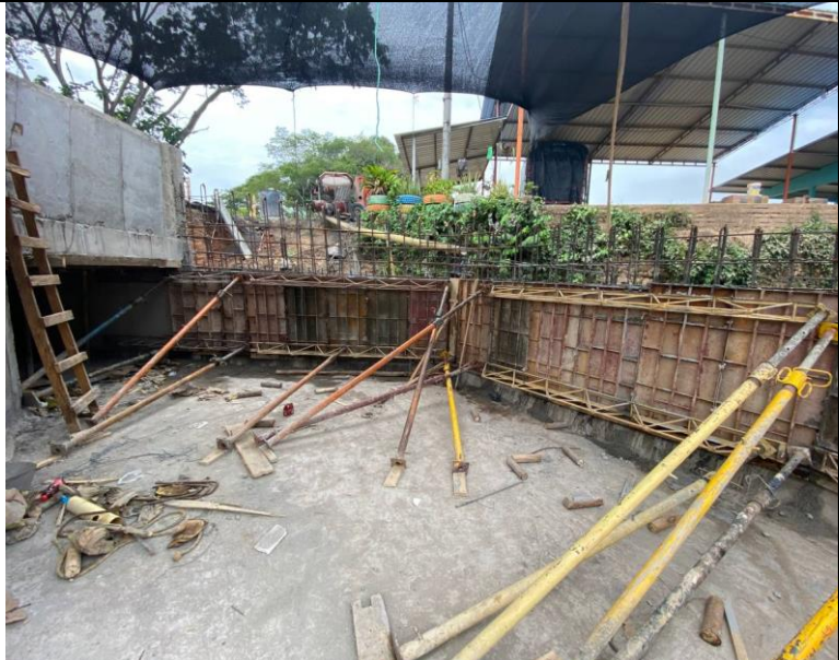
FOTO 43. 2025-03-06 FUNDIDA DE PARTE INFERIOR DE ALETA IZQUIERDA AGUAS ABAJO DE BOX CULVERT K0+500 VÍA SAN PABLO – SIMITÍ, CON CONCRETO DE 4000 PSI CON ADITIVO IMPERMEABILIZANTE Y APLICACIÓN DE ANTISOL
