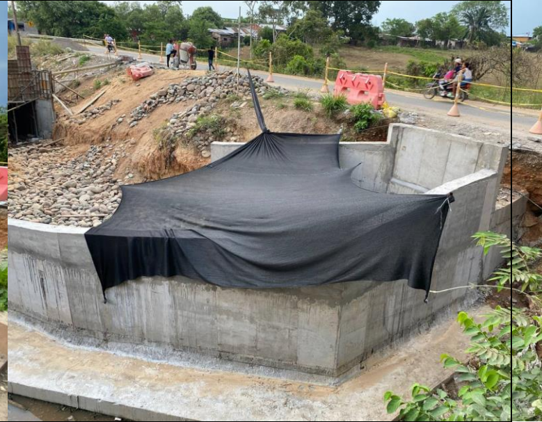
FOTO 156. 2025-03-16 ESTADO GENERAL DE LAS OBRAS DEL BOX CULVERT K0+500 VÍA SAN PABLO - SIMITÍ
