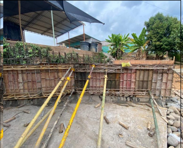
FOTO 44. 2025-03-06 FUNDIDA DE PARTE INFERIOR DE ALETA IZQUIERDA AGUAS ABAJO DE BOX CULVERT K0+500 VÍA SAN PABLO – SIMITÍ, CON CONCRETO DE 4000 PSI CON ADITIVO IMPERMEABILIZANTE Y APLICACIÓN DE ANTISOL
