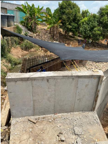
FOTO 27. 2025-03-05 CONTINUACIÓN DE ENCOFRADO DE PARTE BAJA DE LA ALETA IZQUIERDA AGUAS DEBAJO DE BOX CULVERT K0+500 VÍA SAN PABLO – SIMITÍ
