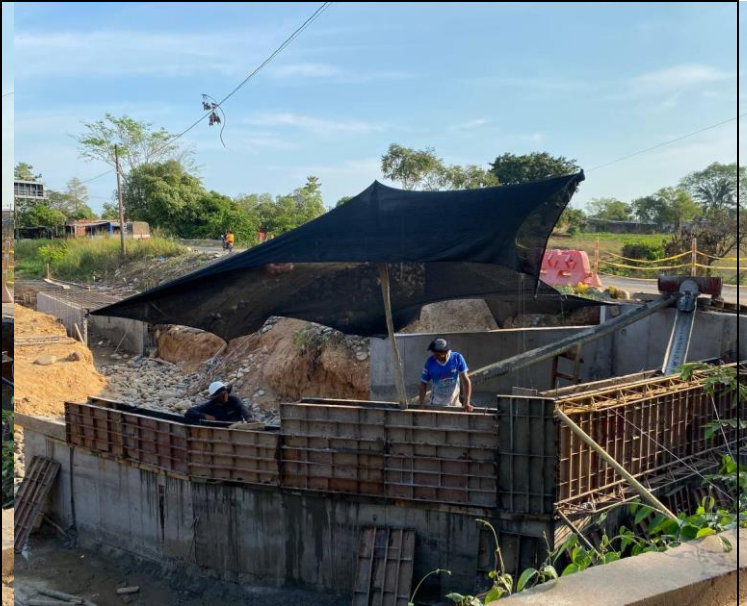
FOTO 122. 2025-03-08 FUNDIDA DE LA PARTE SUPERIOR DE LA ALETA IZQUIERDA AGUAS ABAJO DE BOX CULVERT K0+500 VÍA SAN PABLO CON CONCRETO DE 4000 PSI CON ADITIVO IMPERMEABILIZANTE Y APLICACIÓN DE ANTISOL
