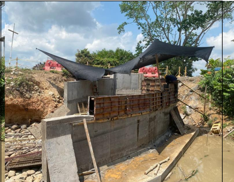
FOTO 90. 2025-03-08 FUNDIDA DE LA PARTE SUPERIOR DE LA ALETA IZQUIERDA AGUAS ABAJO DE BOX CULVERT K0+500 VÍA SAN PABLO CON CONCRETO DE 4000 PSI CON ADITIVO IMPERMEABILIZANTE Y APLICACIÓN DE ANTISOL
