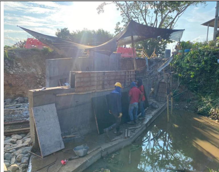
FOTO 73. 2025-03-07 DESENCOFRADO DE PARTE INFERIOR DE ALETA IZQUIERDA. SE LLEVA A CABO ENCOFRADO DE LA PARTE SUPERIOR DE LA ALETA IZQUIERDA AGUAS ABAJO DE BOX CULVERT K0+500 VÍA SAN PABLO – SIMITÍ
