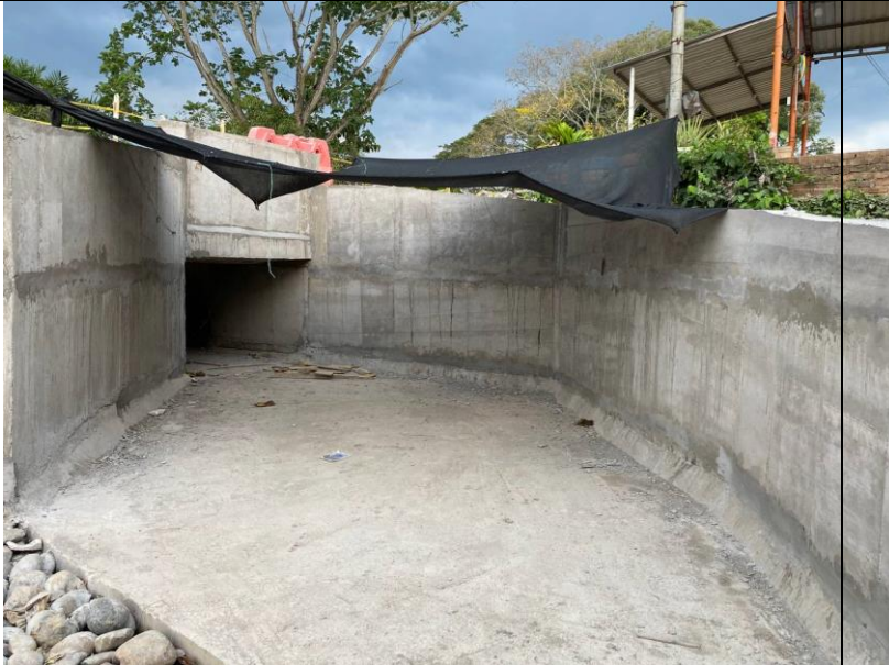
FOTO 147. 2025-03-16 ESTADO GENERAL DE LAS OBRAS DEL BOX CULVERT K0+500 VÍA SAN PABLO - SIMITÍ
