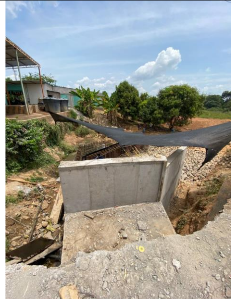
FOTO 32. 2025-03-05 CONTINUACIÓN DE ENCOFRADO DE PARTE BAJA DE LA ALETA IZQUIERDA AGUAS DEBAJO DE BOX CULVERT K0+500 VÍA SAN PABLO – SIMITÍ
