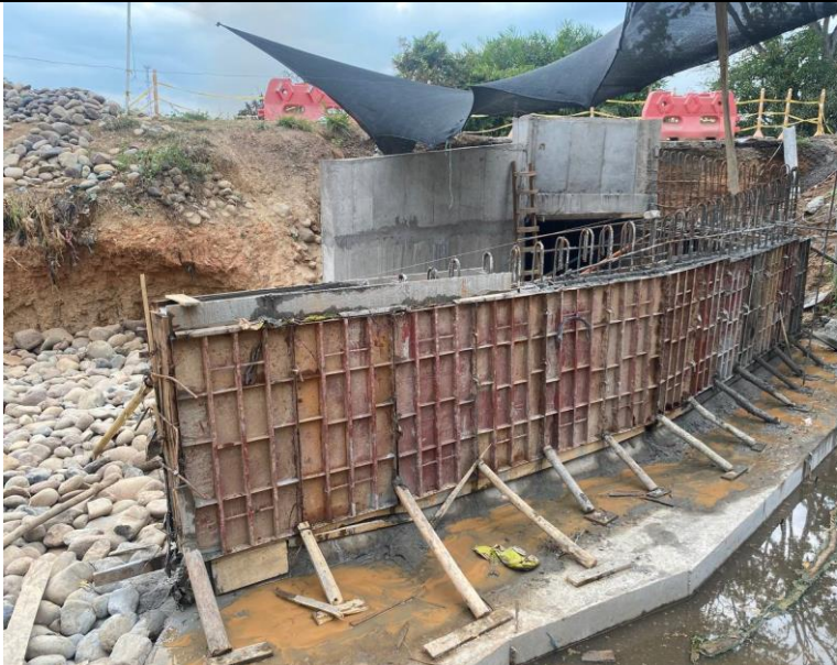
FOTO 51. 2025-03-06 FUNDIDA DE PARTE INFERIOR DE ALETA IZQUIERDA AGUAS ABAJO DE BOX CULVERT K0+500 VÍA SAN PABLO – SIMITÍ, CON CONCRETO DE 4000 PSI CON ADITIVO IMPERMEABILIZANTE Y APLICACIÓN DE ANTISOL
