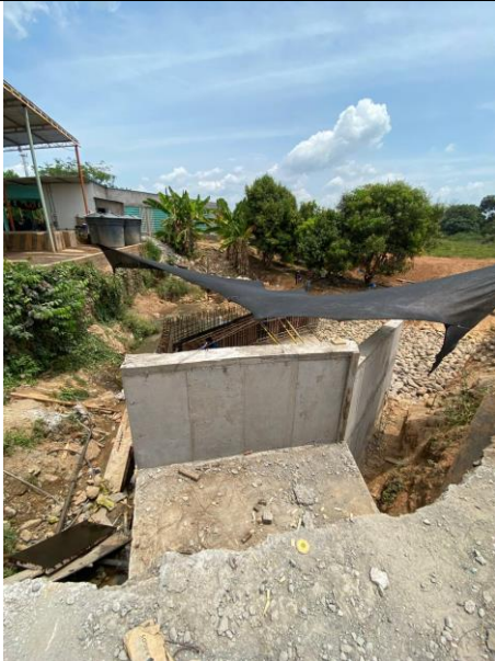
FOTO 31. 2025-03-05 CONTINUACIÓN DE ENCOFRADO DE PARTE BAJA DE LA ALETA IZQUIERDA AGUAS DEBAJO DE BOX CULVERT K0+500 VÍA SAN PABLO – SIMITÍ
