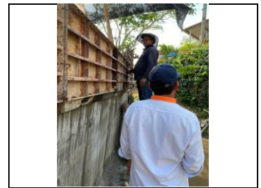
08/03/2025 INSTALACIÓN DE FORMALETAS PARA PODER REALIZAR VACIADO DE PARTE SUPERIOR DE MURO IZQUIERDO AGUAS ABAJO DE BOX CULVERT K0+500, VÍA SAN PABLO - SIMITÍ, BOLÍVAR
