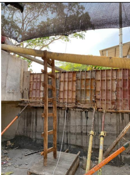
FOTO 117. 2025-03-08 FUNDIDA DE LA PARTE SUPERIOR DE LA ALETA IZQUIERDA AGUAS ABAJO DE BOX CULVERT K0+500 VÍA SAN PABLO CON CONCRETO DE 4000 PSI CON ADITIVO IMPERMEABILIZANTE Y APLICACIÓN DE ANTISOL
