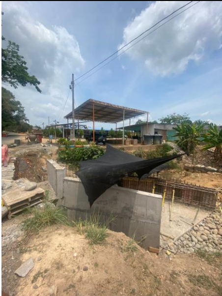
FOTO 29. 2025-03-05 CONTINUACIÓN DE ENCOFRADO DE PARTE BAJA DE LA ALETA IZQUIERDA AGUAS DEBAJO DE BOX CULVERT K0+500 VÍA SAN PABLO – SIMITÍ
