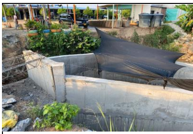
10/03/2025 VISTA DE BOX CULVERT K0+500, VÍA SAN PABLO - SIMITÍ, BOLÍVAR
