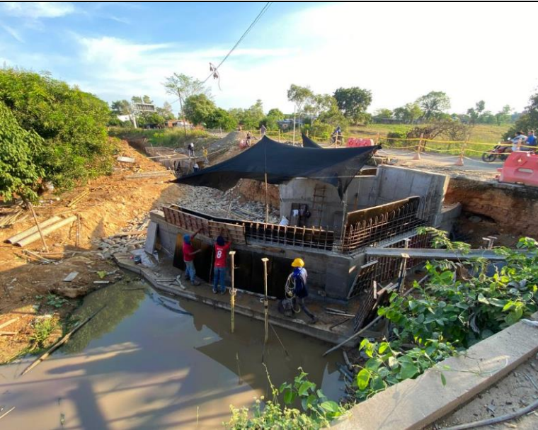
FOTO 67. 2025-03-07 DESENCOFRADO DE PARTE INFERIOR DE ALETA IZQUIERDA. SE LLEVA A CABO ENCOFRADO DE LA PARTE SUPERIOR DE LA ALETA IZQUIERDA AGUAS ABAJO DE BOX CULVERT K0+500 VÍA SAN PABLO – SIMITÍ
