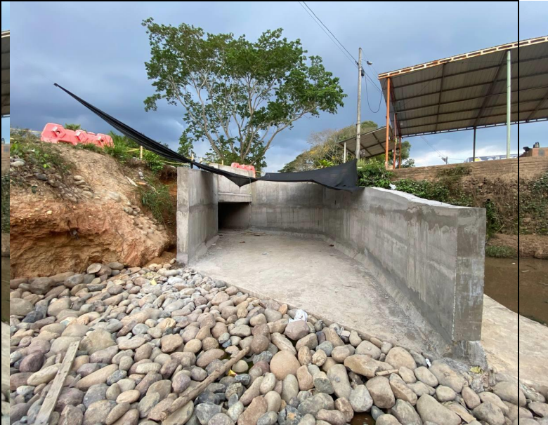
FOTO 158. 2025-03-16 ESTADO GENERAL DE LAS OBRAS DEL BOX CULVERT K0+500 VÍA SAN PABLO - SIMITÍ
