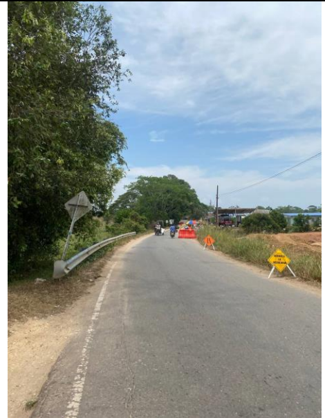
FOTO 16. 2025-03-01 IMPLEMENTACIÓN DE PMT EN CAMPO, BOX CULVERT K0+500, VÍA SAN PABLO - SIMITÍ, BOLÍVAR
