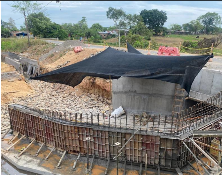
FOTO 53. 2025-03-06 FUNDIDA DE PARTE INFERIOR DE ALETA IZQUIERDA AGUAS ABAJO DE BOX CULVERT K0+500 VÍA SAN PABLO – SIMITÍ, CON CONCRETO DE 4000 PSI CON ADITIVO IMPERMEABILIZANTE Y APLICACIÓN DE ANTISOL
