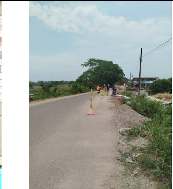
FOTO 164. 2025-03-25 ESTADO GENERAL DE LAS OBRAS DEL BOX CULVERT K0+500 VÍA SAN PABLO - SIMITÍ
