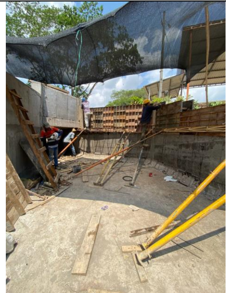
FOTO 104. 2025-03-08 FUNDIDA DE LA PARTE SUPERIOR DE LA ALETA IZQUIERDA AGUAS ABAJO DE BOX CULVERT K0+500 VÍA SAN PABLO CON CONCRETO DE 4000 PSI CON ADITIVO IMPERMEABILIZANTE Y APLICACIÓN DE ANTISOL
