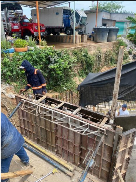
FOTO 9. 2025-03-01 DESENCOFRADO DE PARTE SUPERIOR DE LA ALETA DERECHA AGUAS DEBAJO DE BOX CULVERT K0+500 VÍA SAN PABLO – SIMITÍ. CONTINUACIÓN DE ENCONFRADO DE MURO PANTALLA EN LA PARTE SUPERIOR DE LA ESTRUCTURA DE TRANSICIÓN.
