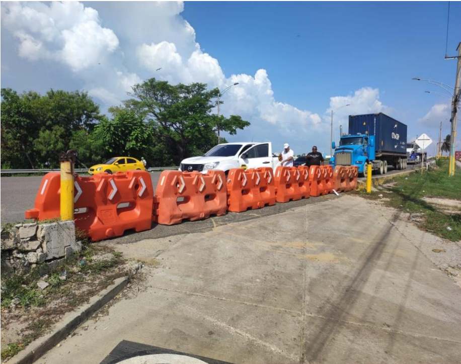
FOTO 2: BLOQUEO CALLE 29 CON CALLE 28 (S.P.C)
