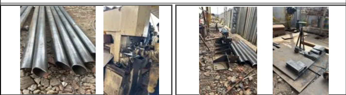
SE ADELANTAN TRABAJOS EN EL SUMINISTRO Y TRABAJOS EN AVANCE DE ESTRUCTURA METÁLICA DE CUBIERTA DE DOMOS EN TALLER UBICADO EN LA CIUDAD DE BOGOTÁ.
