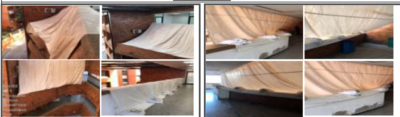
INSTALACION DE LONA EN PISO 5 Y 4 DE TORRE AB PARA PROTECCION CONTRA INGRESO DE AGUA POR CUBIERTA TIPO DOMO // ESTA ACTIVIDAD SE REALIZA POR SUGERENCIA DE LA SUPERVISION DE LA OBRA DEBIDO A QUE SE PRESENTA UN INGRESO DE AGUA BASTANTE NOTABLE DESDE LA CUBIERTA DOMO DEL HALL DE LA TORRE B EN SU NIVEL SUPERIOR Y PRODUCE ENCHARCAMIENTOS EN EL PISO 4 POR UN DESNIVEL PRESENTE. POR LO TANTO SE HARA UN SEGUIMIENTO AL RESPECTO DE ESTA SOLUCION PROVISIONAL
