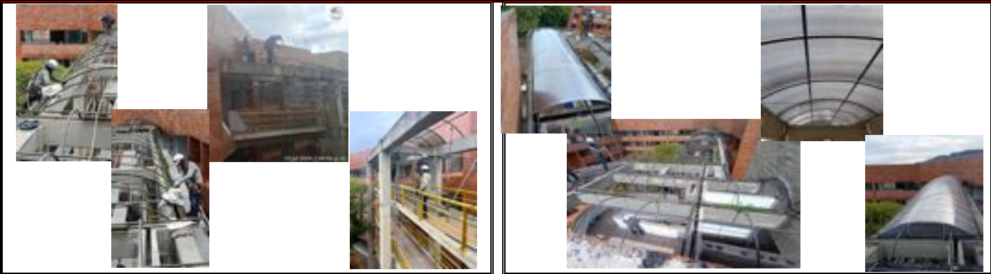
REMOCIÓN DE COBERTURA VEGETAL, LAVADO CON HIDRO LAVADORA, IMPERMEABILIZACIÓN, PINTURA DE ESTRUCTURA METÁLICA, DESINSTALACIÓN DE CUBIERTA DE CONEXIÓN DE POLICARBONATO, PARA REALIZAR LA INSTALACIÓN DE POLICARBONATO NUEVO.
