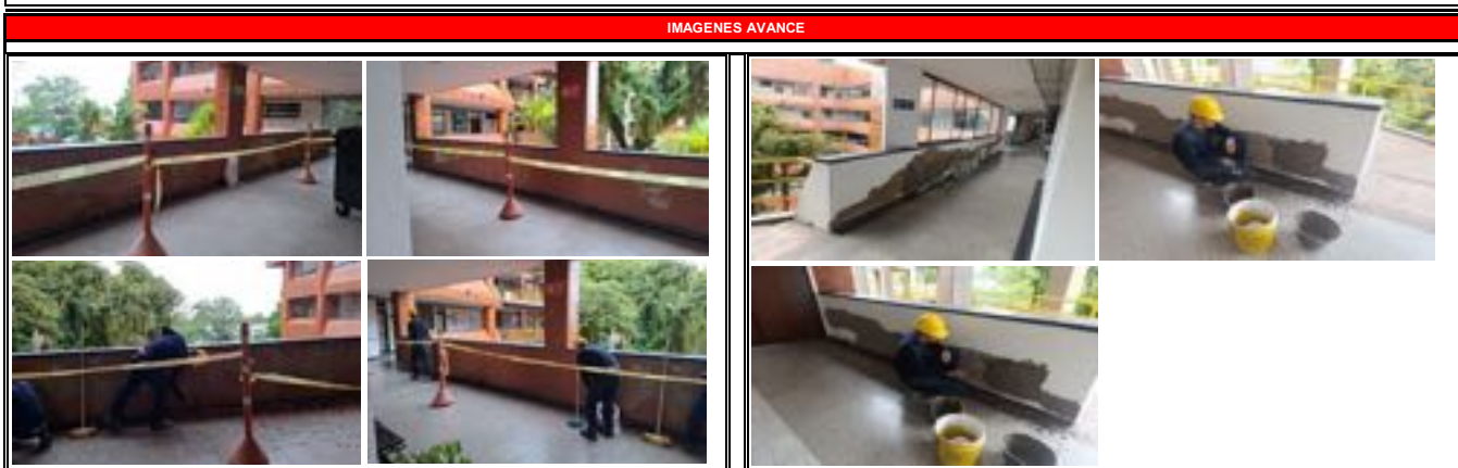
ESCARIFICADO DE MUROS DE ANTEPECHOS EN CORREDORES TORRE A - APLICACIÓN DE PAÑETE IMPERMEABILIZADO // SE HACE LA MEZCLA CON IMPERMUR Y SIKA, ASI COMO LATEX PARA FIJAR Y EVITAR QUE SE VUELVAN A PRESENTAR FALLOS Y TRAZAS DE HUMEDAD EN LA PARED, CABE ACLARAR QUE SE PRESENTAN FISURAS EN LAS ALFAJIAS QUE PUEDEN AFECTAR EL DESARROLLO DE LA ACTIVIDAD
