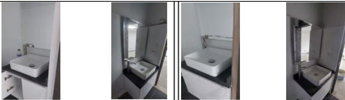
INSTALACION DE LAVAMANOS Y ESPEJOS EN BAÑOS DE OFICINAS PISO 5 TORRE B ALA B
