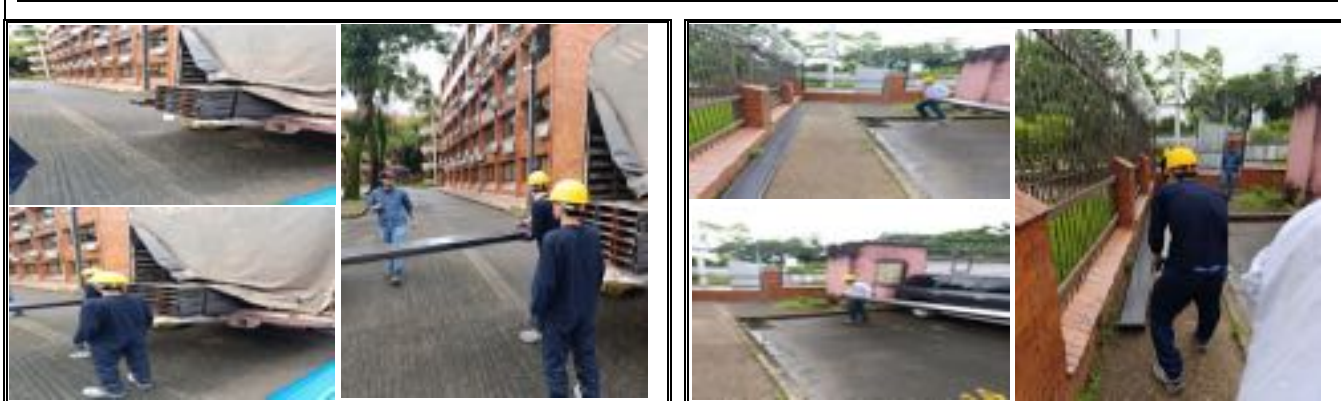
LLEGADA DE PERFILES METALICOS PARA ESTRUCTURA DE CUBIERTA Y ALMACENAMIENTO EN AREA DESIGNADA // SE HACE EL DESCARGUE DEL MATERIAL DESDE EL VEHICULO TRANSPORTADOR Y SE ADECUA EN EL AREA QUE ANTERIORMENTE SE UTILIZÓ PARA COLOCAR LOS PERFILES Y POSTERIORMENTE HACER EL TRANSPORTE HACIA EL PISO 5 DONDE SE EJECUTA LA INSTALACIÓN DE LOS PERFILES PARA LA CUBIERTA
