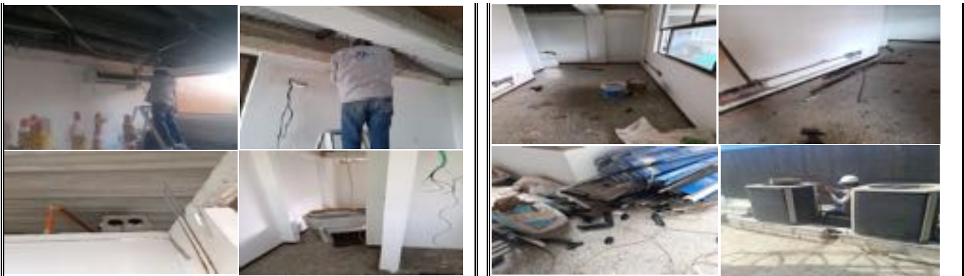
DESMONTE DE MINI SPLIT, UNIDADES DE AIRE ACONDICIONADO, MANEJADORAS Y TUBERÍA PARA OFICINAS 501 A 507 PISO 5 TORRE B - SE DESMONTAN Y ALMACENAN LOS EQUIPOS MINI SPLIT DE AIRES ACONDICIONADOS Y SE ALMACENAN EN SITIO SEGURO PARA SU POSTERIOR REINSTALACIÓN. LA TUBERÍA DESMONTADA SE DEJA ALMACENADA EN LA OFICINA ASIGNADA AL AREA ADMINISTRATIVA DE OBRA PARA POSTERIOR ENTREGA.
