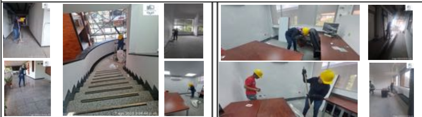
JORNADAS DE ORDEN Y ASEO DIARIO EN LA OBRA
