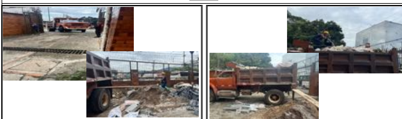
RETIRO DE ESCOMBROS - SE REALIZA EL MOVIMIENTO Y RETIRO DE ESCOMBROS Y RESIDUOS DE LA OBRA CON EL VEHICULO QUE HA ESTADO AUTORIZADO DESDE EL INICIO DE LA OBRA. CABE ANOTAR QUE EL COORDINADOR ADMINISTRATIVO SOLICITA LE SEAN ENTREGADOS UNOS PERFILES. Y SE QUEDA A AL ESPERA DE LA ENTREGA DEL CERTIFICADO DE DISPOSICIÓN DE RESIDUOS QUE DEBE ENTREGAR LA ESCOMBREIRA AL AREA HSE DEL CONTRATISTA
