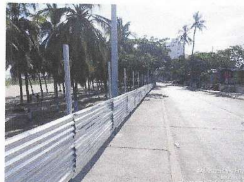
Instalación de cerramiento provisional.
