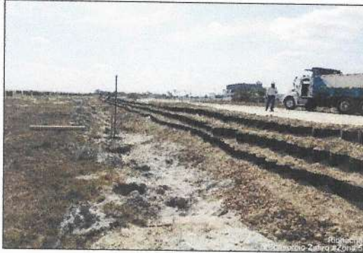
Instalación de Geocelda
