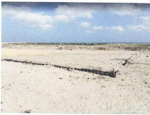
Transporte y compactación de material de sitio
