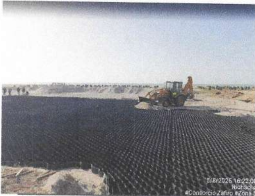
Instalación de geocelda 356-150.
