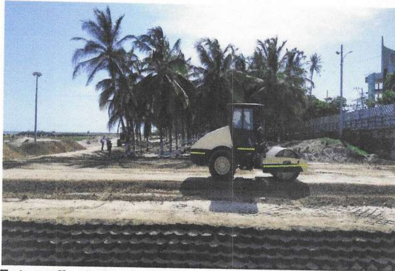
Fotografía. 1. Compactación de terreno en recebo.
