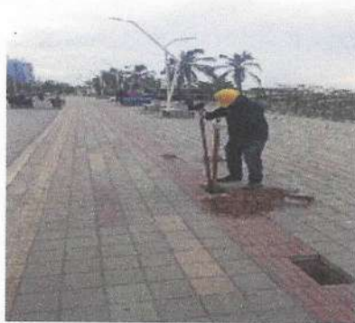
Instalación de cerramiento provisional.
