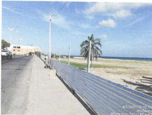
Instalación de cerramiento provisional.
