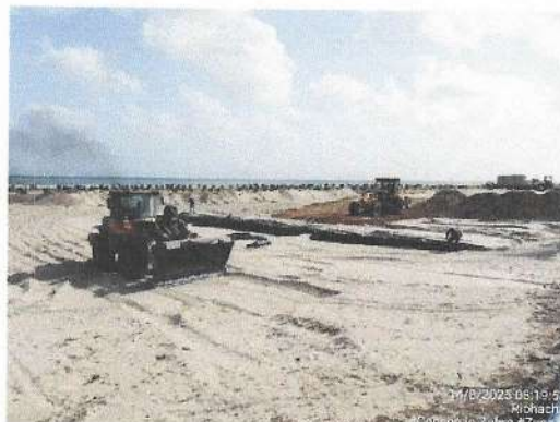
Excavación de terreno natural.
