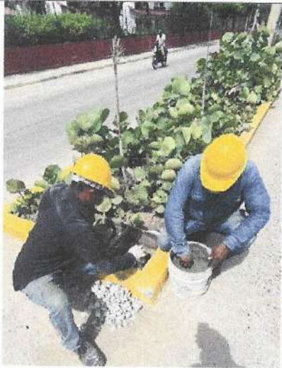
Excavación para la materialización de los puntos GPS1 y GPS2.
