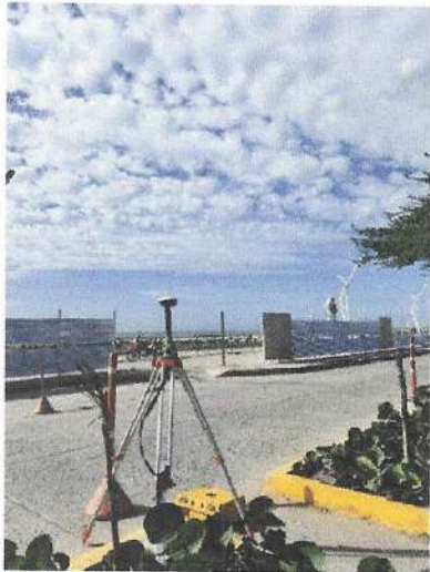
Marcación de los puntos de cerramiento.
