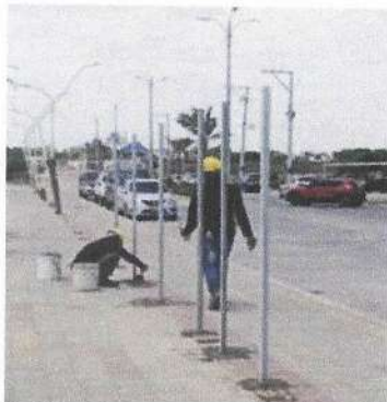
Instalación de cerramiento provisional.
