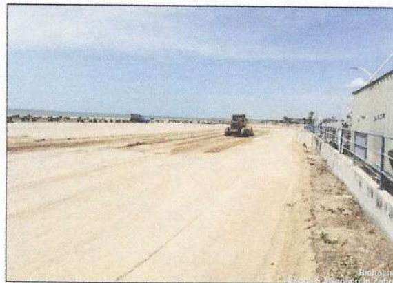
Actividades de rellenos en zona 5
