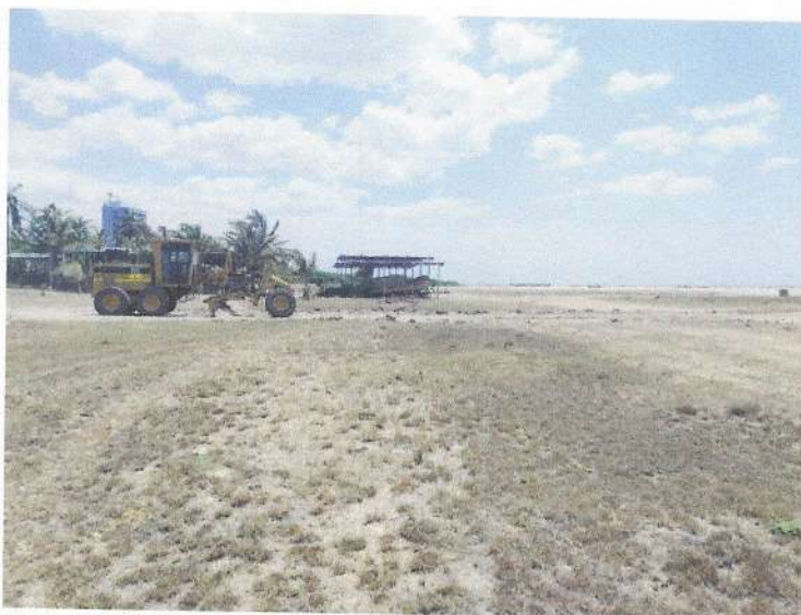
Fotografía 3. Descapote y limpieza.
