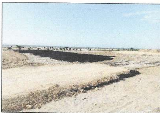
Instalación de geocelda en zona 5.
