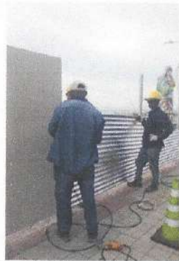
Instalación de cerramiento provisional.
