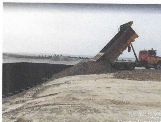
Compactación de geocelda 356-150.
