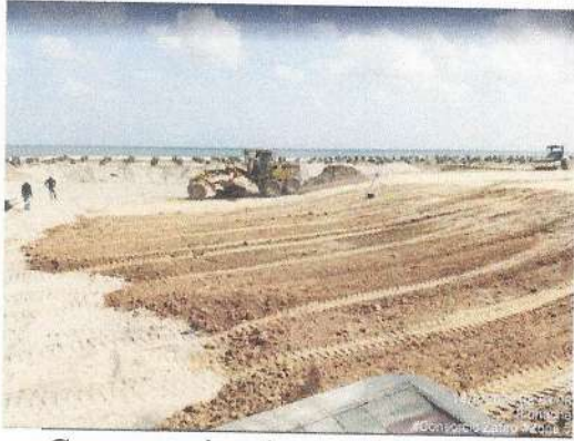
Compactacion de material en sitio.
