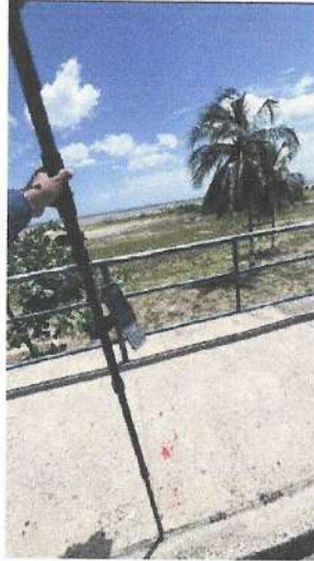
Marcación de los puntos de cerramiento.
