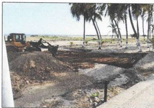
Rellenos en zona 1
