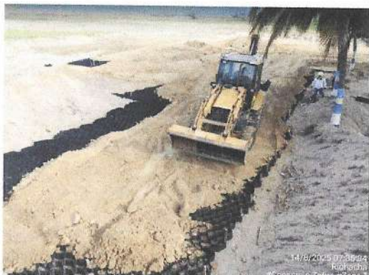
Compactación de geocelda 356-150.
