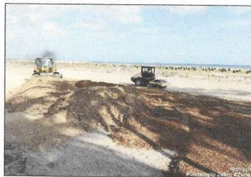
Relleno y compactación en zona 1
