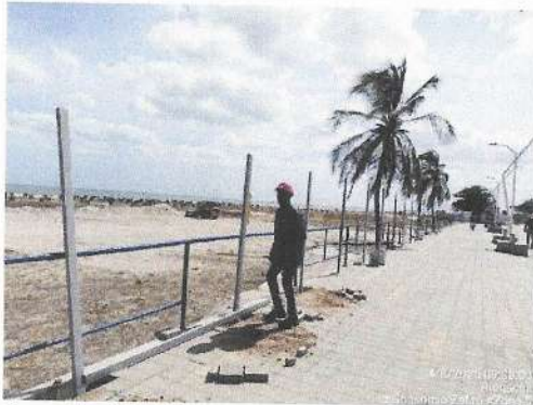
Instalación de cerramiento provisional.
