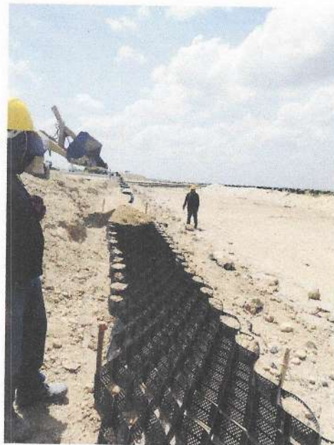
Fotografía 11. Geocelda de 20 cm para muro.
