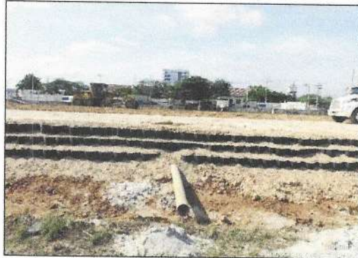
Instalación de Geocelda
