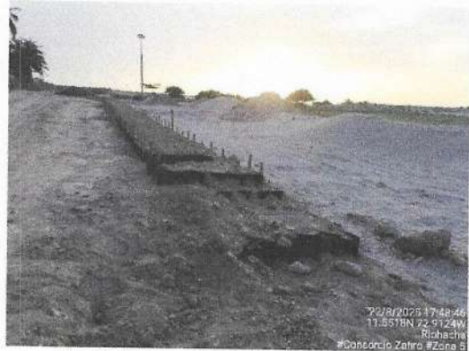
Instalacion de geocela 356-200
