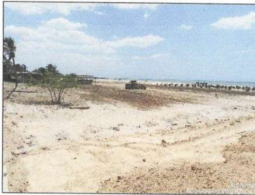
Relleno y compactación zona 5
