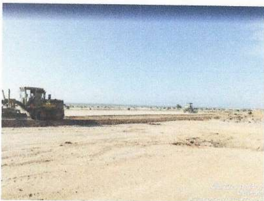
Relleno en recebo común para nivelación.
