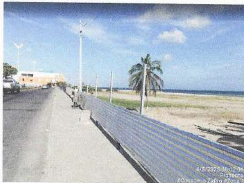
Instalación de cerramiento provisional.
