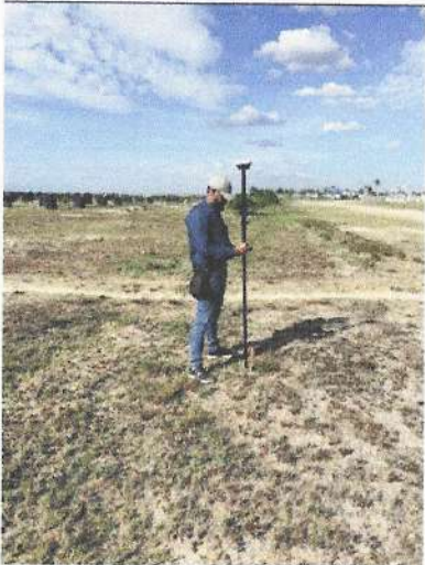
Marcación de los puntos de cerramiento.
