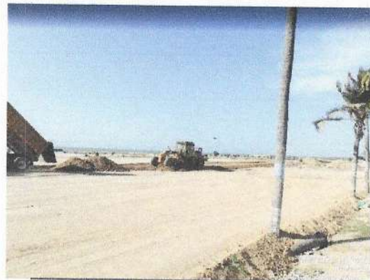
Relleno en recebo común para nivelación.
