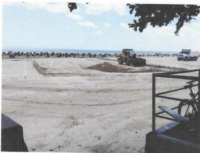
Fotografía 5. Relleno con recebo.
