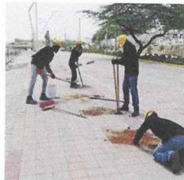
Instalación de cerramiento provisional.
