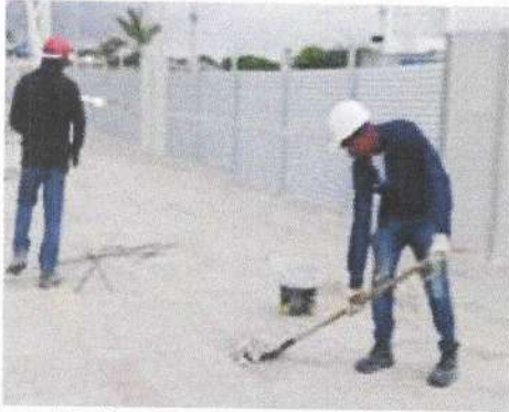
Instalación de cerramiento provisional.
