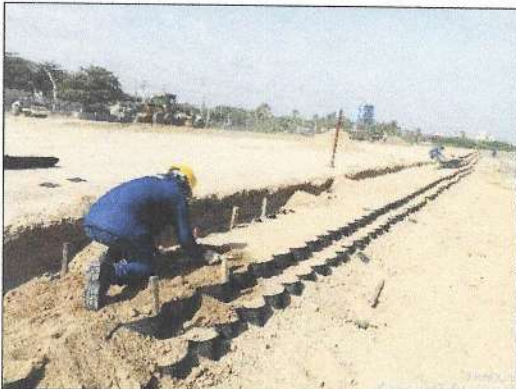
Instalación de Geocelda
