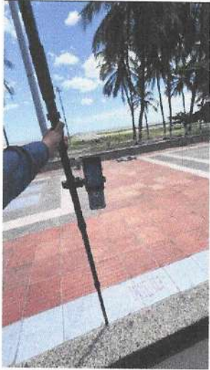
Marcación de los puntos de cerramiento.
