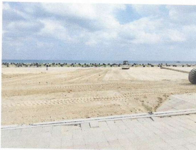
Fotografía 7. Relleno con recebo.
