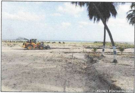
Actividades de rellenos en zona 1
