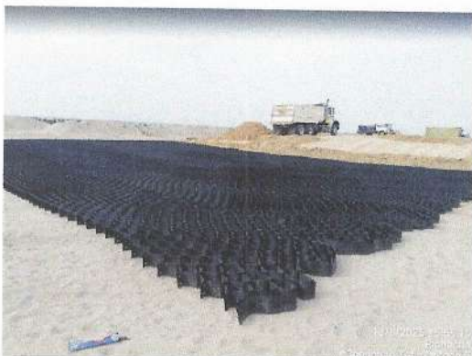
Instalación de geocelda 356-150.
