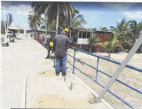
Instalación de cerramiento provisional.
