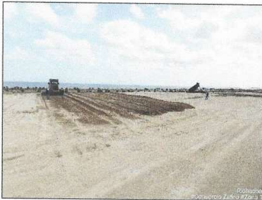
Relleno y compactación zona 5
