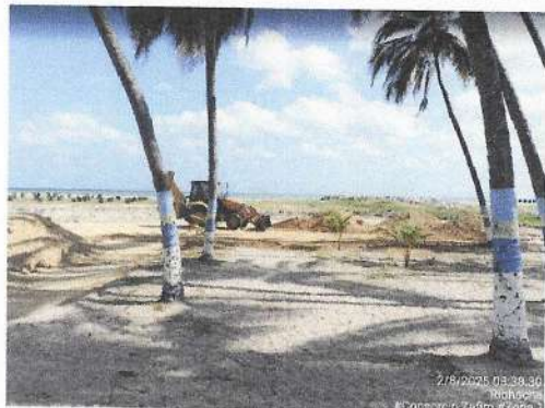
Relleno en recebo común para nivelación de terreno
