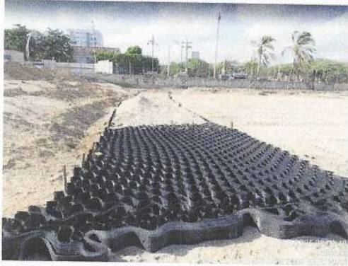
Instalación de geocelda 356-150.
