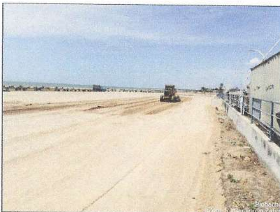
Actividades de rellenos en zona 5
