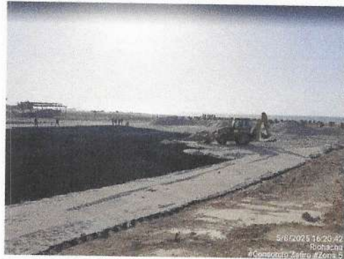
Instalación de geocelda 356-150.
