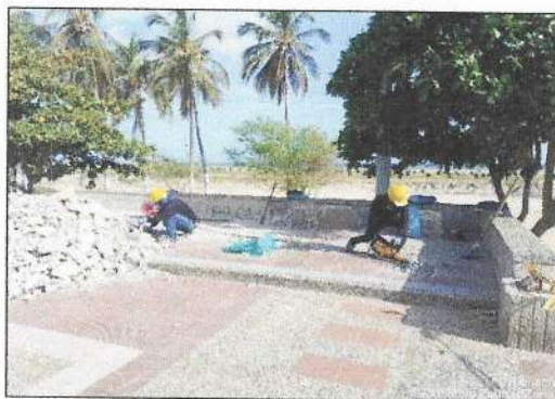
Actividades de demolición de andenes.
