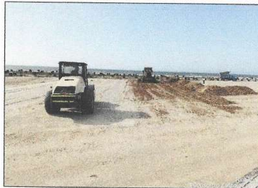
Actividades de relleno y compactación
