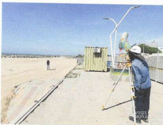
Fotografía 13. Localización, trazado y replanteo
