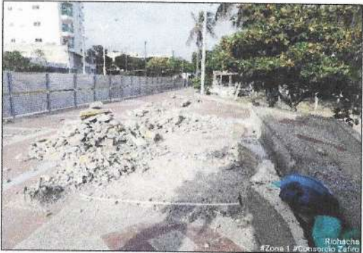
Demolición de andenes en zona 1
