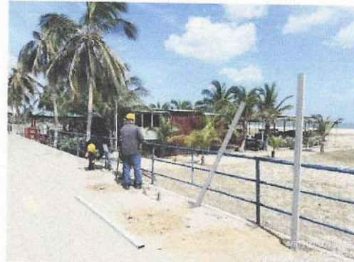
Instalación de cerramiento provisional.
