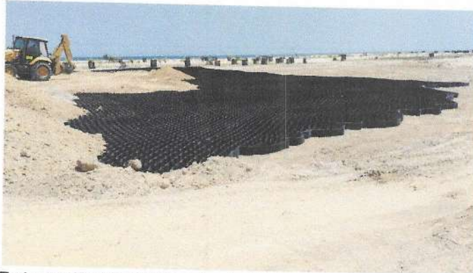
Fotografía 12. Geocelda de 15 cm a 2 capas.
