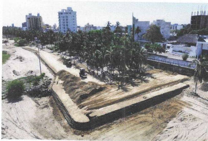
Fotografía. 2. Compactación de terreno en recebo.
