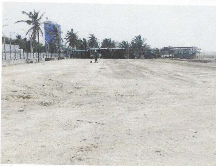
Fotografía 4. Descapote y limpieza.
