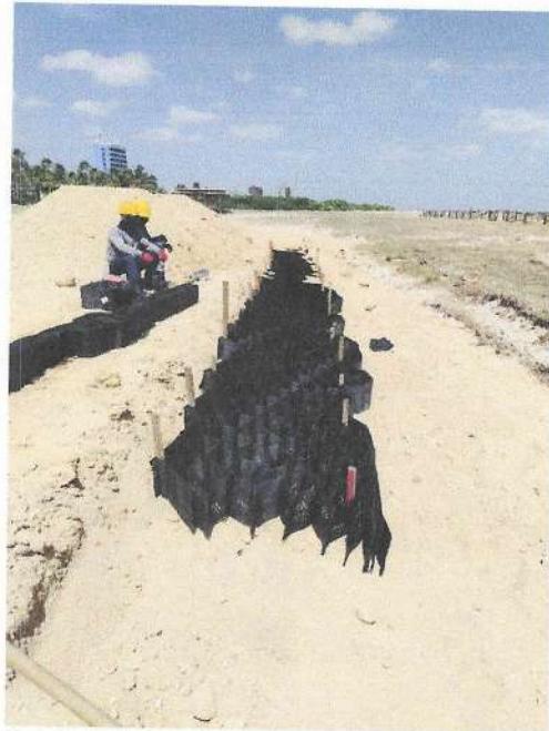
Fotografía 9. Geocelda de 20 cm para muro.
