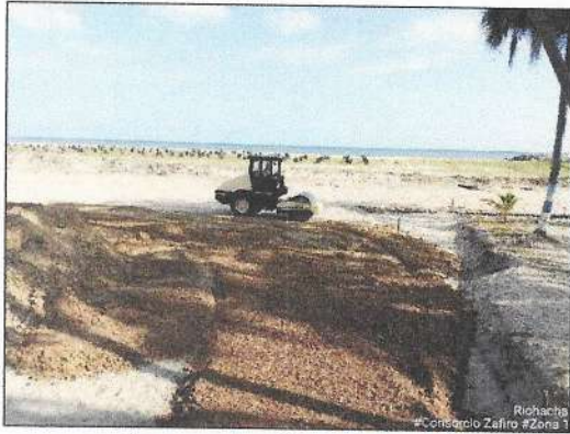
Compactación en zona 1
