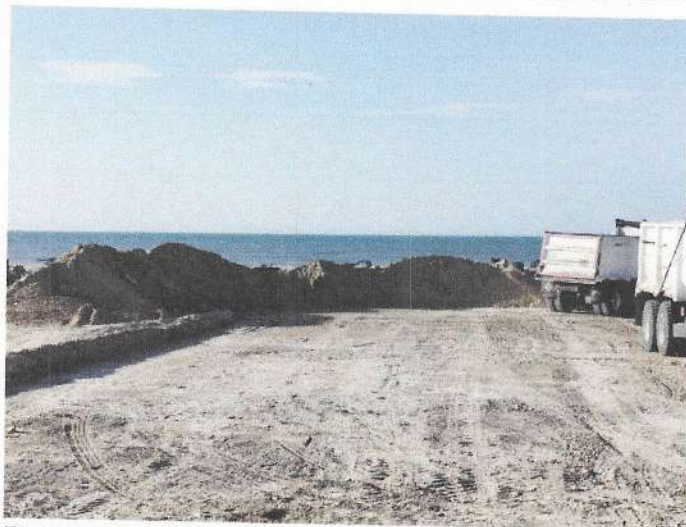
Fotografía 6. Relleno con recebo.
