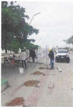
Instalación de cerramiento provisional.
