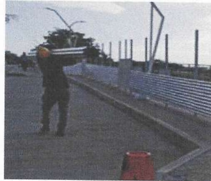
Instalación de cerramiento provisional.
