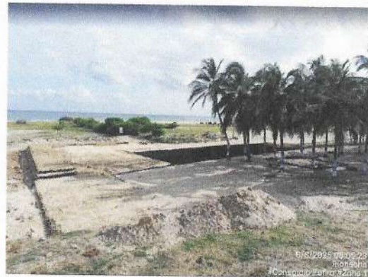
Instalación de geocelda 356-150.
