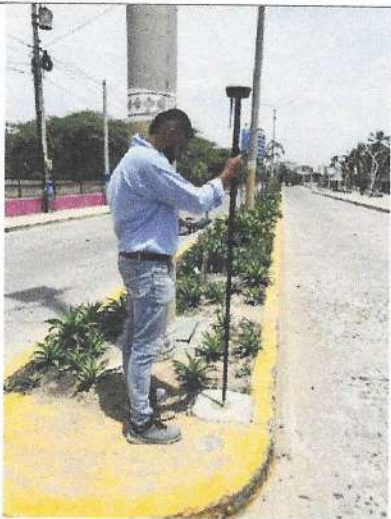
Excavación para la materialización de los puntos GPS1 y GPS2.
