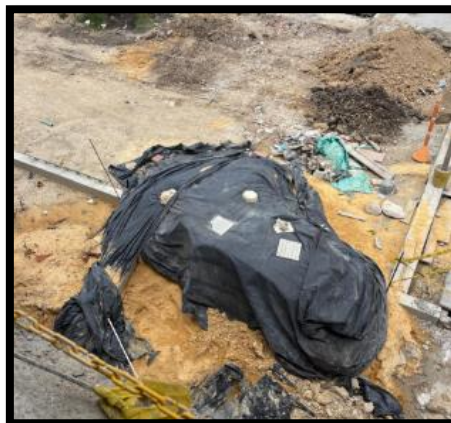
Cubrimiento de material granular. Fecha: 08 -2025
