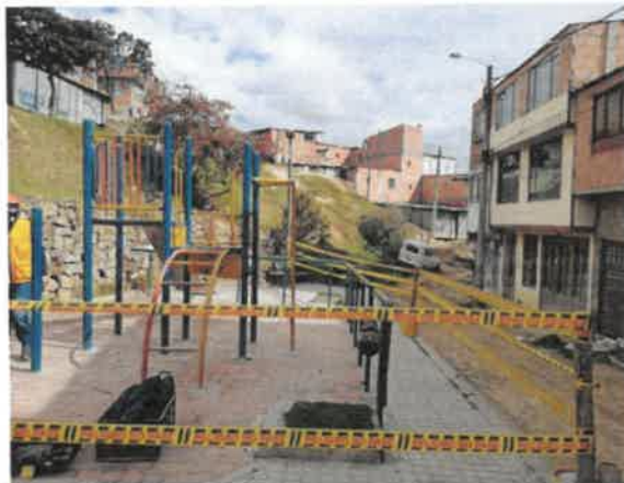
FOTO No 7: La interventoría ARQUITECTURA URBANA LTDA revisa y verifica que el contratista CONSORCIO OPORTO realice la instalación del cerramiento (Cinta de peligro), parque HUERTAS (19-287).
