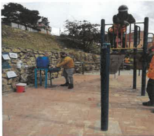
FOTO No 5: La interventoría ARQUITECTURA URBANA LTDA revisa y verifica que el contratista CONSORCIO OPORTO realice la instalación del punto de disposición de residuos (Ordinarios), parque DESARROLLO HUERTAS 19-287.
