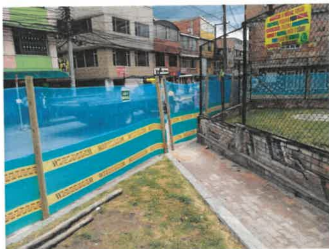
FOTO No 9: La interventoría ARQUITECTURA URBANA LTDA revisa y verifica que el contratista CONSORCIO OPORTO realice la actividad de cerramiento perimetral al PARQUE 19-039 PARQUE DE BOLSILLO URBANIZACIÓN LA ESTANCIA
