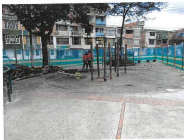
FOTO No 16: La interventoría ARQUITECTURA URBANA LTDA revisa y verifica que el contratista CONSORCIO OPORTO realice la actividad de cerramiento perimetral al PARQUE 19-150 PARQUE VECINAL URBANIZACIÓN LA ESTANCIA
