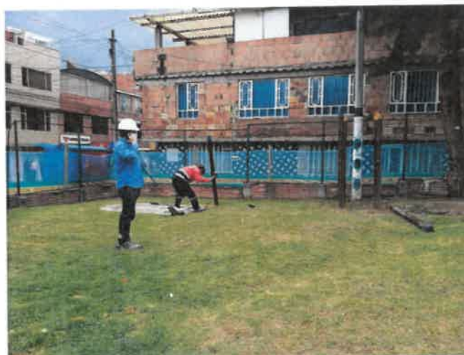
FOTO No 10: La interventoría ARQUITECTURA URBANA LTDA revisa y verifica que el contratista CONSORCIO OPORTO realice la actividad de desmonte de juego en madera en mal estado en el PARQUE 19-039 PARQUE DE BOLSILLO URBANIZACIÓN LA ESTANCIA
