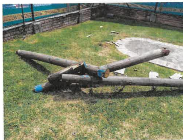
FOTO No 12: La interventoría ARQUITECTURA URBANA LTDA revisa y verifica que el contratista CONSORCIO OPORTO realice la actividad de desmonte de juego en madera en mal estado en el PARQUE 19-039 PARQUE DE BOLSILLO URBANIZACIÓN LA ESTANCIA
