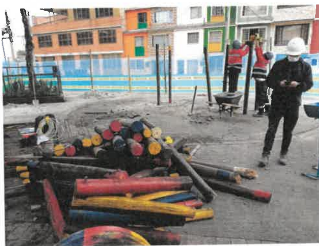
FOTO No 15: La interventoría ARQUITECTURA URBANA LTDA revisa y verifica que el contratista CONSORCIO OPORTO realice la actividad de desmonte de juego en madera en mal estado en el PARQUE 19-150 PARQUE VECINAL URBANIZACIÓN LA ESTANCIA
