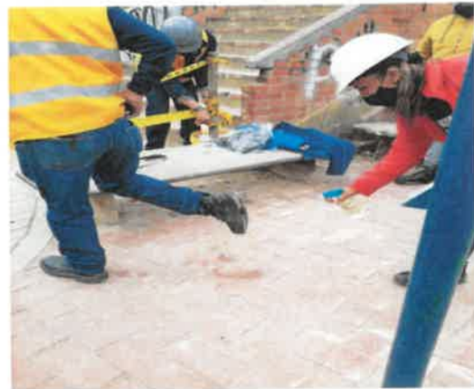
FOTO No 8: La interventoría ARQUITECTURA URBANA LTDA revisa y verifica que el contratista CONSORCIO OPORTO realice la implementación de protocolo de ingreso, parque HUERTAS (19-287).
