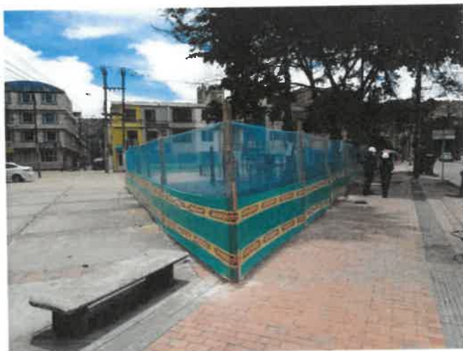
FOTO No 13: La interventoría ARQUITECTURA URBANA LTDA revisa y verifica que el contratista CONSORCIO OPORTO realice la actividad de cerramiento perimetral al PARQUE 19-150 PARQUE VECINAL URBANIZACIÓN LA ESTANCIA
