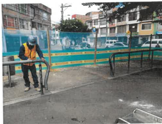
FOTO No 14: La interventoría ARQUITECTURA URBANA LTDA revisa y verifica que el contratista CONSORCIO OPORTO realice la actividad de desmonte de juego en madera en mal estado en el PARQUE 19-150 PARQUE VECINAL URBANIZACIÓN LA ESTANCIA
