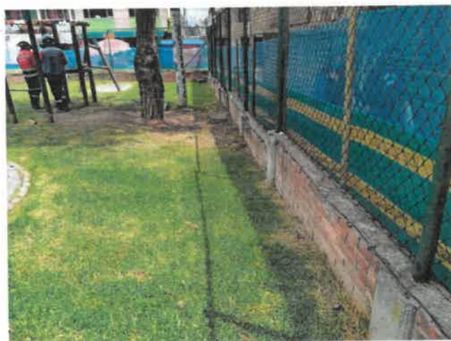
FOTO No 11: La interventoría ARQUITECTURA URBANA LTDA revisa y verifica que el contratista CONSORCIO OPORTO realice la actividad de cerramiento perimetral al PARQUE 19-039 PARQUE DE BOLSILLO URBANIZACIÓN LA ESTANCIA
