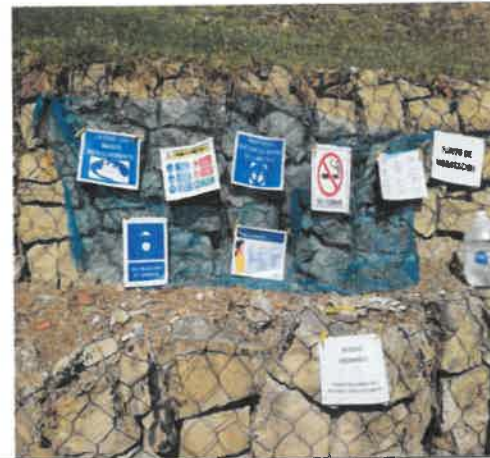
FOTO No 6: La interventoría ARQUITECTURA URBANA LTDA revisa y verifica que el contratista CONSORCIO OPORTO realice la instalación de señalización de punto de segregación de residuos (Ordinarios), parque DESARROLLO HUERTAS 19-287.
