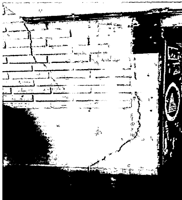
Fotografía 3. Grietas pronunciadas en los muros del pasillo del segundo piso, indicativas de posibles fallas estructurales.
