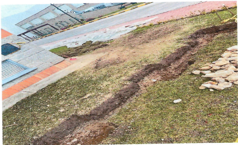
Foto No.4 excavación para muro
