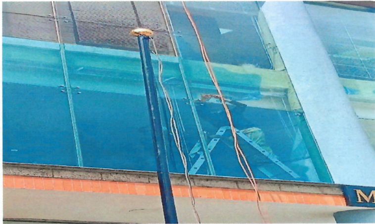
Foto No.6 Desmonte de película de polarizado existente
