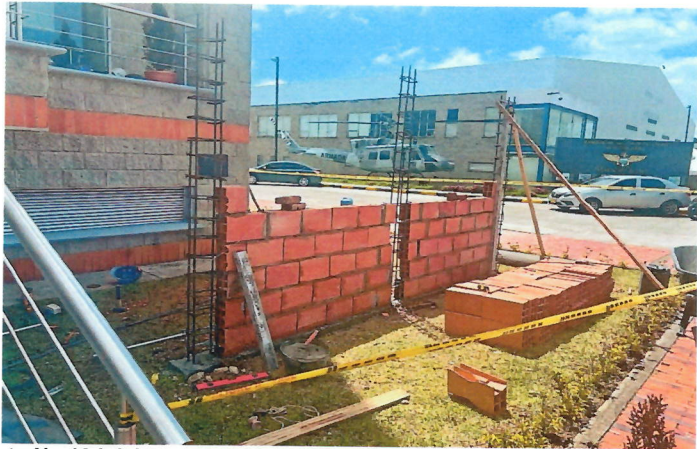
Foto No.10 Inicio construcción muro.
