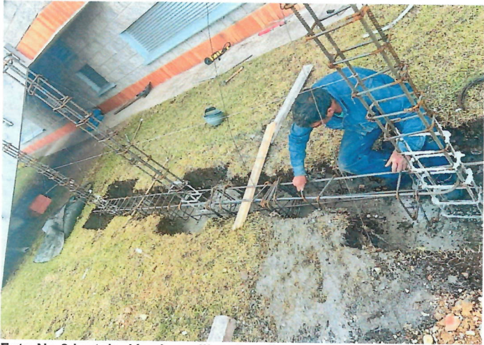
Foto No.9 Instalación de varillas de refuerzo en zapata corrida.
