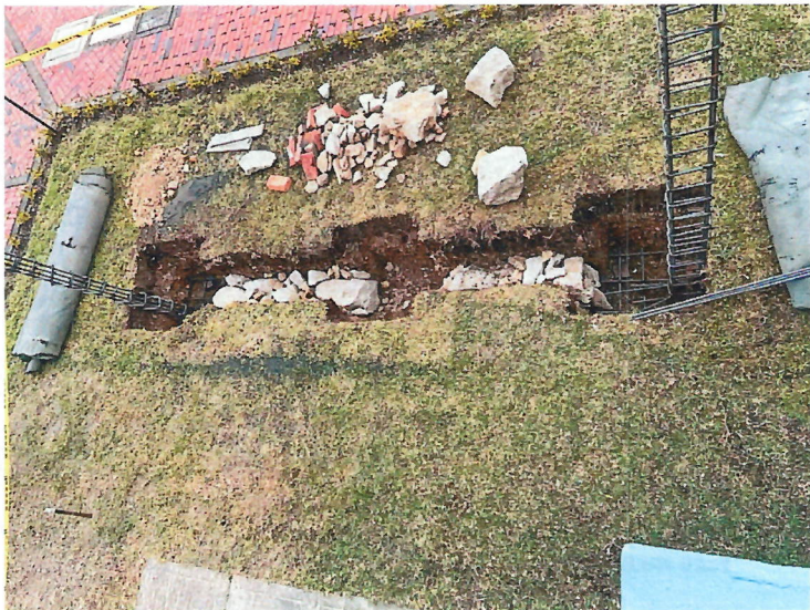
Foto No.8 Excavación y preparación del terreno para cimentación
