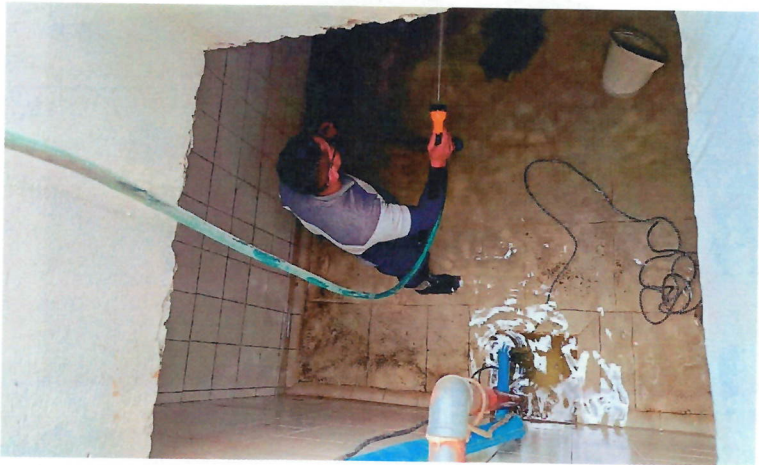
Foto No.1 Lavado de tanque con hipoclorito
