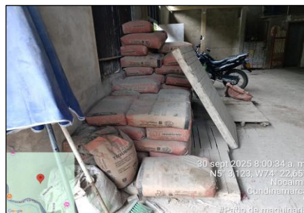
Imagen No. 2: Verificación de la disponibilidad de insumos para la conformación de la base estabilizada
