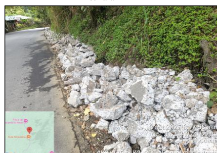
Imagen No. 6: Labores de demolición de cuenta entre el Km 2+070 al Km 2+210 costado derecho de la vía
