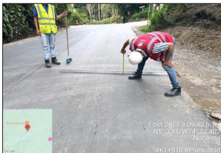
Imagen No. 3: Verificación y control de la planicidad sobre la capa de rodadura entre el Km 1+530 a Km 2+150
