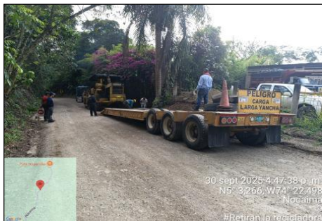
Imagen No. 1: Retiro de la recicladora de la zona de obra por parte del contratista de obra
