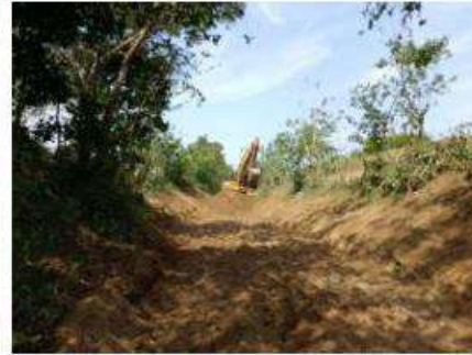
Limpieza para recuperación ambiental con retroexcavadora CAT 320 GX hasta abscisa k0+500.
