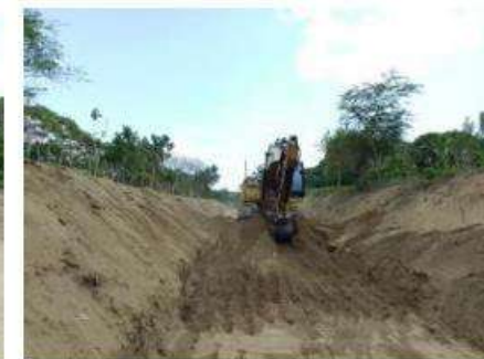
Limpieza para recuperación ambiental con retroexcavadora CAT 320 GX hasta abscisa k0+800.
