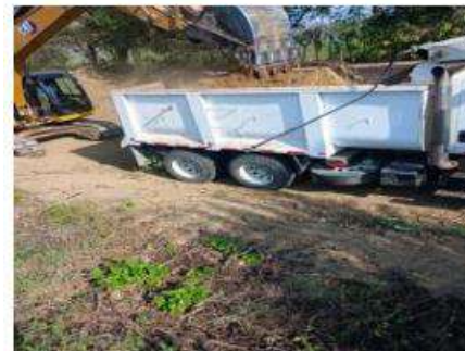
Limpieza para recuperación ambiental con retroexcavadora CAT 320 GX hasta abscisa k0+300
