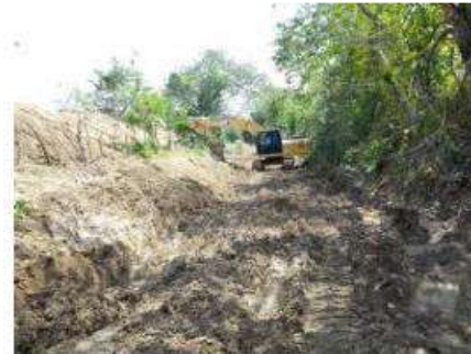
Limpieza para recuperación ambiental con retroexcavadora CAT 320 GX hasta abscisa k0+500.
