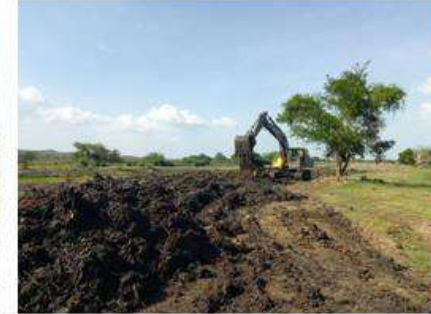
Limpieza para recuperación ambiental con retroexcavadora Volvo 240, Repaleo de material
