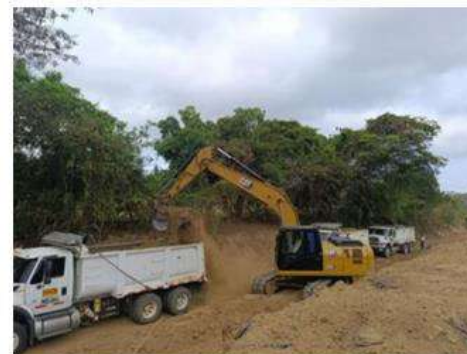
Limpieza para recuperación ambiental con retroexcavadora CAT 320 GX, Abscisas k0+140 a k0+000
