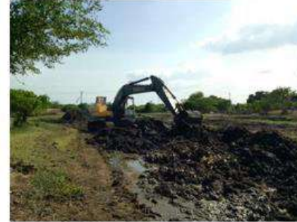
Limpieza para recuperación ambiental con retroexcavadora Volvo 240, Repaleo de material
