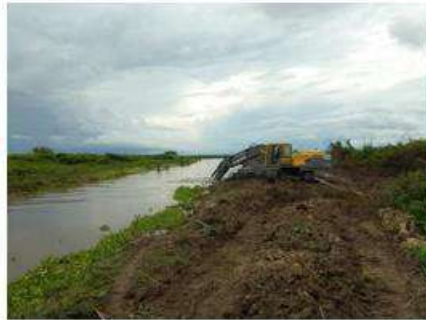
Limpieza para recuperación ambiental con retroexcavadora Volvo 240, Abscisas k1+130 a k1+340
