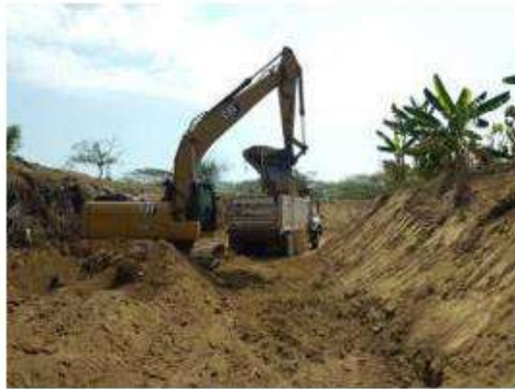
Limpieza para recuperación ambiental con retroexcavadora CAT 320 GX hasta abscisa k0+140
