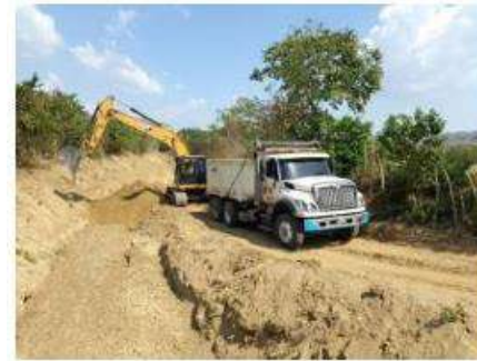
Limpieza para recuperación ambiental con retroexcavadora CAT 320 GX hasta abscisa k0+720, sector puente arroyo Negro, Luruaco, Atlántico.
