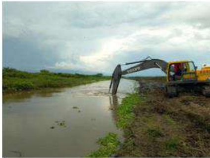
Limpieza para recuperación ambiental con retroexcavadora Volvo 240, Abscisas k1+130 a k1+340
