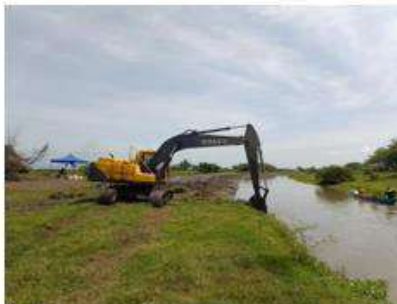
Limpieza para recuperación ambiental con retroexcavadora Volvo 210, Abscisas k2+200 a k1+740
