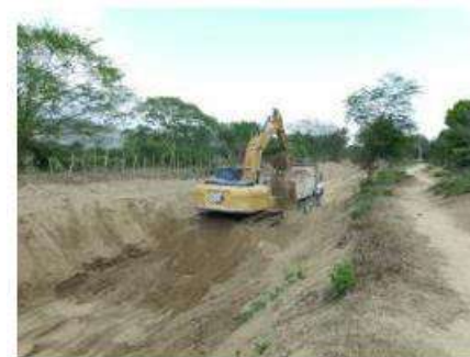
Limpieza para recuperación ambiental con retroexcavadora CAT 320 GX hasta abscisa k0+800.
