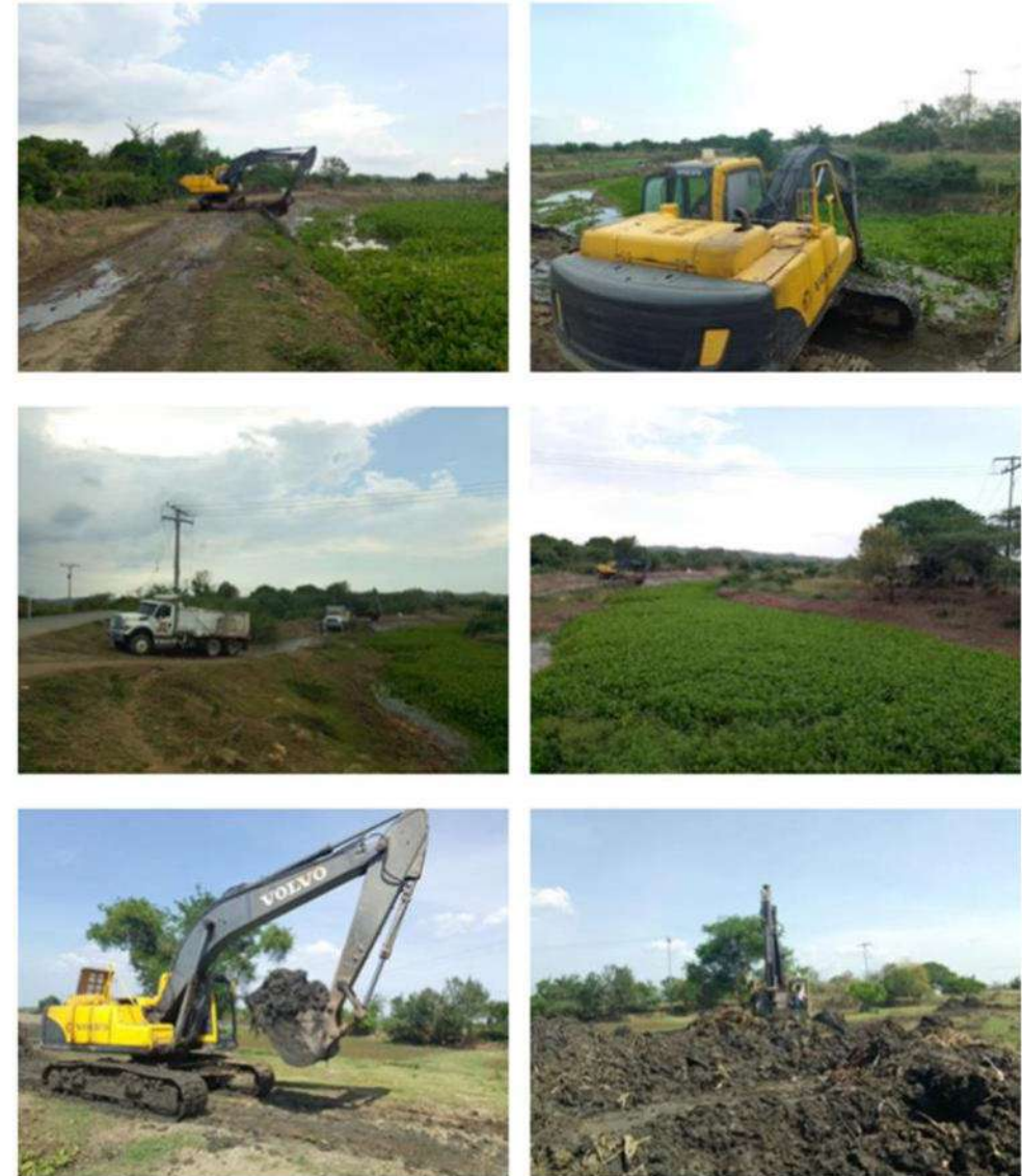
Limpieza para recuperación ambiental con retroexcavadora Volvo 240, Abscisas k0+000 a k0+140
