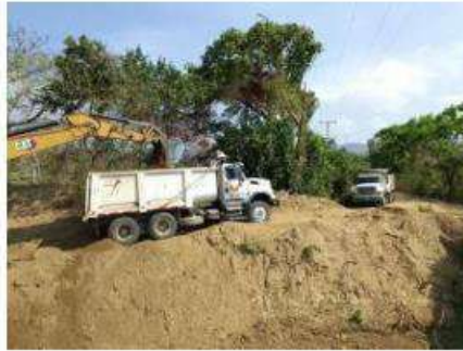
Limpieza para recuperación ambiental con retroexcavadora CAT 320 GX hasta abscisa k0+720.
