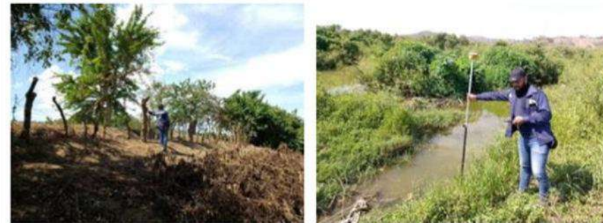
Localización, trazado y replanteo inicial con equipos topográficos.
