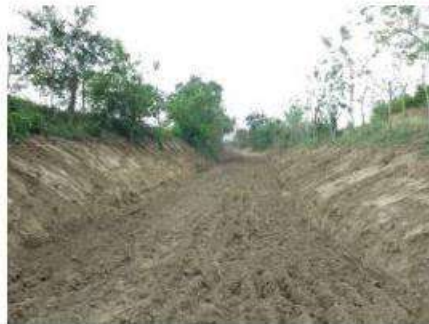
Limpieza para recuperación ambiental con retroexcavadora CAT 320 GX hasta abscisa k0+500.
