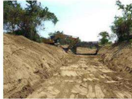
Limpieza para recuperación ambiental con retroexcavadora CAT 320 GX hasta abscisa k0+720.
