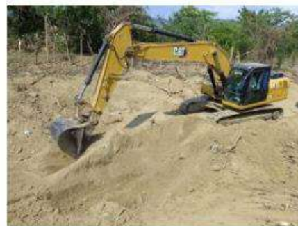
Limpieza para recuperación ambiental con retroexcavadora CAT 320 GX y repaleo de material hasta abscisa k0+980.
