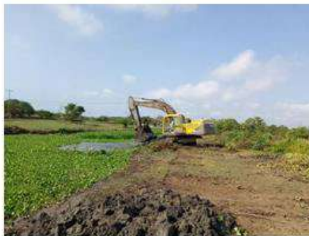
Limpieza para recuperación ambiental con retroexcavadora Volvo 240, Abscisas k0+140 a k0+320
