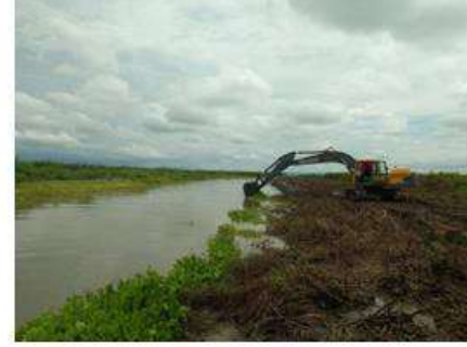
Limpieza para recuperación ambiental con retroexcavadora Volvo 240, Abscisas k1+130 a k1+340
