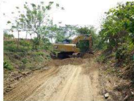
Limpieza para recuperación ambiental con retroexcavadora CAT 320 GX hasta abscisa k0+500.
