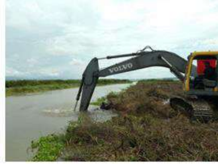
Limpieza para recuperación ambiental con retroexcavadora Volvo 240, Abscisas k1+130 a k1+340
