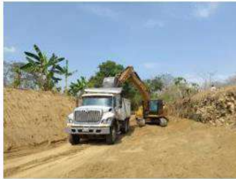
Limpieza para recuperación ambiental con retroexcavadora CAT 320 GX hasta abscisa k0+140
