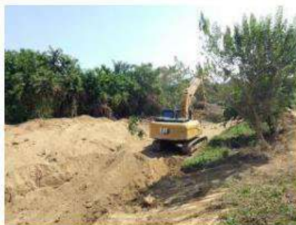
Limpieza para recuperación ambiental con retroexcavadora CAT 320 GX y repaleo de material hasta abscisa k0+980.
