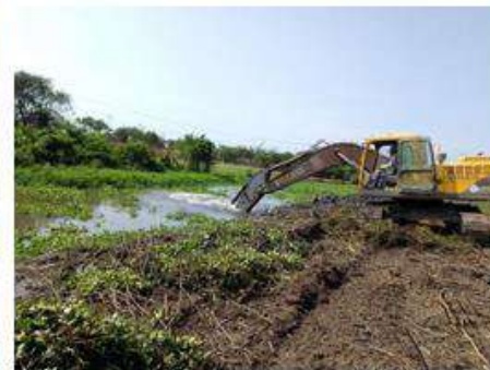
Limpieza para recuperación ambiental con retroexcavadora Volvo 240, Abscisas k0+140 a k0+320
