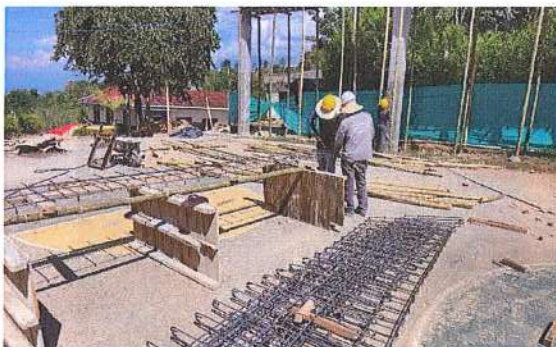
AMARRE DE ACERO PARA VIGA CANAL EJE 2
