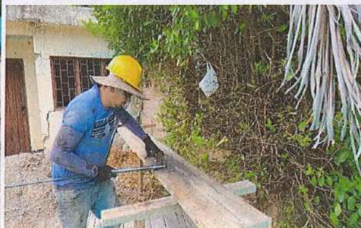
CORTE Y FIGURADO DE ACERO PARA VIGA CANAL.
