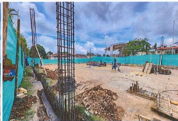
PANORÁMICA DE OBRA
