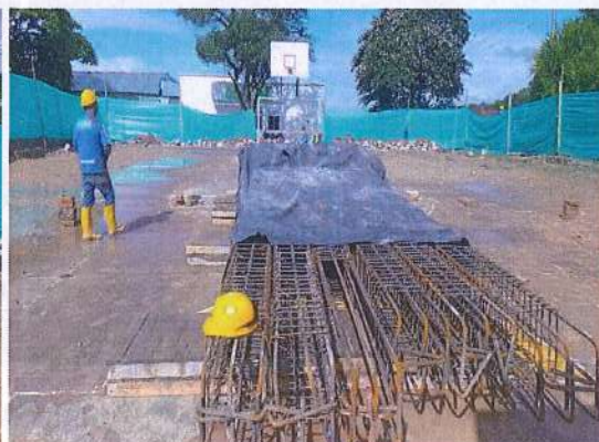
ACOPIO DE ACERO (CANASTAS) PARA VIGAS DE CIMENTACIÓN Y COLUMNAS
