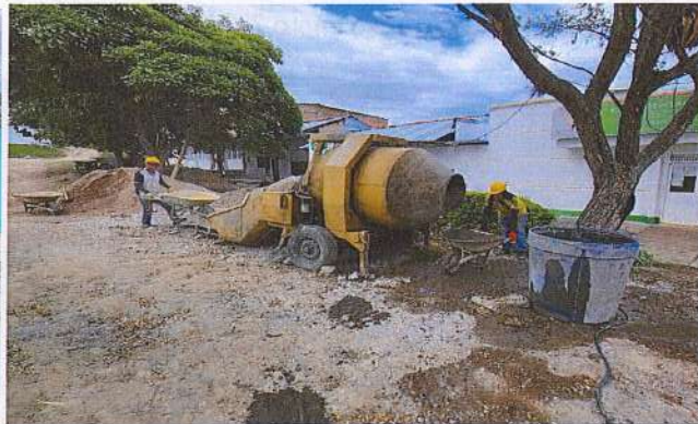
PROCESO DE MEZCLADO DE CONCRETO PARA ZAPATAS
