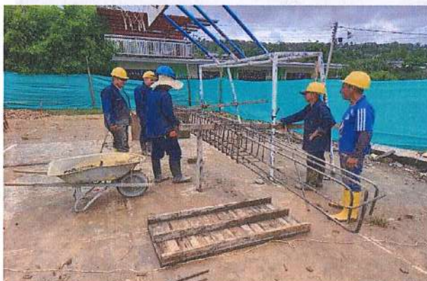
AMARRE DE ACERO PARA VIGAS DE CEMENTACIÓN
