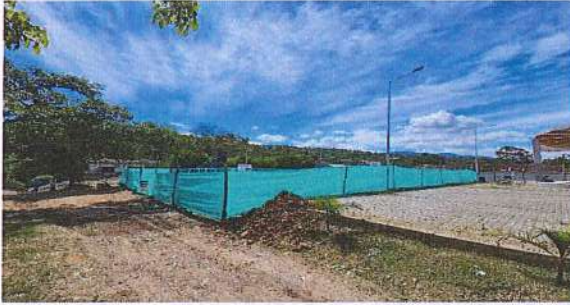
INSTALACION DE CERRAMIENTO LONA VERDE
