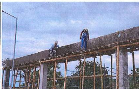
PAÑETE SOBRE VIGA CANAL EJE 1, PARTE POSTERIOR
