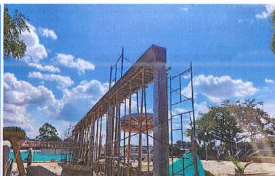
COLUMNAS Y VIGA CANAL EJE 1
