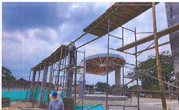
INSTALACIÓN DE ESTIBAS PARA SOPORTE EN CONSTRUCCIÓN DE VIGA CANAL.
