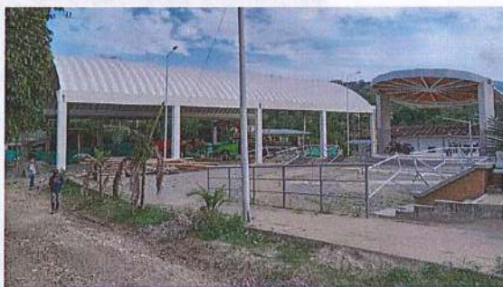
SUMINISTRO, FABRICACIÓN E INSTALACIÓN DE CUBIERTAS AUTO SOPORTANTE A BASE DE LÁMINA DE ACERO CAL. 22
