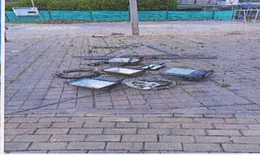
DESMONTE DE LUMINARIAS Y POSTES EN EXISTENTES
