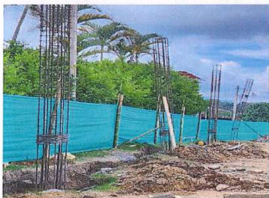
ACERO PARA COLUMNAS EJE 2
