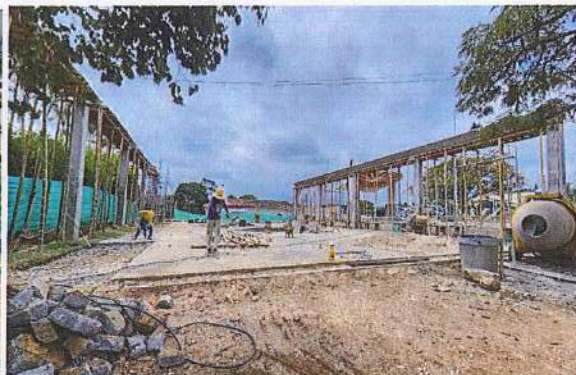
PANORAMICA DE OBRA
