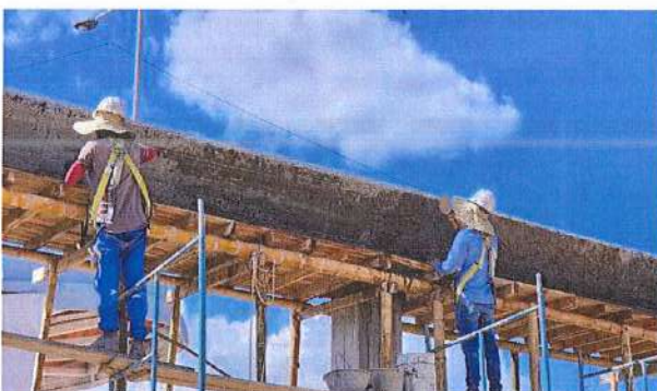
PAÑETE SOBRE VIGA CANAL EJE 1
