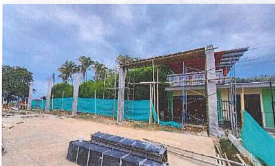
INSTALACIÓN DE CAMILLAS PARA VIGA CANAL EJE 2
