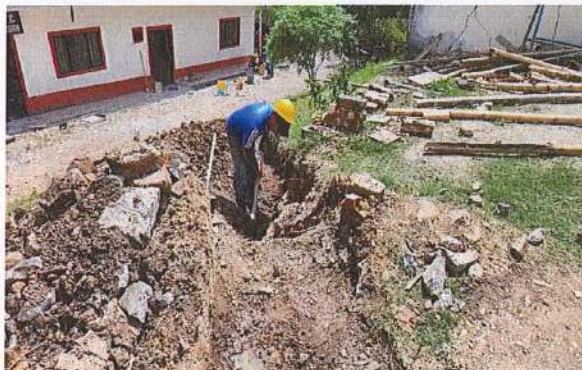
EXCAVACIÓN MANUAL PARA INSTALACION DE TUBERIA DE 10"
