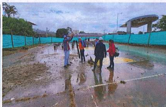
RECORRIDO DE OBRA, CONTRATISTA, INTERVENTORIA Y COMUNIDAD.
