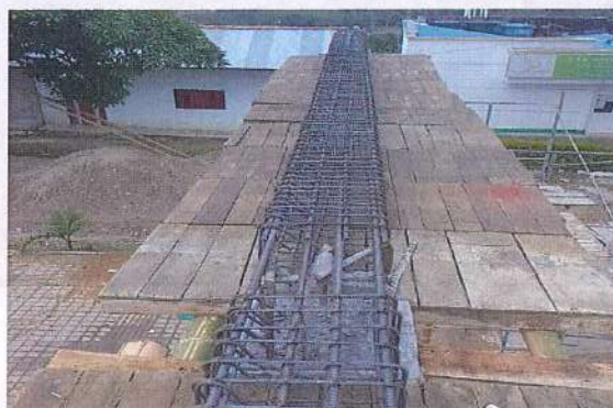
INSTALACIÓN DE ACERO DE REFUERZO PARA VIGA CANAL.
