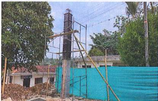
SEGUNDA SECCIÓN COLUMNAS EJE 2
