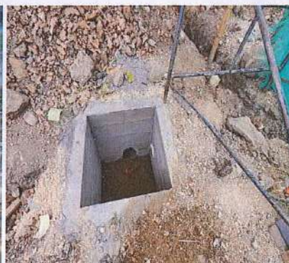
CAJAS DE INSPECCIÓN PARA RED DE INSTALACIONES HIDROSANITARIAS.
