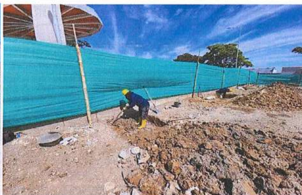
EXCAVACION MANUAL PARA ZAPATAS
