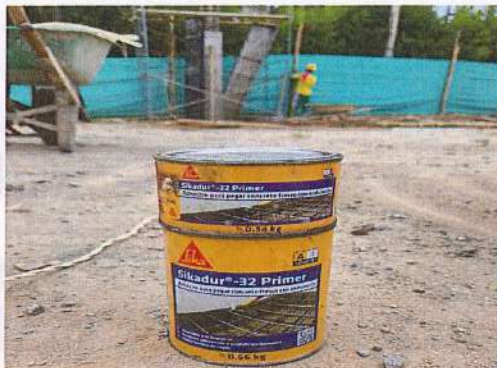
EPOXICO SIKADUR 32 UTILIZADO EN COLUMNAS PARA ADHERENCIA DE CONCRETOS DE PRIMERA Y SEGUNDA SECCIÓN
