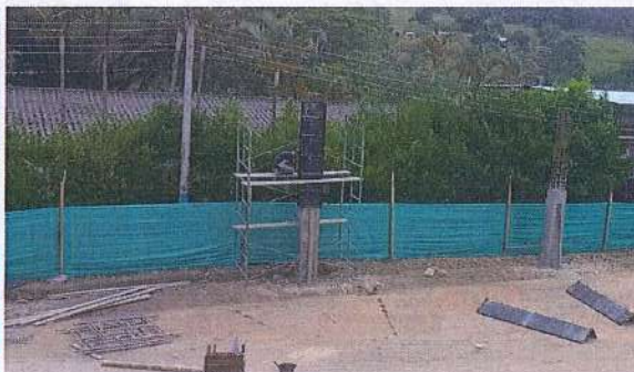
INSTALACIÓN DE ENCOFRADOS PARA COLUMNAS SEGUNDA SECCIÓN
