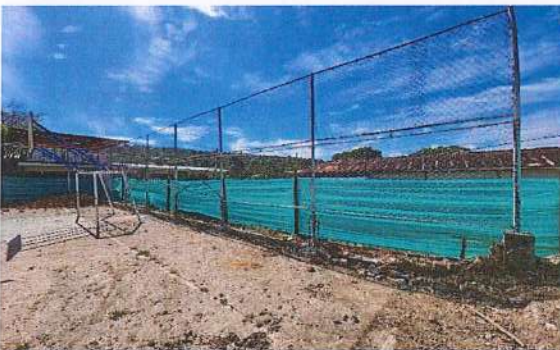
DEMOLICION DE CERRAMIENTO EXISTENTE
