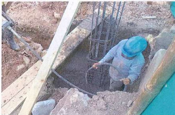
VACIADO Y VIBRADO DE CONCRETO PARA ZAPATAS
