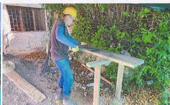
FIGURADO DE ACERO PARA VIGA CANAL EJE 2.
