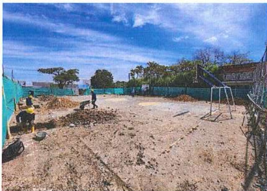
EXCAVACION MANUAL Y RETIRO DE MATERIAL
