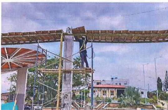
INSTALACIÓN DE ESTIBAS PARA SOPORTE EN CONSTRUCCIÓN DE VIGA CANAL.
