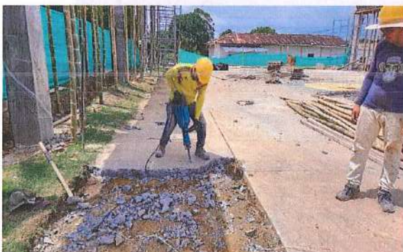
DEMOLICION DE 24 M2 DE PLACA EXISTENTE PARA SU RESTITUCIÓN
