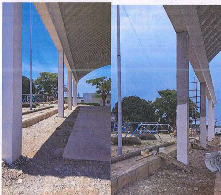
ESGRAFIADO DE GRANIPLAST PARA ESTRUCTURA EN CONCRETO
