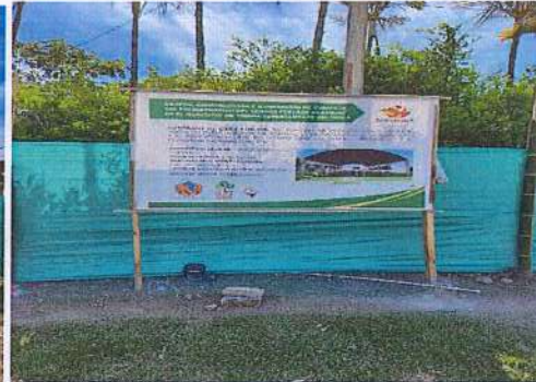
INSTALACION DE VALLA INFORMATIVA
