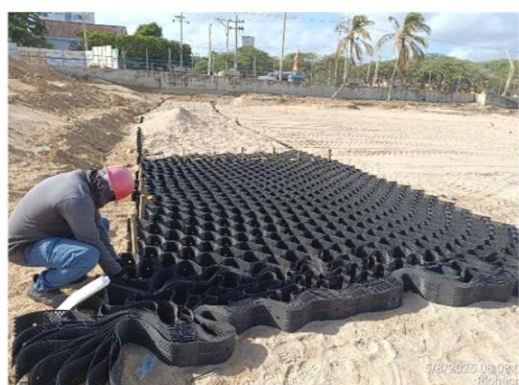
Suministro e instalación Geocelda 356-150
