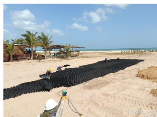
Suministro e instalación Geocelda 356-150
