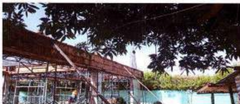
Foto 8: Instalación de formaleta para vigas aéreas
