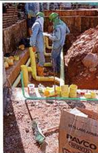
Foto 34: Instalación de tubería PVC sanitaria
