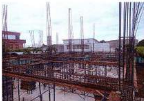
Foto 3: Instalación de acero de refuerzo para vigas aéreas
