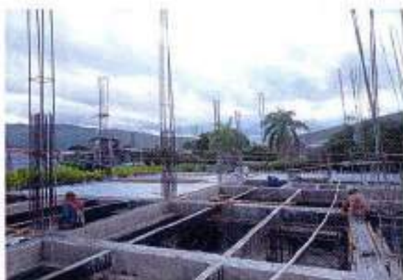
Foto No 5: Instalación de Metaldeck
