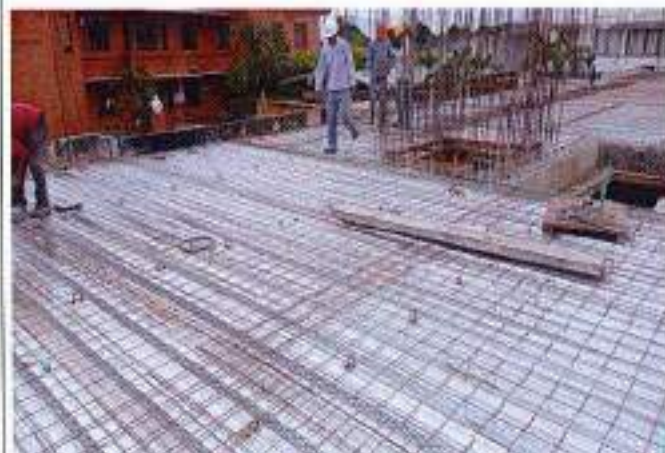
Foto 23: Instalación de malla electrosoldada
