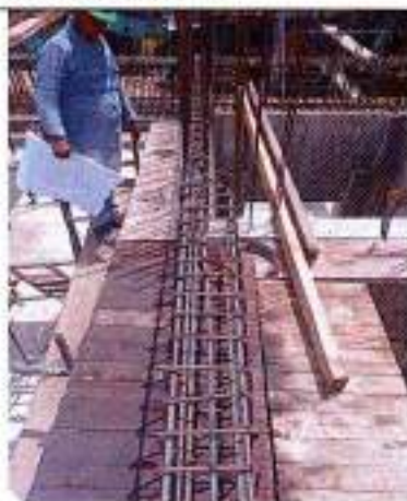
Foto 4: Instalación de acero de refuerzo para vigas aéreas
