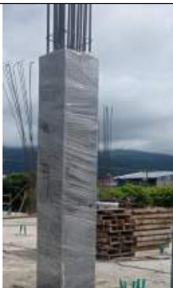
Foto No 7: Instalacion de papel viniepel para conservacion de humedad
