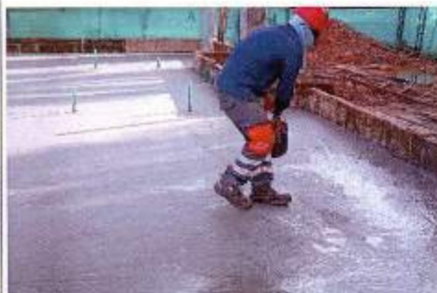
Foto 32: Hidratación placa de concreto de 3000 psi
