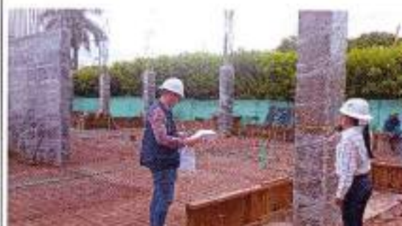
Foto 60: Visita de inspección ocular por parte de profesional de la Oficina Asesora de Planeación del municipio de Aguazul.
