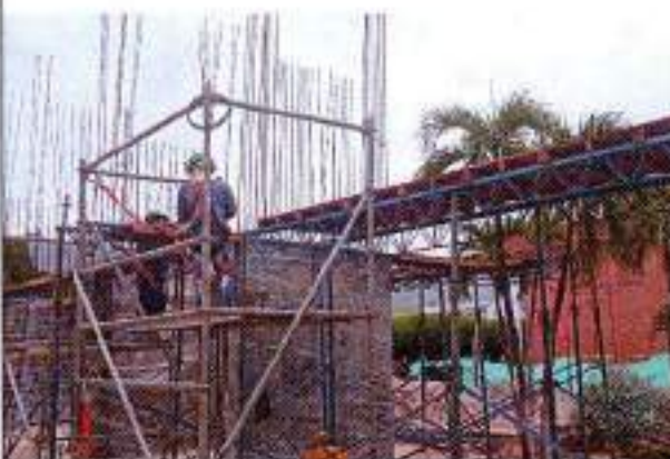
Foto 4: Instalación de camillas para encofrado de vigas aéreas
