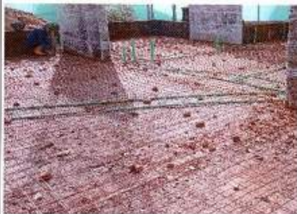
Foto 45: Instalación de tubería eléctrica
