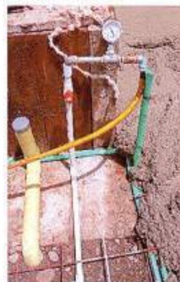
Foto 40: Prueba de presión Hidráulica
