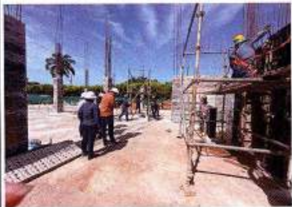
Foto 3: Recorrido de inspección y verificación de las obras por parte de la Supervisión del Ministerio del Interior, Personal de Obra y Personal de Interventoría.
