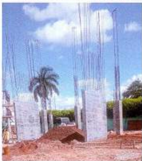
Foto 23: Concreto de 3500 psi para columnas y muros
