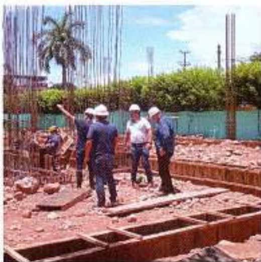
Foto 51: Recorrido de inspección ocular y verificación a la ejecución de las obras por parte de supervisión, interventoría y el señor alcalde.
