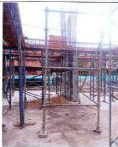
Foto 5: armazón de acero de refuerzo para vigas aéreas.
