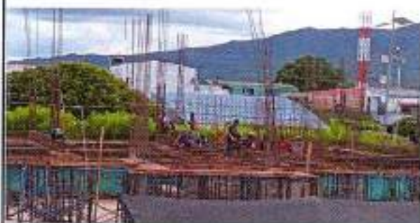
Foto 1: asero de refuerzo para vigas aéreas
