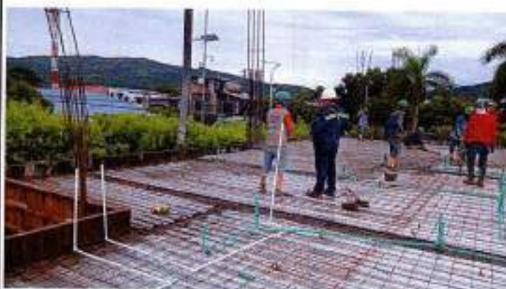
Foto No 6: Vaciado de concreto para losa maciza elevada en concreto de 3000 psi, e=0,10 m tipo metaldeck -
