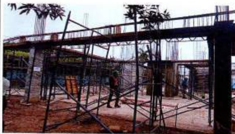
Foto 6: armazón de acero de refuerzo para vigas aéreas.
