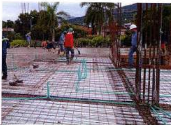
Foto No 8: Vaciado de concreto para losa maciza elevada en concreto de 3000 psi, e=0,10 m tipo metaldeck -
