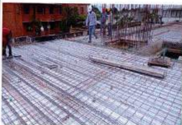
Foto No 5: Instalación de malla electrocable
