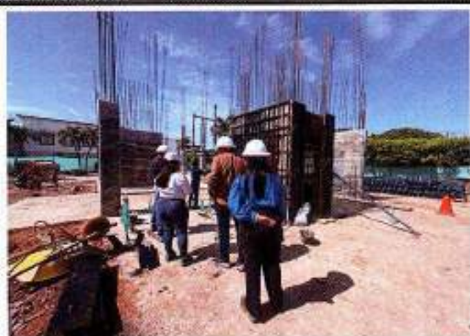
Foto 2: Recorrido de inspección y verificación de las obras por parte de la Supervisión del Ministerio del Interior, Personal de Obra y Personal de Interventoría.
