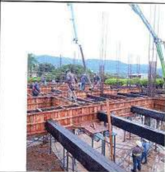
Foto No 3: Fundida de vigas aéreas
