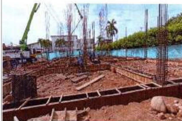
Foto 16: Concreto para vigas de cimentación de 3500 psi
