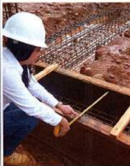
Foto 54: Verificación de medidas armado de formaleta para vigas de cimentación, para liberación y fundida
