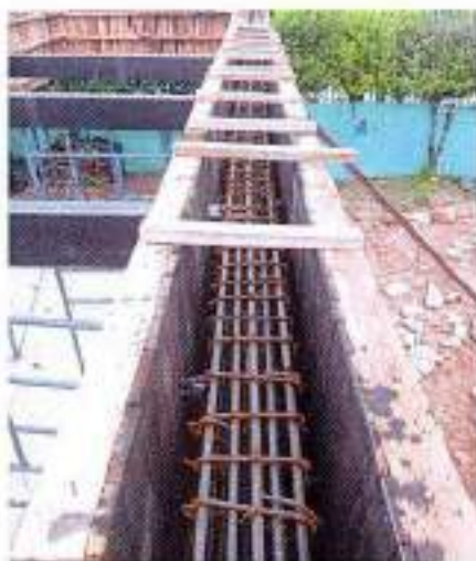
Foto 11: amarre de acero de refuerzo para vigas aéreas
