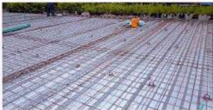
Foto No 8: Instalación de malla electrosoldada
