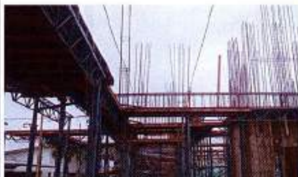
Foto 1: Instalación de acero de refuerzo para vigas aéreas
