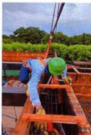
Foto 4: Instalación de estructura metálica ASTM 500
