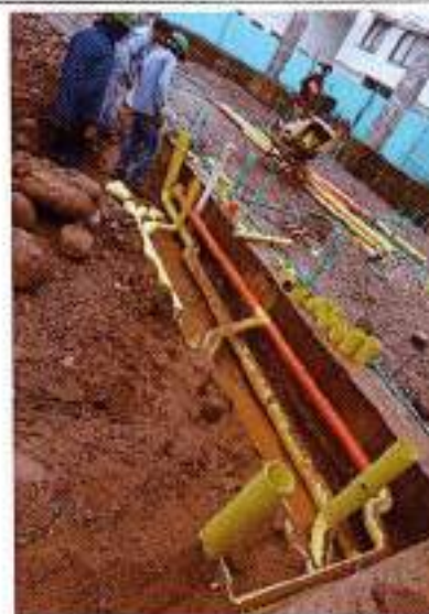
Foto 36: Instalación de tubería PVC sanitaria
