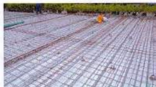
Foto 24: Instalación de malla electrosoldada
