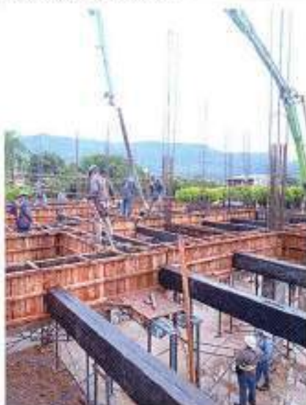
Foto 19: Fundida de vigas aéreas
