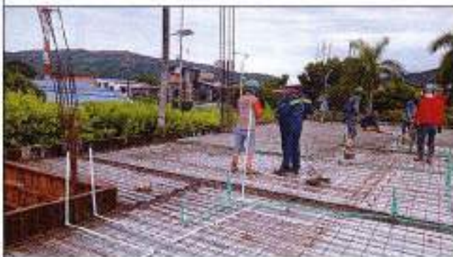
Foto 25: Vaciado de concreto para losa maciza elevada en concreto de 3000 psi, e = 0.10 m tipo metaldeck -
