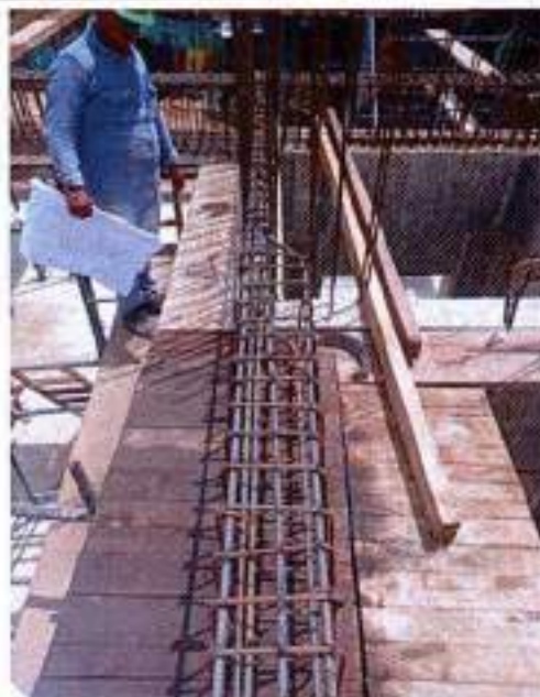
Foto 10: amarre de acero de refuerzo para vigas aéreas
