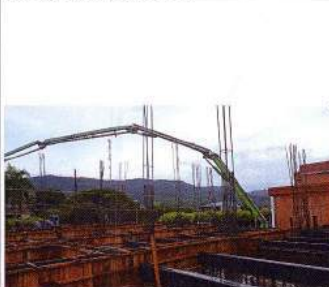
Foto 20: Fundida de vigas aéreas
