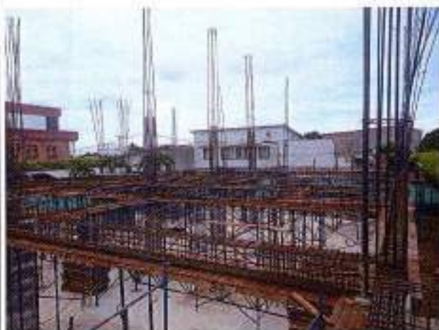
Foto 9: amarre de acero de refuerzo para vigas aéreas
