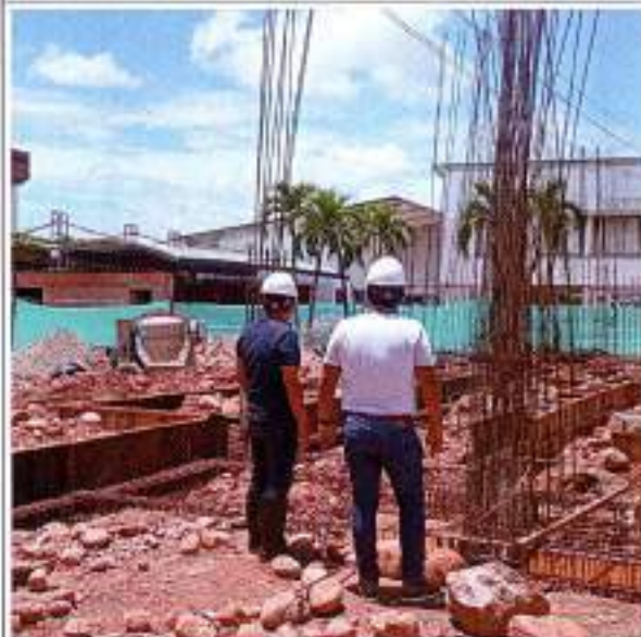
Foto 49: Recorrido de inspección ocular y verificación a la ejecución de las obras por parte de supervisión, interventoría y el señor alcalde.
