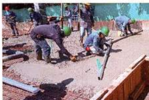
Foto 28: Vaciado de concreto de 3000 psi para placa base
