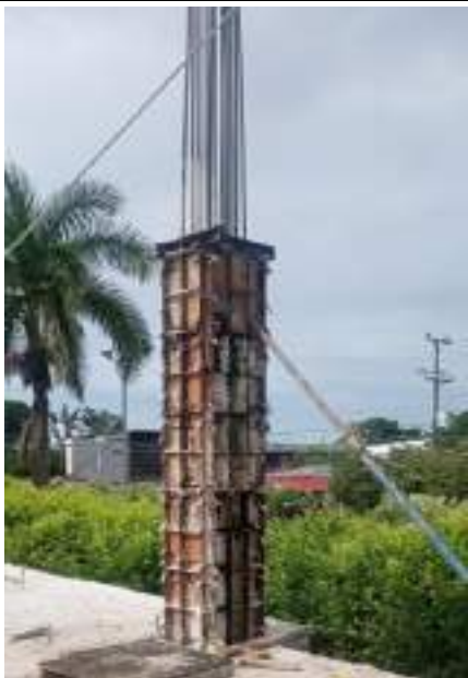
Foto No 5: Fundida de columnas
