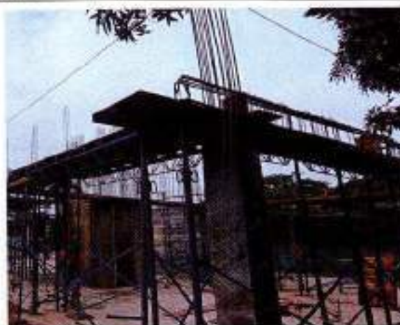
Foto 4: armaz de aço de refuerzo para vigas aéreas
