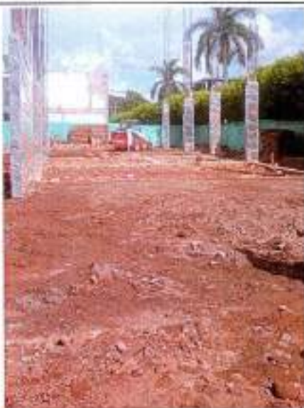
Foto 7: Compactación de sub base triturada
