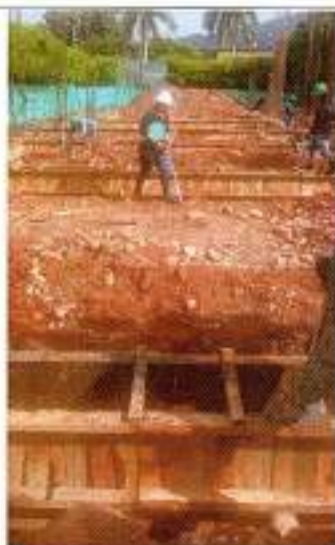
Foto 15: Concreto para vigas de cimentación de 3500 psi
