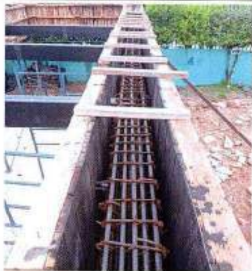
Foto 3: Instalación de estructura metálica ASTM 500
