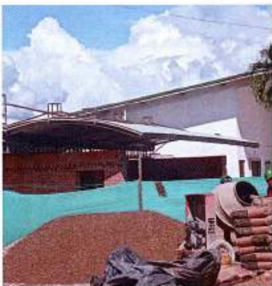
Foto 5: Relleno con material sub base triturada – tamaño máximo 2"
