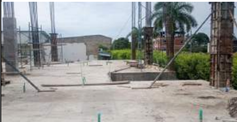
Foto No 6: Desencobrado de columnas
