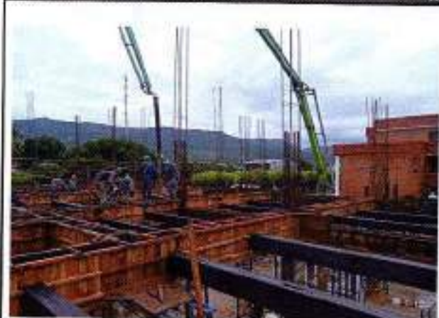
Foto No 1: Fundida de vigas aéreas
