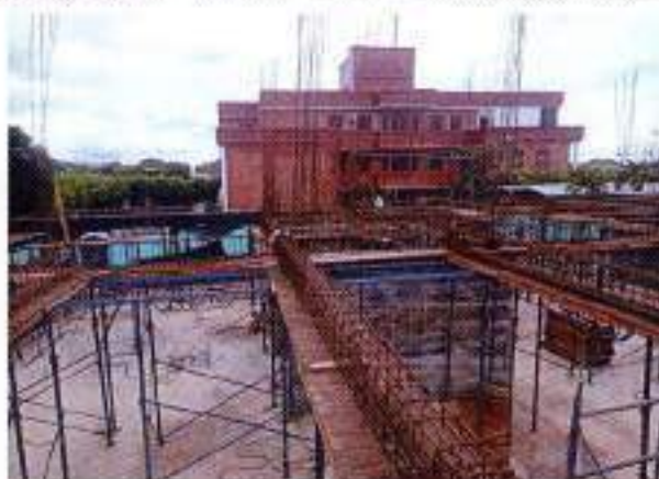
Foto 6: Instalación de acero de refuerzo para vigas aéreas
