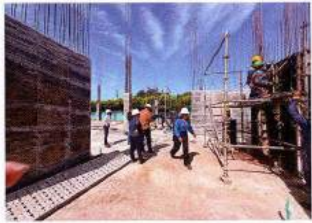
Foto 4: Recorrido de inspección y verificación de las obras por parte de la Supervisión del Ministerio del Interior, Personal de Obra y Personal de Interventoría.
