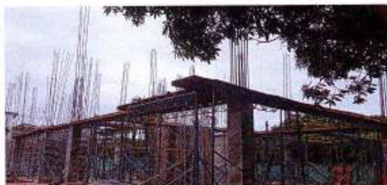
Foto 2 : Instalación de camillas para para vigas aéreas.
