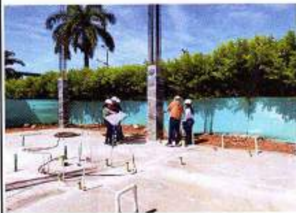
Foto 5: Recorrido de inspección y verificación de las obras por parte de la Supervisión del Ministerio del Interior, Personal de Obra y Personal de Interventoría.
