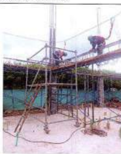
Foto 8: armazón de acero de refuerzo para vigas aéreas.
