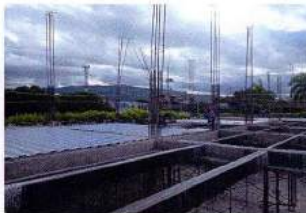
Foto No 6: Instalación de Metaldeck
