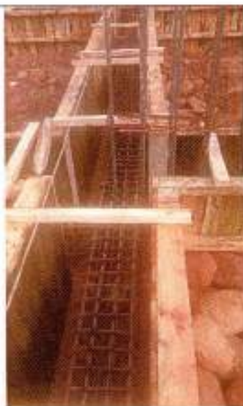
Foto 11: Instalación de formaleta para vigas de cimentación
