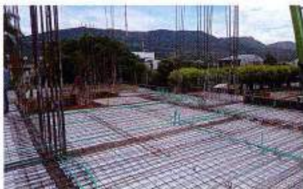
Foto No 7: Instalación de tubería eléctrica
