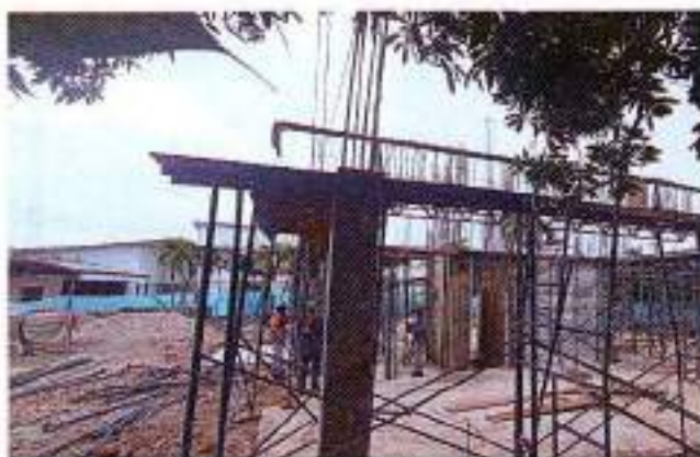
Foto 3: Instalación de camillas para encofrado de vigas aéreas
