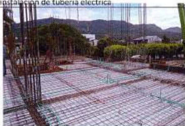
Foto 26: Vaciado de concreto para losa maciza elevada en concreto de 3000 psi, e = 0.10 m tipo metaldeck – e instalación de tubería eléctrica
