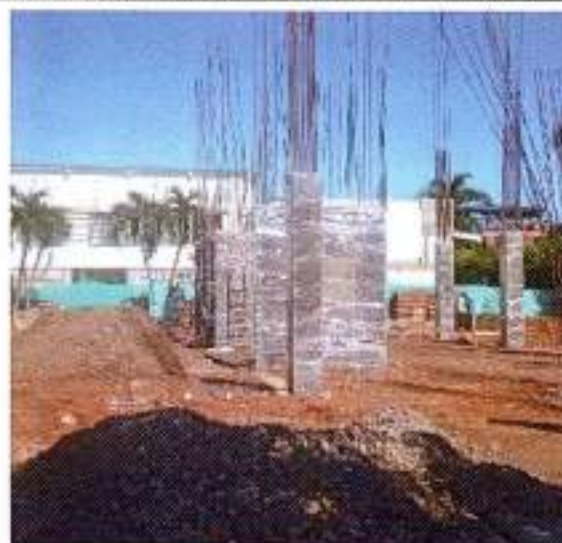
Foto 24: Concreto de 3500 psi para columnas y muros
