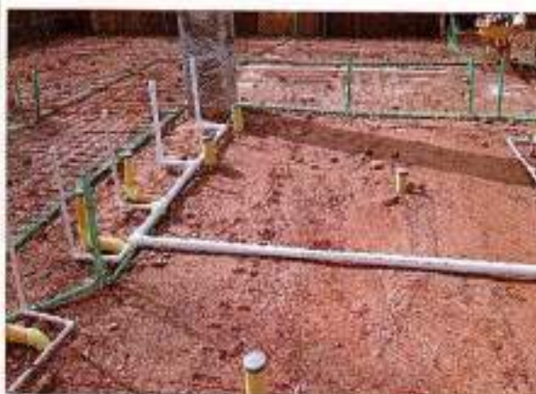
Foto 46: Instalación de tubería eléctrica
