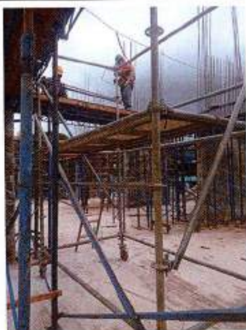
Foto 7: amarre de acero de refuerzo para vigas aéreas
