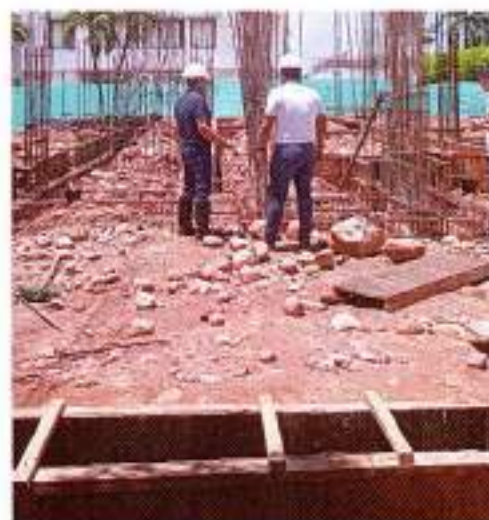
Foto 52: Recorrido de inspección ocular y verificación a la ejecución de las obras por parte de supervisión, interventoría y el señor alcalde.
