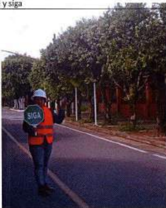
Foto 63: Control de Maniobras de Acceso y salida de equipo pesado
