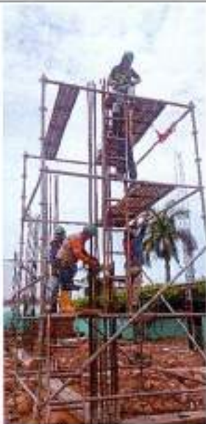
Foto 17: Amarre de acero de refuerzo para columnas en concreto de 3500 psi
