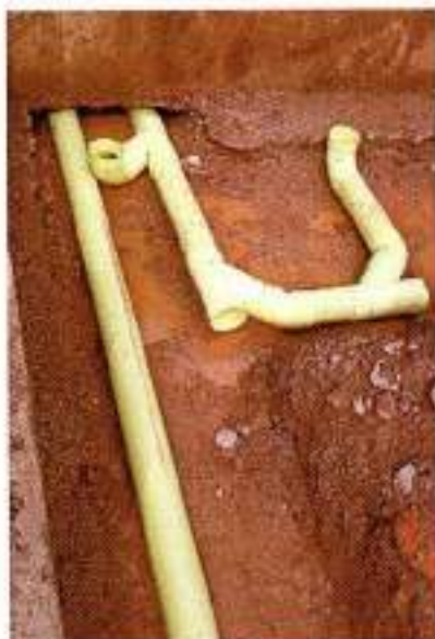
Foto 33: Instalación de tubería PVC sanitaria
