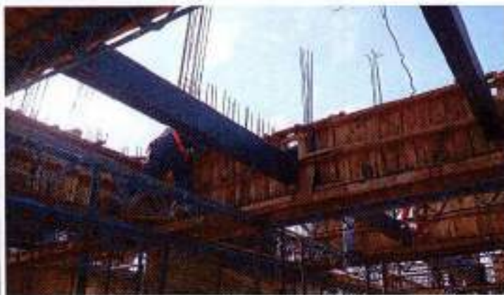
Foto 13: Instalación de estructura metálica ASTM 500
