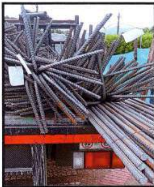
FOTO 1: Puesta de aceros en obra
