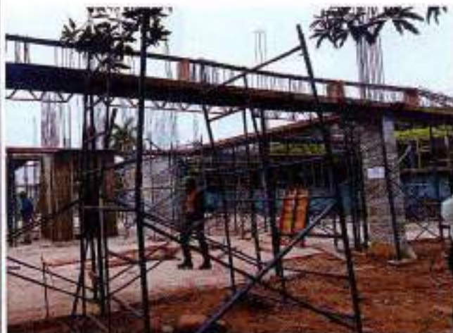
Foto 2: Instalación de camillas para encofrado de vigas aéreas
