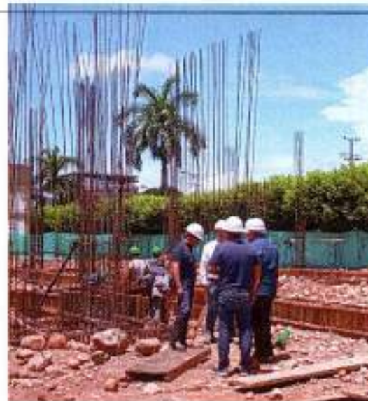
Foto 50: Recorrido de inspección ocular y verificación a la ejecución de las obras por parte de supervisión, interventoría y el señor alcalde.
