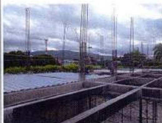
Foto 22: Instalación de Metaldeck
