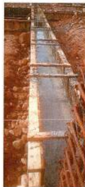
Foto 14: Concreto para vigas de cimentación de 3500 psi
