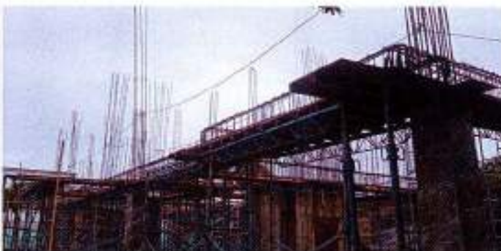
Foto 2: Instalación de acero de refuerzo para vigas aéreas
