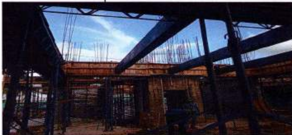
Foto 7: Instalación de estructura metálica ASTM 500
