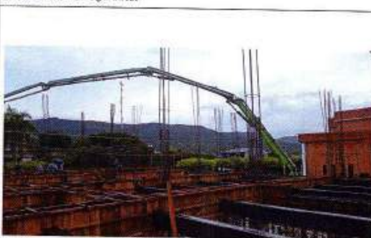
Foto No 2: Fundida de vigas aéreas
