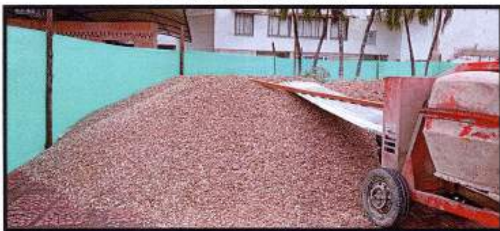
FOTO 2: Material disponible en obra
