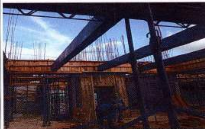
Foto 15: Instalación de estructura metálica ASTM 500
