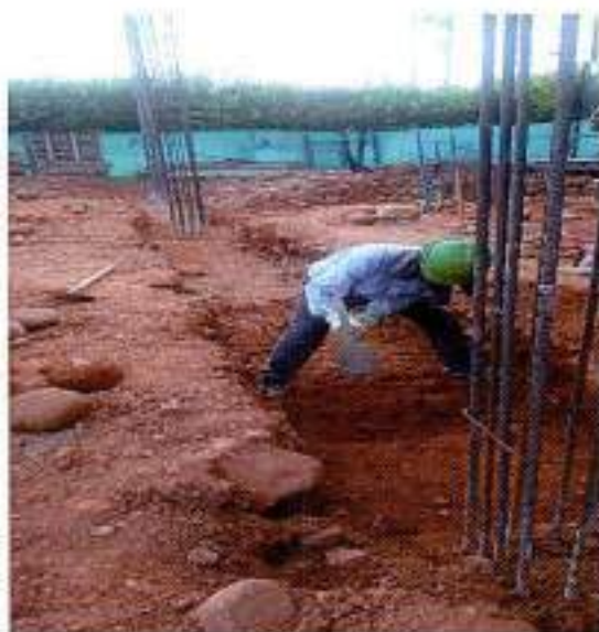
Foto 6: Relleno con material sub base triturada – tamaño máximo 2"
