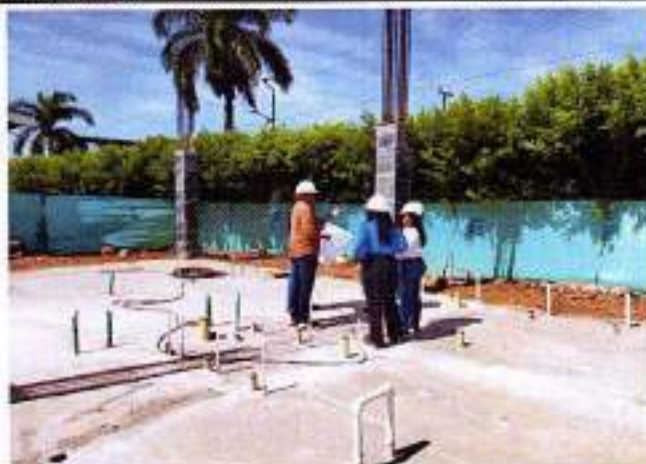
Foto 6: Recorrido de inspección y verificación de las obras por parte de la Supervisión del Ministerio del Interior, Personal de Obra y Personal de Interventoría.
