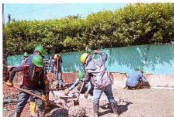
Foto 27: Vaciado de concreto de 3000 psi para placa base
