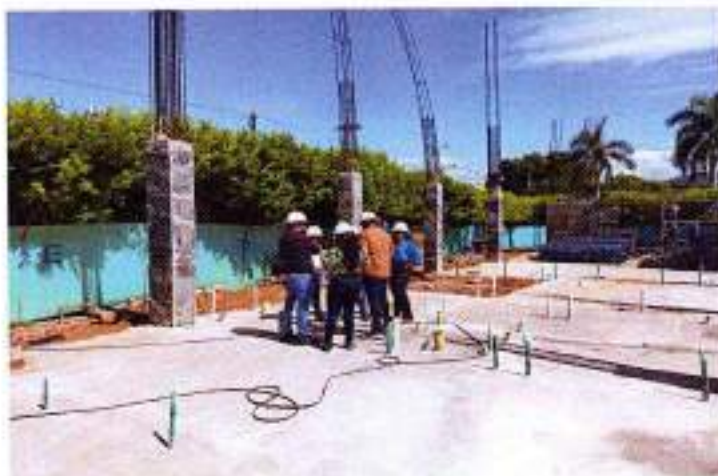
Foto 7: Recorrido de inspección y verificación de las obras por parte de la Supervisión del Ministerio del Interior, Personal de Obra y Personal de Interventoría.
