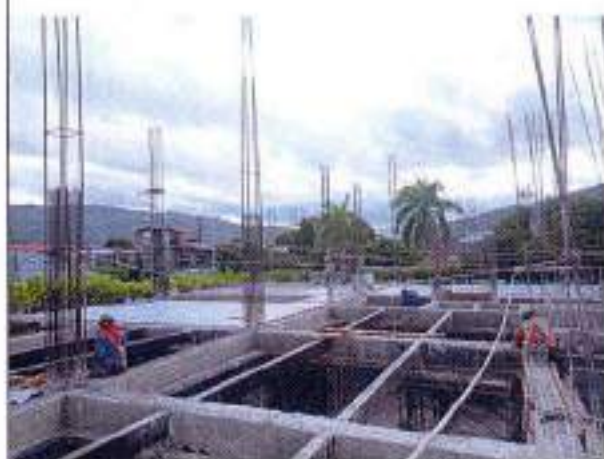
Foto 21: Instalación de Metaldeck
