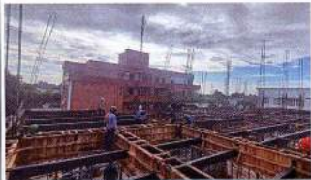
Foto 16: Instalación de estructura metálica ASTM 500
