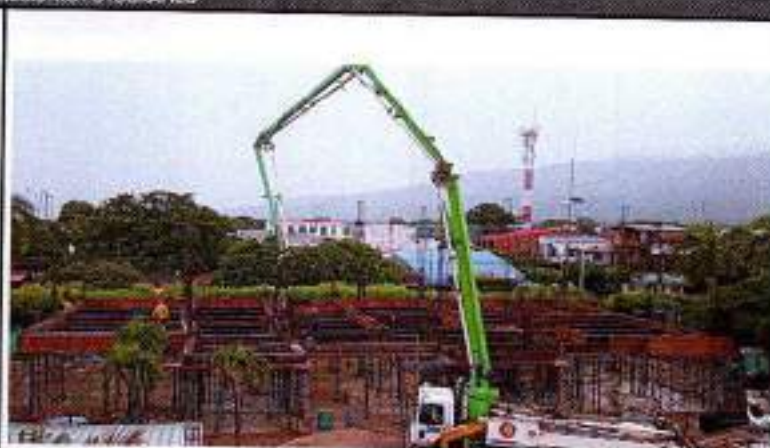
Foto No 2: Fundida de vigas aéreas
