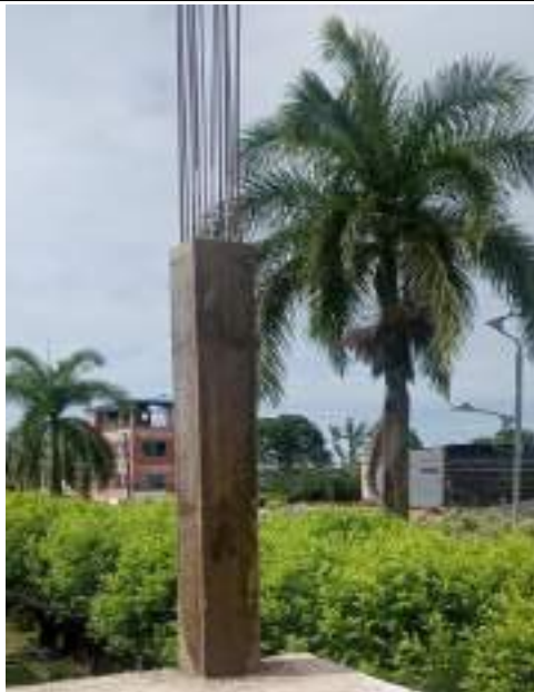
Foto No 6: Desencobrado de columnas
