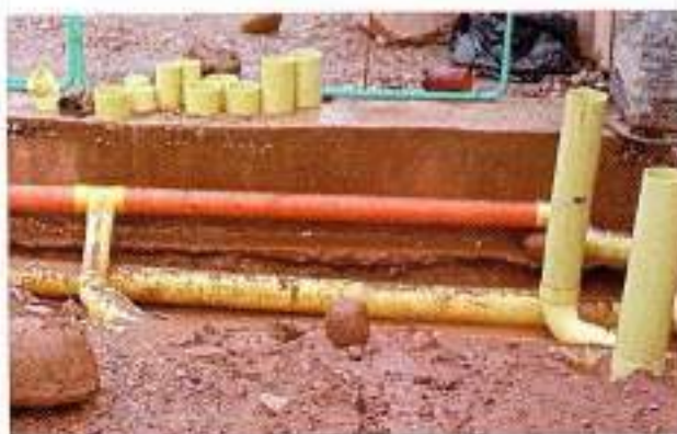
Foto 33: Instalación de tubería PVC sanitaria
