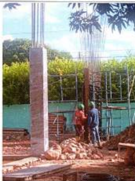
Foto 22: Concreto de 3500 psi para columnas y muros
