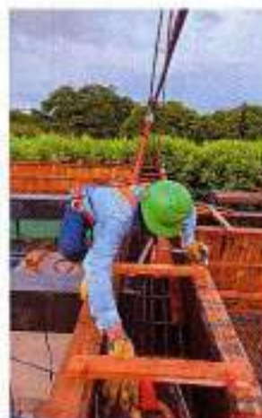
Foto 12: amarre de acero de refuerzo para vigas aéreas
