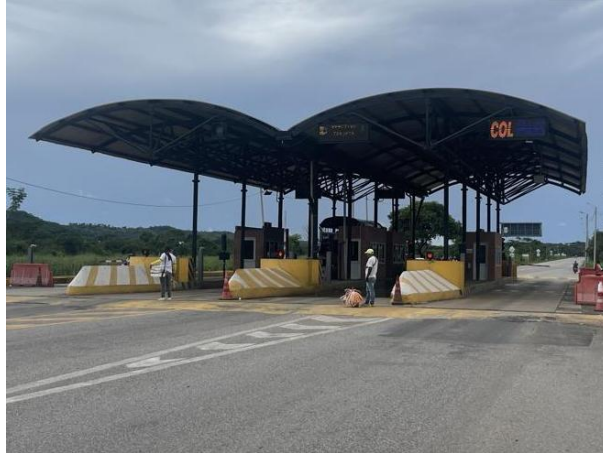
Ilustración 5.12-2 Estación de Peaje, el Carmen – PR 60+750 RN 2515. Fuente: Elaboración propia
