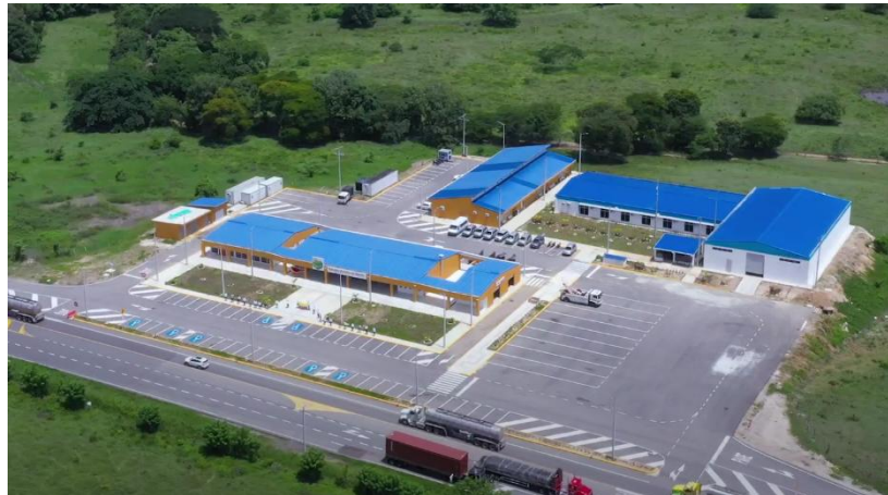
Ilustración 5.8-1 Centro De Control De Operaciones, CCO Fuente: SCVMM
