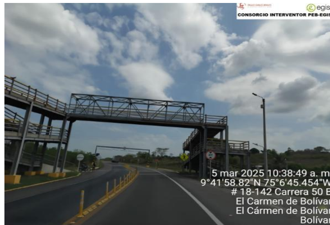
Ilustración 6.6-4 Señalización en el cruce “Puente Peatonal El Salado” Fuente: Elaboración propia
