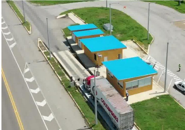
Ilustración 5.12-3 Estación de pesaje, Calamar. Fuente: Elaboración propia
