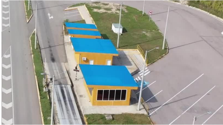
Ilustración 5.12-4 Estación de pesaje, San Jacinto. Fuente: Elaboración propia
