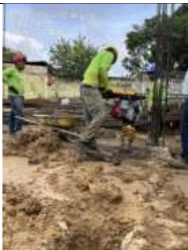
Relleno con material seleccionado Compactado
