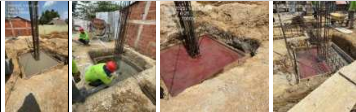
Construcción de zapatas en concreto de 3000 PSI
