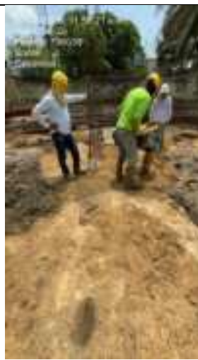
Relleno con material seleccionado Compactado
