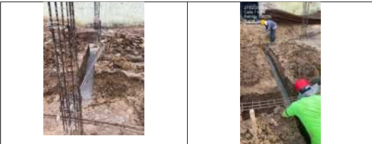
Construcción de solado en concreto para viga cimiento
