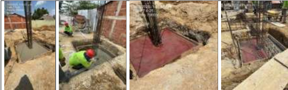
Construcción de zapatas en concreto de 3000 PSI
