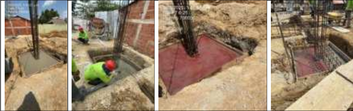
Construcción de zapatas en concreto de 3000 PSI
