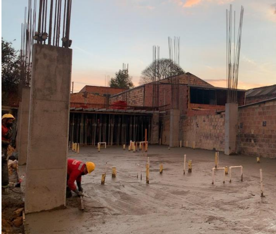
Ilustración 3 Módulo 1 (Vaciado de Placa de Contrapiso)
