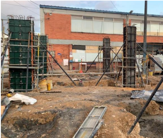
Ilustración 2 Teatrino (Vaciado de Columnas)
