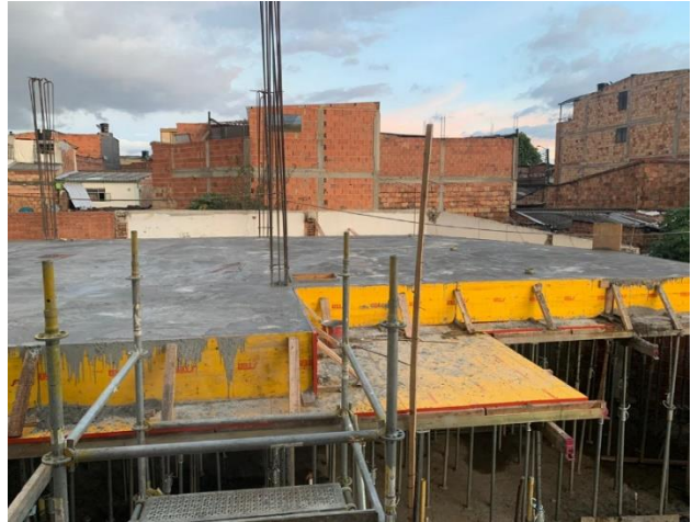
Ilustración 1 Módulo 7 (Vaciado de Placa de Entre piso)
