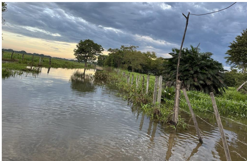
Figura 11. Vía intransitable municipio La Jagua de Ibirico
