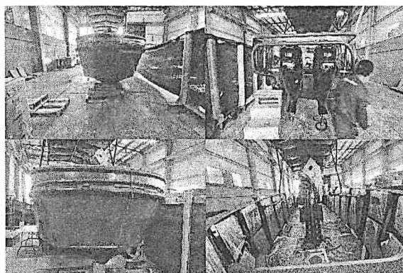
Foto No. 38 a 41 – Bote No. 7 y 8 integración de equipos, sistema de mando control, balístico, afustes,jack plate y motores
