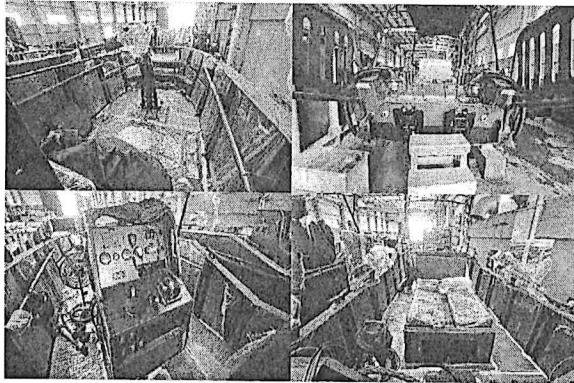
Foto No. 01 a 04 – Bote No. 6,7 y 8 integración de equipos, sistema de mando control, balístico, afustes y jack plate
