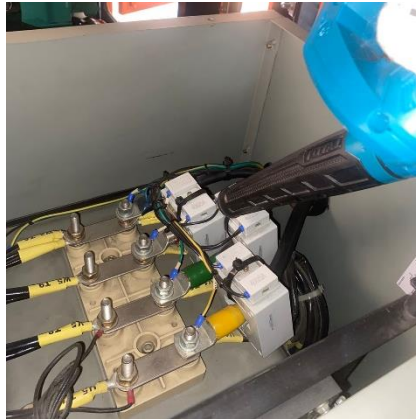
Revisión y ajuste de bornes de conexión del generador
