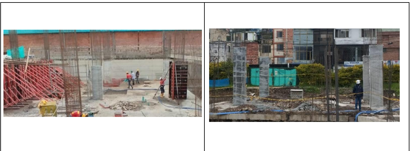
Fig. 20 y 21 suministro de concreto para columnas
