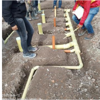
Fig. 32 suministro de tubería 2"
