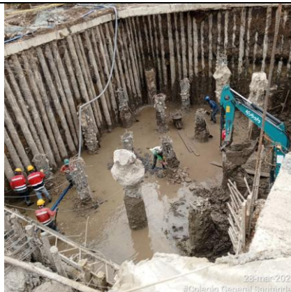
Fig. 38 Descabece de pilotes
