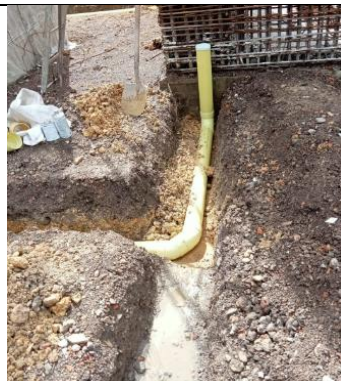
Fig. 31 suministro de tubería 4"
