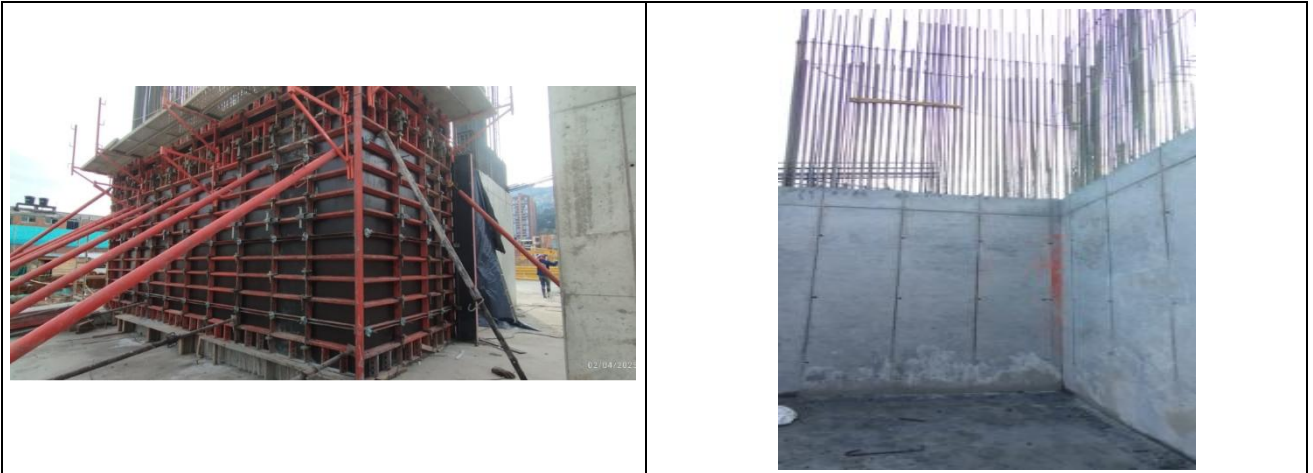
Fig. 18 y 19 Acero de refuerzo
