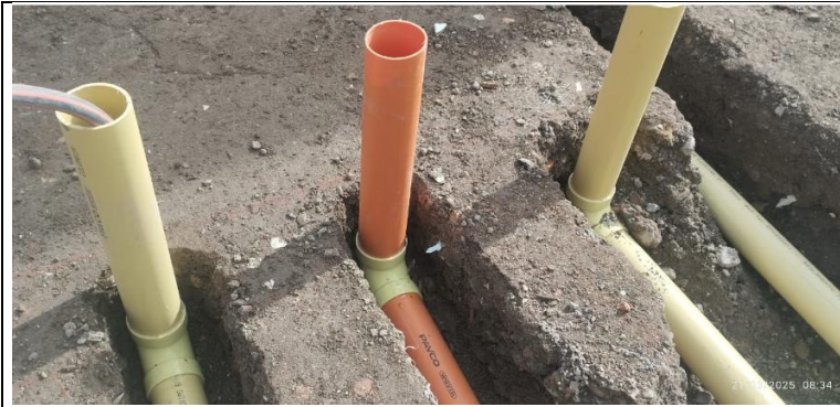
Fig. 36 tubería PVC-L 2"
