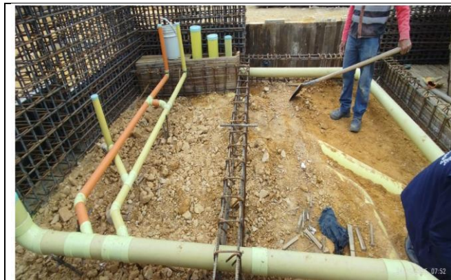
Fig. 30 suministro de tubería 6"
