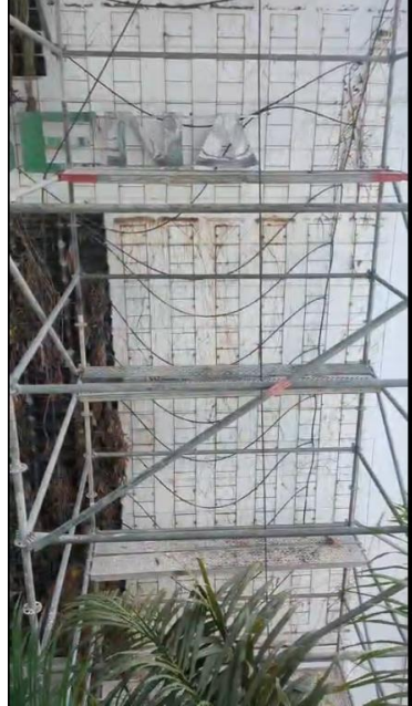
Foto. Montaje de estructura metálica certificada jardín exterior
