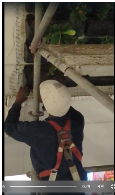
Foto. Instalación malla jardin interno
