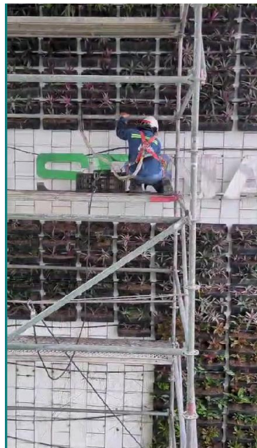
Foto. Limpieza de letras metálicas.
