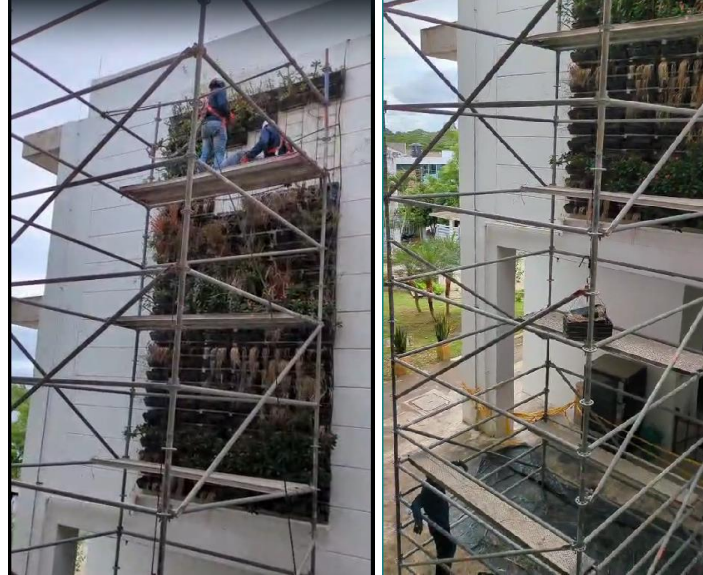
Foto. Desmontaje de bandejas
