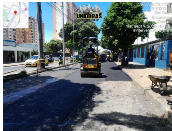
Compactación de rodillos vibratorios
