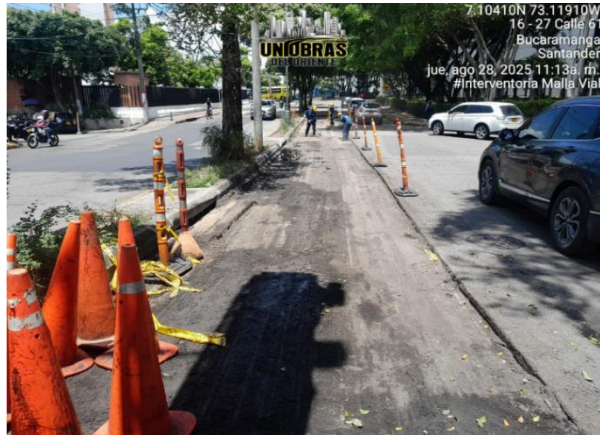
Fresado tramo afectado
