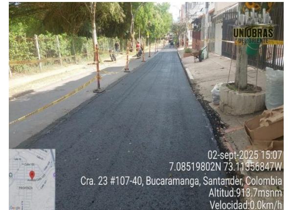
Acabado de caja después de intervención
