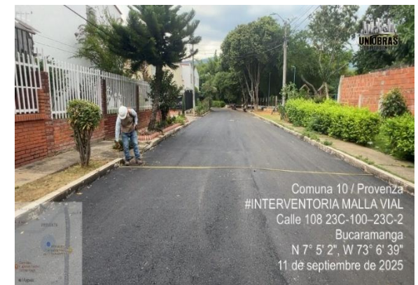
Acabado de caja después de intervención
