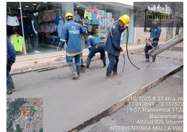
APLICACIÓN Y VIBRADO CONCRETO
