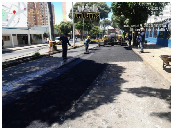
Aplicación 2da capa mezcla asfáltica MDC19
