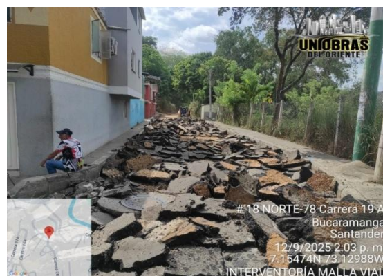
Excavación y demolición
