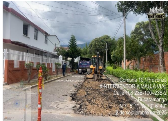
Excavación y demolición área afectada
