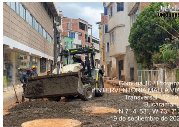
INSTALACION DE BASE GRANULAR
