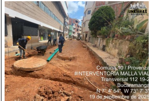
INSTALACION DE TUBERIA
