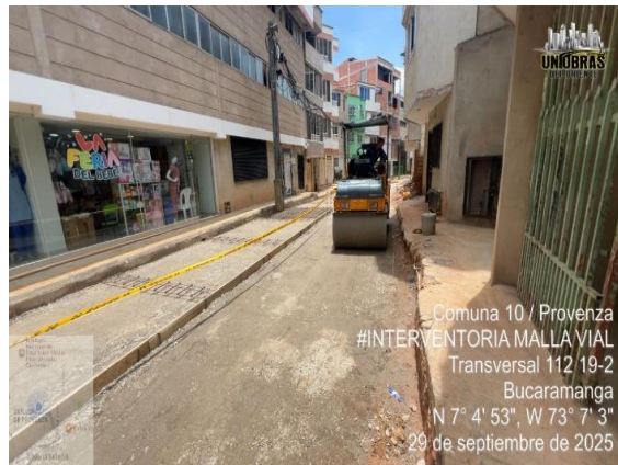
CONFORMACION DE CALZADA
