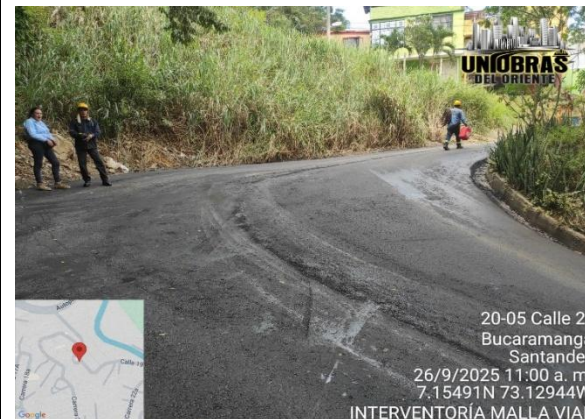
Instalación de MDC-19.
