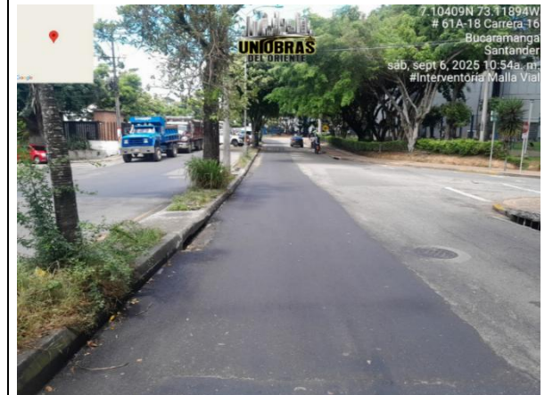
Acabado con aplicación MDC-19
