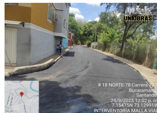
Instalación de MDC-19
