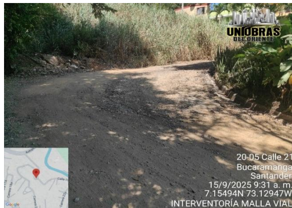
Excavación y demolición
