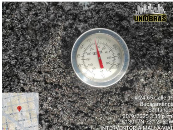
CONTROL DE TEMPERATURAS DE ASFALTO
