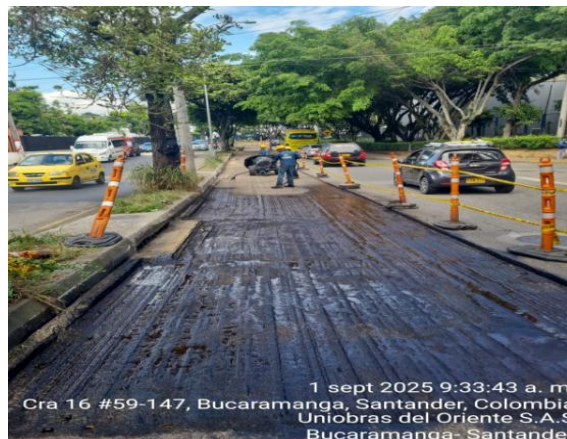
Imprimación con emulsión asfáltica CRR60
