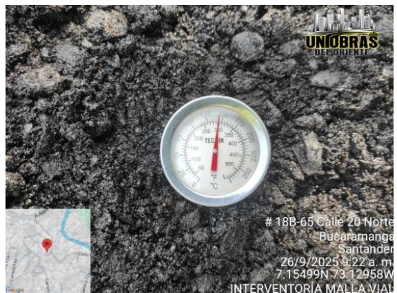
CONTROL DE TEMPERATURAS DE ASFALTO
