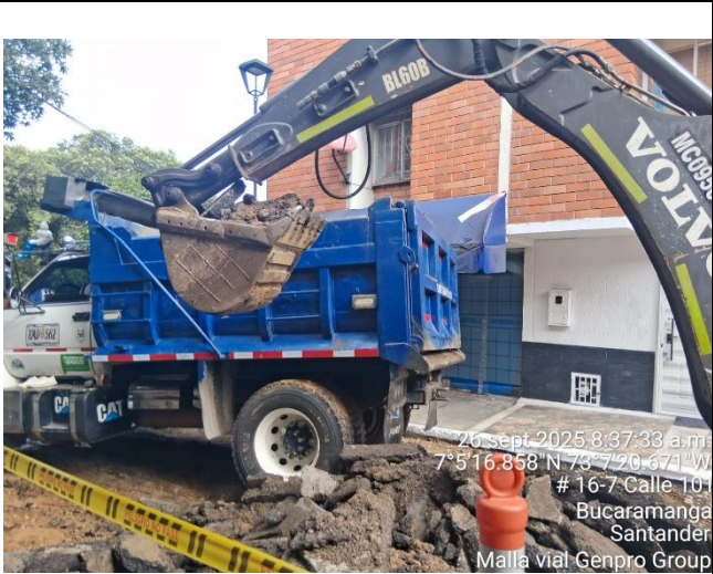
Cargue y transporte de material
