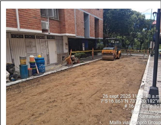
Conformación base granular
