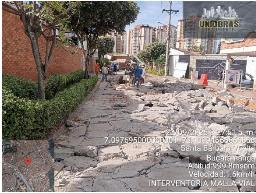
Corte de pavimento rígido
