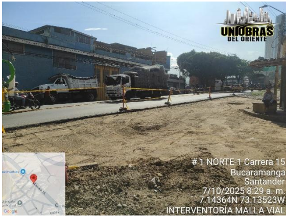
Conformación de subrasante
