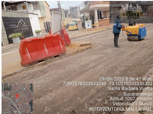
Conformación de subrasante
