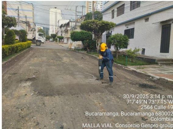
Demolición de pavimento existente
