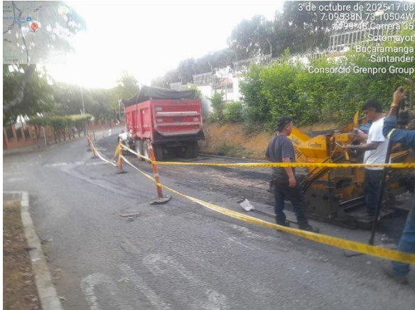
INSTALACION DE MEZCLA MDC-19
