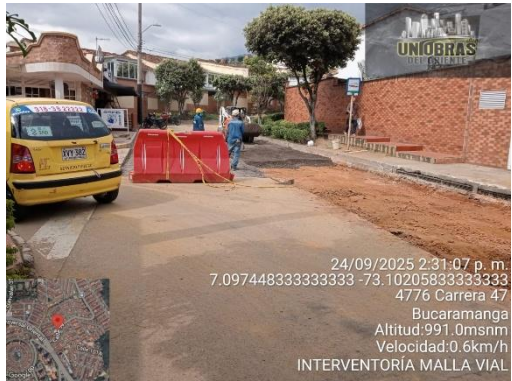
Conformación de subrasante
