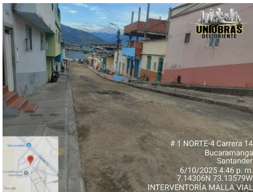
Conformación de subrasante
