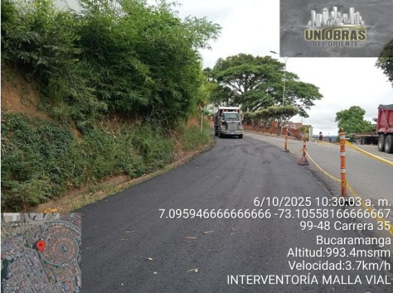
INSTALACION DE MEZCLA MDC-19
