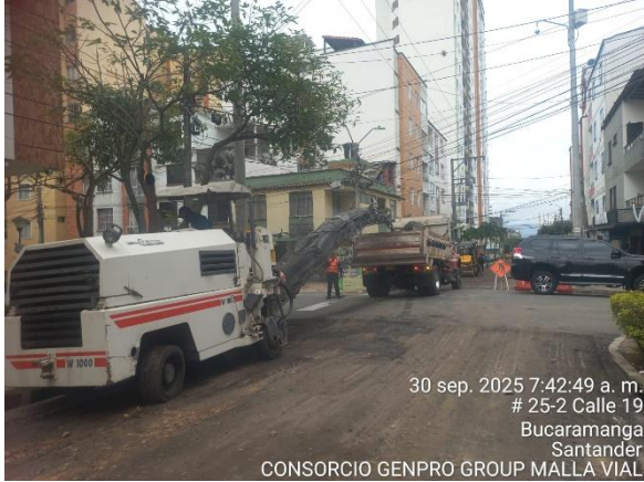
Demolición y cargue de fresado
