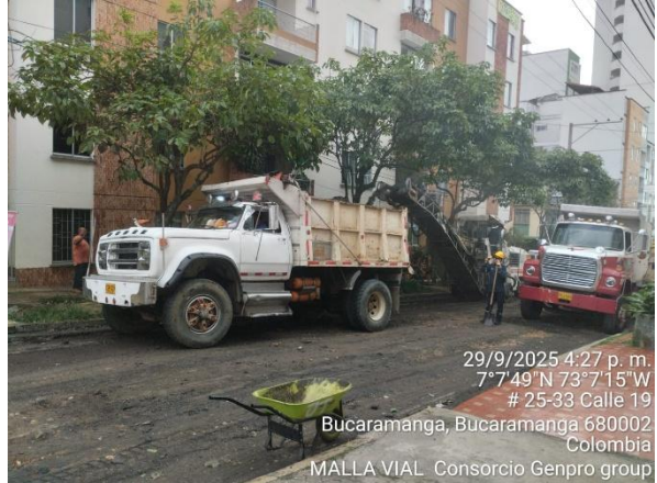
Demolición y cargue de fresado
