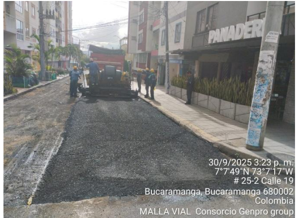
Instalación de MDC-19
