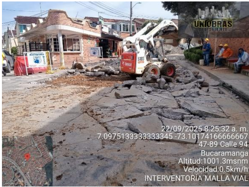
Corte de pavimento rígido
