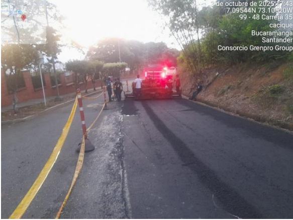
INSTALACION DE MEZCLA MDC-19
