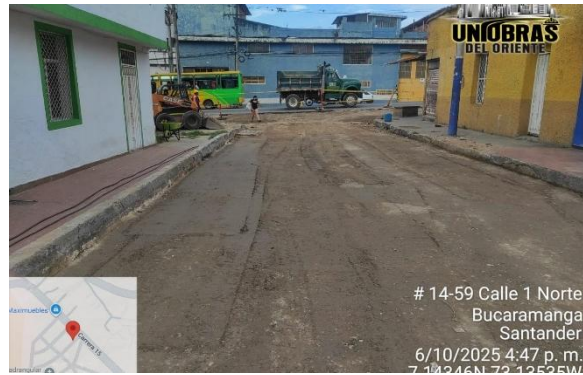
Conformación de subrasante
