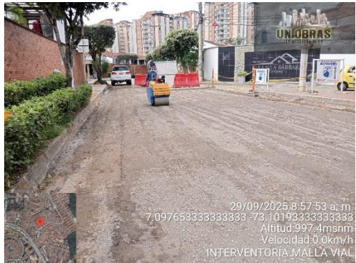
Conformación de subrasante
