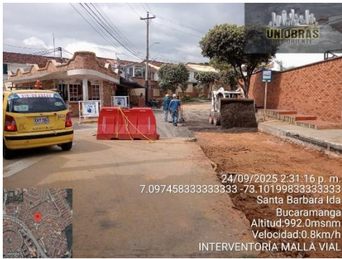
Instalación de base granular
