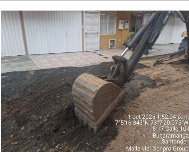
Conformación base granular
