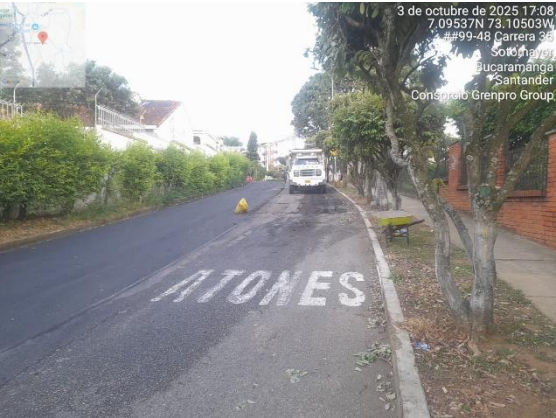
INSTALACION DE MEZCLA MDC-19
