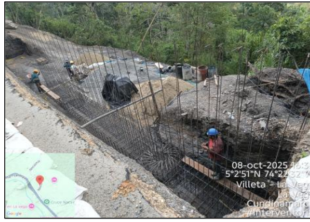
Imagen No.4: Revisión, verificación y control de instalación de acero de refuerzo del modulo No. 2 del muro de contención.
