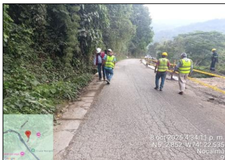
Imagen No. 3: Recorrido de verificación del estado las de cunetas
