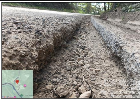
Imagen No. 2: Labores de inspección sobre el estado de la base estabilizada entre el Km 0+740 al Km 0+560
