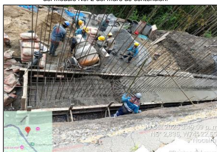
Imagen No.6: Labores verificación y control, fundida viga de amarre modulo No. 2 del muro de contención
