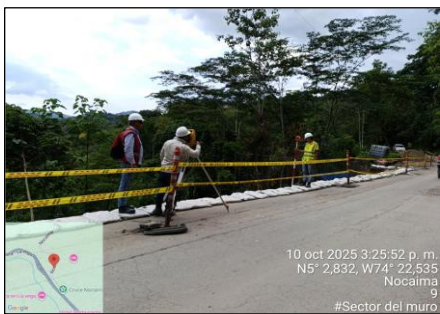
Imagen No.5: Labores de replanteo de caisson, verificación de niveles de caisson y viga de amarre, zona muro de contención
