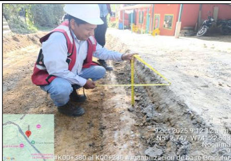
Imagen No. 1: Verificación y control de los espesores de la base estabilizada con emulsión y cemento
