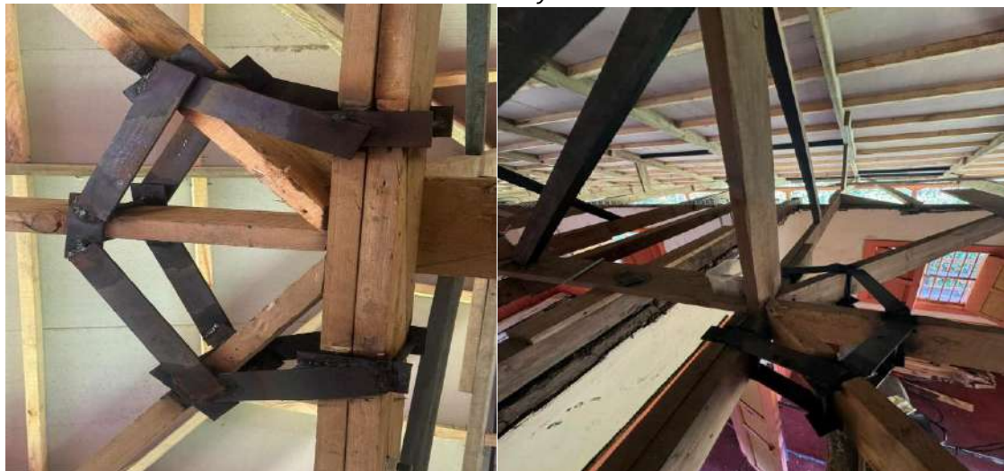
N.P.16 Reforzamiento en nodos de la estructura 1 y 2
