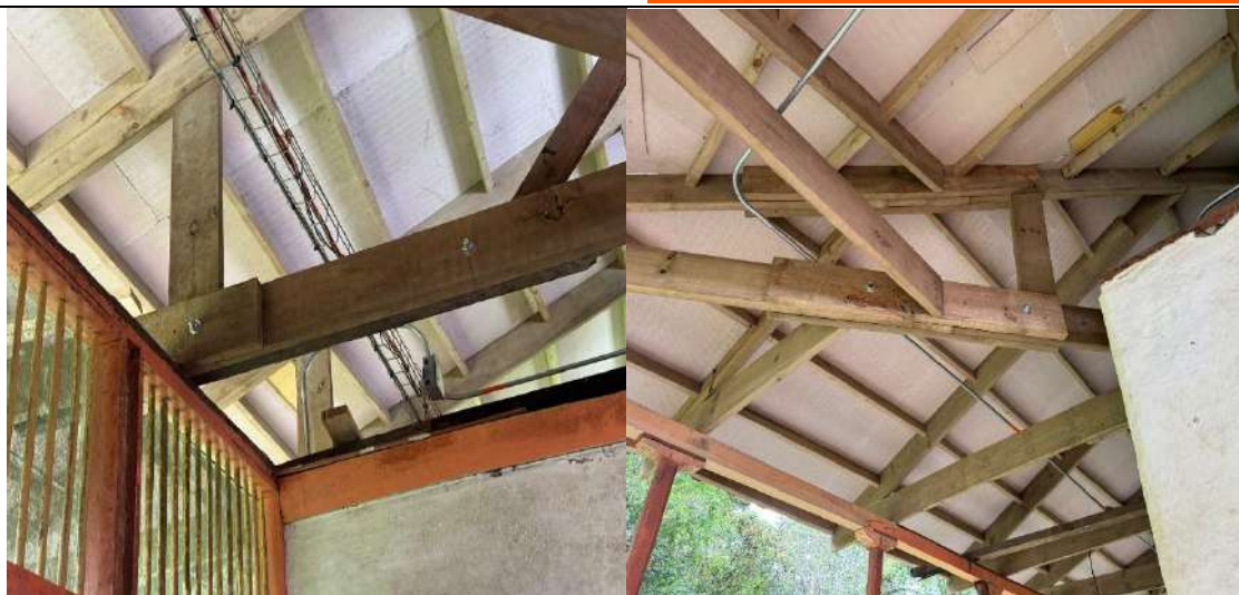
N.P.16 Reforzamiento en nodos de la estructura 1 y 2
