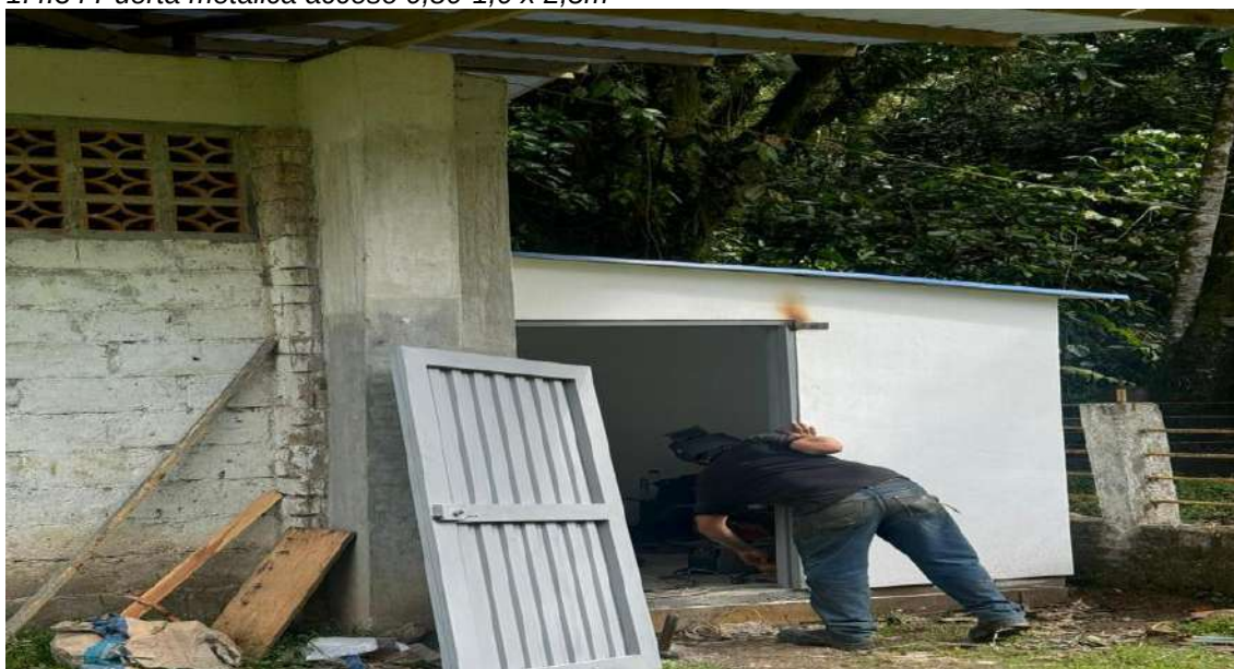
2.1.1 Desmonstaje en cubierta de barro
