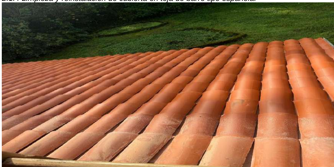
2.1.5 Reposición tejas de barro
