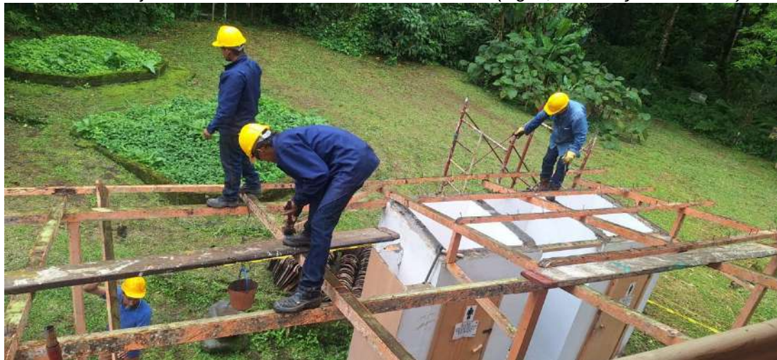
2.1.3 Suministro e instalación de cielorraso en lamina de superbord de 8mm de espesor. Incluye estructura y todos los elementos de fijación.
