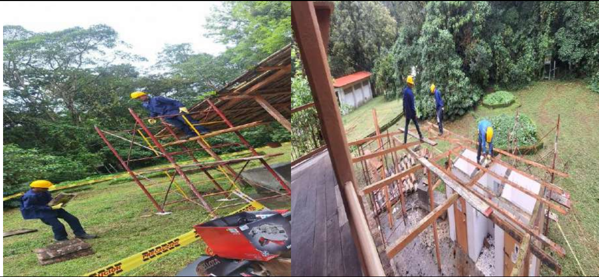
2.1.2 Desmontaje de estructura en madera en mal estado (vigas, correas y/o columnas).
