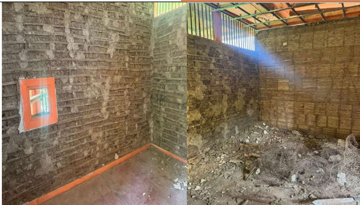
N.P.5 Reforzamiento en platinas angular para cercha ref: WBO ANGULAR SIN REFUERZO 40X50X2,5
