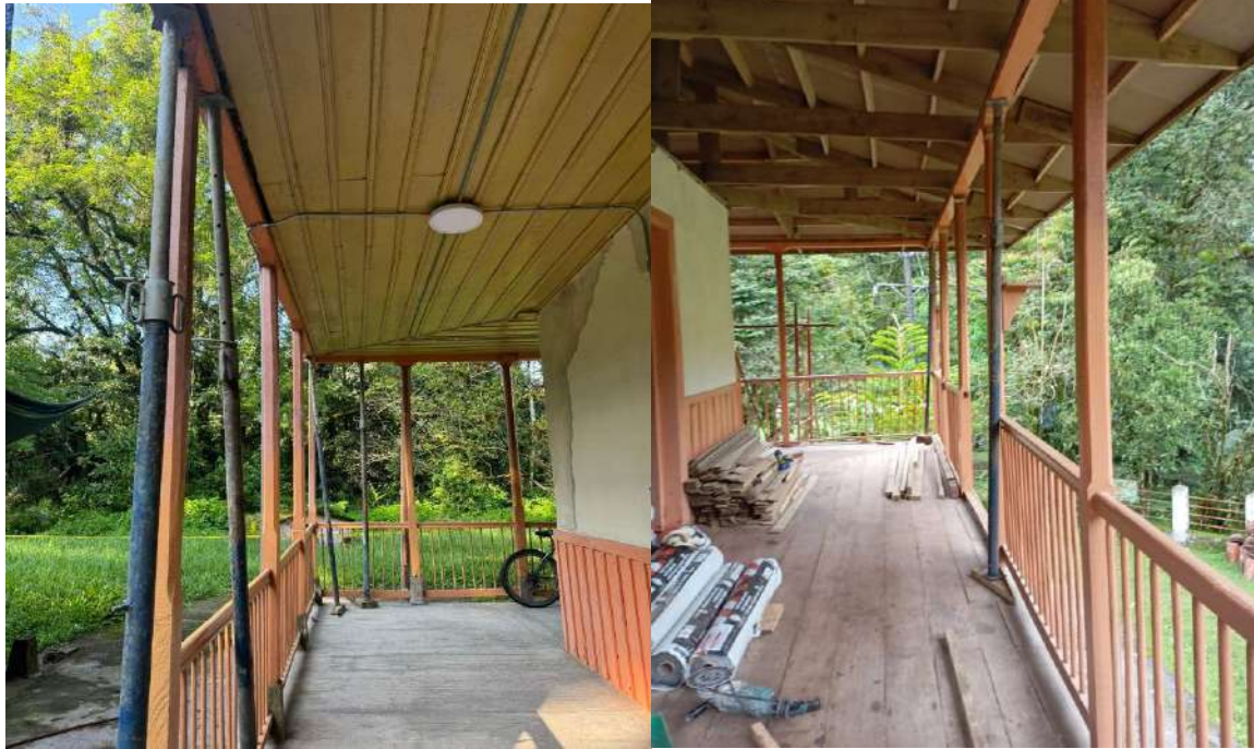
N.P.13 Suministro e instalación de estuco
